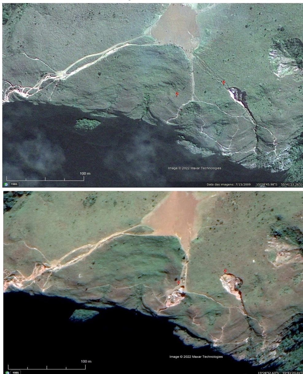
Figura 91. Imagens obtidas do Google Earth, a superior 2009 e a inferior de 2022, mostrando a evolução de processos erosivos no Mirante de Chapada dos Guimarães causadas por trilhas (indicadas pelas setas) formadas por visitantes do local. Coordenadas do local Lat. 14°37'52.65"S e Long. 55°14'32.60"O. Imagem obtida do Google Earth Pro em 05/10/2022.
