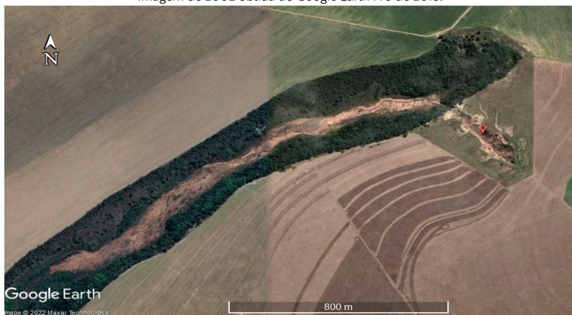
Figura 99. Boçoroca com 350 de comprimento gerando assoreamento visível na imagem de satélite com extensão de aproximadamente 1600m. Coordenadas do local: Lat. 15° 3'36.77"S e Long. 54°59'41.81"O. Imagem de 2002 obtida do Google Earth Pro de 2018.
