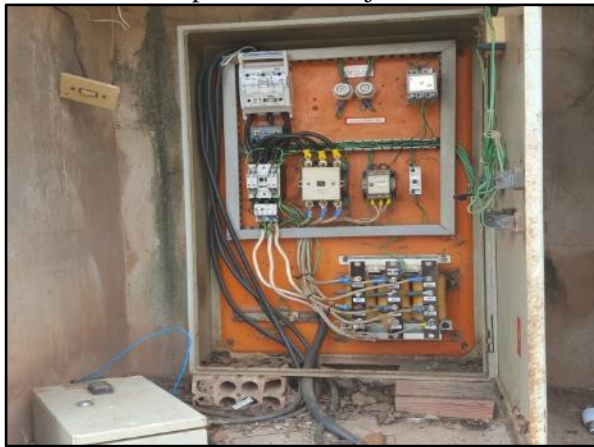
Figura 14. Quadro de comando da captação apoiado sobre tijolos
