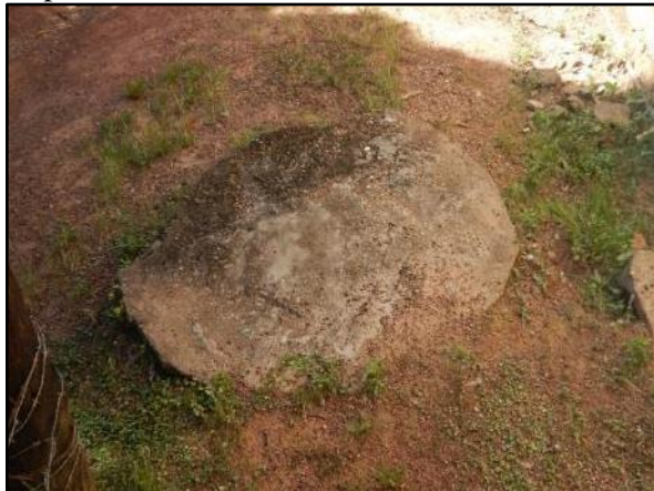
Figura 168. Tampa de fossa absorvente em uma residência no distrito de Baús
