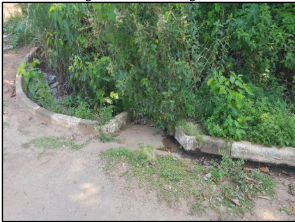
Figura 76. Abertura no meio-fio na Rua Antônio Hermenegildo recebendo águas servidas
