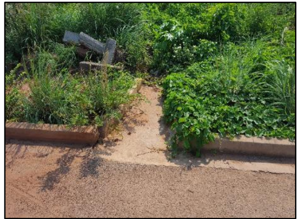
Figura 77. Abertura no meio-fio na Rua Cuiabá, bairro Vó Geová
