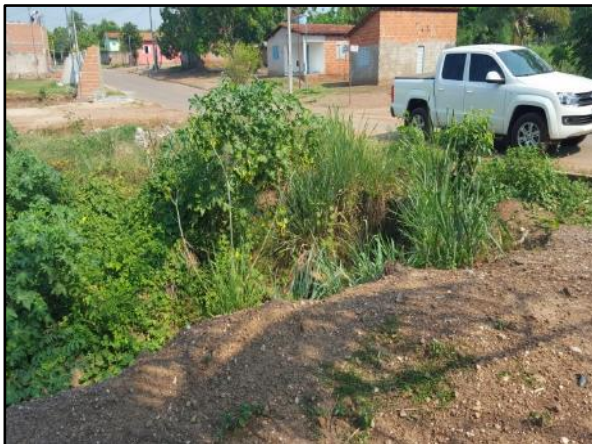
Figura 64. Fundo de vale poluído sob a Rua Antônio Hermenegildo e próximo a intersecção com a Rua Santo Antônio
