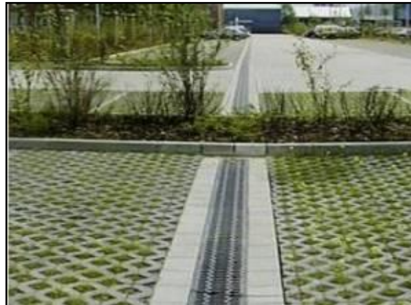
Figura 226. Trincheira de infiltração no estacionamento
