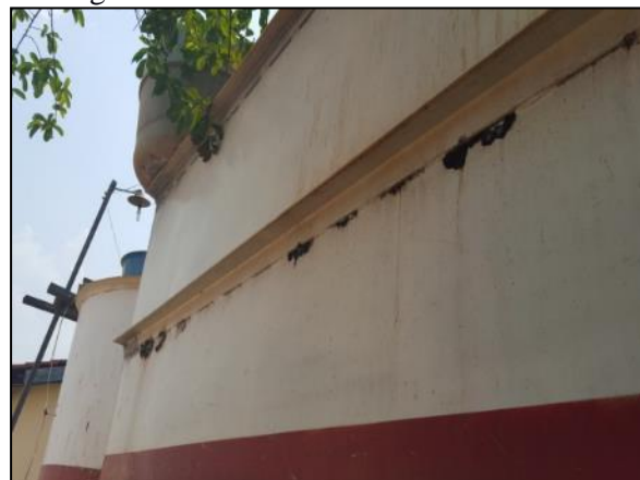
Figura 58. Estrutura filtro com corrosão
