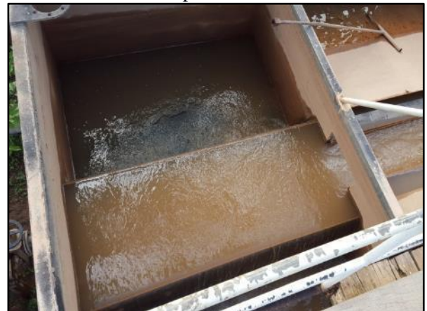
Figura 27. Filtro rápido descendente com múltiplas camadas
