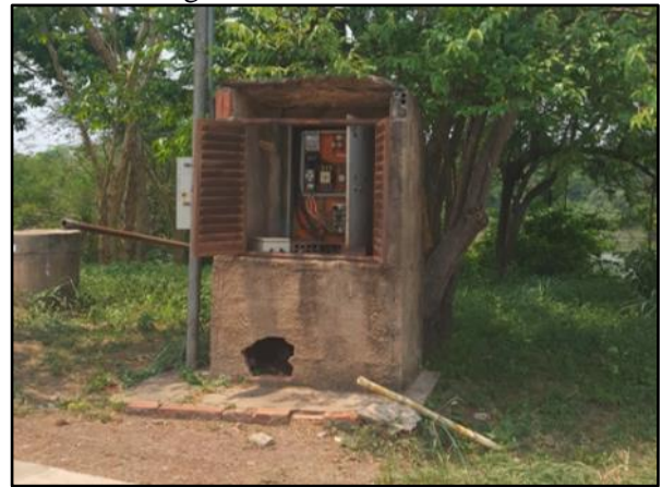
Figura 15. Abrigo do Quadro de comando degradado na Av. Beira Rio
