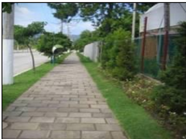
Figura 227. Vala de detenção ao longo da rua
