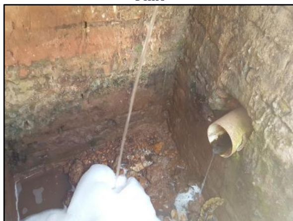
Figura 67. Lançamento de efluente na galeria de águas pluviais na Rua Antônio Ribeiro Taques Filho
