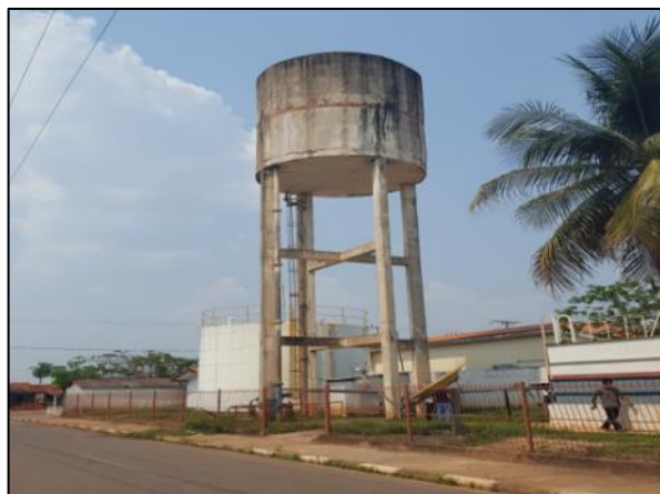
Figura 35. Reservatório elevado (REL-01) de 100 m 3 na área da ETA
