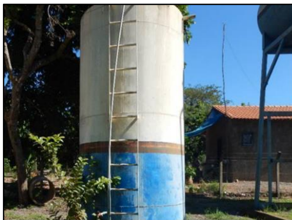
Figura 140. Câmara de contato da ETA de Baús
