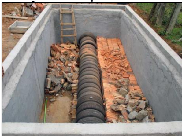
Figura 213. Execução fossa bananeira
