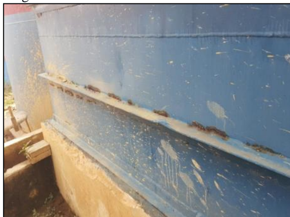
Figura 57. Estrutura decantador com corrosão
