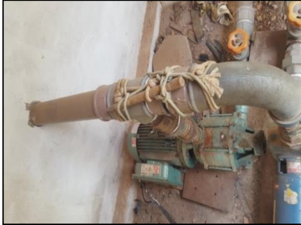
Figura 41. Adaptações não convencionais feitas de cabo de vassoura e corda na tubulação pressurizada de distribuição
