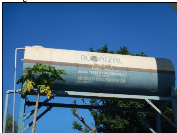
Figura 148. Reservatório elevado de 20 m 3
