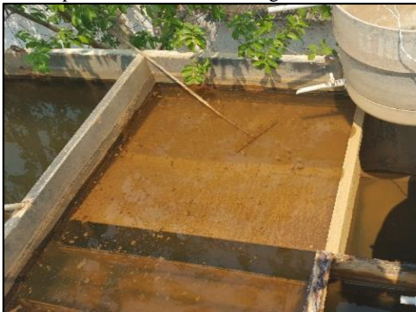
Figura 26. Decantador de alta taxa com placas planas inclinadas com ângulo de 5°.
