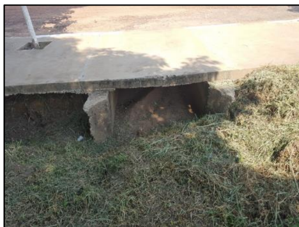
Figura 75. Deságue da saída sob a calçada na grama da quadra dos quiosques públicos
