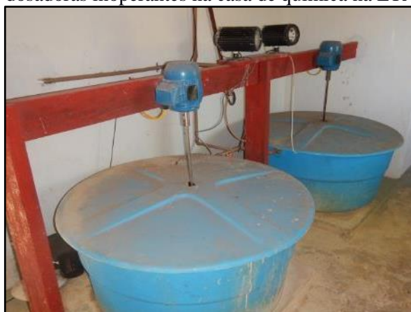
Figura 146. Tanques de preparo das soluções equipados com misturadores mecânicos e bombas dosadoras inoperantes na casa de química na ETA
