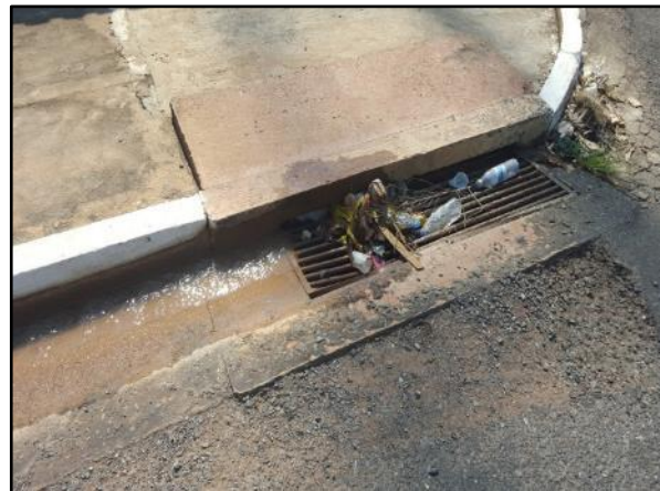
Figura 83. Águas de lavagem do filtro da ETA de Acorizal escoando para boca de lobo na Av. Mato Grosso
