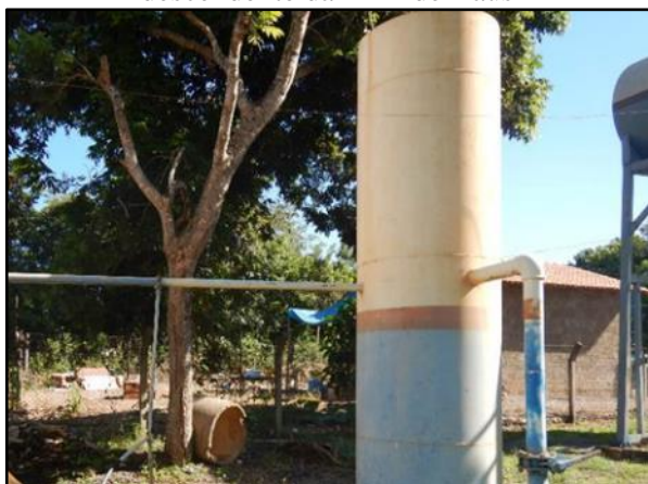
Figura 139. Filtro de múltiplas camadas de fluxo descendente da ETA de Baús
