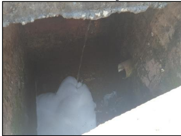
Figura 81. Caixa coletora com lançamento clandestino de esgoto
