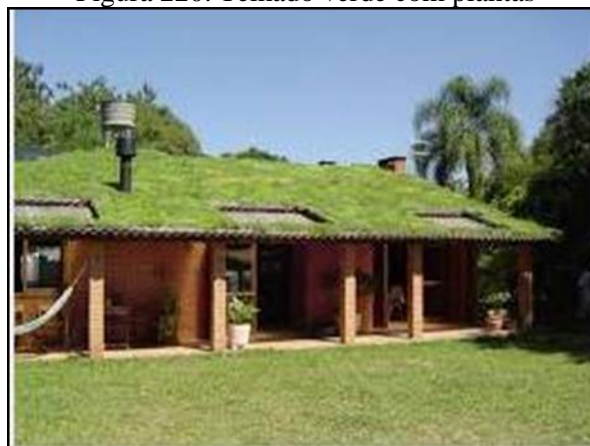
Figura 220. Telhado verde com plantas
