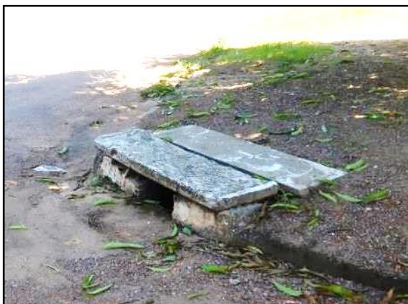
Figura 169. Rua pavimentada com boca de lobo na área urbana de Baús
