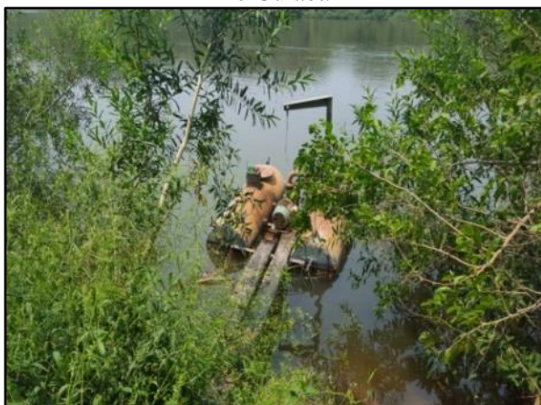
Figura 10. Captação superficial em operação no rio Cuiabá
