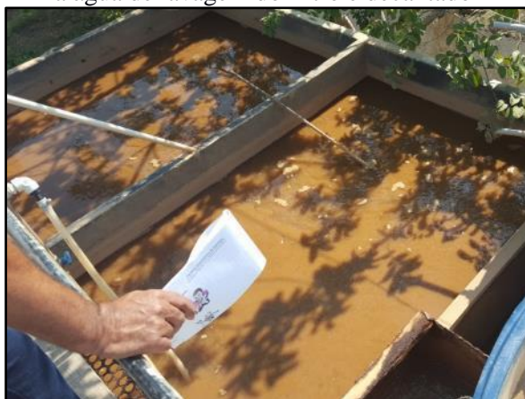
Figura 29. Ponto de descarga do decantador para a água de lavagem do filtro e decantador
