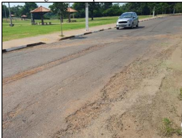
Figura 90. Rua Santos Dumont, onde há alagamentos no período chuvoso
