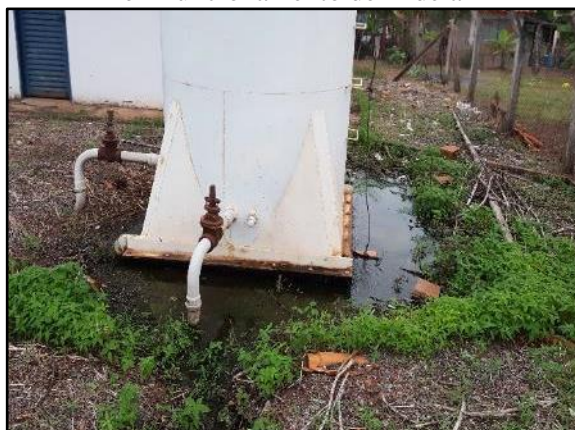
Figura 156. Vazamento na base do reservatório em funcionamento de Aldeia
