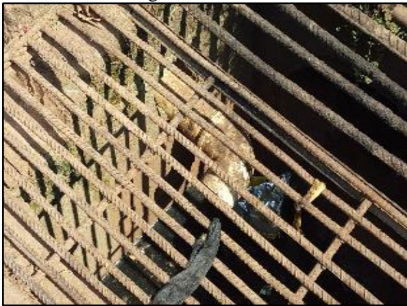
Figura 80. Boca de lobo com lançamento de esgoto clandestino
