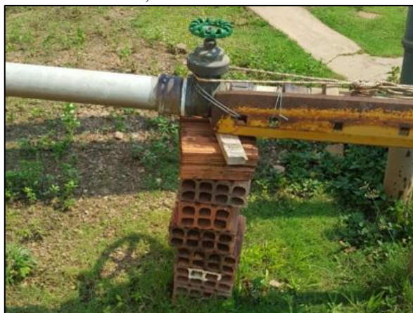
Figura 45. Escoramento da tubulação de distribuição na saída do RAP-01 de tijolos cerâmicos, cordas e lâminas de ferro
