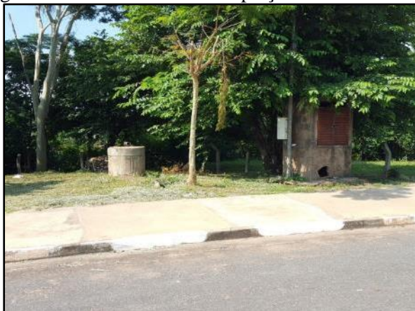
Figura 13. Local de acesso à captação na Av. Beira Rio
