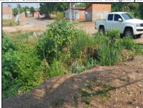
Figura 69. Canal natural de escoamento das águas pluviais
