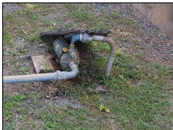
Figura 141. Conjunto motobomba para recalque da água tratada para os reservatórios na área da ETA de Baús
