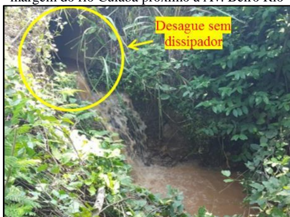
Figura 72. Deságue da galeria de águas pluviais na margem do rio Cuiabá próximo à Av. Beiro Rio
