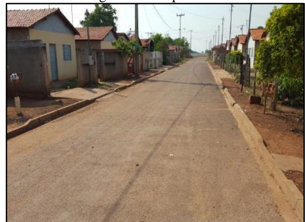
Figura 88. Trecho da Rua Santos Dumont onde ocorre alagamento no período chuvoso
