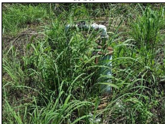
Figura 159. Poço PT-02 da comunidade Chapéu do Sol
