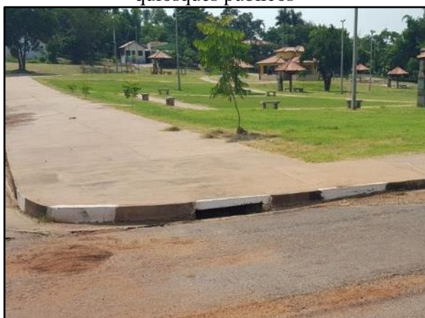
Figura 74. Saída das águas de escoamento superficial na Rua José Jacinto na quadra dos quiosques públicos
