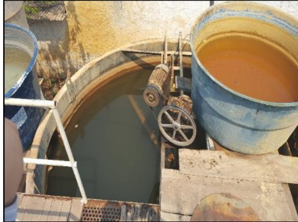
Figura 25. Floculador mecânica com paletas verticais
