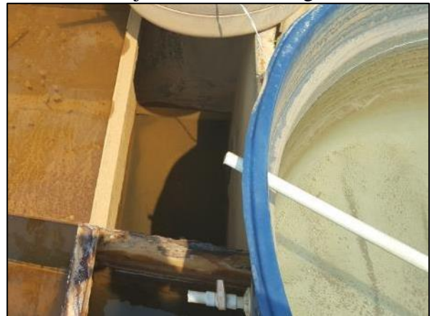
Figura 61. Dosagem da solução de cloro feito com ajuste manual no registro
