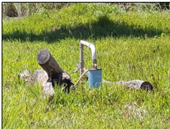
Figura 160. Poço PT-03 da comunidade Chapéu do Sol
