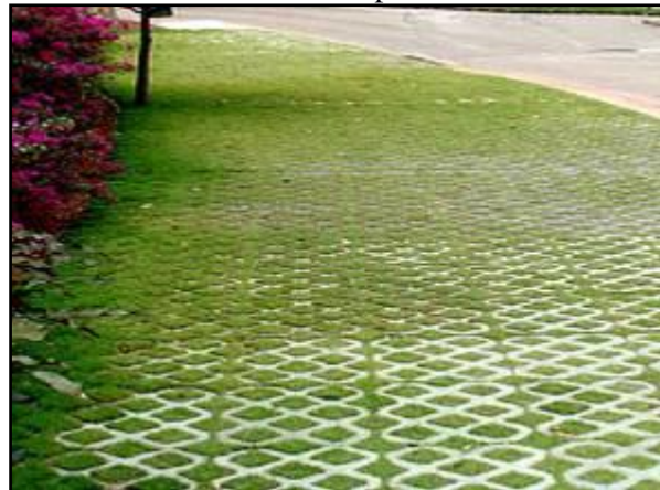
Figura 222. Pavimento poroso – concregrama instalado em passeio
