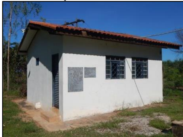
Figura 144. Casa de química e laboratório da ETA de Baús
