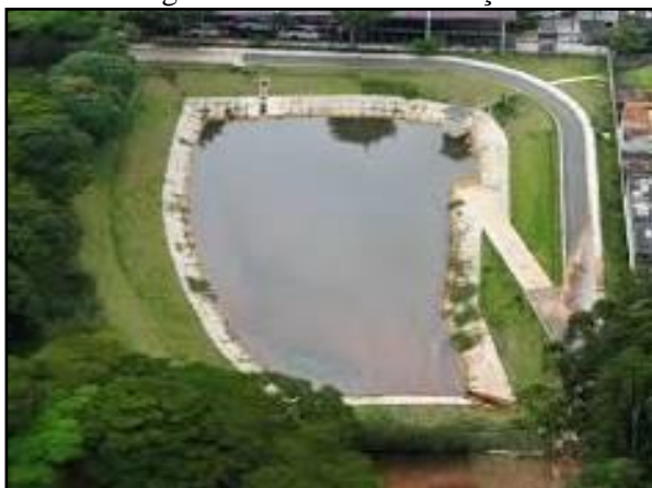
Figura 229. Bacia de detenção
