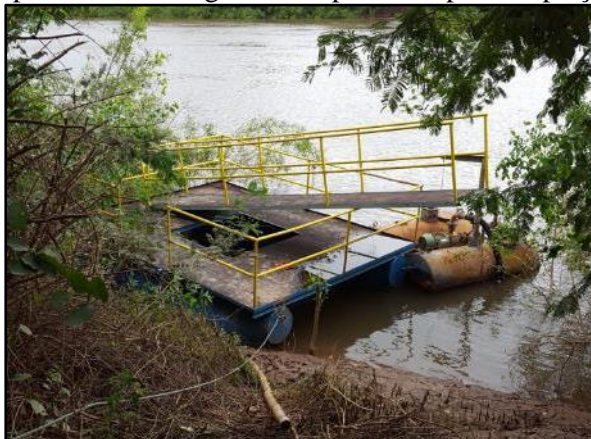
Figura 12. Balsa, plataforma com guarda-corpos e rampa da captação em construção
