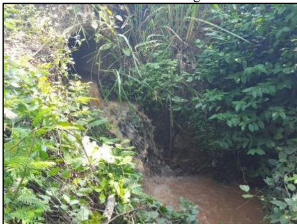
Figura 31. Desague do efluente proveniente da lavagem do filtro e decantador da ETA na margem do rio Cuiabá
