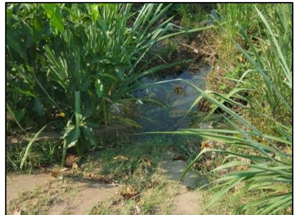
Figura 65. Águas servidas escoando a céu aberto no fundo de vale da Rua Antônio Hermenegildo
