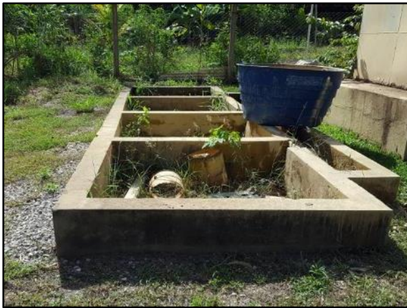
Figura 142. Leito de secagem desativado da ETA de Baús
