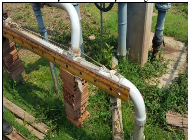
Figura 44. Adaptações não convencionais feitas de cordas, lâmina de ferro e tijolos cerâmicos na tubulação de distribuição de água
