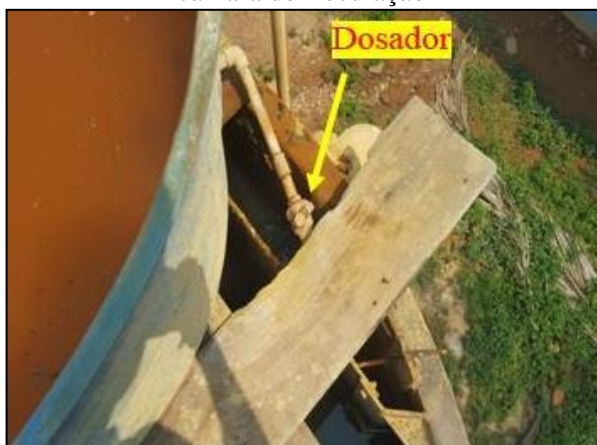
Figura 22. Ponto de dosagem da solução de sulfato de alumínio em um compartimento na câmara de floculação
