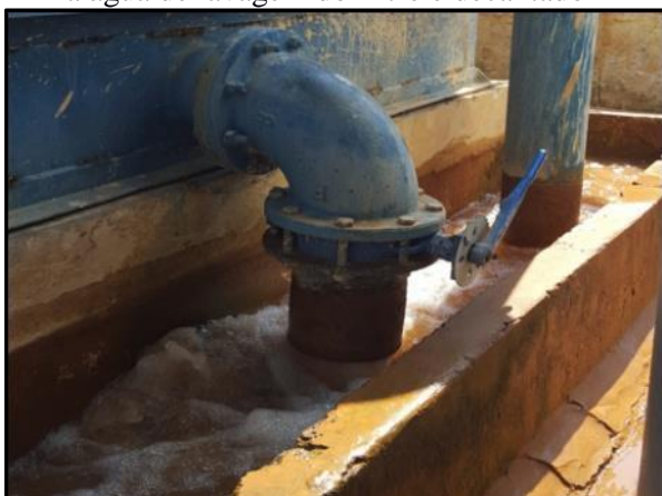
Figura 28. Ponto de descarga do decantador para a água de lavagem do filtro e decantador
