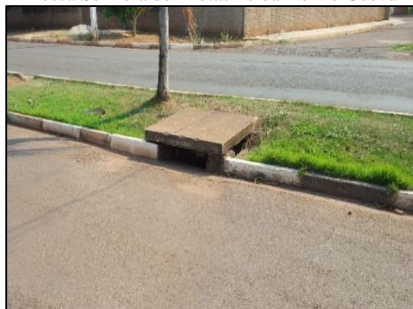
Figura 71. Boca de lobo no canteiro central da Av. Nossa Senhora de Brotas no bairro Vó Geová
