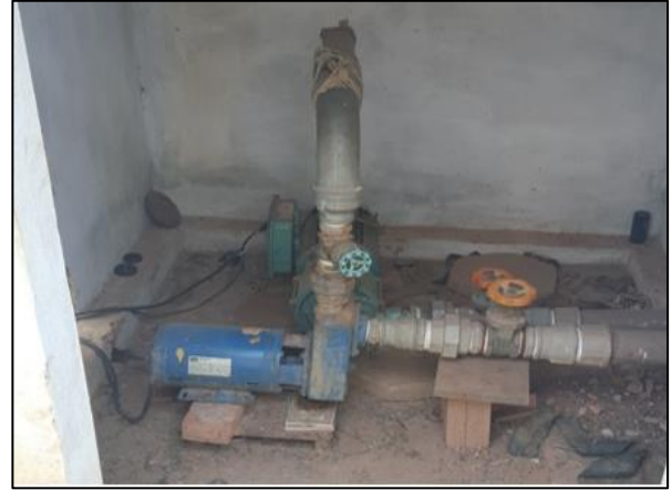
Figura 42. Conjuntos motobomba e tubulações escoradas em madeiras e tijolos cerâmicos improvisados
