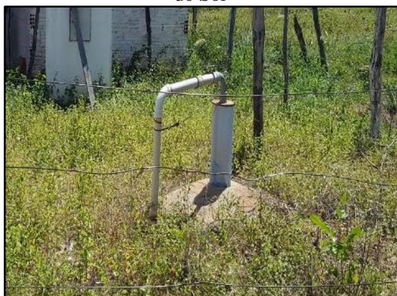
Figura 158. Poço PT-01 da comunidade Chapéu do Sol
