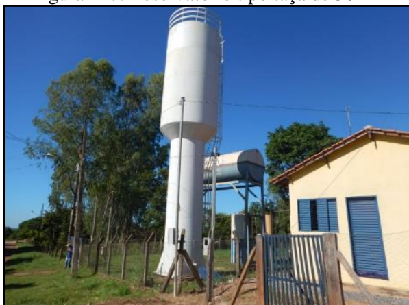
Figura 147. Reservatório tipo taça de 50 m 3
