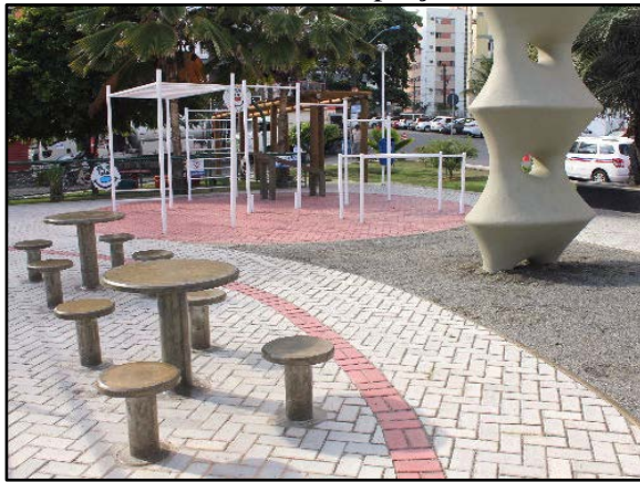
Figura 88. Pavimento poroso – piso intertravado instalado em praça
