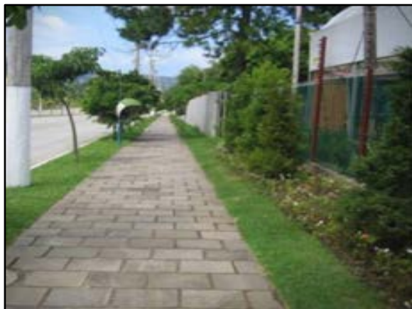
Figura 94. Vala de detenção ao longo da rua
