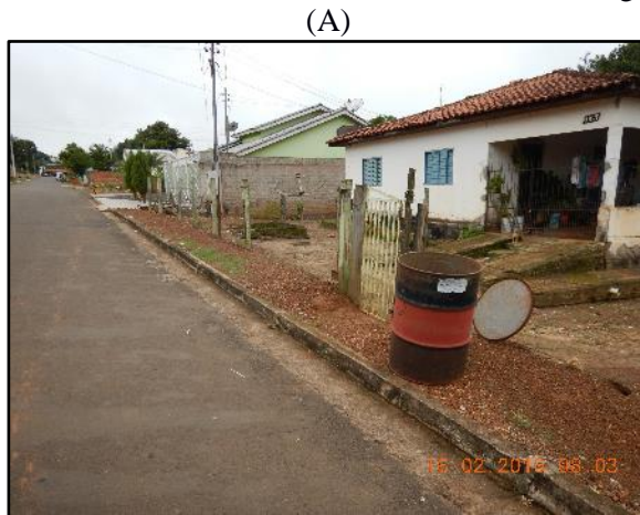
Figura 36. Dispositivos de microdrenagem existentes no núcleo urbano de Alto Garças, meio-fio e sarjeta (A), sarjetão e grelha (B), boca de lobo (C), poço de visita (D) e dissipador de energia com degraus (F)
