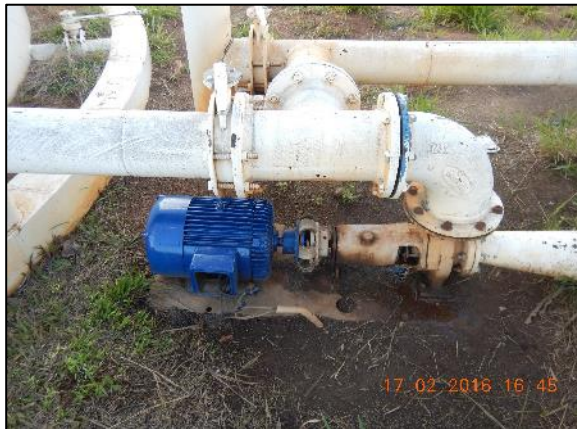
Figura 20. Bomba pressurizadora (A) e booster – Vila Morena (B) (A) (B)
