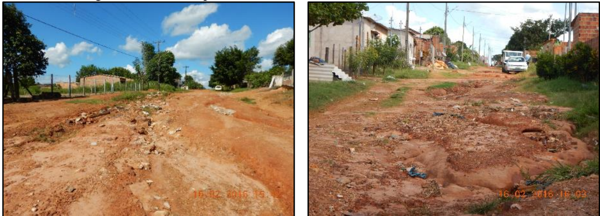
Figura 41. Vias não pavimentadas com erosões decorrentes de enxurradas
