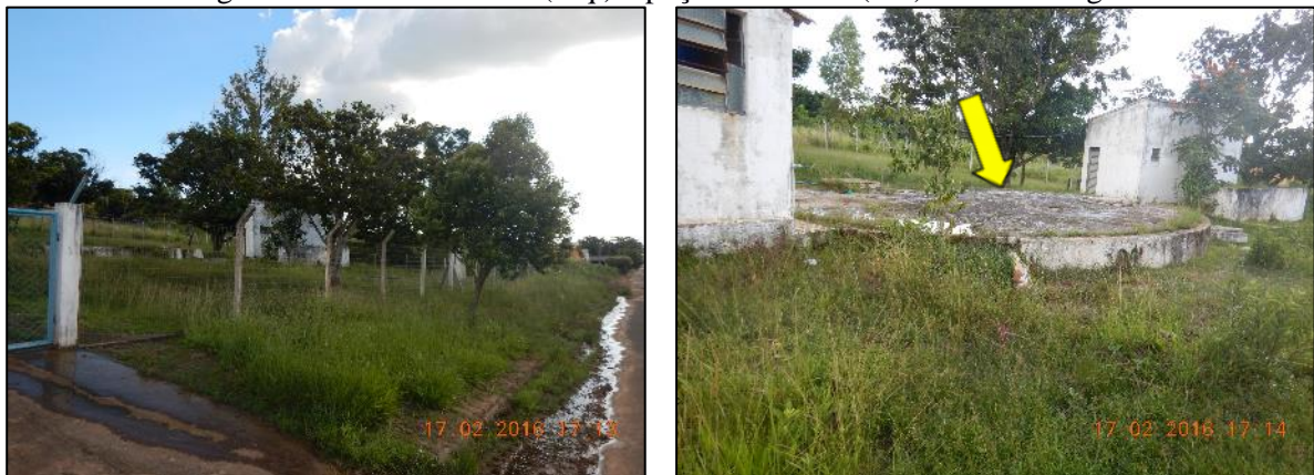
Figura 10. Vista do acesso (esq.) e poço de tomada (dir.) da mina d'água
