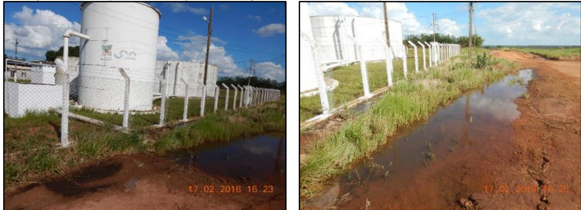
Figura 13. Lançamento da água de lavagem do filtro na rua adjacente a unidade de tratamento
