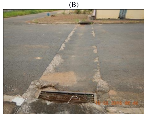
Figura 36. Dispositivos de microdrenagem existentes no núcleo urbano de Alto Garças, meio-fio e sarjeta (A), sarjetão e grelha (B), boca de lobo (C), poço de visita (D) e dissipador de energia com degraus (F)
