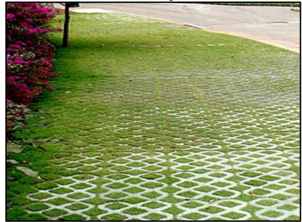
Figura 89. Pavimento poroso – concregrama instalado em passeio
