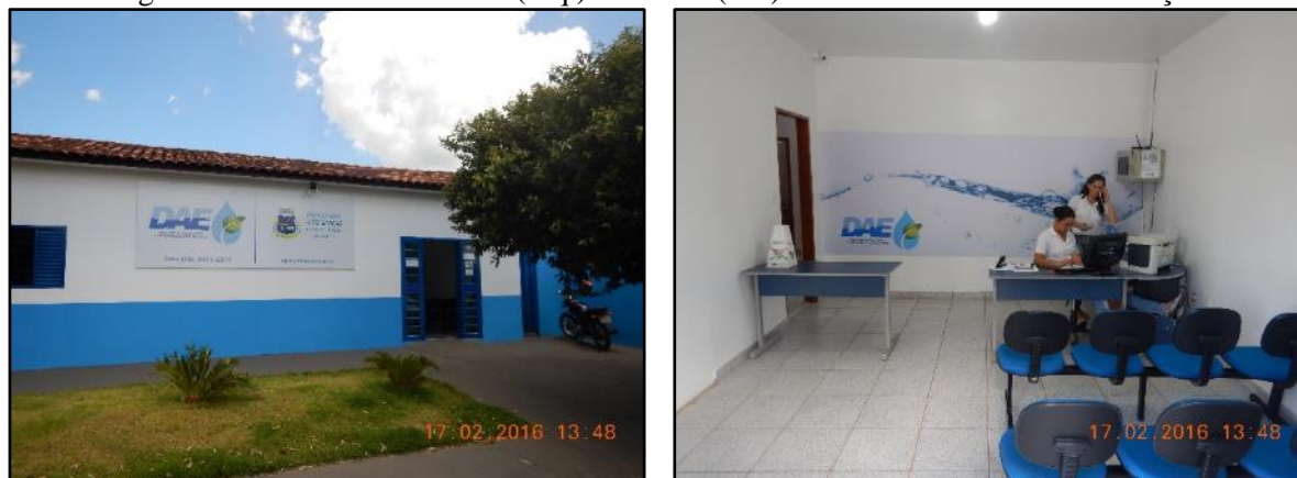
Figura 7. Vista da área externa (esq.) e interna (dir.) da sede do DAE de Alto Garças
