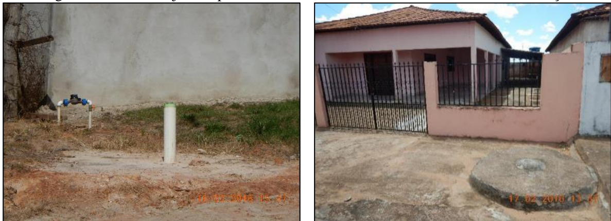
Figura 30. Vista da laje e suspiros de fossas existentes no núcleo urbano de Alto Garças
