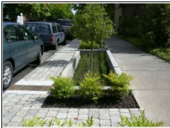
Figura 92. Trincheira de infiltração no passeio
