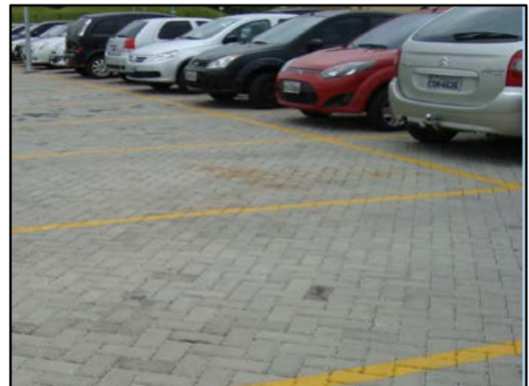
Figura 91. Pavimento poroso instalado em estacionamento
