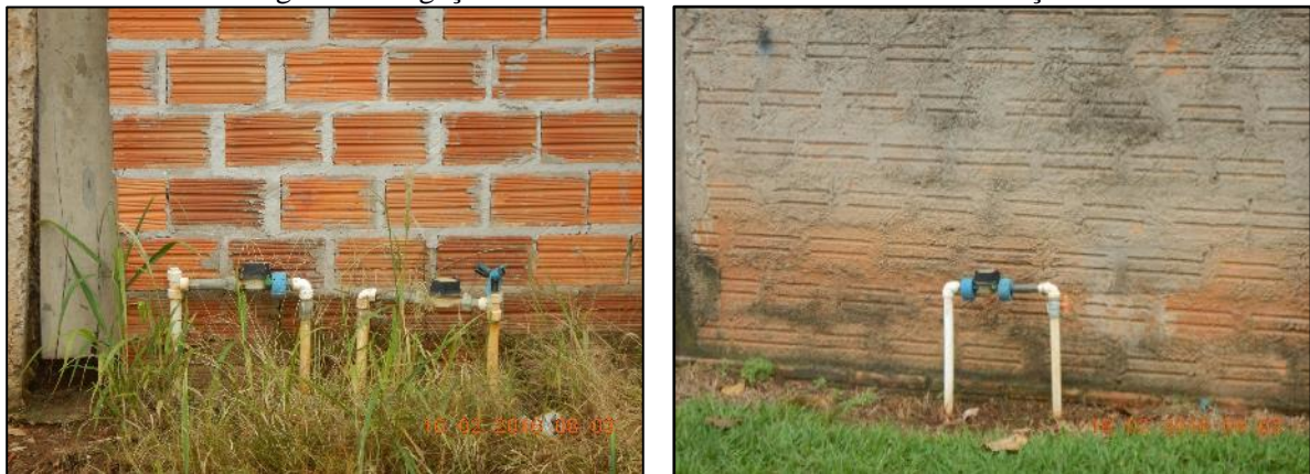
Figura 22. Ligação domiciliar no núcleo urbano de Alto Garças
