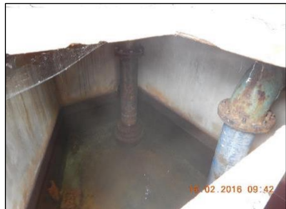
Figura 8. Barragem de nível (esq.) e poço de sucção (dir.) da captação superficial no córrego Lajeado
