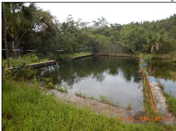
Figura 8. Barragem de nível (esq.) e poço de sucção (dir.) da captação superficial no córrego Lajeado
