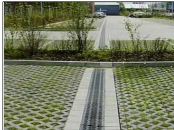
Figura 93. Trincheira de infiltração no estacionamento
