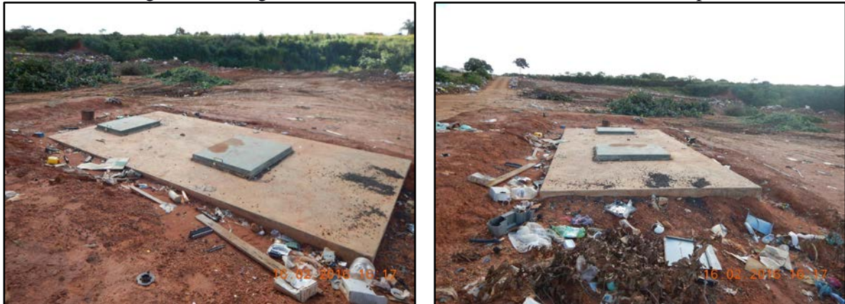
Figura 57. Abrigo de alvenaria enterrado na área do lixão do município
