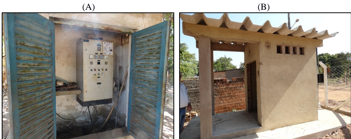
Figura 14. (A) Abrigo para o quadro de comando (B) Construção da nova estrutura para abrigo do comando elétrico
