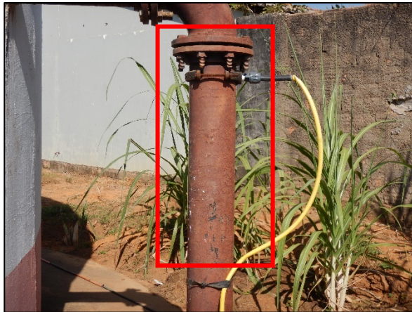
Figura 12. (A) Tubulação de inserção da solução de cloro na tubulação de entrada do reservatório (B) Produto químico utilizado no preparo da solução desinfetante
