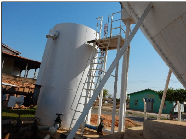
Figura 11. (A) Filtro russo (B) Galeria de concreto para deságue do efluente (C) Tubulação de inserção da solução de cal na saída do filtro
