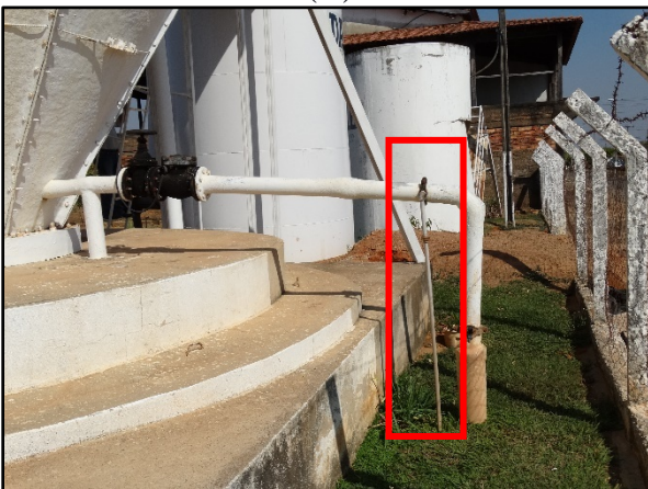
Figura 10. (A) Tubulação de aplicação do sulfato de alumínio (B) Floco-decantador situado na ETA de Araguaiana (C) Calhas onde são coletadas as águas decantadas
