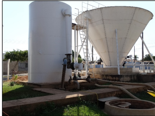
Figura 8. Visão geral da ETA
