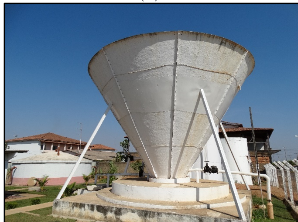
Figura 10. (A) Tubulação de aplicação do sulfato de alumínio (B) Floco-decantador situado na ETA de Araguaiana (C) Calhas onde são coletadas as águas decantadas
