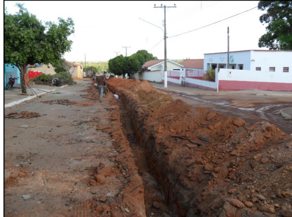
Figura 17. Execução da rede coletora (agosto/2011)
