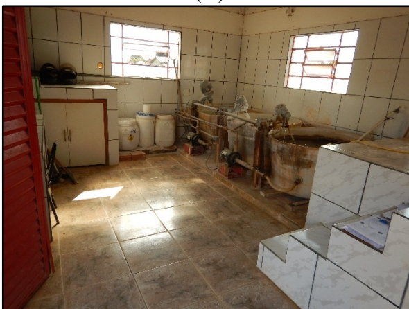
Figura 13. (A) Casa de química (B) Laboratório para realização das análises físico-químicas (C) Bombas agitadores dos reservatórios de solução
