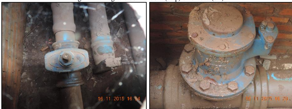
Figura 12. Registro de manobra (esq.) e ventosa (dir)
