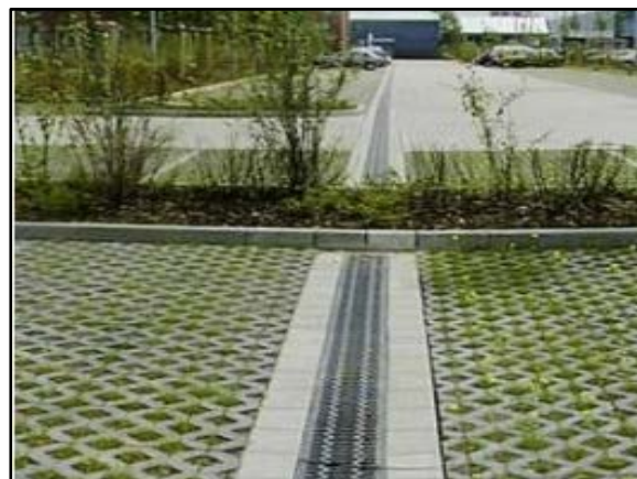
Figura 91. Trincheira de infiltração no estacionamento
