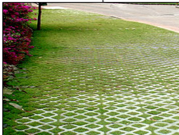
Figura 87. Pavimento poroso – concregrama instalado em passeio
