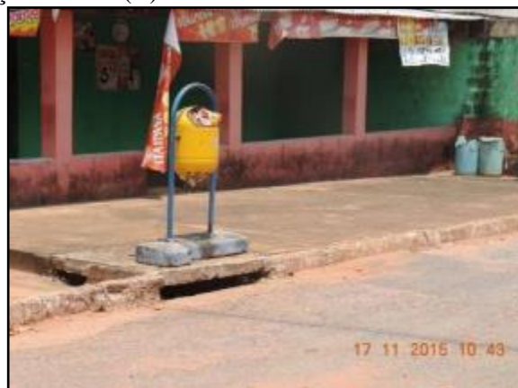
Figura 30. Microdrenagem – meio-fio e sarjeta e boca de lobo (A), bocas de lobo (B) e boca de lobo com grade e poço de visita (C)
