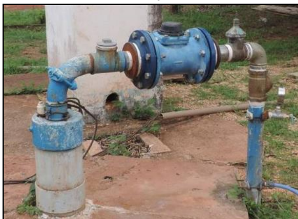
Figura 8. Visão geral do barrilete dos poços em operação no SAA de Arenópolis PT-01 PT-03
