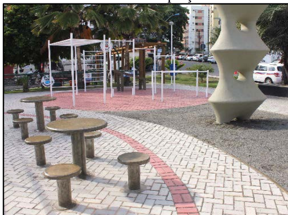
Figura 86. Pavimento poroso – piso intertravado instalado em praça
