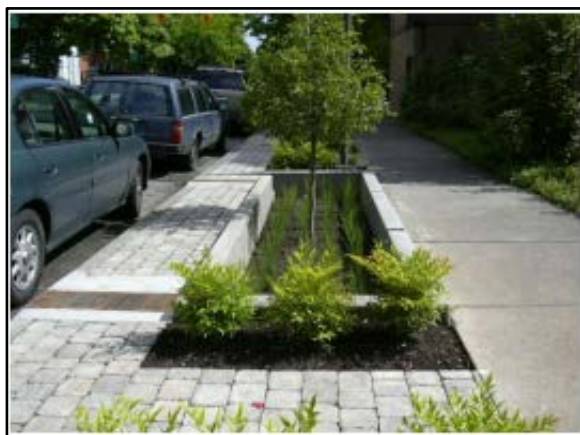
Figura 90. Trincheira de infiltração no passeio
