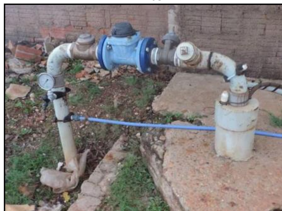
Figura 8. Visão geral do barrilete dos poços em operação no SAA de Arenópolis PT-01 PT-03
