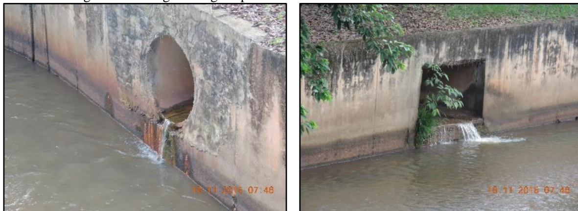
Figura 27. Deságue de águas pluviais no trecho canalizado do ribeirão Areias
