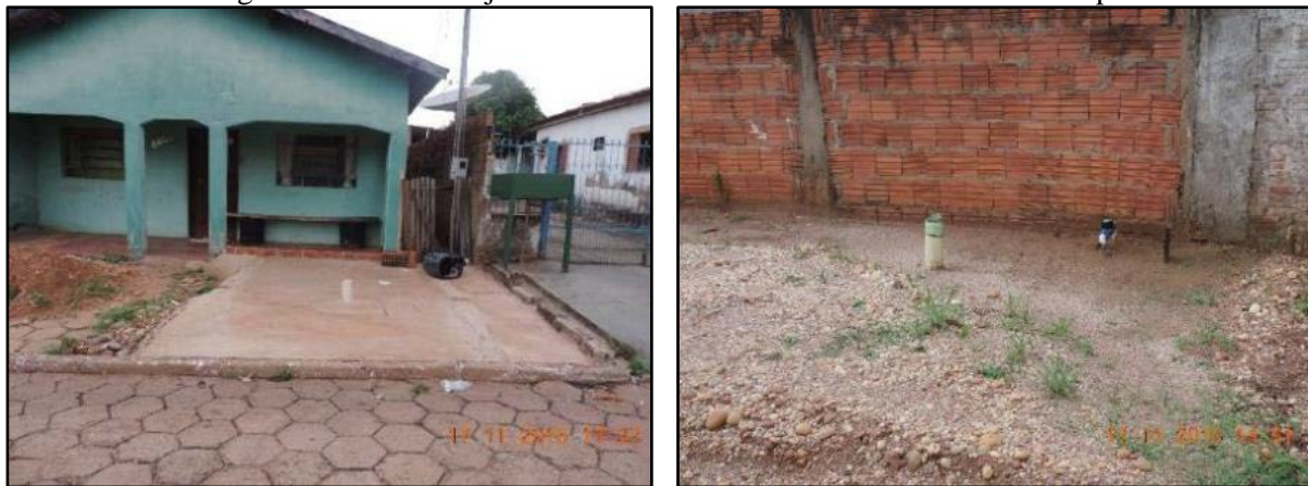
Figura 21. Vista da laje de fossa existente no núcleo urbano de Arenápolis
