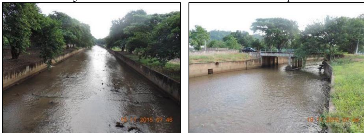
Figura 26. Trecho do canal existente na área urbana de Arenópolis
