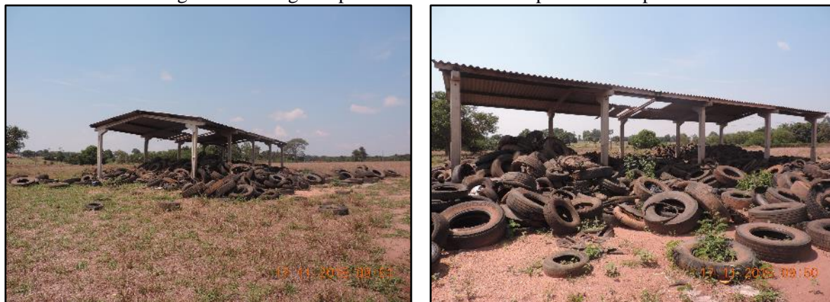
Figura 61. Abrigo de pneus usados no município de Arenópolis
