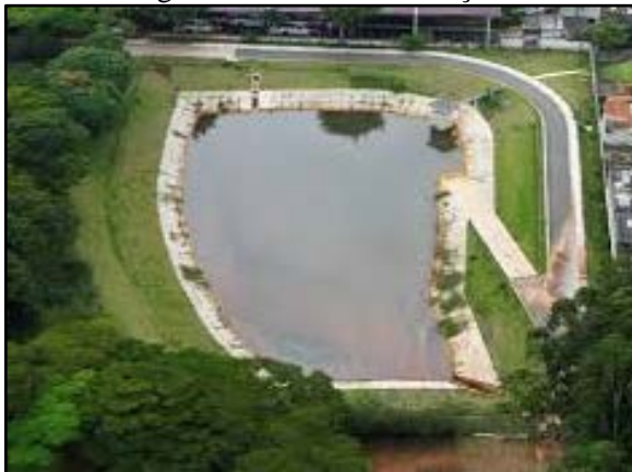
Figura 94. Bacia de detenção
