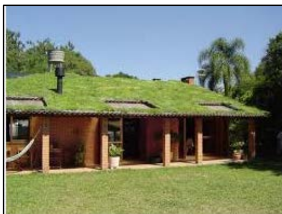
Figura 85. Telhado verde com plantas
