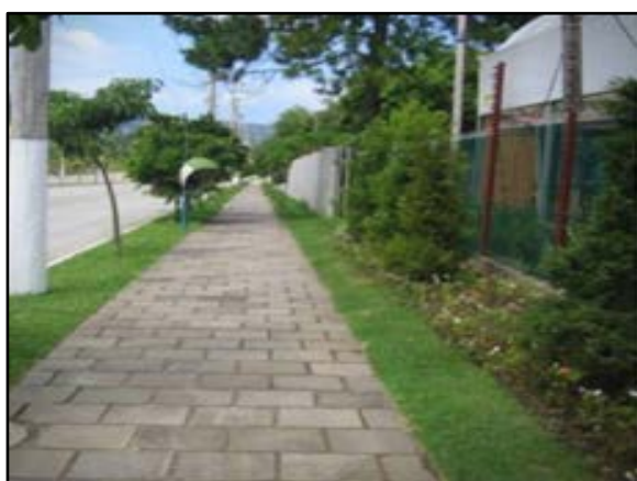
Figura 92. Vala de detenção ao longo da rua
