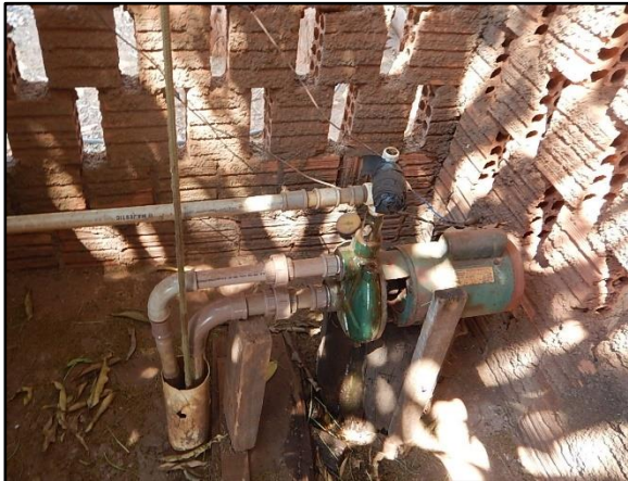
Figura 52. Vista da boca do poço tubular e da bomba (a), as precariedades do abrigo (b) e a locação de uma fossa ao lado do poço, Boa Esperança, Brasnorte-MT
