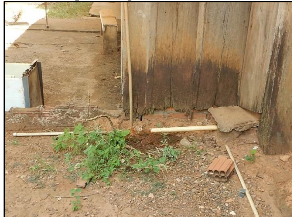
Figura 94. Disposição de efluente de pia e tanque a céu aberto, Mundo Novo, Brasnorte-MT
