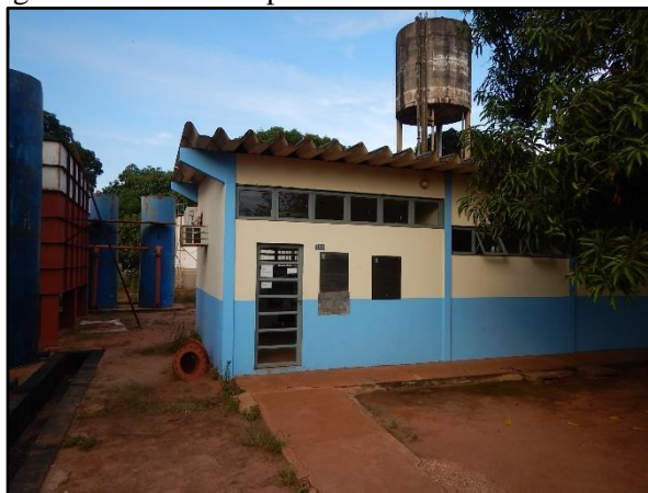
Figura 6. Fachada do prédio do DAE de Brasnorte-MT
