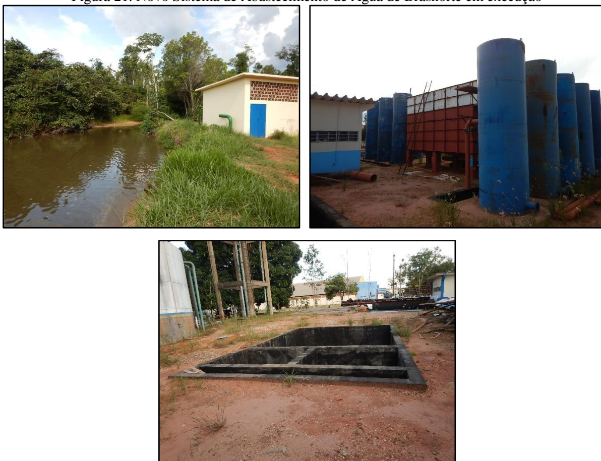
Figura 21. Novo Sistema de Abastecimento de Água de Brasnorte em execução
