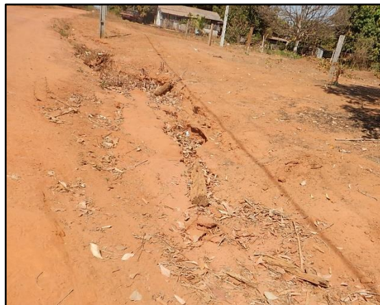
Figura 57. Rua não pavimentada (a) processos erosivos em via não pavimentada (b), Boa Esperança, Brasnorte-MT
