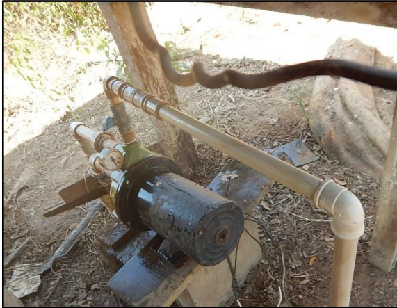
Figura 61. Vista da boca do poço tubular e da bomba (a), as precariedades do abrigo (b) e o reservatório, Vila Nova, Brasnorte-MT
