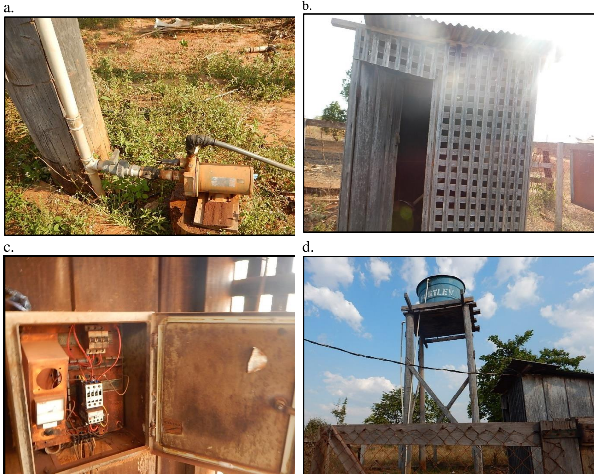
Figura 69. Vista da boca do poço tubular e da bomba (a), as precariedades do abrigo (b), quadro de comando (c) e o reservatório (d), São Bento, Brasnorte-MT
