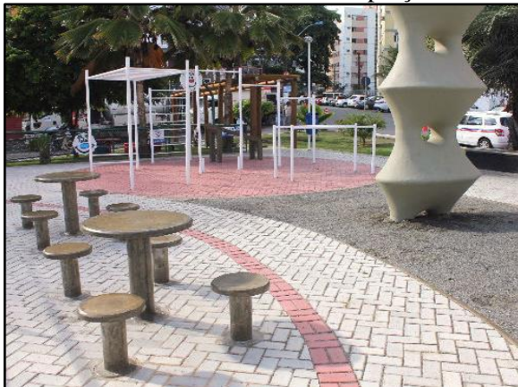
Figura 129. Pavimento poroso – piso intertravado instalado em praça
