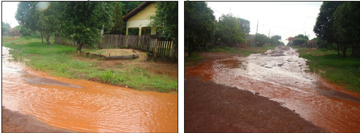
Figura 31. Vias com fortes alagamentos em Brasnorte-MT
