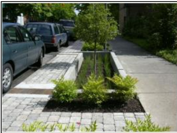
Figura 133. Trincheira de infiltração no passeio
