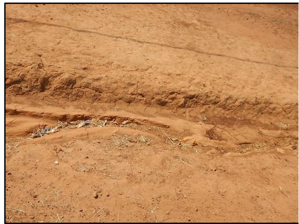
Figura 95. Rua não pavimentada (a) processos erosivos em via não pavimentada (b), Mundo Novo, Brasnorte-MT
