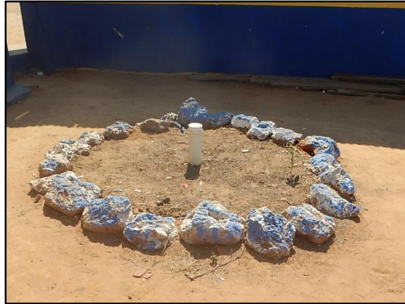
Figura 64. Vista exterior de fossa com suspiro (a e b), Vila Nova, Brasnorte-MT
