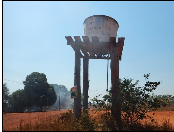
Figura 53. Reservatório elevado, Boa Esperança, Brasnorte-MT
