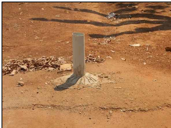
Figura 93. Vista exterior de fossa com suspiro (a e b), Mundo Novo, Brasnorte-MT
