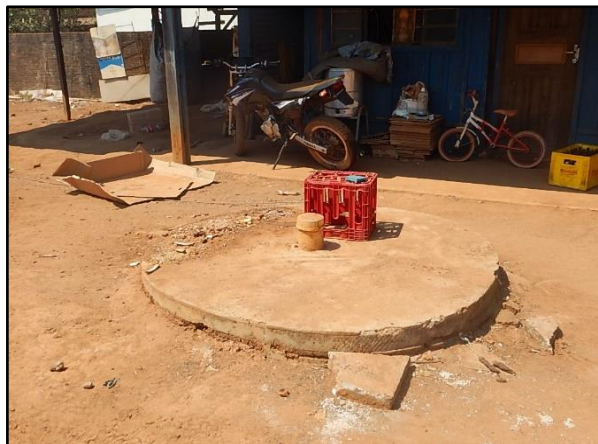
Figura 93. Vista exterior de fossa com suspiro (a e b), Mundo Novo, Brasnorte-MT
