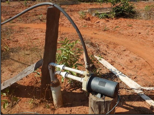
Figura 102. Vista da boca do poço tubular e da bomba 2 (a), quadro de comando (b), e área do poço (d), Bom Futuro, Brasnorte-MT
