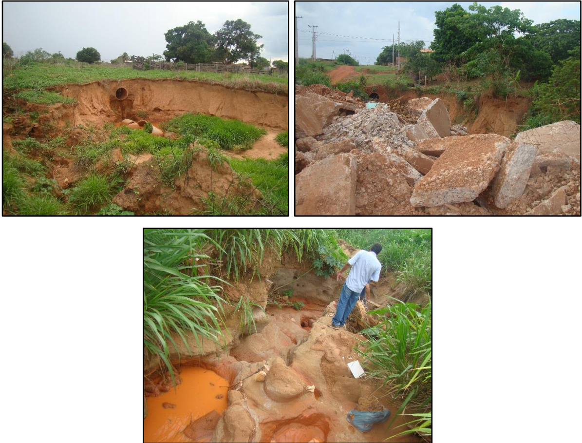
Figura 33. Voçorocas na sede urbana de Brasnorte-MT
