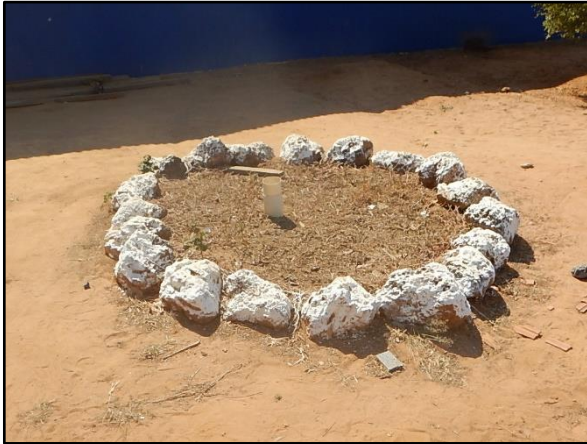
Figura 64. Vista exterior de fossa com suspiro (a e b), Vila Nova, Brasnorte-MT
