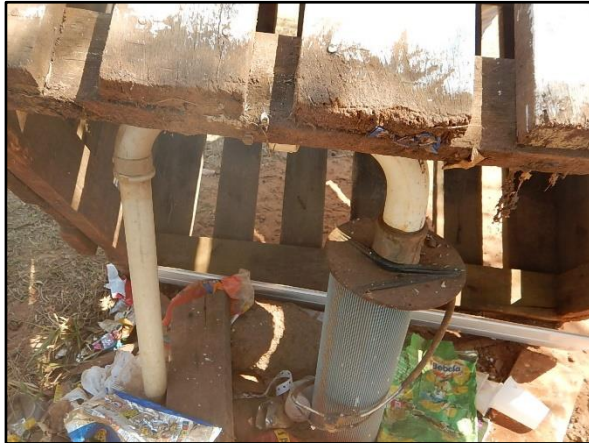
Figura 63. Poço tubular individual com bomba submersa (a) e poço individual tipo cacimba com bomba submersa (b), Vila Nova, Brasnorte-MT
