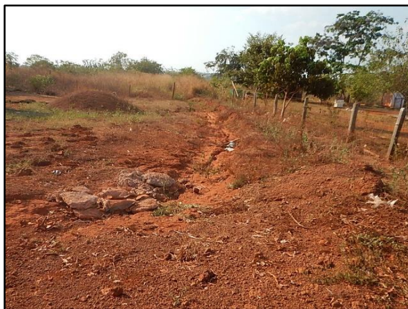
Figura 75. Rua não pavimentada (a) processos erosivos em via não pavimentada (b), São Bento, Brasnorte-MT
