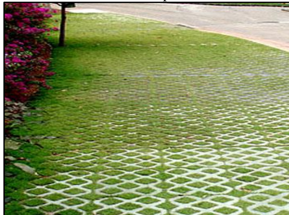
Figura 130. Pavimento poroso – concregrama instalado em passeio
