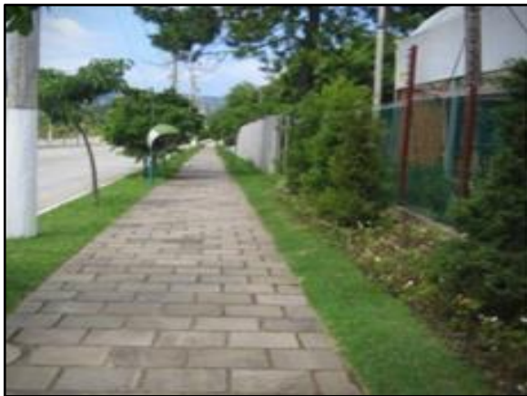
Figura 135. Vala de retenção ao longo da rua
