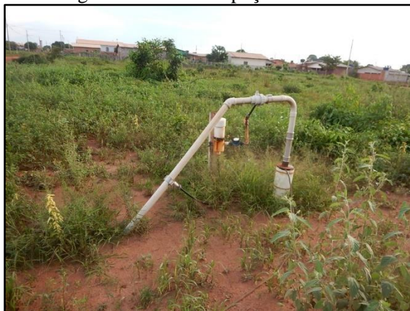
Figura 14. Estrutura poço tubular 07
