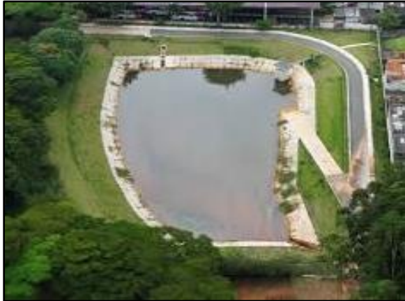
Figura 125. Bacia de deteFnção
