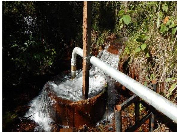
Figura 90. Captação superficial
