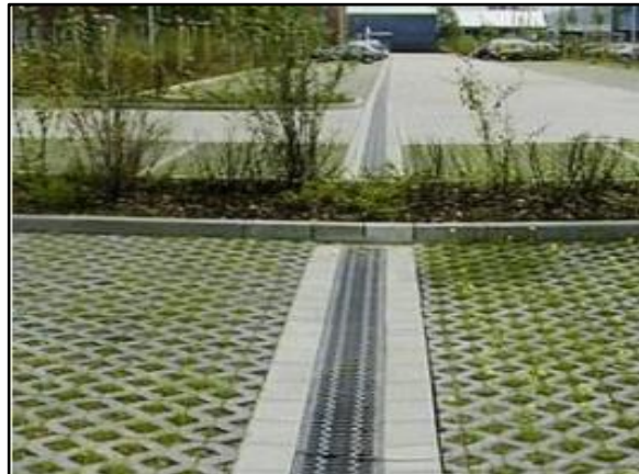
Figura 122. Trincheira de infiltração no estacionamento
