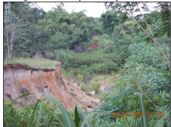
Figura 46. Erosão provocado pela chuva
