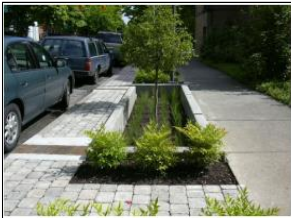
Figura 121. Trincheira de infiltração no passeio
