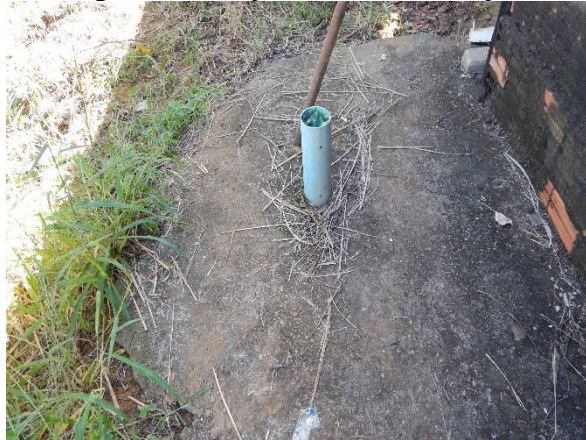
Figura 94. Tapa da fossa com suspiro
