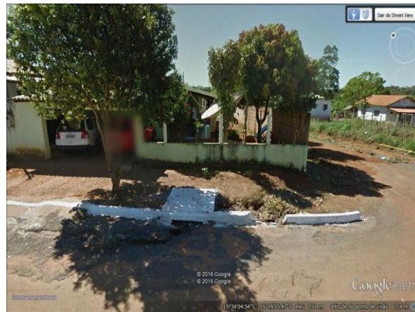
Figura 41. Via pavimentada com boca de lobo
