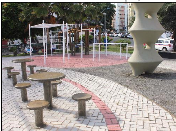
Figura 117. Pavimento poroso – piso intertravado instalado em praça
