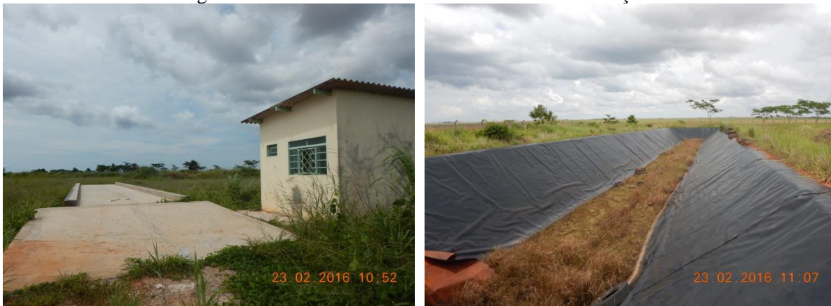
Figura 51. Área do aterro sanitário em fase de construção
