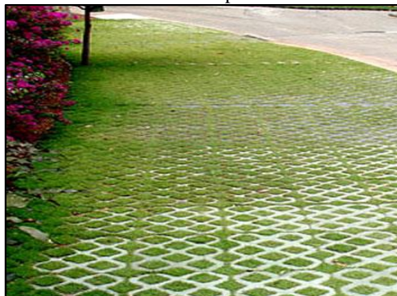
Figura 118. Pavimento poroso – concregrama instalado em passeio
