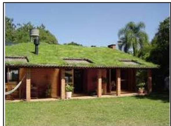
Figura 116. Telhado verde com plantas
