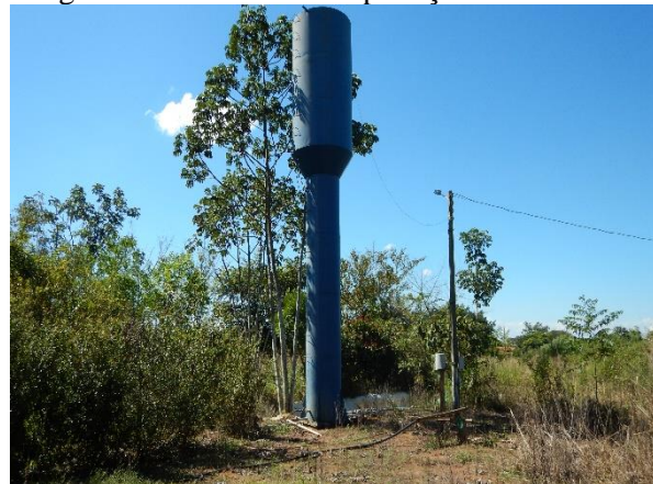
Figura 92. Reservatório tipo taça metálico 02.
