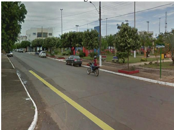
Figura 40. Via pavimentadas com meio fio e sarjeta
