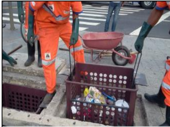
Figura 113. Cesta acoplada à boca do bueiro
