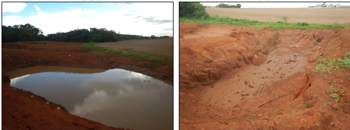
Figura 15. Bacias de infiltração na sede urbana de Campos de Júlio (A) (B)
