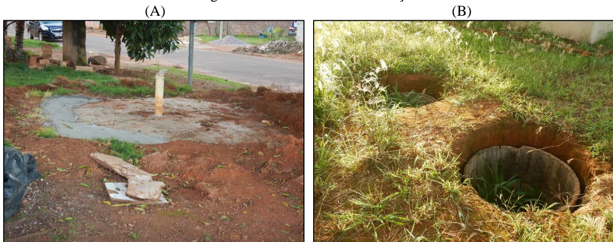
Figura 14. Sistema de tratamento individual por fossa (A) Visão de fossa construída (B) Fossa séptica seguida de sumidouro em construção
