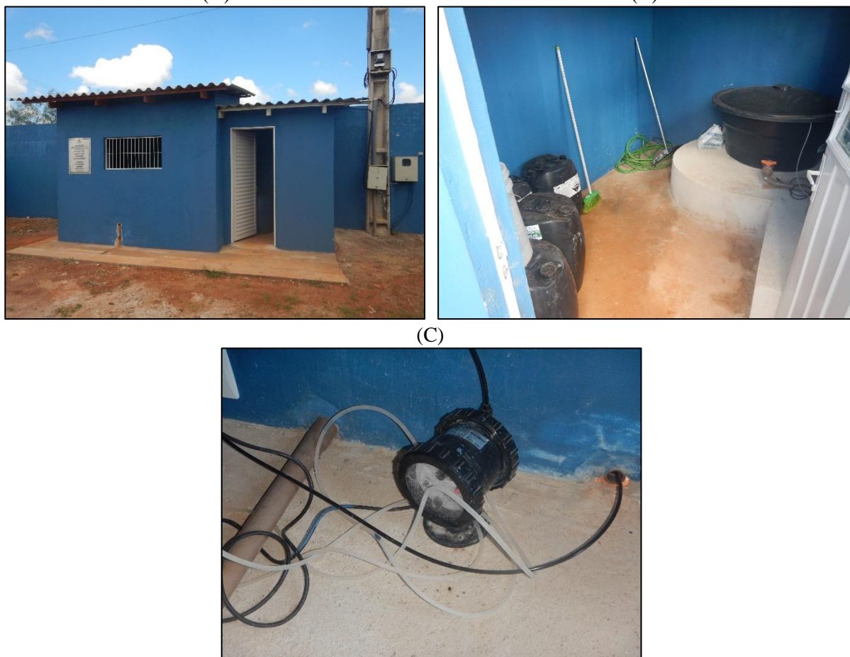
Figura 10. (A) Estrutura de alvenaria do PT-03 para abrigo do sistema de cloração (B) Reservatório de diluição do hipoclorito de sódio (C) Bomba dosadora
