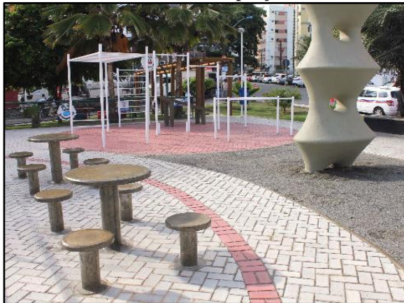
Figura 54. Pavimento poroso – piso intertravado instalado em praça
