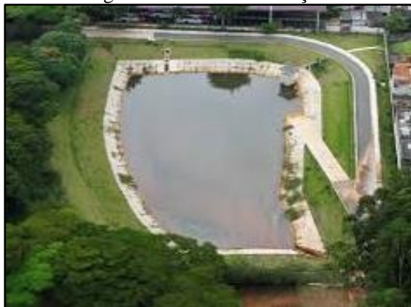
Figura 60. Bacia de detenção
