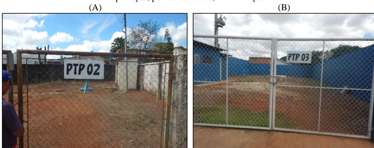
Figura 8. (A) Portão de acesso do PT-02 com identificação (B) Visão geral do PT-03 com cerca de proteção, portão de acesso, identificação
