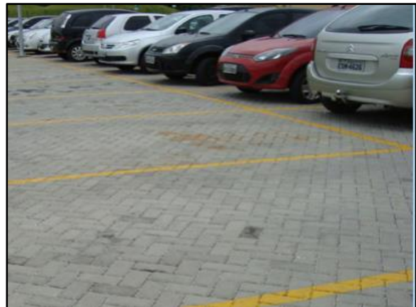
Figura 57. Pavimento poroso instalado em estacionamento
