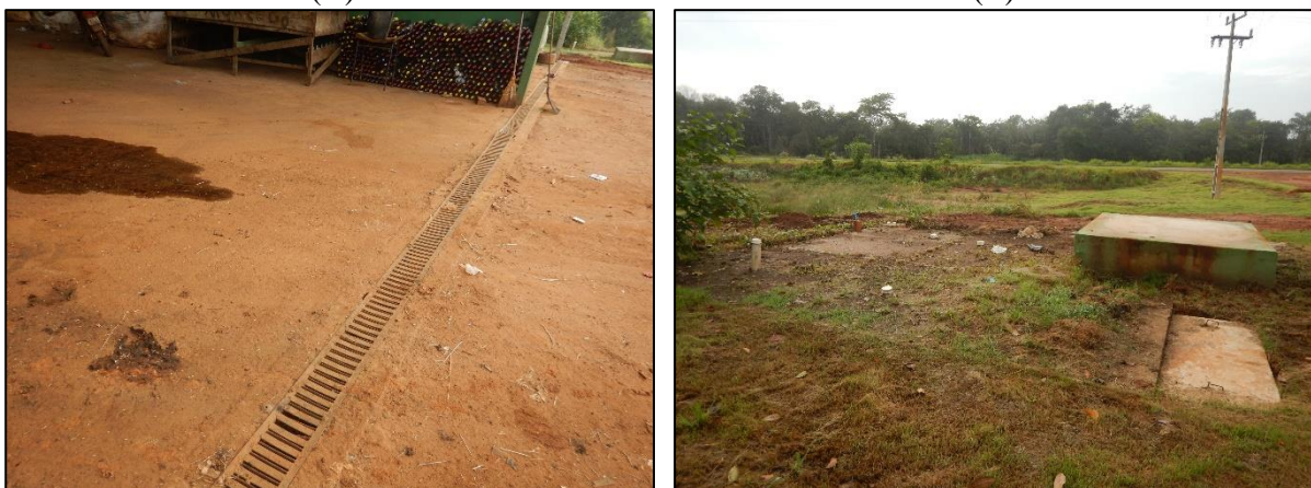
Figura 23. (A) Canaleta de coleta de chorume (B) Sistema de tratamento do chorume (A) (B)
