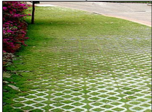
Figura 55. Pavimento poroso – concregrama instalado em passeio
