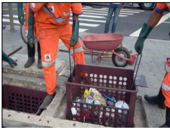
Figura 51. Cesta acoplada à boca do bueiro
