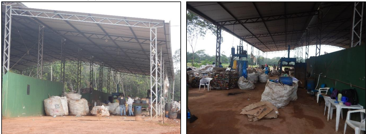
Figura 33. Galpão do centro de triagem de resíduos sólidos (A) Parte externa (B) Parte interna
