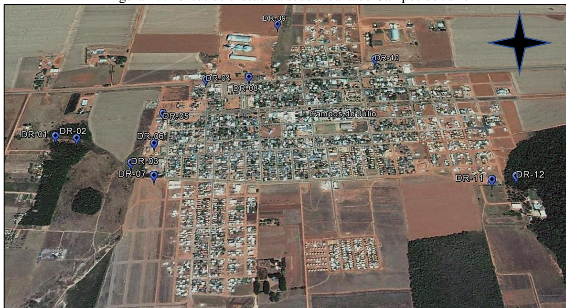
Figura 17. Pontos de erosão na sede urbana de Campos de Júlio
