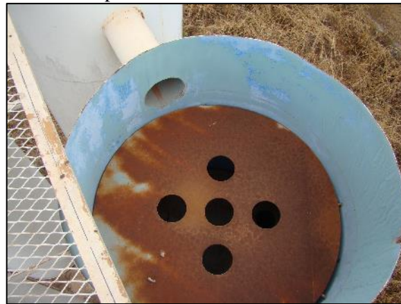
Reservatório apoiado de 250m 3
