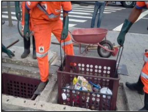
Figura 84. Cesta acoplada a boca do bueiro
