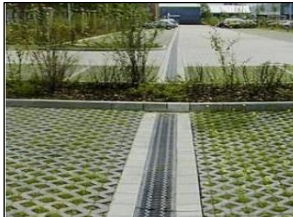
Figura 93. Trincheira de infiltração no estacionamento
