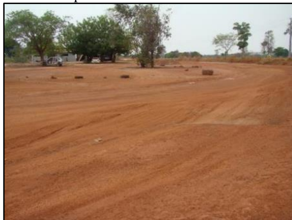
Figura 62. Início de processos erosivos em Primavera do Fontoura
