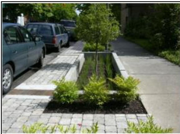
Figura 92. Trincheira de infiltração no passeio
