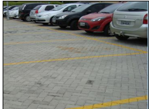
Figura 91. Pavimento poroso instalado em estacionamento
