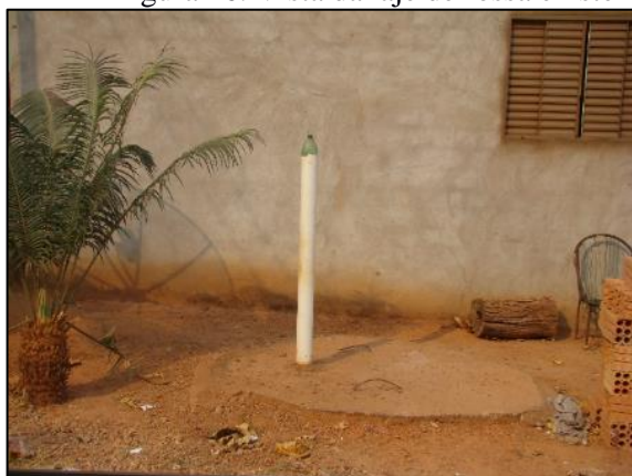
Figura 26. Vista da laje de fossa existente no núcleo urbano de Canabrava do Norte
