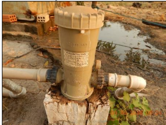
Figura 11. Clorador de contato para tratamento simplificado de cloração no SAA
