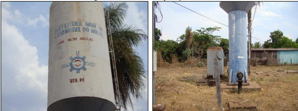
Figura 57. Reservatório tipo taça de 40 m 3
