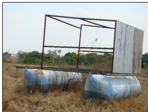
Balsa flutuante danificada e oxidada
