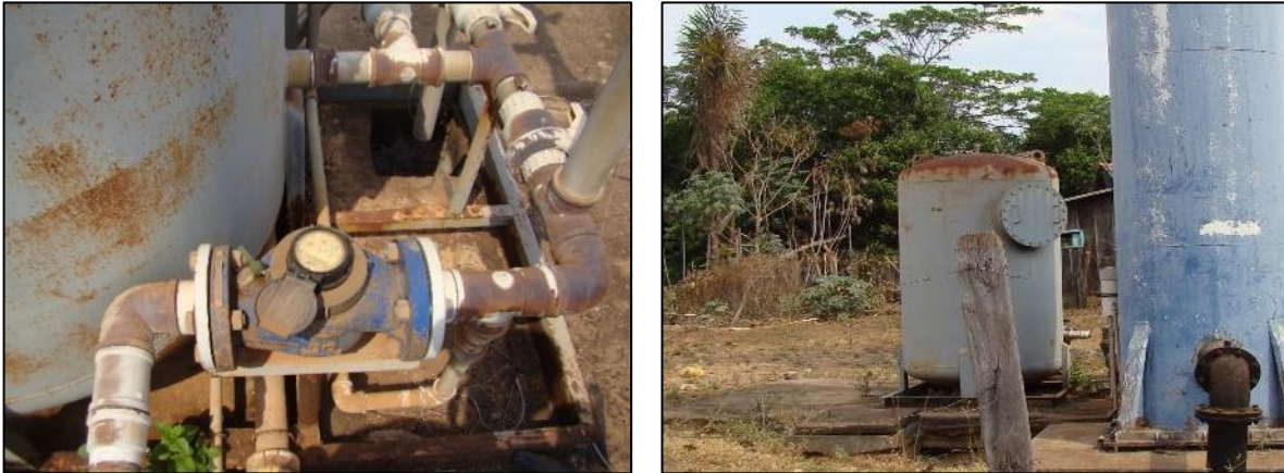
Figura 56. Vista macromedidor inoperante (esq.) e abrandador desativado (dir.)
