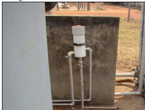
Figura 55. Clorador de contato desativado
