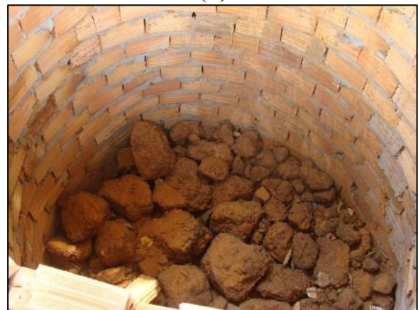
Figura 60. Vista do suspiro da fossa rudimentar (A) e fossa negra em construção (B)
