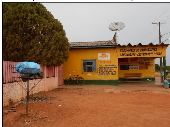
Figura 51. Ponto de parada de ônibus intermunicipal em Castanheira-MT
