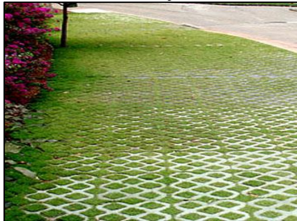
Figura 117. Pavimento poroso – concregrama instalado em passeio
