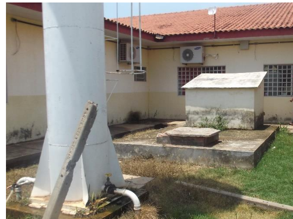
Figura 78. Vista da boca do poço tubular (a), cisterna e abrigo (b), recalque (c) e bomba de recalque (d), São Lourenço, Castanheira-MT
