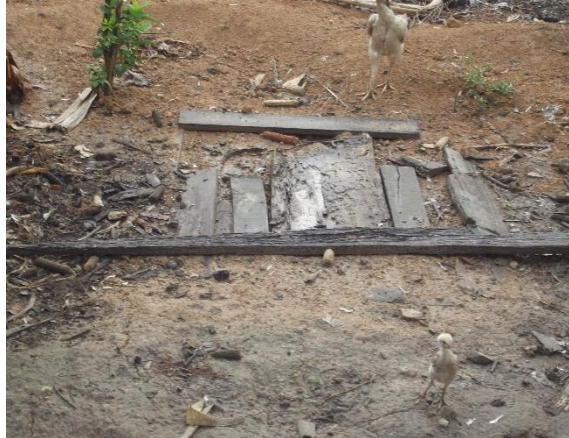
Figura 90. Vista exterior de fossa com tampa de madeira, Projeto Casulo, Castanheira-MT
