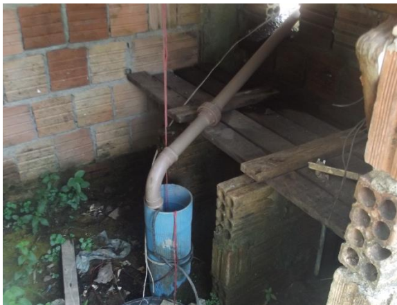
Figura 78. Vista da boca do poço tubular (a), cisterna e abrigo (b), recalque (c) e bomba de recalque (d), São Lourenço, Castanheira-MT
