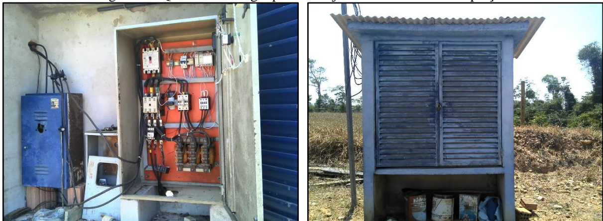
Figura 12. Quadro de energia para o conjunto motobomba da captação
