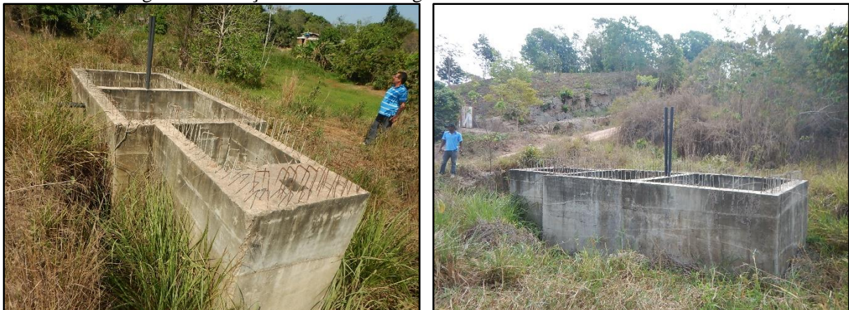
Figura 27. Estação elevatória de esgoto abandonada em Castanheira- MT
