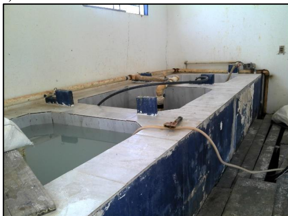
Figura 14. a) Tanques de mistura de coagulantes; b) bomba dosadora de mistura coagulante
