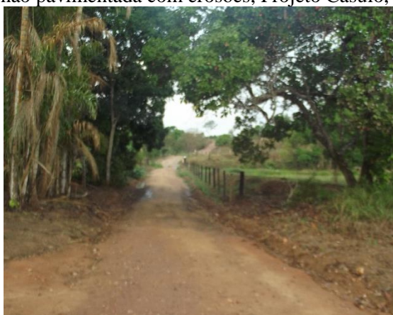
Figura 92. Via não pavimentada com erosões, Projeto Casulo, Castanheira-MT
