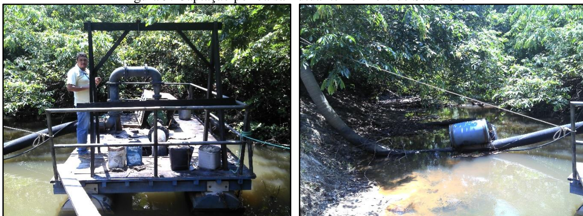
Figura 9. Captação por balsa flutuante no Rio 7 de Setembro
