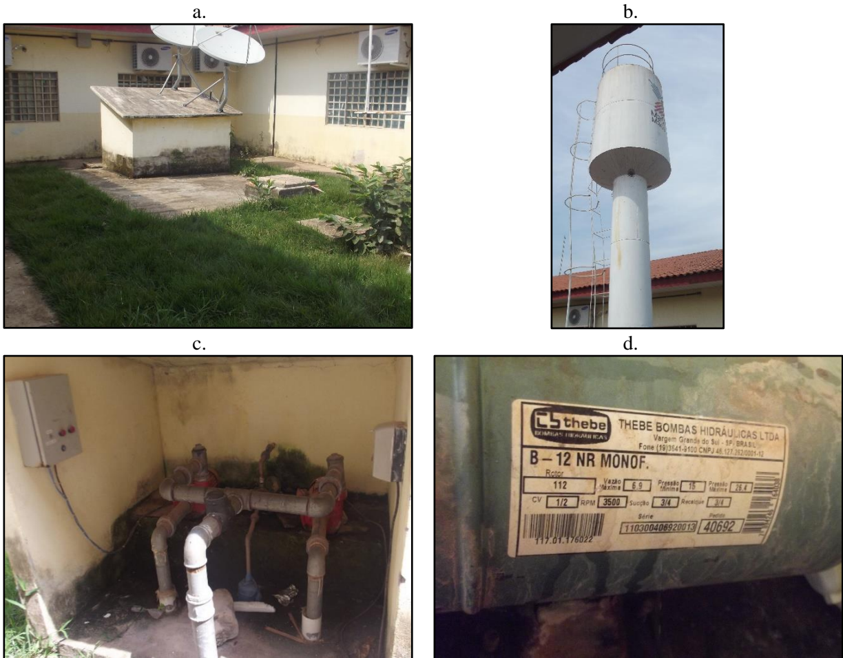
Figura 56. Cisterna e abrigo em alvenaria (a), reservatório 2 (b), Abrigo da bomba de recalque (c) e bomba de recalque (d) , Nova Conquista, Castanheira-MT
