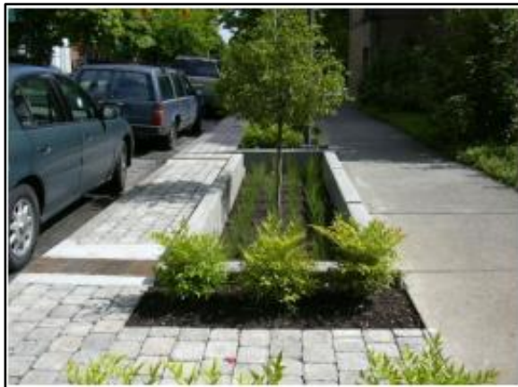
Figura 120. Trincheira de infiltração no passeio
