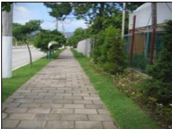
Figura 122. Vala de detenção ao longo da rua
