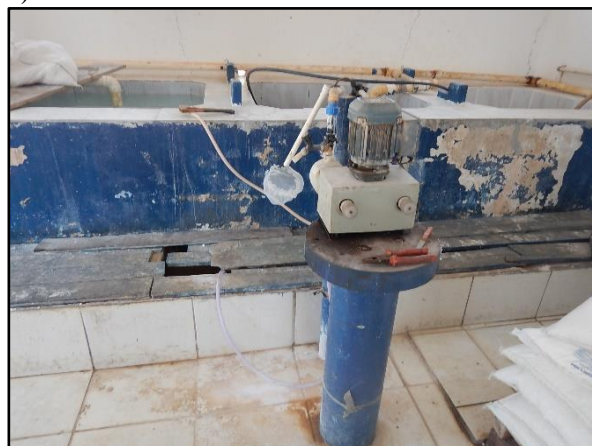
Figura 14. a) Tanques de mistura de coagulantes; b) bomba dosadora de mistura coagulante
