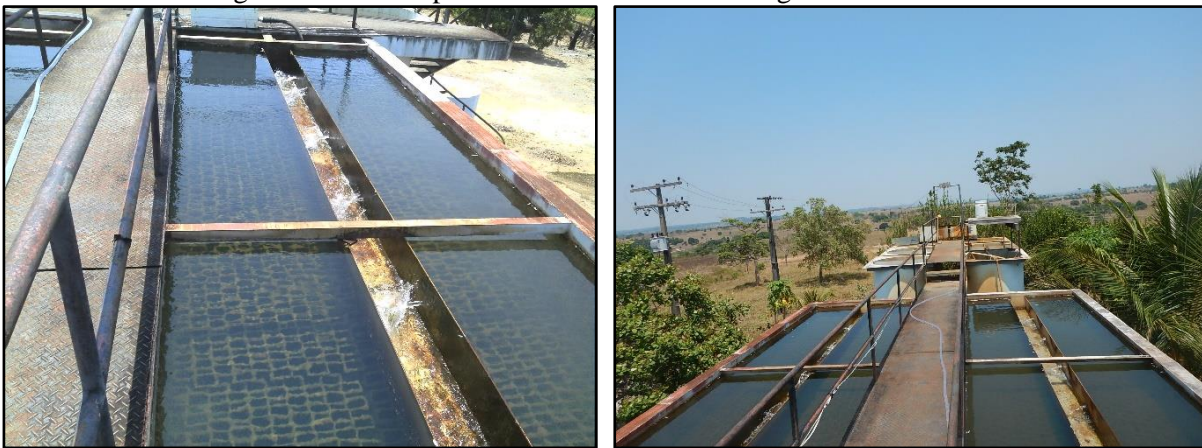
Figura 16. Vista superior dos decantadores retangulares de alta taxa
