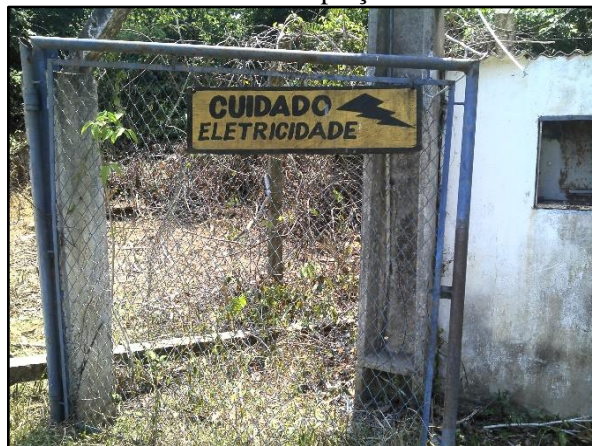
Figura 10. Entrada do acesso a captação do SAA de Castanheira
