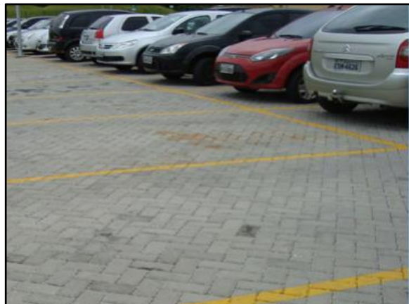
Figura 119. Pavimento poroso instalado em estacionamento
