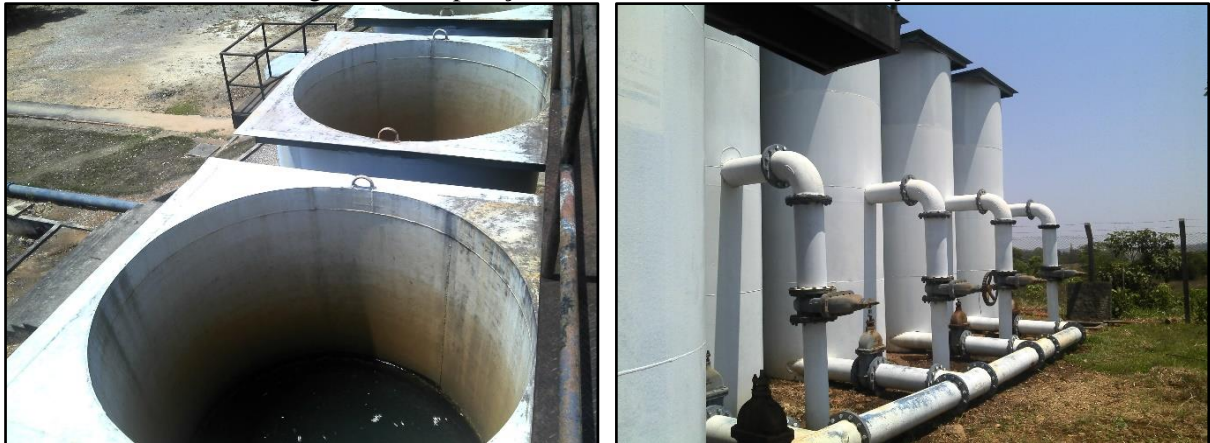
Figura 17. Disposição dos filtros e câmaras de filtração
