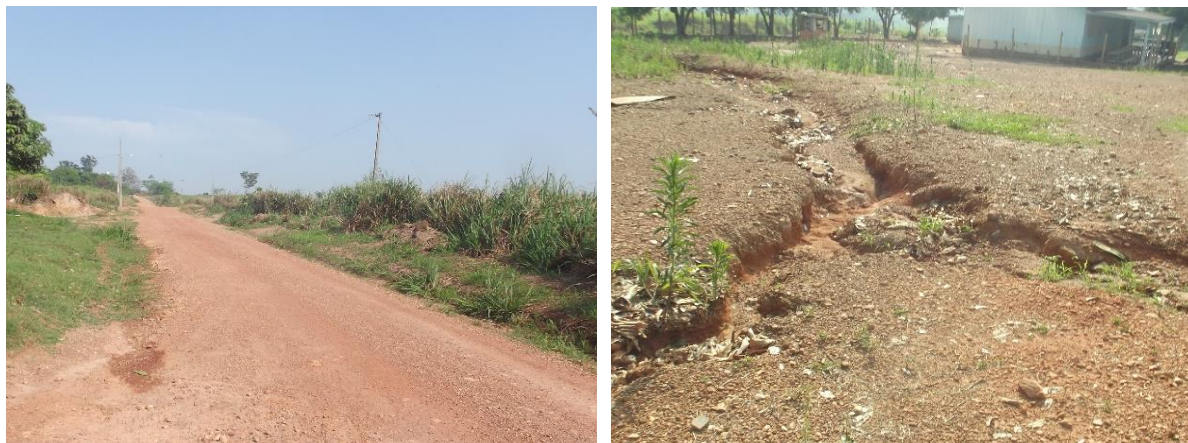
Figura 66. Via não pavimentada (a) e processo erosivos (b), Santa Eliza, Castanheira-MT
