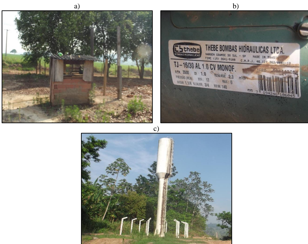
Figura 63. Vista da boca do poço tubular (a), bomba (b) e reservatório (c), Nova Conquista, Castanheira-MT
