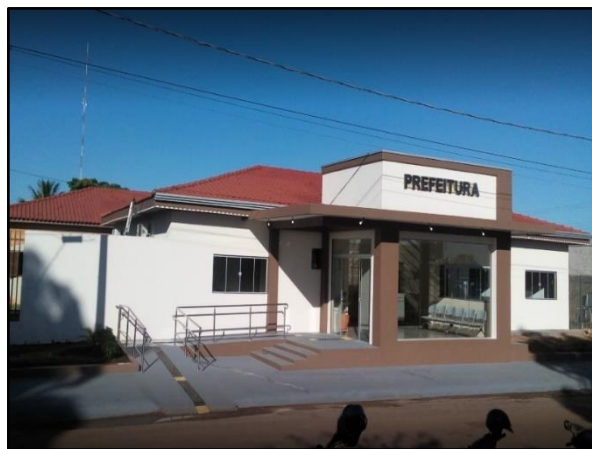
Figura 7. Fachada da Prefeitura e do DAE de Castanheira-MT
