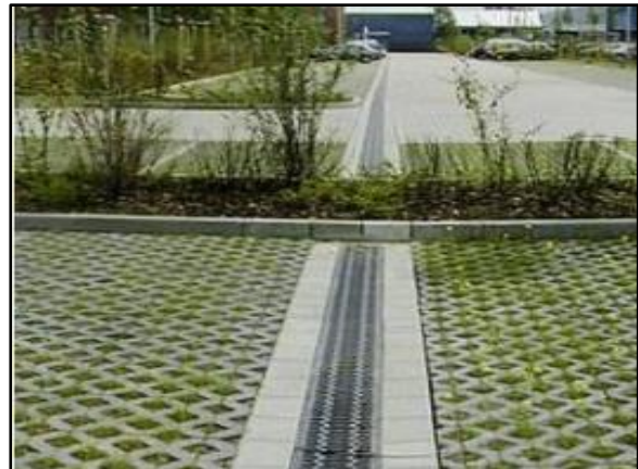
Figura 121. Trincheira de infiltração no estacionamento
