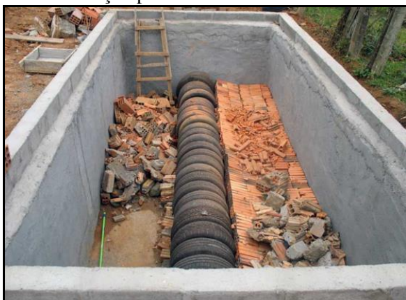
Figura 108. Método do círculo de bananeiras em execução para tratamento individual
