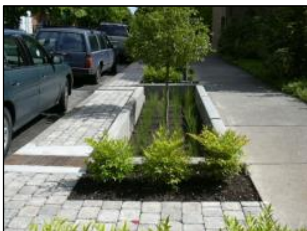
Figura 114. Trincheira de infiltração no passeio
