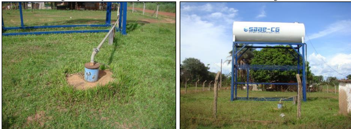
Figura 53. Poço tubular profundo e reservatório do distrito de Água Fria
