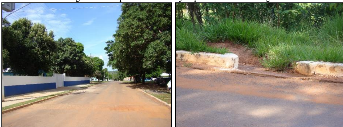
Figura 55. Via pavimentada e sarjeta para escoamento de água
