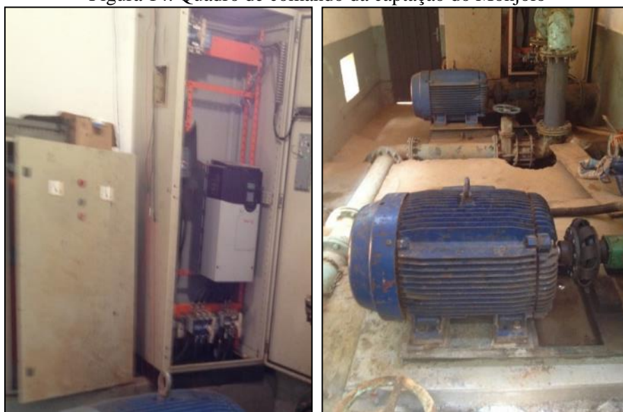
Figura 14. Quadro de comando da captação do Monjolo
