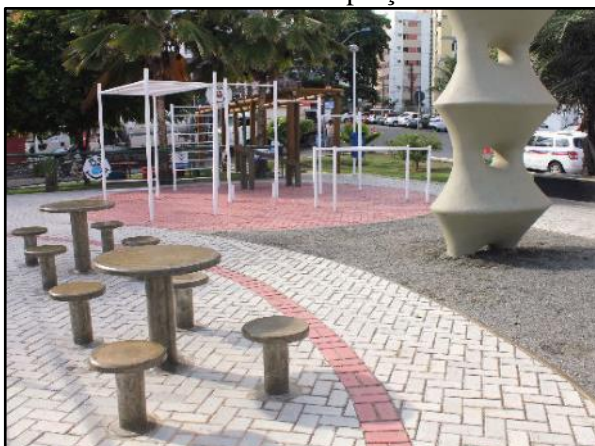
Figura 110. Pavimento poroso – piso intertravado instalado em praça
