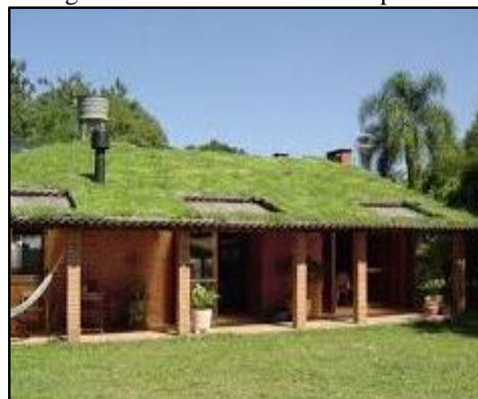
Figura 109. Telhado verde com plantas
