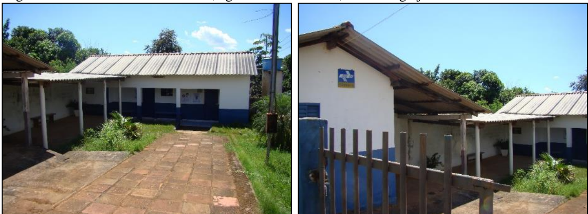
Figura 57. Unidade Básica de Saúde, agência dos Correios, escola e igreja do distrito de Rio da Casca
