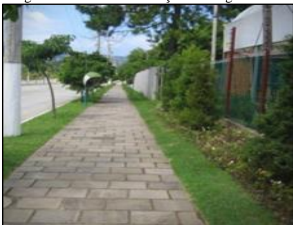
Figura 116. Vala de retenção ao longo da rua
