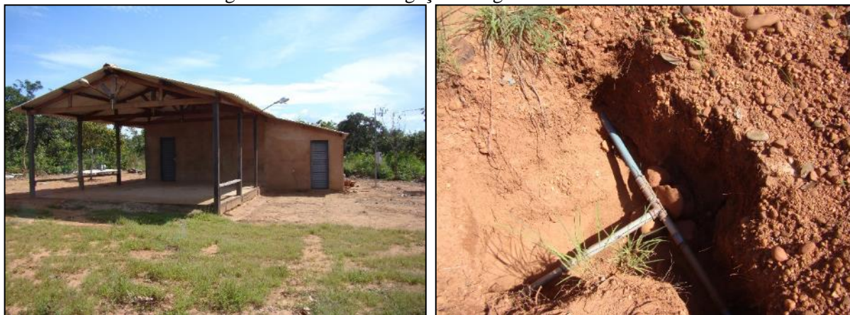
Figura 67. Barracão e ligação de água na comunidade
