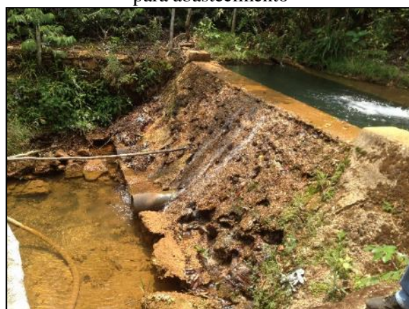
Figura 13. Barragem construída para captar água para abastecimento
