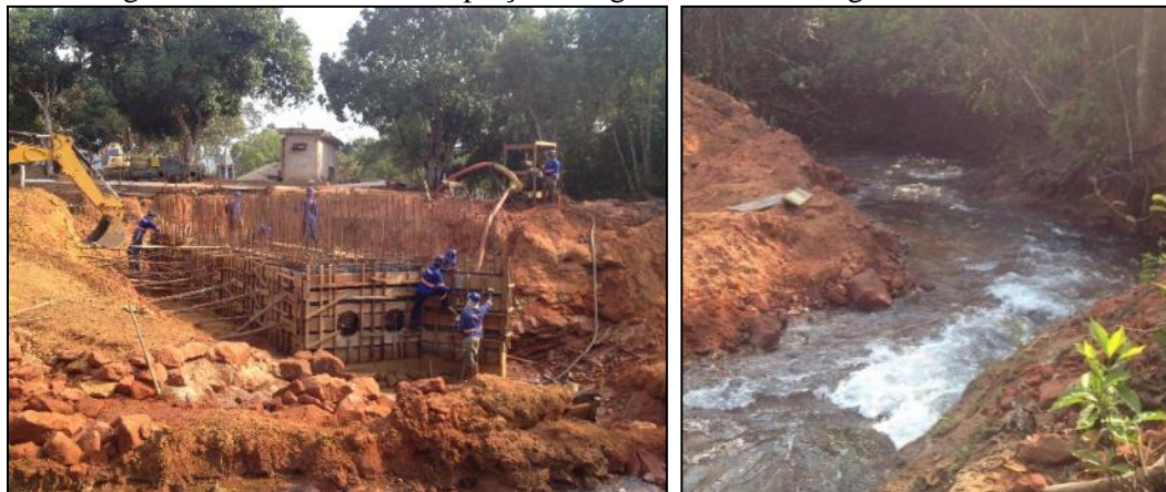
Figura 26. Obras da nova captação de água bruta no córrego Cachoeira Rica
