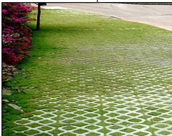
Figura 111. Pavimento poroso – concregrama instalado em passeio
