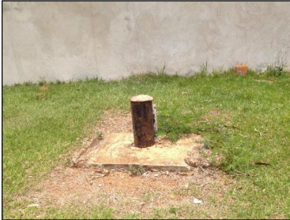
Figura 19. Poço tubular profundo desativado na sede do SAAE de Chapada dos Guimarães
