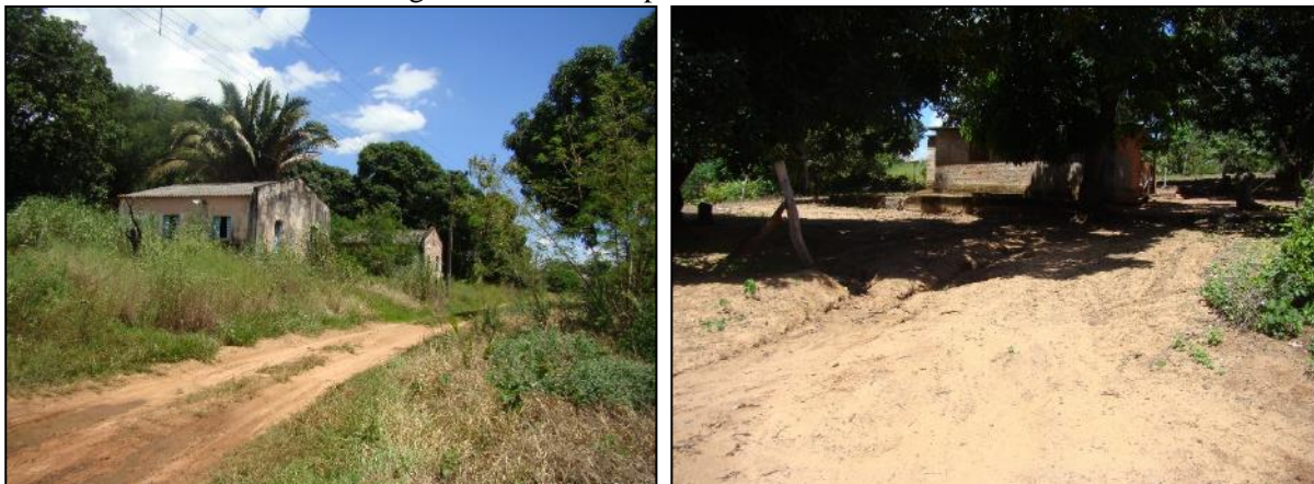
Figura 61. Vias não pavimentadas e erosões
