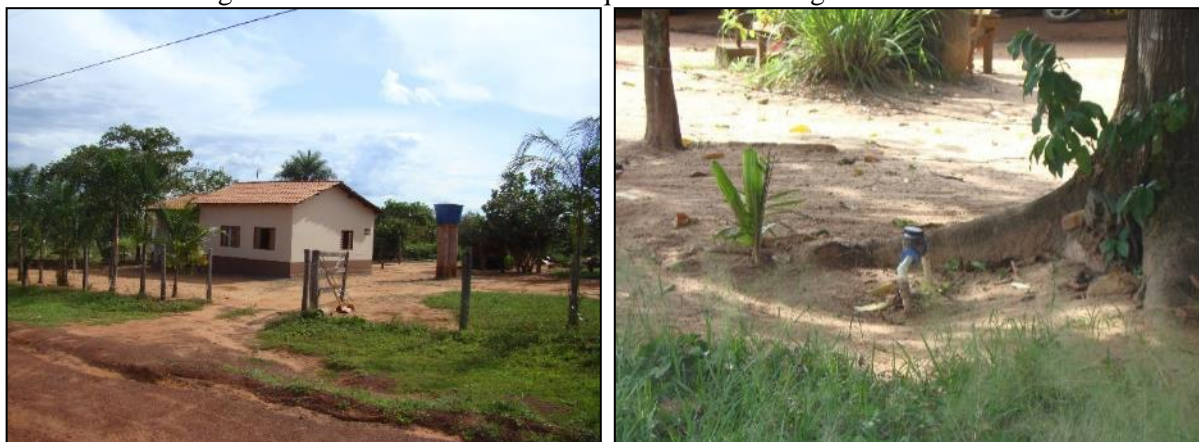
Figura 54. Residências do distrito que têm caixas d'água e hidrômetros
