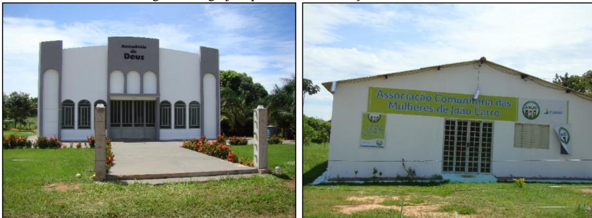
Figura 79. Igreja e prédio de Associação de João Carro
