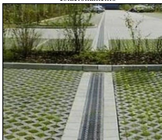
Figura 115. Trincheira de infiltração no estacionamento
