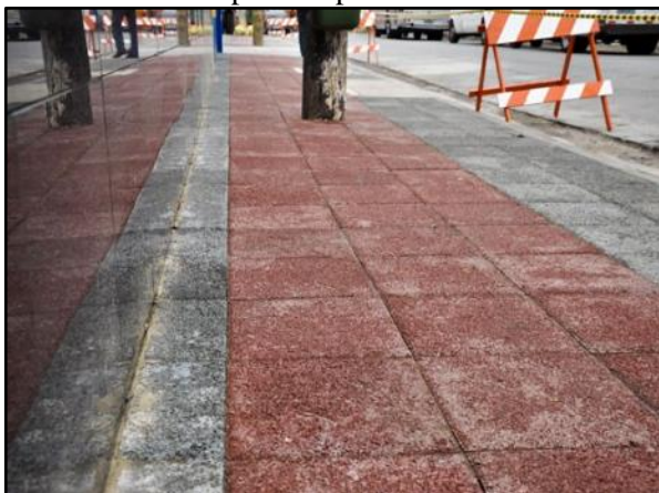
Figura 112. Pavimento poroso – instalado em passeio público
