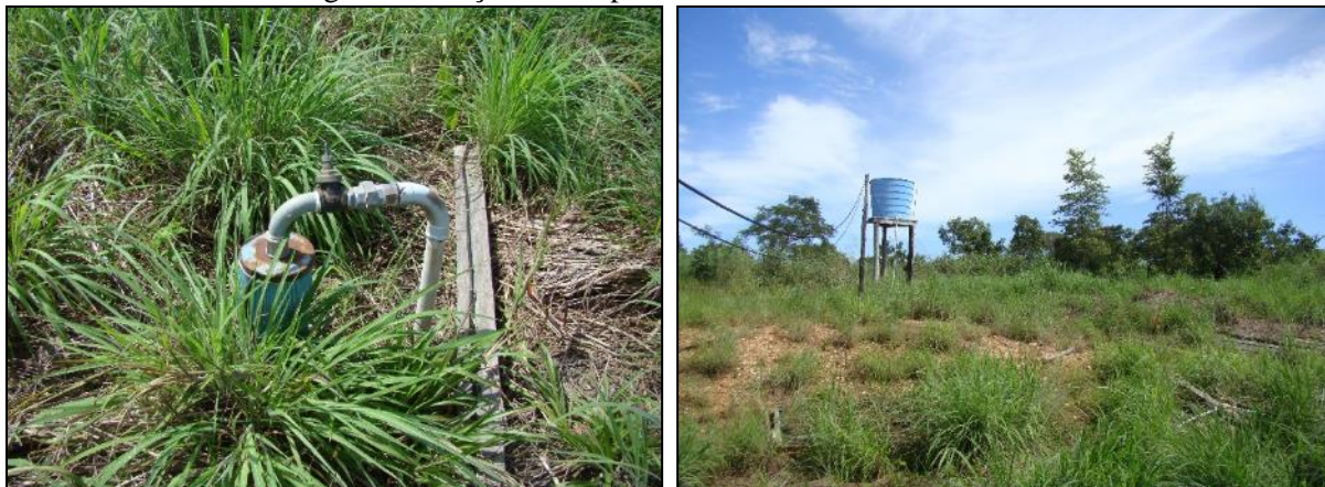
Figura 65. Poço tubular profundo e reservatório da escola
