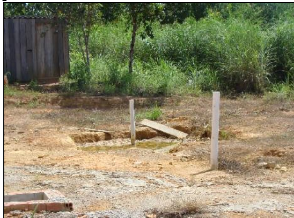
Figura 66. Fossas localizadas em residências do distrito
