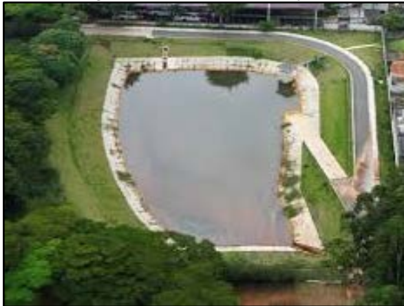
Figura 118. Bacia de detenção
