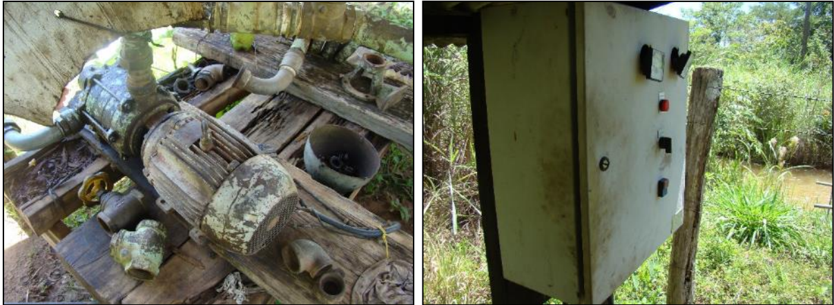
Figura 59. Conjunto motobomba utilizado para captação de água e quadro de força
