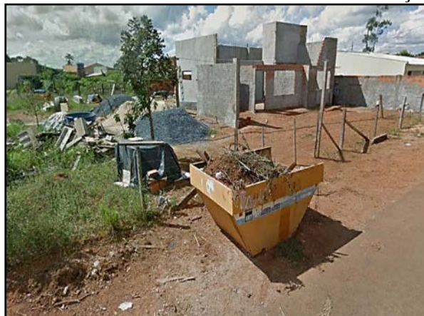
Figura 46. Acondicionamento de resíduos da construção civil
