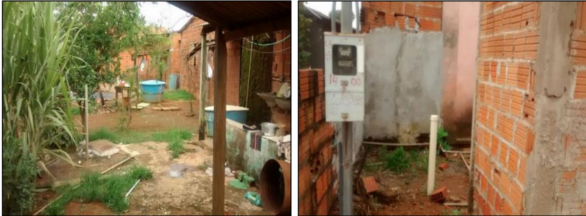
Figura 32. Fossas negras instaladas em residências de Chapada dos Guimarães
