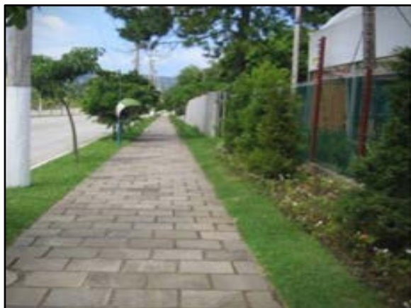
Figura 142. Vala de detenção ao longo da rua
