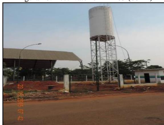
Figura 20. Reservatório REL-03 (60 m 3 )
