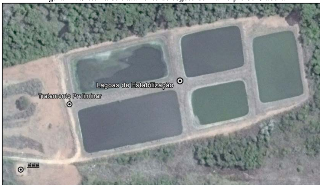
Figura 42. Sistema de tratamento de esgoto do município de Cláudia
