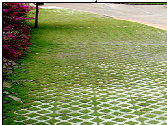
Figura 137. Pavimento poroso – concregrama instalado em passeio
