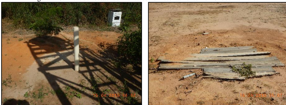
Figura 120. Vista de fossas rudimentares no Assentamento Zumbi dos Palmares
