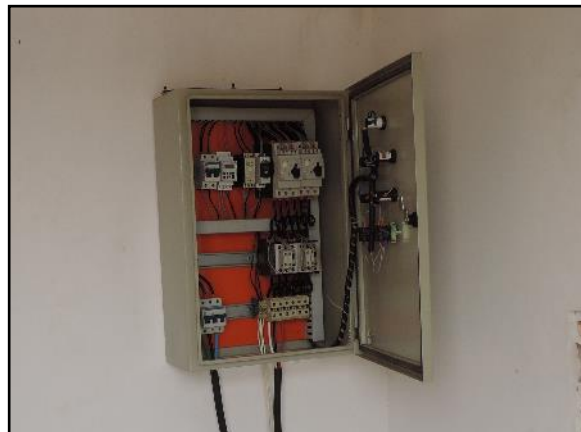
Figura 41. Abrigo e quadro de comando da EEE
