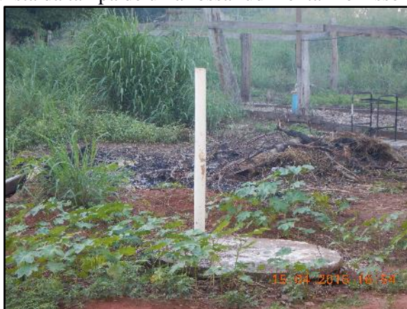
Figura 116. Vista da tampa de uma fossa rudimentar no Assentamento Keno
