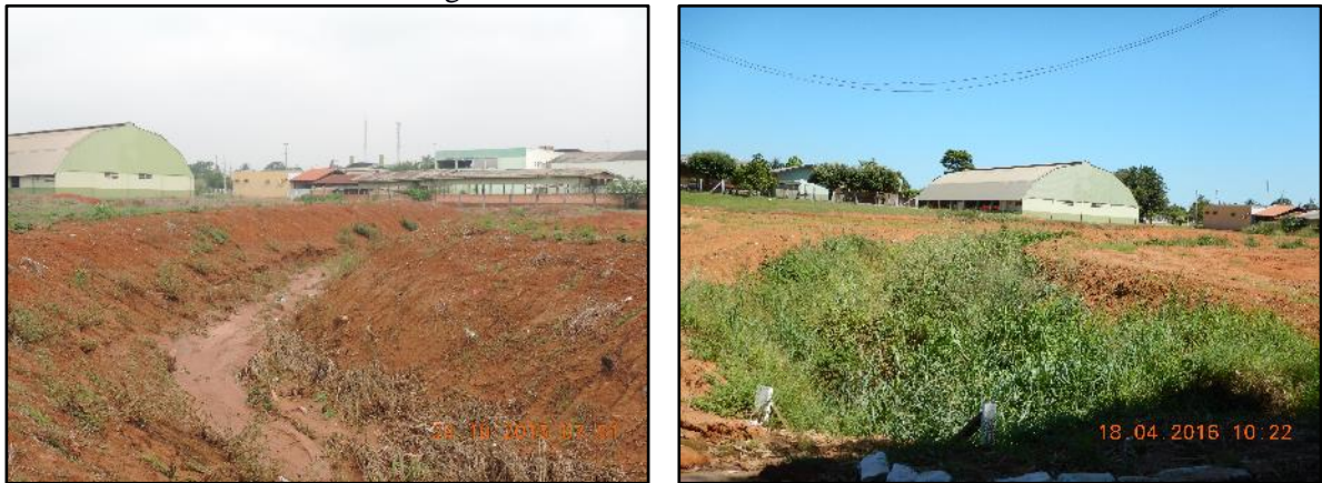
Figura 59. Canal de sem revestimento
