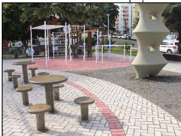
Figura 136. Pavimento poroso – piso intertravado instalado em praça
