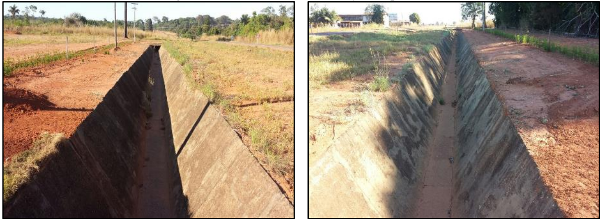
Figura 58. Canal de concreto seção trapezoidal
