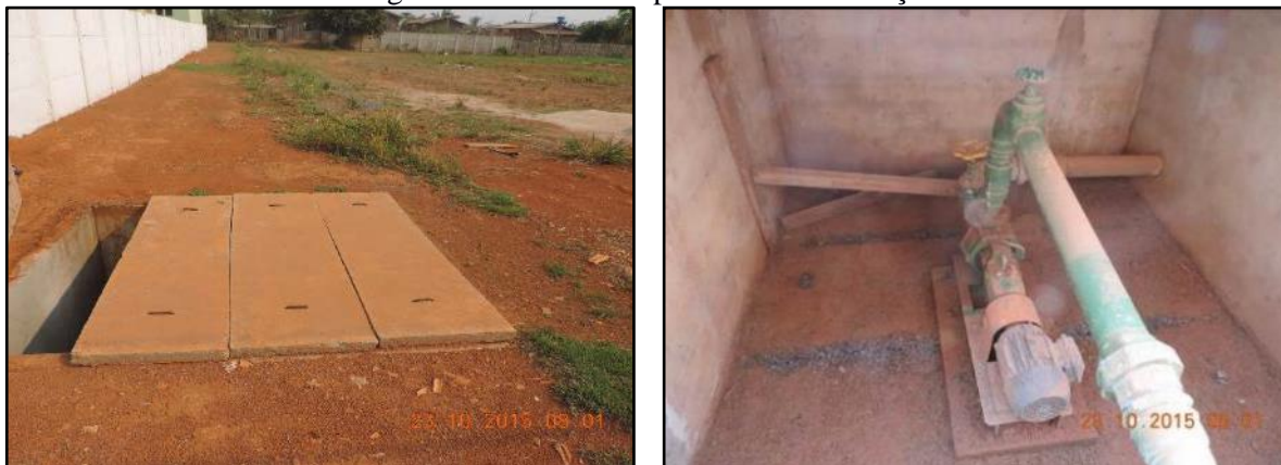
Figura 23. Booster em processo de instalação
