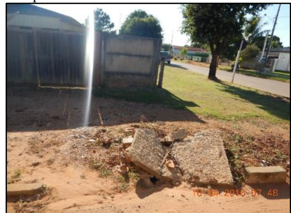
Figura 70. Falta manutenção e limpeza nos dispositivos e boca de lobo danificada
