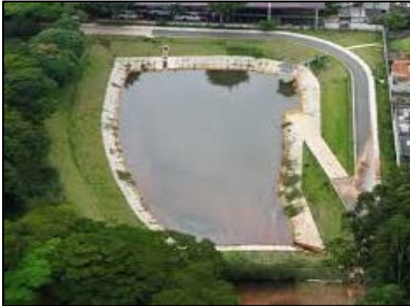
Figura 144. Bacia de detenção
