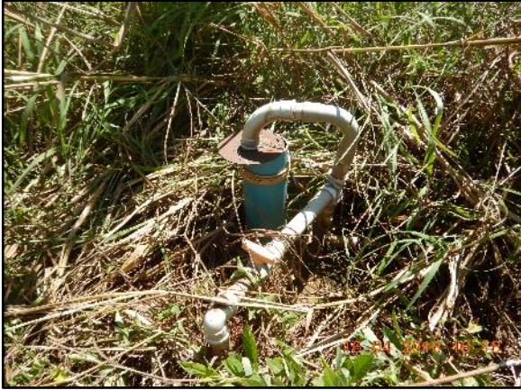
Figura 108. Poços tubulares (A) e mina d' água (B) utilizados para o abastecimento no Assentamento 12 de Outubro
