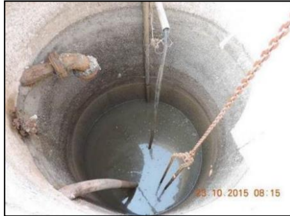
Figura 40. Poço de sucção da estação elevatória
