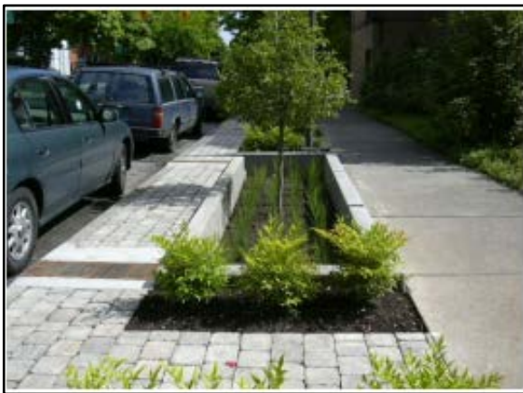
Figura 140. Trincheira de infiltração no passeio
