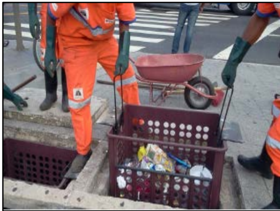
Figura 132. Cesta acoplada a boca do bueiro
