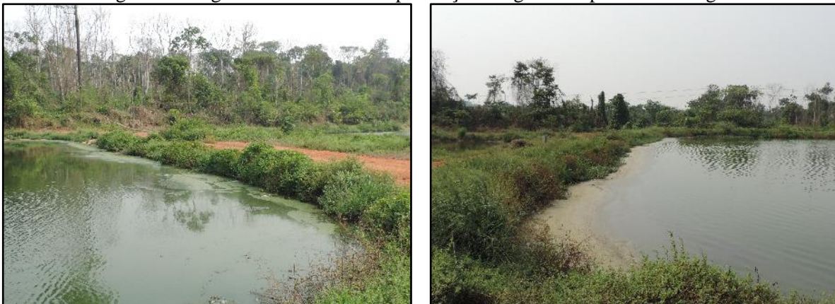
Figura 47. Lagoas facultativas com presença de algas na superfície das lagoas
