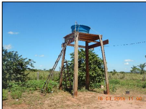
Figura 109. Reservatório de 500 litros Assentamento 12 de Outubro
