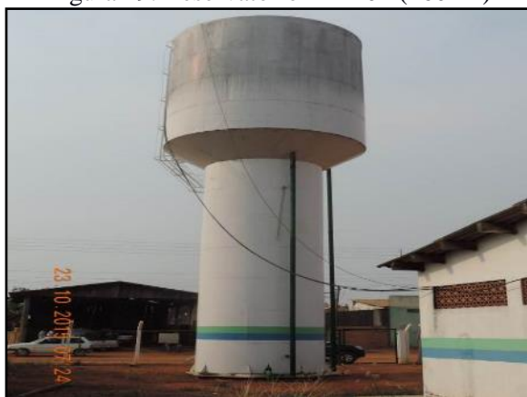
Figura 19. Reservatório REL-02 (160 m 3 )
