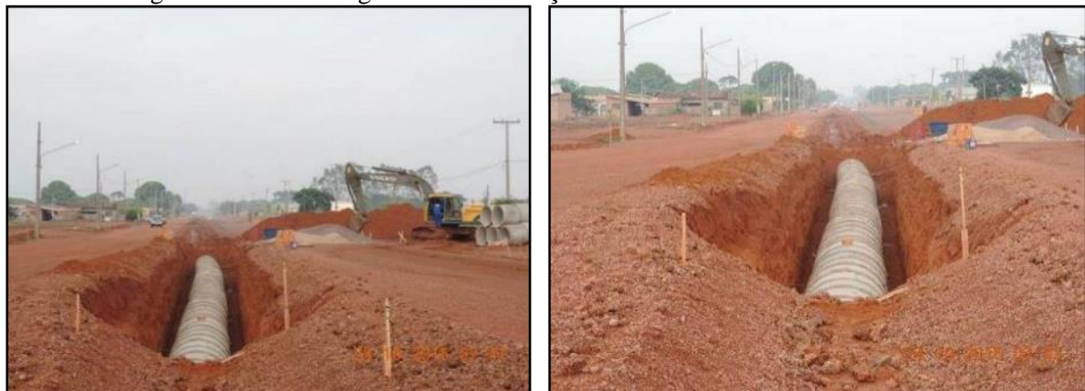
Figura 65. Trecho de galerias em execução na Avenida Juscelino Kubitscheck
