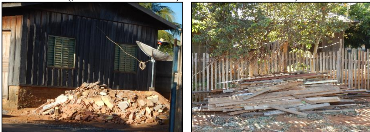
Figura 96. Resíduos da construção civil acondicionados nas calçadas
