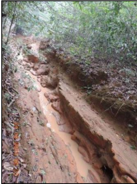
Figura 72. Erosão formada após ao lançamento das águas pluviais
