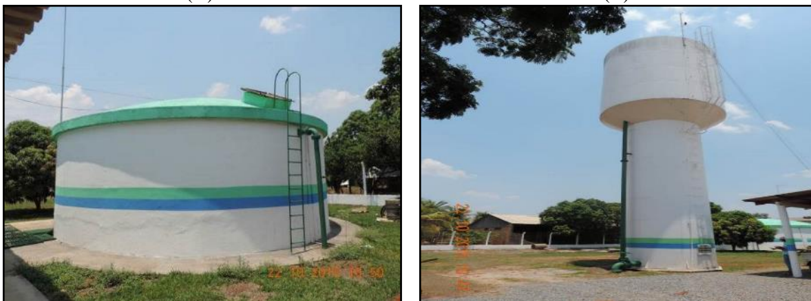
Figura 18. Reservatório RAP-01 de 200 m 3 (A) e Reservatório REL-01 de 160 m 3 (B)
