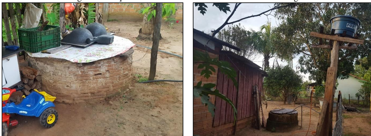
Figura 84. Poços-cacimba nas residências do distrito de Noroagro
