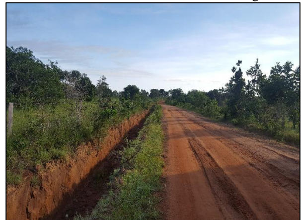
Figura 99. Escavação para drenagem da estrada vicinal de acesso ao distrito de Noroagro
