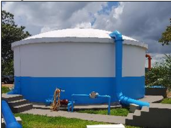
Figura 27. Reservatório RAP-01 de 200 m 3
