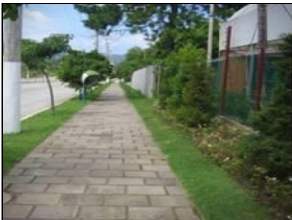
Figura 136. Vala de retenção ao longo da rua
