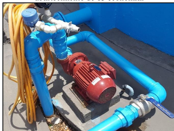
Figura 30. Conjunto motobomba utilizado para o abastecimento de 83 economias
