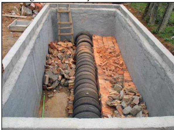
Figura 122. Execução fossa bananeira
