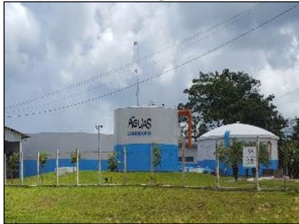
Figura 17. ETA metálica com capacidade nominal de 160 m 3 /h
