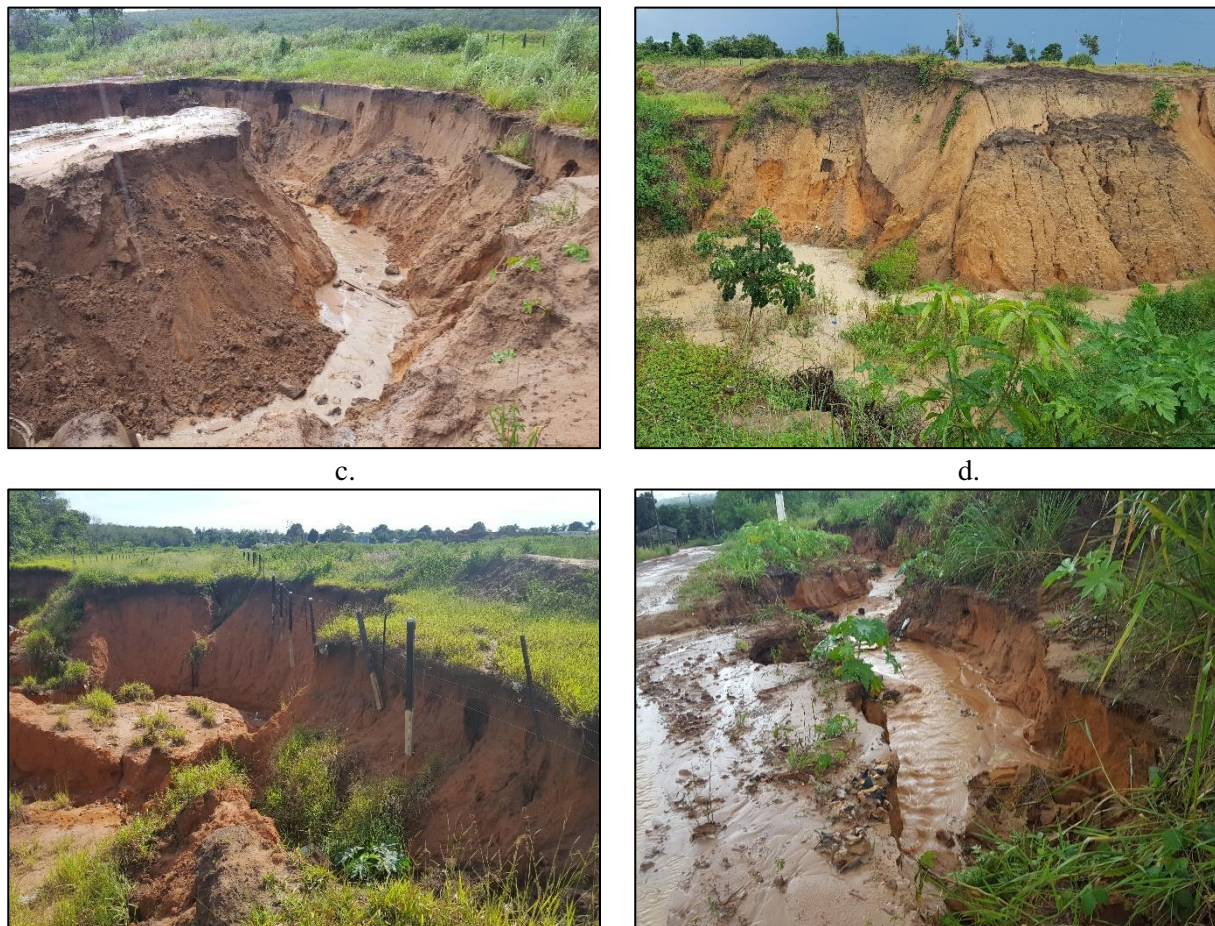
Figura 48. Erosões formadas nos deságues das galerias de águas pluviais (a) erosão-3, (b) erosão-4, (c) erosão-5, e (d) erosão-2 formada pelo escoamento superficial na Rua das Amoreiras não pavimentada
