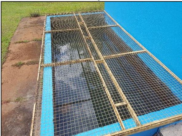
Figura 13. Tubulação de sucção do poço de derivação
