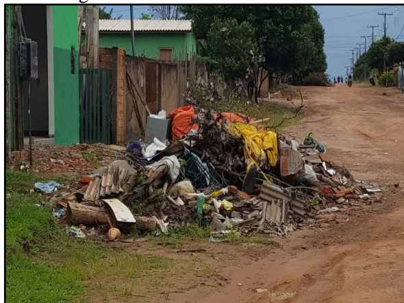
Figura 72. Resíduos de construção e demolição depositados no passeio público da Av. Odair Rangel da Silva no bairro Cidade Verde
