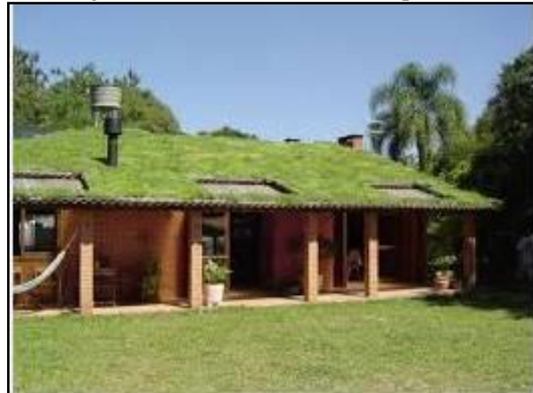
Figura 129. Telhado verde com plantas
