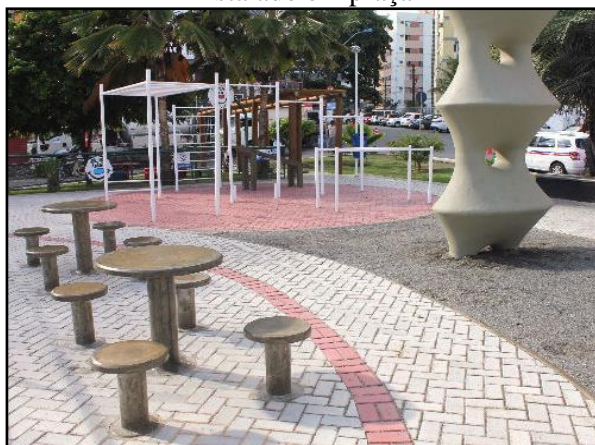
Figura 130. Pavimento poroso – piso intertravado instalado em praça
