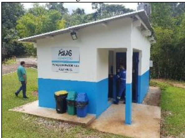
Figura 9. Casa de bombas próxima da captação no córrego Cascalheira
