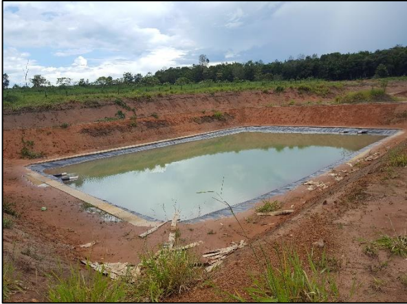
Figura 35. Lagoa anaeróbia da ETE de Comodoro
