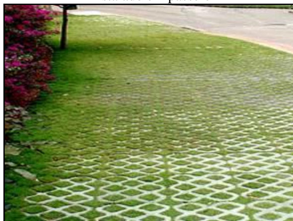
Figura 131. Pavimento poroso – concregrama instalado em passeio
