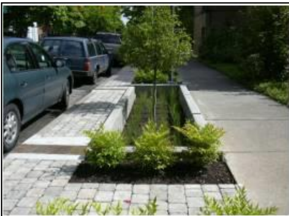
Figura 134. Trincheira de infiltração no passeio
