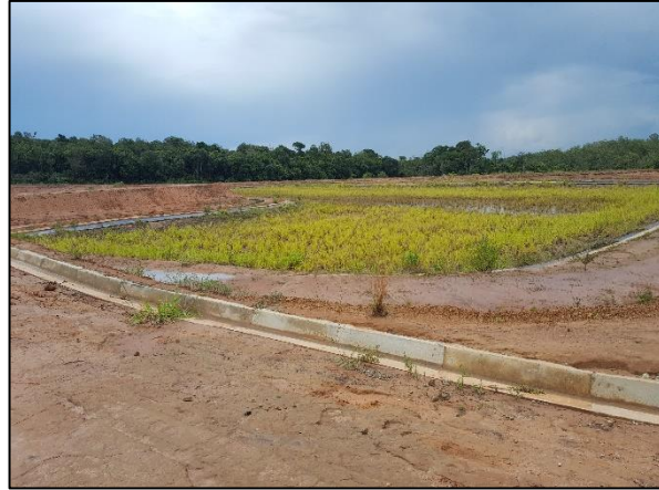
Figura 36. Lagoa de maturação e canaleta de drenagem da ETE de Comodoro
