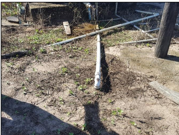
Figura 91. Barrilete do poço tubular de Padronal
