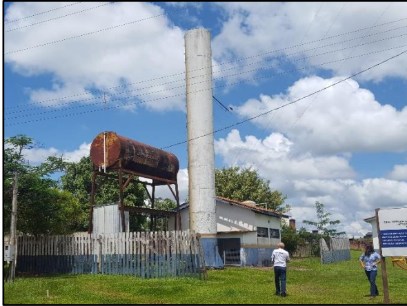
Figura 89. Reservatório de 50 m 3 utilizado para abastecimento do distrito de Nova Alvorada
