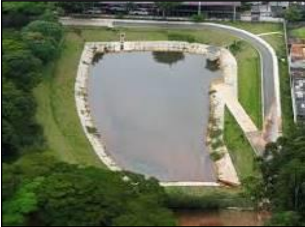
Figura 138. Bacia de detenção
