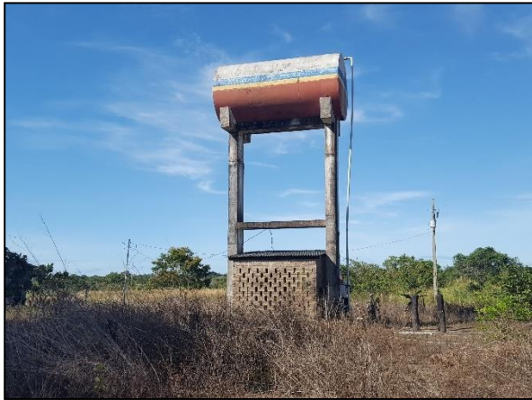
Figura 93. Reservatório metálico elevado em Padronal
