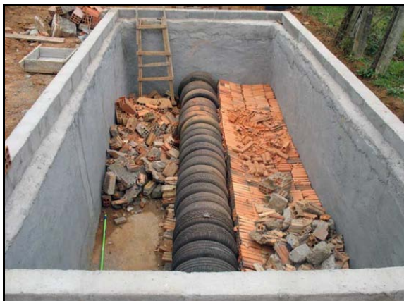
Figura 73. Método do círculo de bananeiras em execução para tratamento individual
