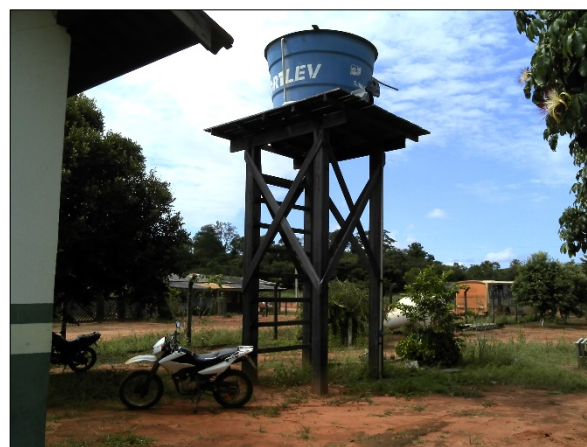
Figura 61. Reservatório elevado na escola rural do Ena
