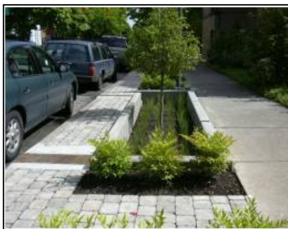
Figura 84. Trincheira de infiltração no passeio
