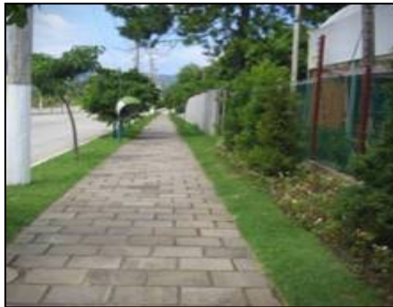
Figura 86. Vala de retenção ao longo da rua
