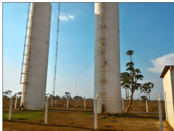
Figura 19. Reservatórios R-04A e R-04B
