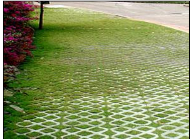
Figura 81. Pavimento poroso – concregrama instalado em passeio
