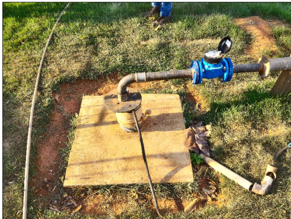
Figura 12. Laje de proteção do PT-03A
