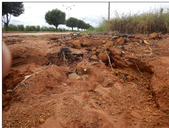
Figura 27. Erosão causada por águas pluviais na Avenida Perimetral Norte
