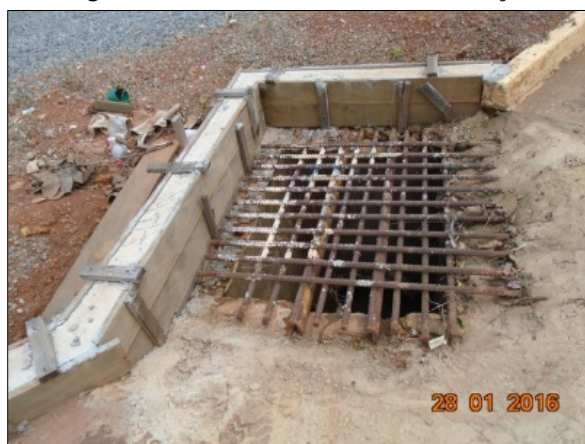
Figura 28. Boca de lobo em manutenção
