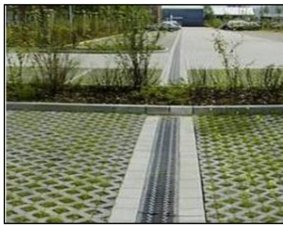
Figura 85. Trincheira de infiltração no estacionamento
