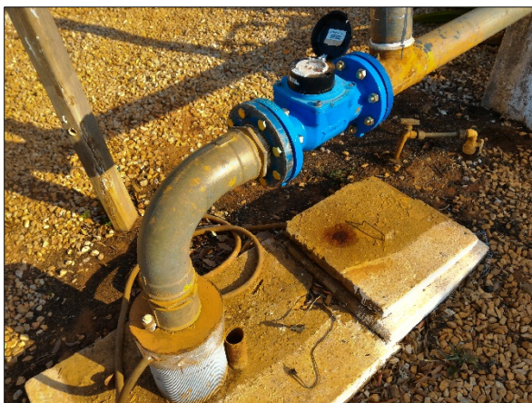
Figura 10. Laje de proteção e macromedidor do PT-01
