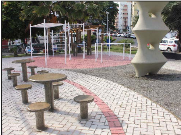
Figura 80. Pavimento poroso – piso intertravado instalado em praça
