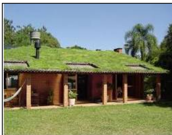
Figura 79. Telhado verde com plantas
