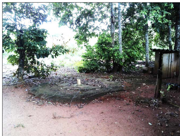
Figura 62. Cobertura da fossa rudimentar da UBS
