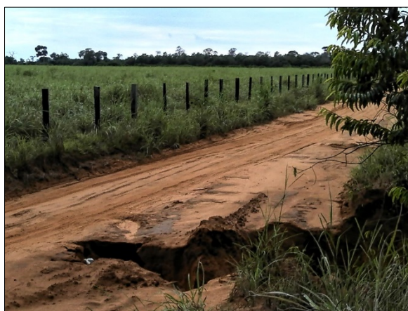
Figura 64. Erosão na estrada que leva ao Assentamento
