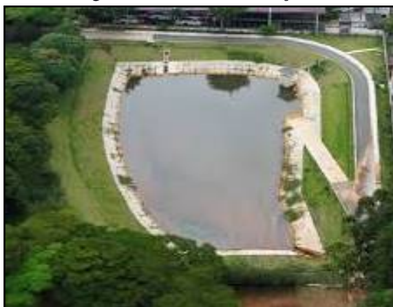
Figura 88. Bacia de detenção
