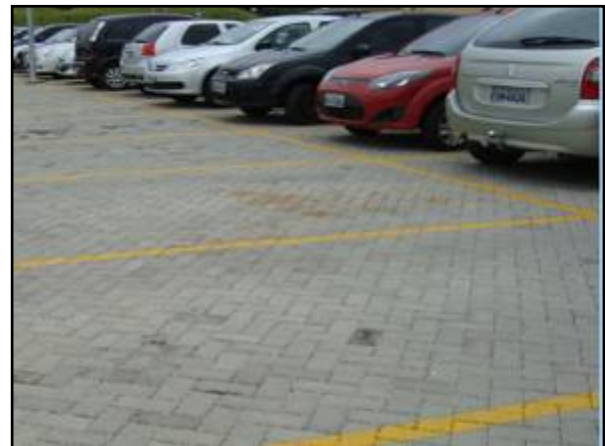
Figura 83. Pavimento poroso instalado em estacionamento
