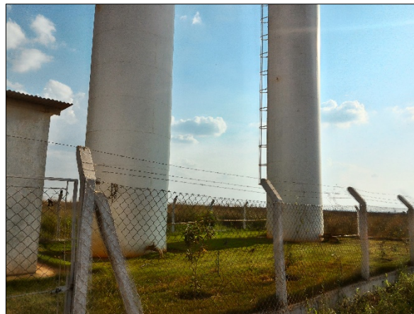
Figura 20. Reservatórios R-05 A e R-05 B
