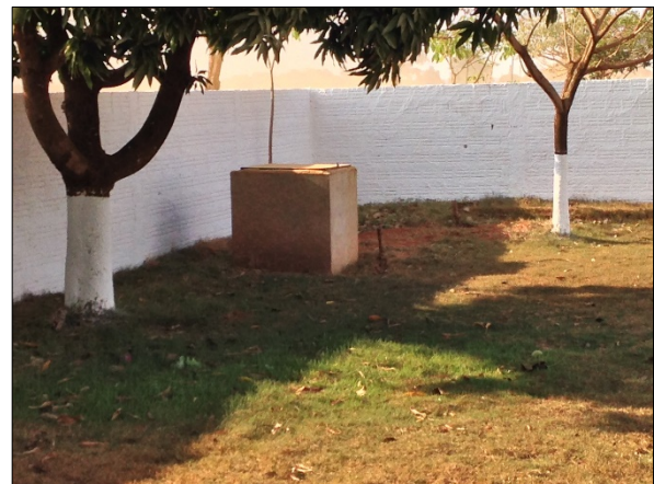
Figura 44. Poço de monitoramento
