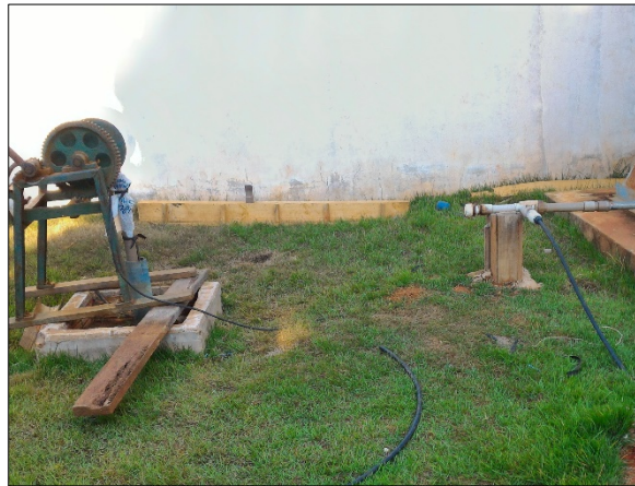
Figura 14. Laje de proteção do Poço tubular 03B
