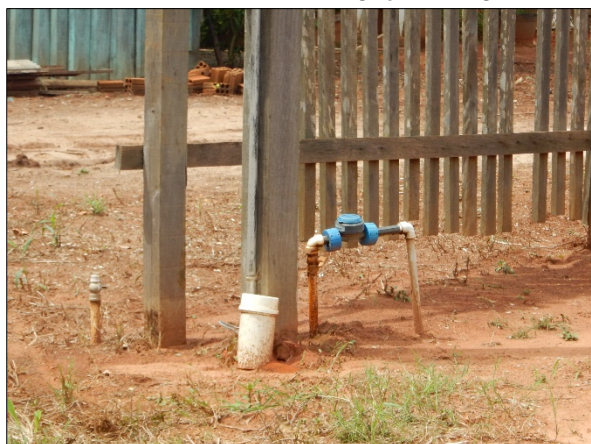
Figura 25. Vista da cobertura da Fossa rudimentar ao lado da ligação de água
