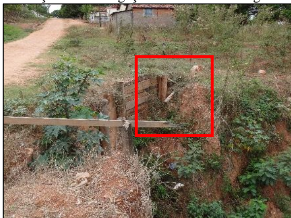
Figura 27. Localização de uma ligação clandestina de esgoto em um córrego
