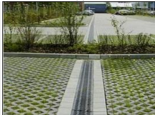
Figura 82. Trincheira de infiltração (A) no passeio (B) estacionamento
