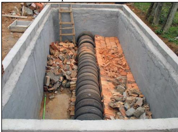
Figura 71. Método do círculo de bananeiras em execução para tratamento individual
