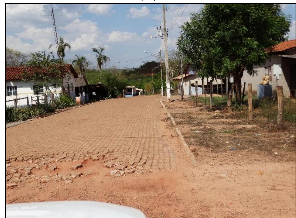
Figura 44. (A) Via não-pavimentada no distrito (B) Via com pavimento intertravado de concreto (C) Vala improvisada para escoamento das águas pluviais
