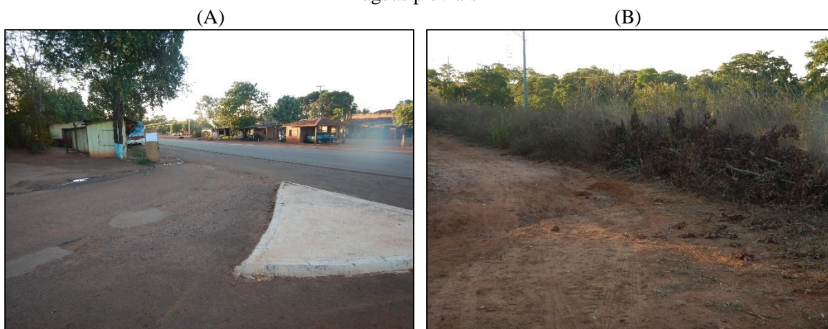
Figura 49. (A) Via pavimentada (B) Via não-pavimentada (C) Vala improvisada para escoamento das águas pluviais
