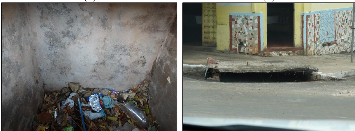
Figura 26. (A) Boca de lobo danificada (B) Boca de lobo com resíduos em seu interior (A) (B)
