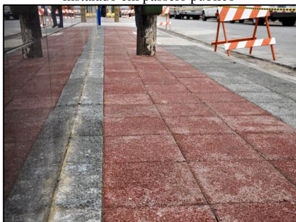
Figura 80. Pavimento poroso – piso intertravado instalado em passeio público
