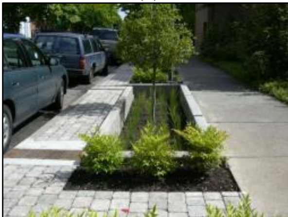
Figura 82. Trincheira de infiltração (A) no passeio (B) estacionamento
