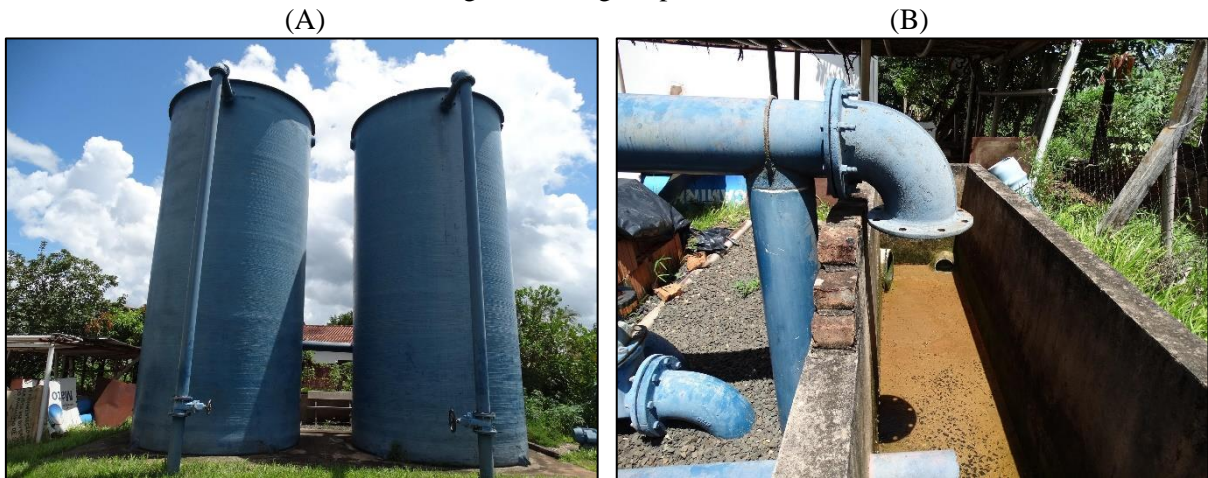
Figura 11. (A) Filtro Russo, (B) Caixa de coleta da água de lavagem dos filtros para posterior envio galeria de águas pluviais
