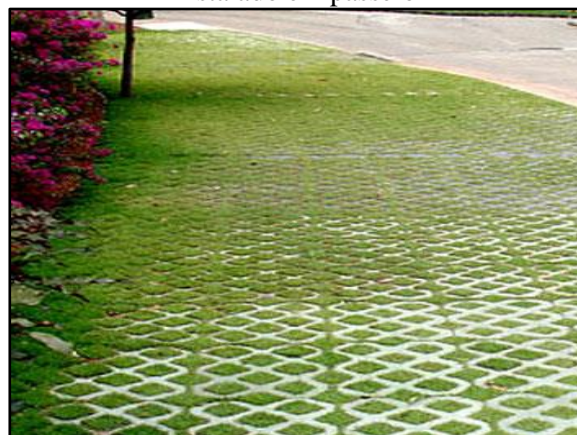
Figura 79. Pavimento poroso – concregrama instalado em passeio
