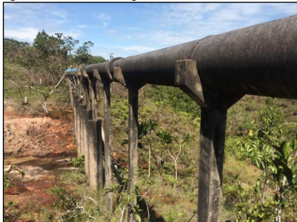
Figura 8. Adutora de água bruta de cimento amianto
