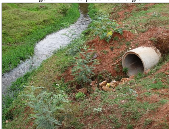
Figura 24. Dissipador de energia
