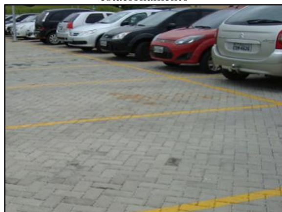
Figura 81. Pavimento poroso instalado em estacionamento
