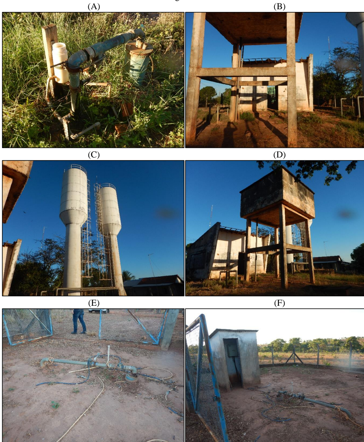
Figura 47. (A) PT-01 e o respectivo dispositivo de cloração (B) Casa de química (C) Reservatórios metálicos tipo taça (D) Reservatório retangular elevado de concreto (E) PT-02 (F) Quadro de comando do PT – 02 e vista geral da área de entorno
