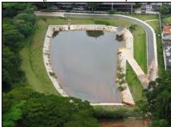
Figura 84. Bacia de detenção
