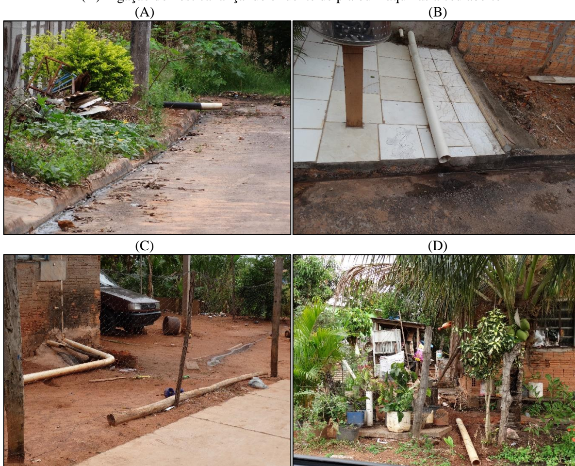
Figura 20. (A) e (B) Esgoto doméstico escoando na rua formando locais de acúmulo do efluente, (C) e (D) Ligação doméstica lançando efluente de pia ou máquinas a céu aberto
