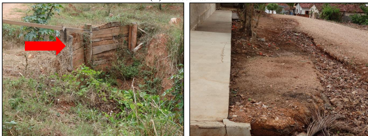
Figura 28. (A) Desmoronamento de talude em função da velocidade de escoamento da água de chuva (B) Erosões nas vias
