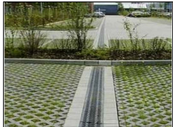
Figura 93. Trincheira de infiltração no estacionamento
