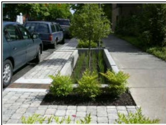
Figura 92. Trincheira de infiltração no passeio
