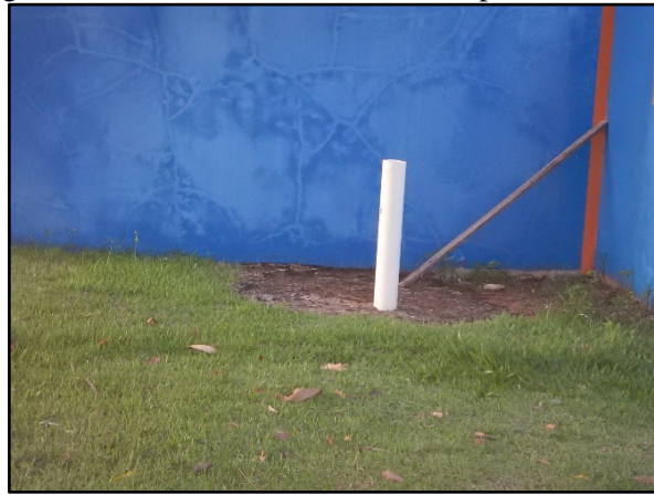
Figura 19. Fossa rudimentar no município de Itanhanga
