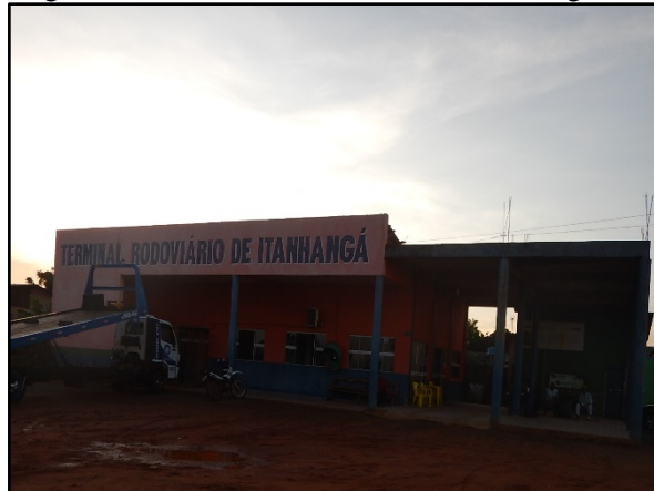
Figura 40. Terminal rodoviário de Itanhangá-MT
