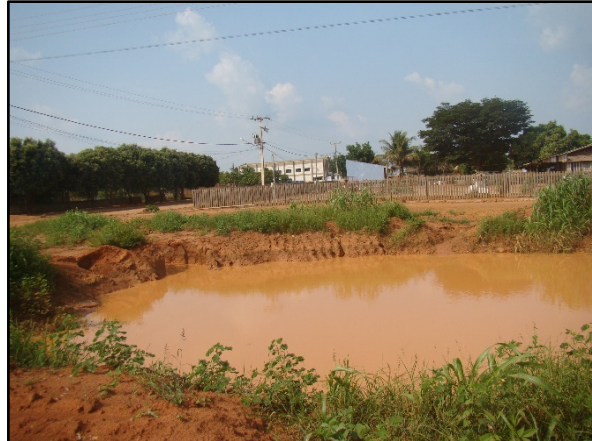
Figura 21. Bacias para contenção de águas pluviais
