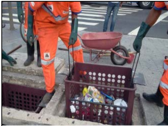
Figura 84. Cesta acoplada à boca do bueiro
