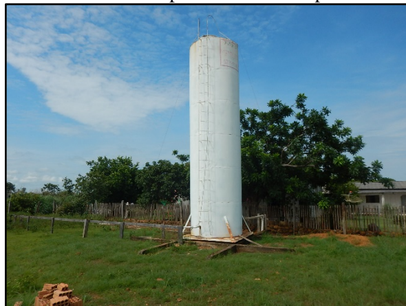
Figura 17. Reservatório apoiado metálico tipo torre de 15 m 3
