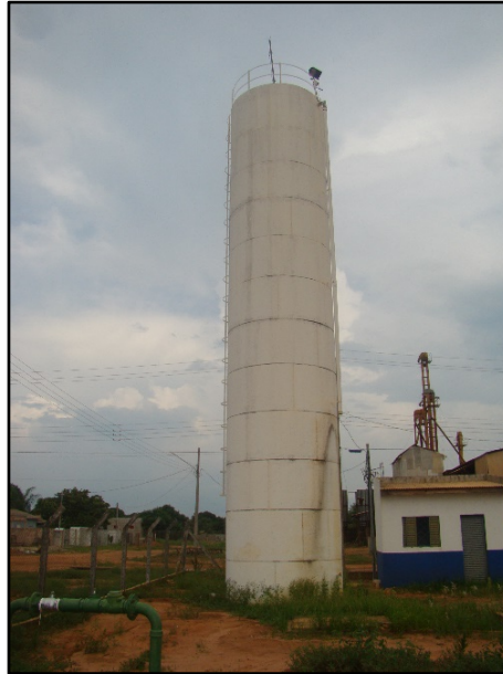
Figura 16. Reservatório apoiado de 120 m 3
