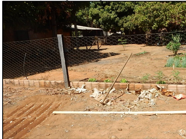
Figura 50. Disposição de efluente de pia e tanque a céu aberto, Monte Alto, Itanhanga-MT
