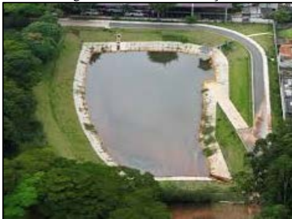
Figura 96. Bacia de detenção
