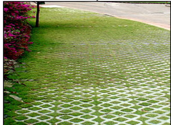
Figura 89. Pavimento poroso – concregrama instalado em passeio
