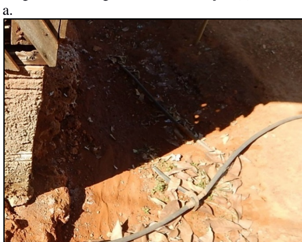
Figura 58. Mangueira de distribuição (a) e tubulação de distribuição de água, Simione, Itanhanga-MT
