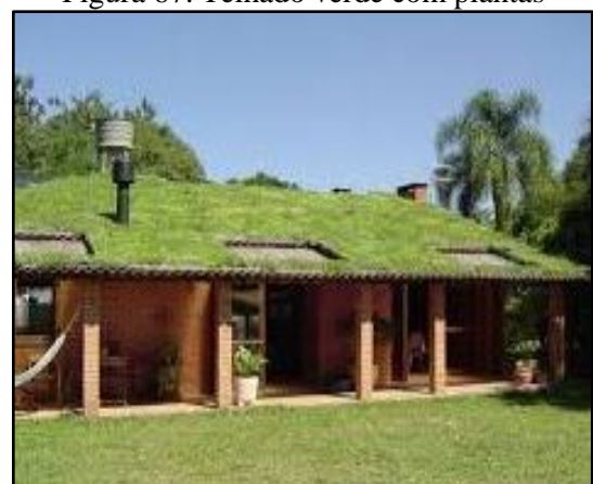
Figura 67. Telhado verde com plantas
