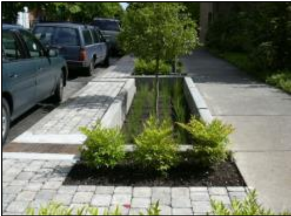
Figura 72. Trincheira de infiltração no passeio
