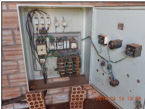
Figura 9. Quadro de comando instalado no PT-04 de acionamento manual
