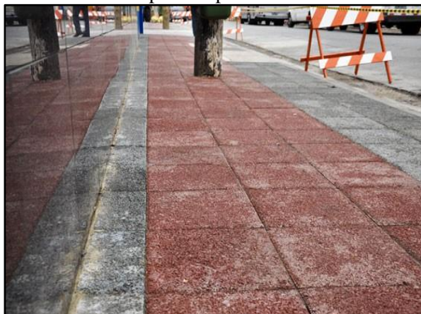
Figura 70. Pavimento poroso – instalado em passeio público
