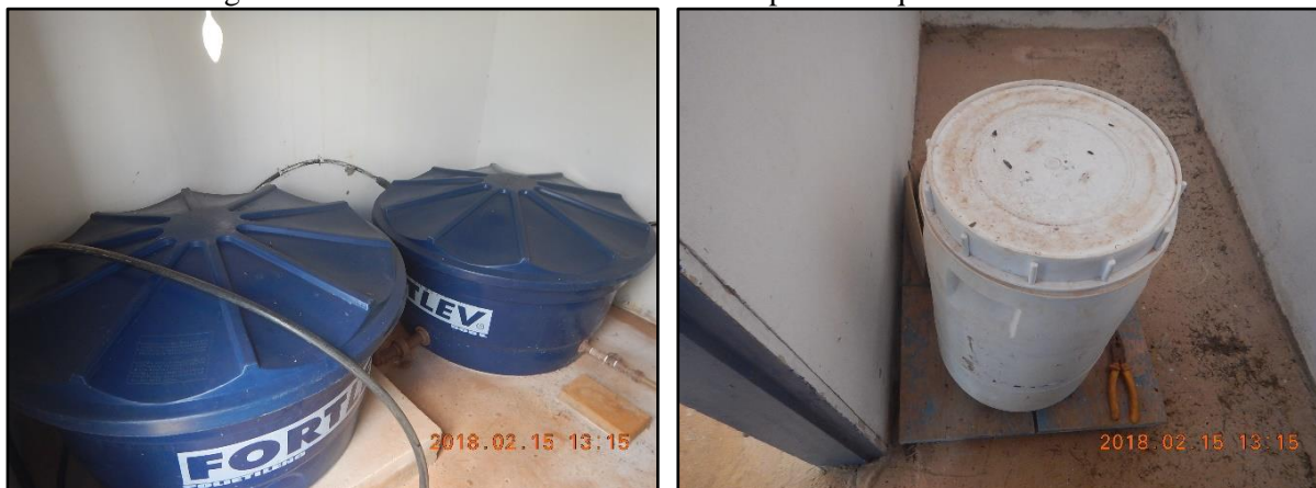
Figura 10. Estrutura de alvenaria da casa de produtos químicos do PT-01
