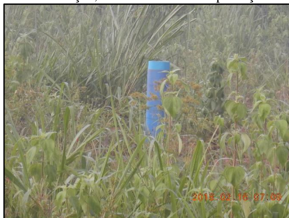
Figura 47. Poço tubular profundo, em fase de instalação, comunidade Boa Esperança
