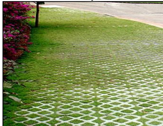
Figura 69. Pavimento poroso – concregrama instalado em passeio
