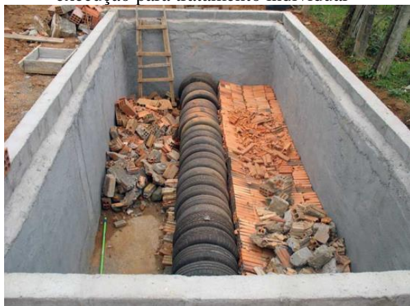
Figura 60. Método do círculo de bananeiras em execução para tratamento individual
