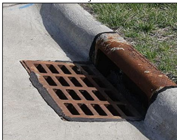
Figura 65. Boca de lobo com gradeamento na sarjeta
