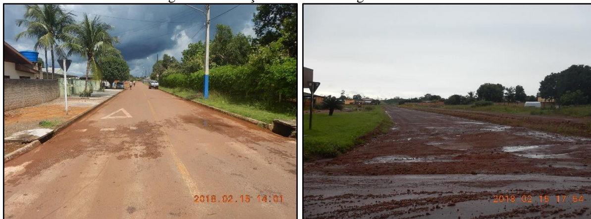
Figura 18. Situação da microdrenagem de Itaúba
