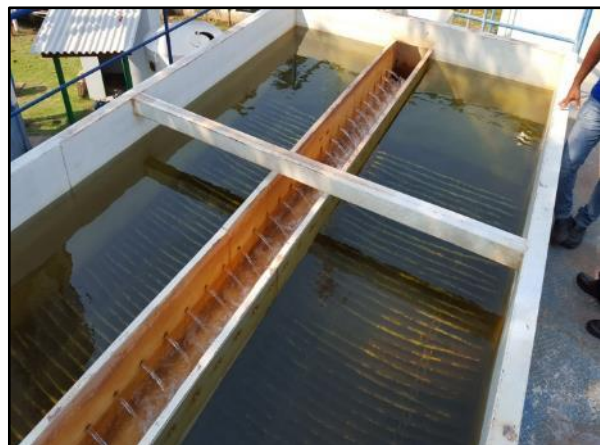
Figura 27. Decantador de alta taxa
