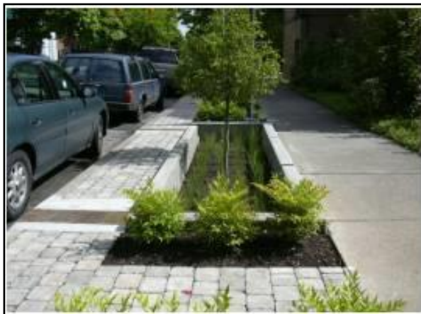
Figura 164. Trincheira de infiltração no passeio
