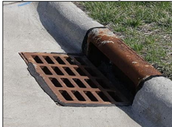
Figura 157. Boca de lobo com gradeamento
