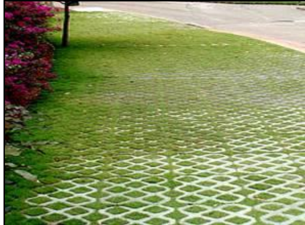
Figura 161. Pavimento poroso – concregrama instalado em passeio
