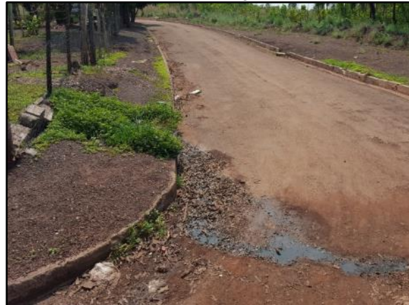
Figura 54. Lançamento de efluente na Rua 10 do Altos da Jangada
