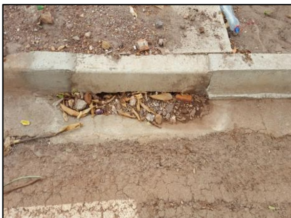
Figura 70. Boca de lobo assoreada na Rua Natalino Piovesan
