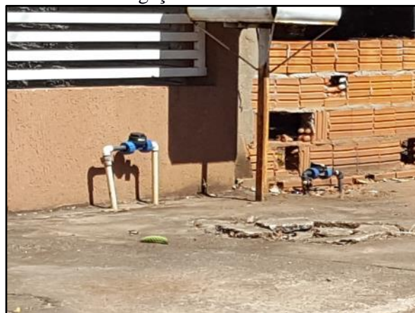
Figura 40. Hidrômetros novos instalados em ligações domiciliares
