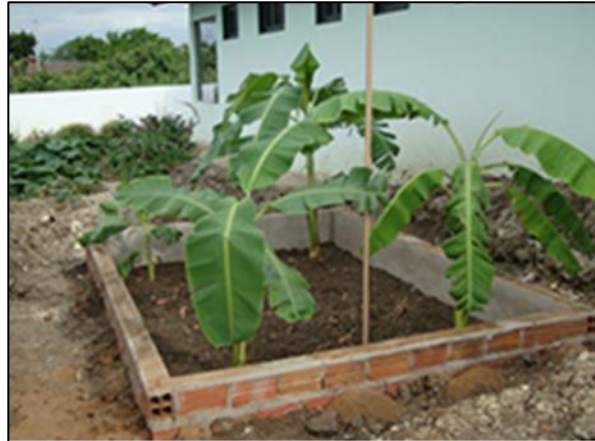
Figura 153. Fossa bananeira em funcionamento
