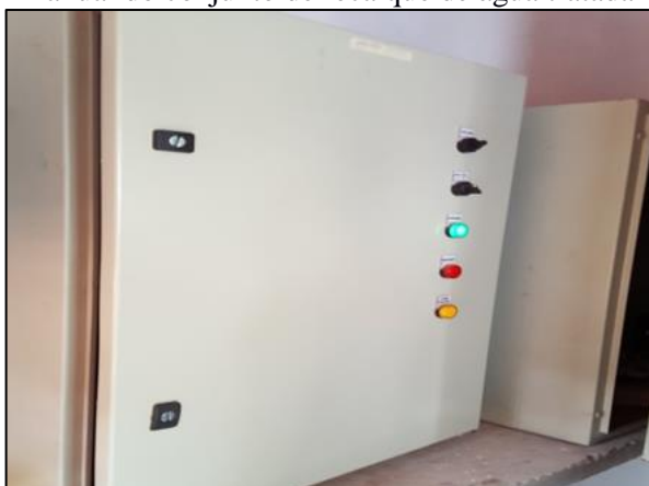
Figura 21. Quadro de comando com acionamento manual do conjunto de recalque de água tratada
