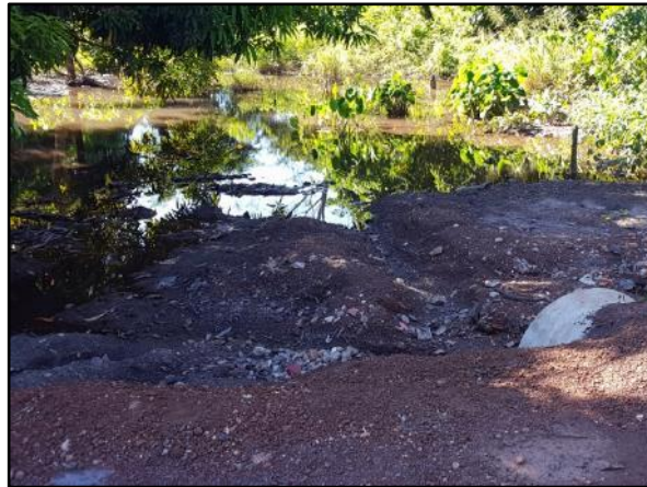
Figura 69. Ponto de alagamento 2 no final da Rua 03
