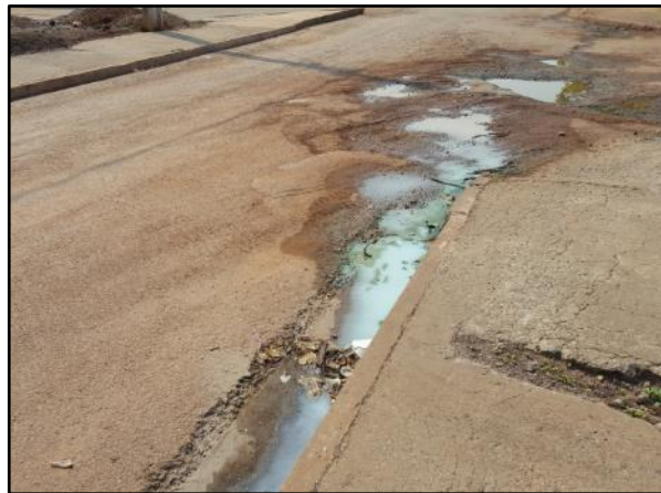
Figura 60. Águas servidas lançadas na sarjeta em frente ao Pronto Atendimento
