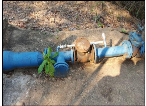
Figura 17. Válvula de retenção, registro de manobra e captação para descarga na adutora de água bruta
