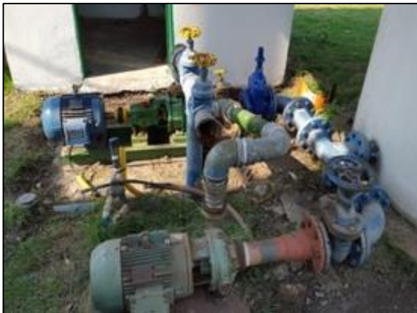
Figura 35. Conjunto motobomba de alimentação do reservatório REL-1
