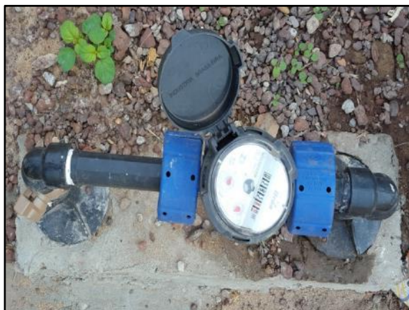
Figura 39. Hidrômetro novo instalado em ligação domiciliar
