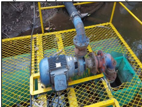
Figura 12. Captação superficial no rio Jangada
