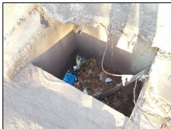
Figura 71. Boca de lobo sem tampa, com uma ligação de esgoto, assoreada e com resíduos sólidos na Rua Natalino Piovesan
