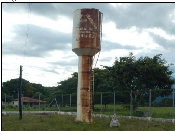
Figura 120. Reservatório de 25,0 m 3 de Raizama
