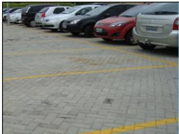
Figura 163. Pavimento poroso instalado em estacionamento
