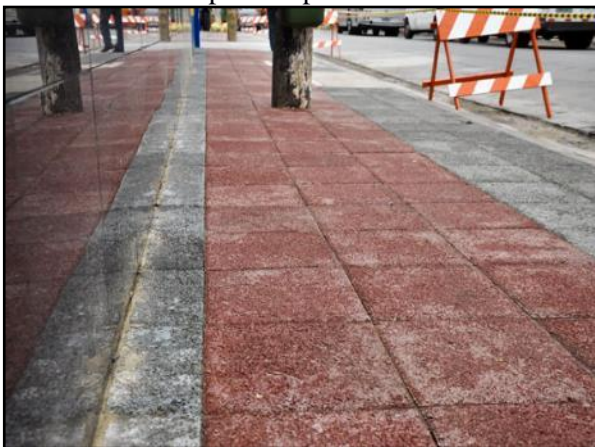
Figura 162. Pavimento poroso instalado em passeio público
