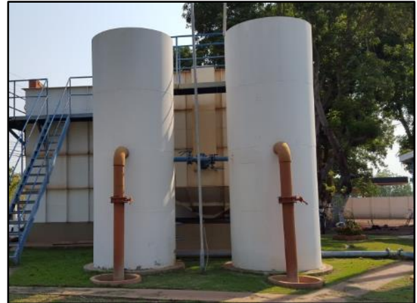
Figura 29. Filtros de múltiplas camadas com fluxo descendentes
