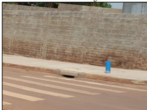
Figura 57. Rua pavimentada com meio-fio, sarjeta e boca de lobo em Jangada-MT
