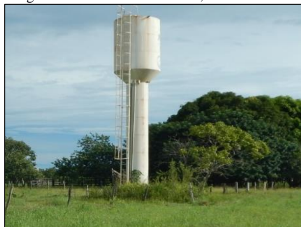
Figura 121. Reservatório de 25,0 m 3 de Mutum
