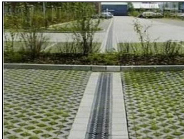
Figura 165. Trincheira de infiltração no estacionamento
