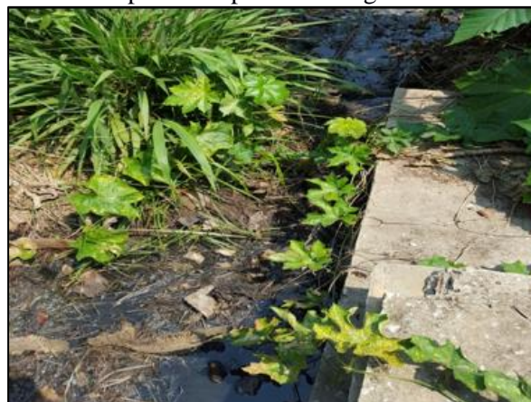
Figura 53. Esgoto sem tratamento da ETE escoando pelo solo para o Córrego Passa Três
