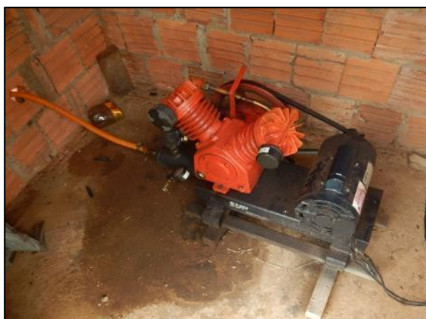
Figura 118. Compressor improvisado para captação de água no poço de Raizama
