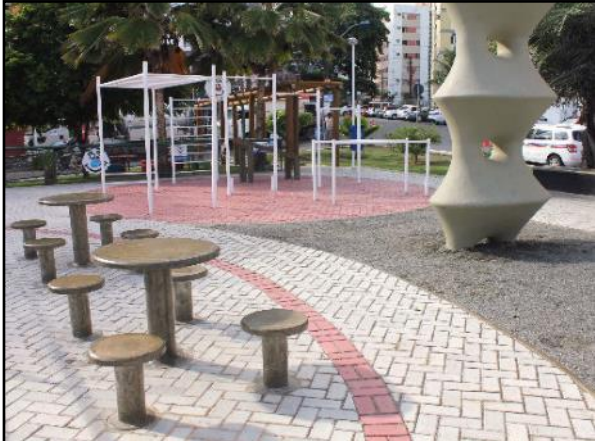
Figura 160. Pavimento poroso – piso intertravado instalado em praça
