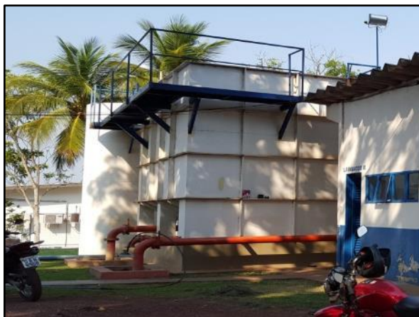
Figura 23. ETA metálica de 20 L/s da sede urbana de Jangada
