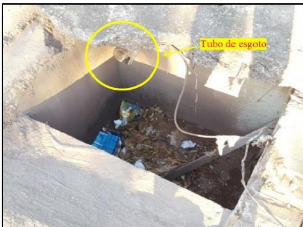
Figura 59. Ligação de esgoto na boca de lobo na Rua Natalino Piovesan
