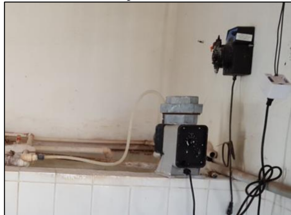
Figura 33. Bomba dosadora da solução de hipoclorito
