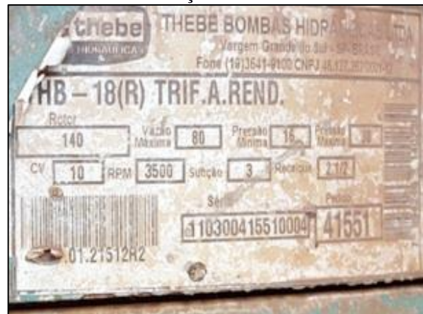
Figura 36. Características do conjunto motobomba de alimentação do reservatório REL-1
