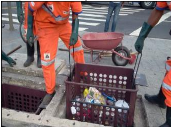
Figura 156. Cesta acoplada a boca do bueiro
