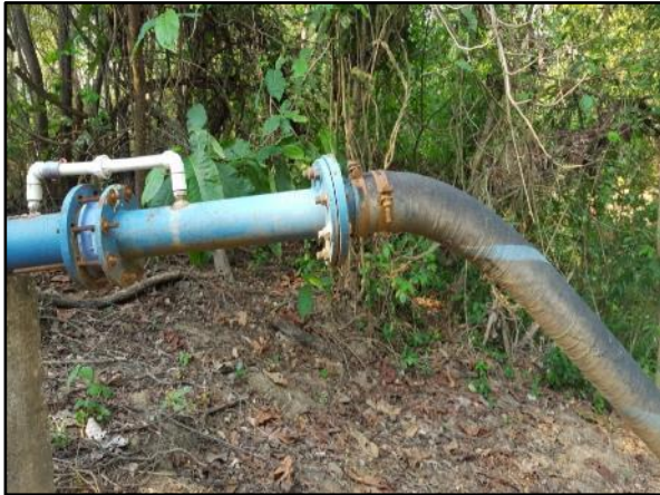
Figura 16. Conexão entre tubulação de ferro fundido e mangote flexível na captação
