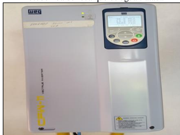
Figura 22. Inversor de frequência do conjunto motobomba de recalque de água tratada
