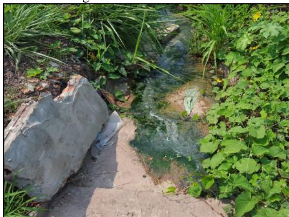
Figura 50. Lançamento de efluente no dispositivo de drenagem no Loteamento Passa Três
