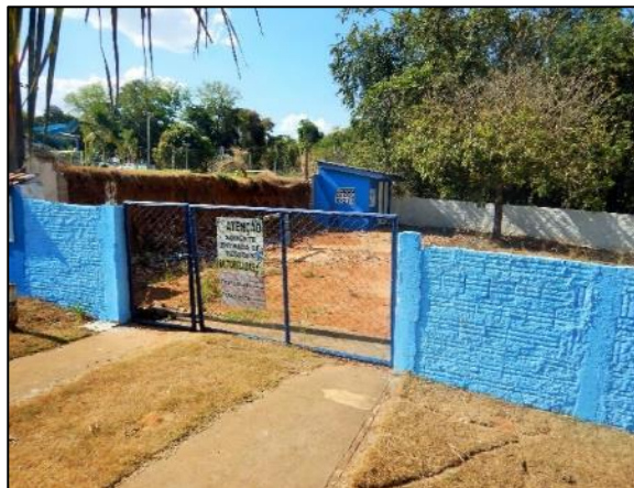
Figura 10. Tipologia padrão das medidas de isolamento e dos abrigos de alvenaria existentes na área dos poços do SAA de Lucas do Rio Verde
