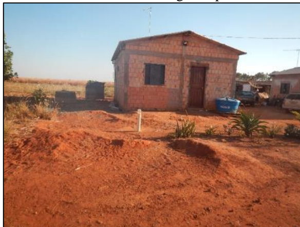
Figura 83. Vista exterior de fossa negra implantada na comunidade
