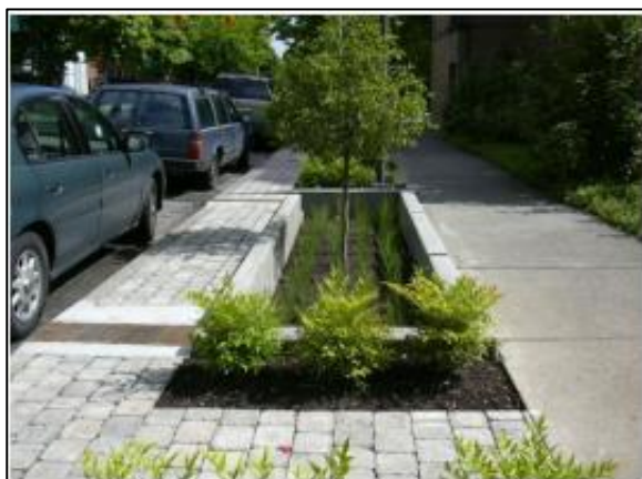
Figura 118. Trincheira de infiltração no passeio
