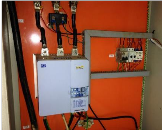
Figura 14. Chaves de partida soft-start utilizados nos poços do SAA de Lucas do Rio Verde: PT-09
