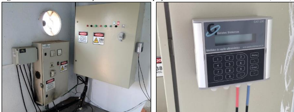
Figura 15. Sistema de automação e telemetria dos poços do SAA de Lucas do Rio Verde (PT-13)
