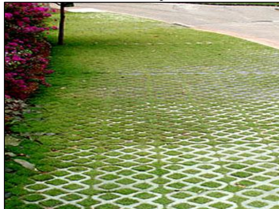
Figura 115. Pavimento poroso – concregrama instalado em passeio
