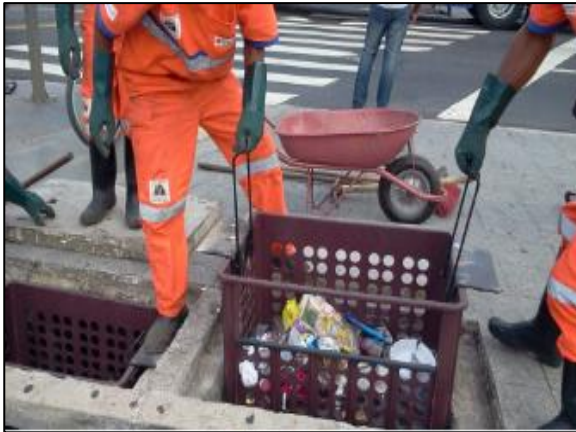
Figura 110. Cesta acoplada à boca do bueiro
