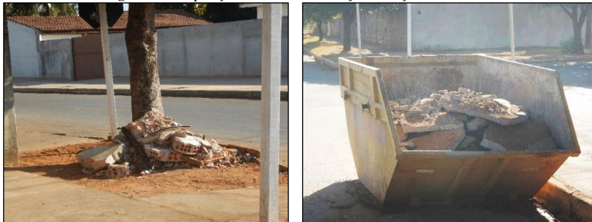
Figura 67. Disposição dos RSCC em calçada e caçamba metálica
