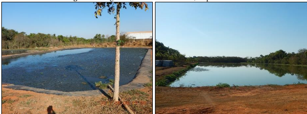
Figura 32. Lagoas anaeróbia e facultativa, respectivamente
