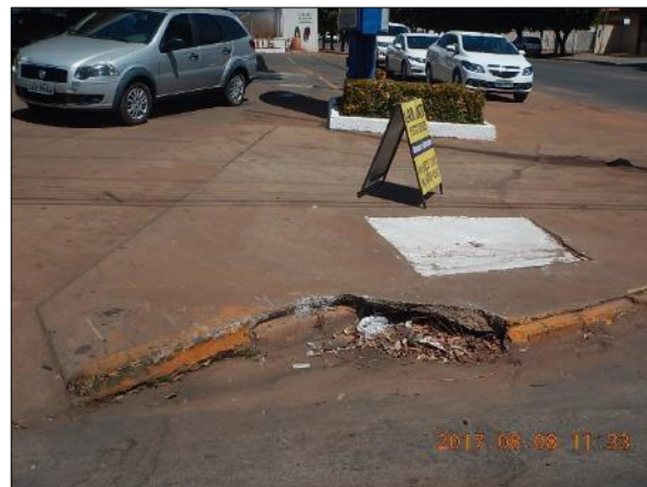
Figura 44. Bocas de lobo danificadas na Avenida Espirito Santo (A), Av.Mato Grosso (B), Av. das Nações (C), Av. Tocantins (D)
