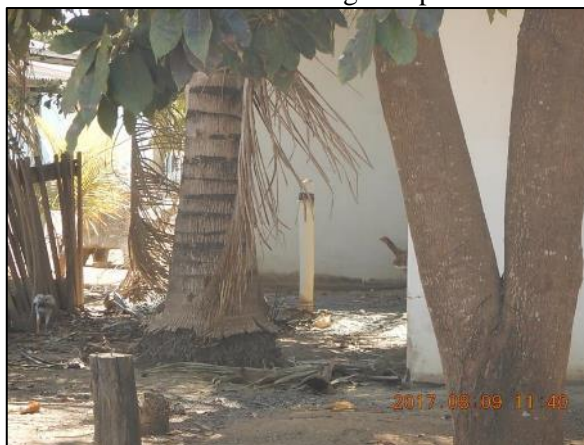
Figura 89. Vista exterior de fossa negra implantada na comunidade
