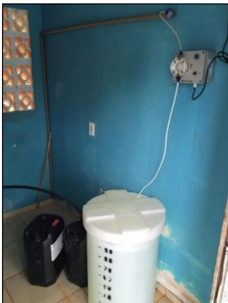
Figura 18. Sistema de desinfecção de poços do SAA de Lucas do Rio Verde: 2015
