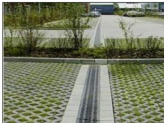
Figura 119. Trincheira de infiltração no estacionamento
