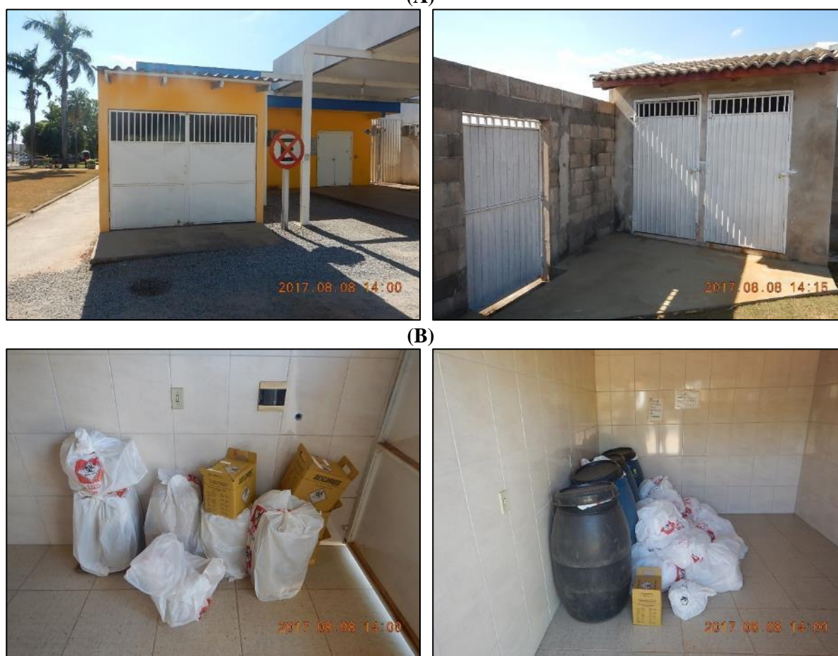
Figura 65. (A) Abrigo para armazenagem de resíduos de serviço de saúde (B) Acondicionamento dos RSS dentro dos abrigos
