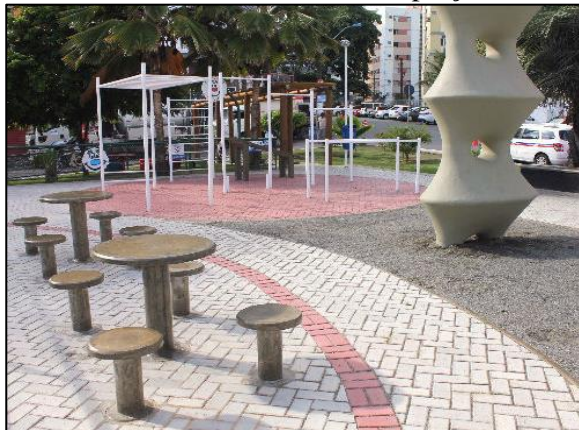
Figura 114. Pavimento poroso – piso intertravado instalado em praça
