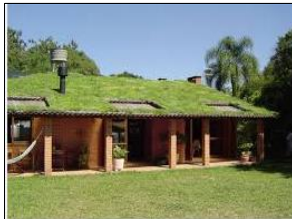
Figura 113. Telhado verde com plantas
