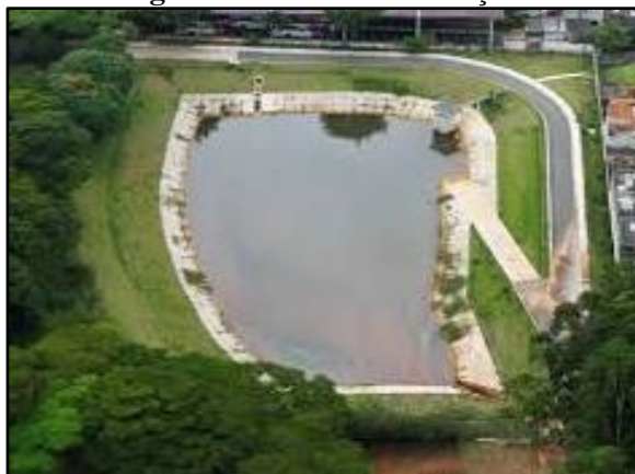
Figura 122. Bacia de detenção
