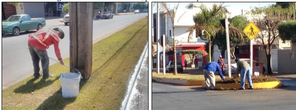
Figura 60. Pintura de meio-fio, postes e manutenção dos canteiros
