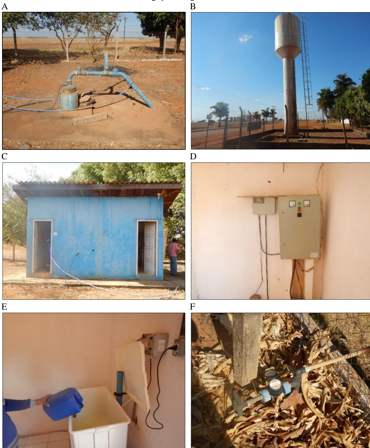
Figura 74. Vista exterior do poço tubular PT-01 (A) e reservatório metálico elevado (B), edificação de abrigo (C), quadro de comando da bomba do poço (D), tanque de diluição e bomba dosadora de cloro (E), ligação de água hidrometrada (F), Groslândia
