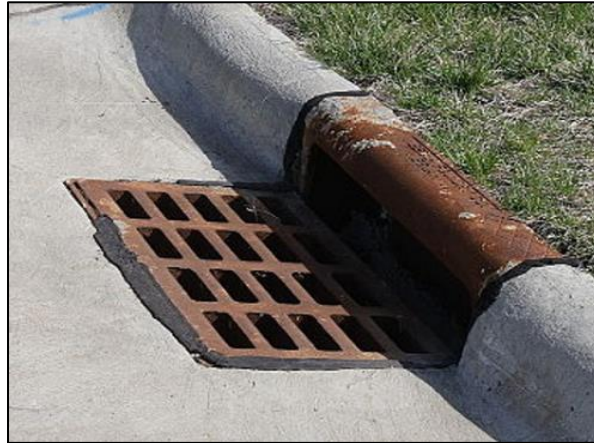
Figura 85. Boca de lobo com gradeamento
