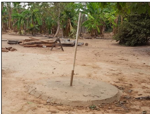
Figura 61. Fossa rudimentar na comunidade Doze de Junho
