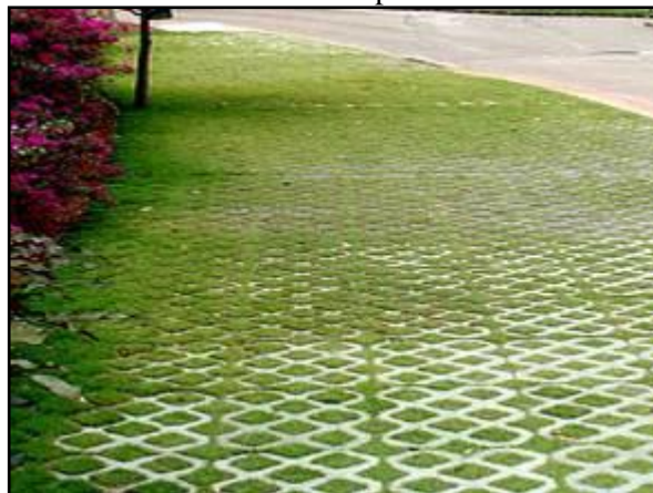
Figura 89. Pavimento poroso – concregrama instalado em passeio
