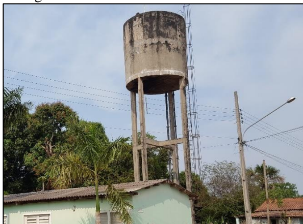
Figura 16. Reservatório REL-01 de 100 m 3
