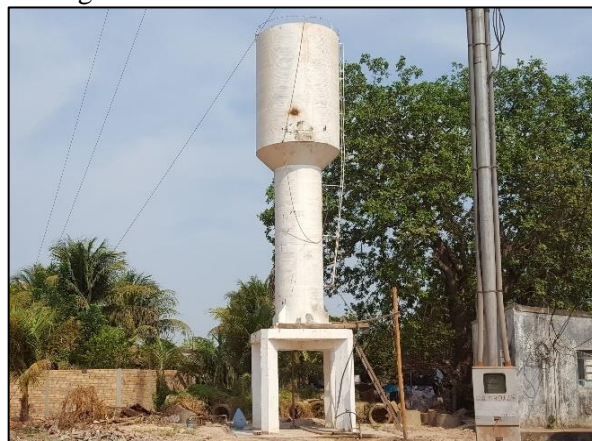
Figura 17. Reservatório REL-02 de 30 m 3
