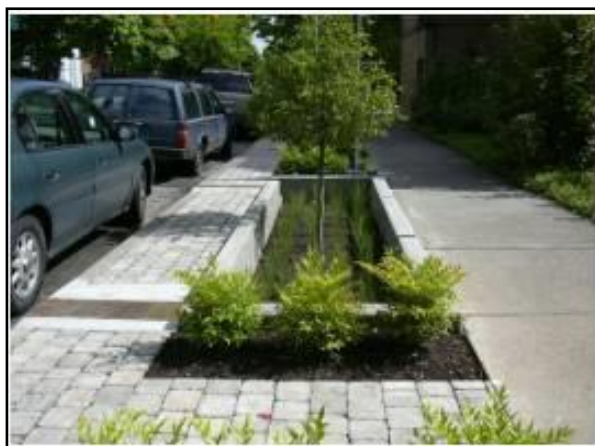
Figura 92. Trincheira de infiltração no passeio
