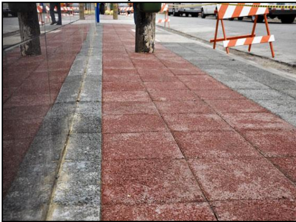
Figura 90. Pavimento poroso instalado em passeio público
