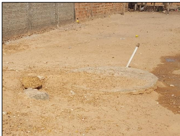
Figura 25. Fossa absorvente utilizada em residência na cidade de Luciara
