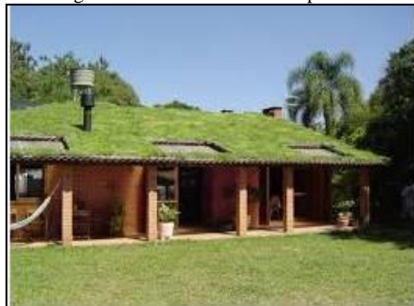
Figura 87. Telhado verde com plantas
