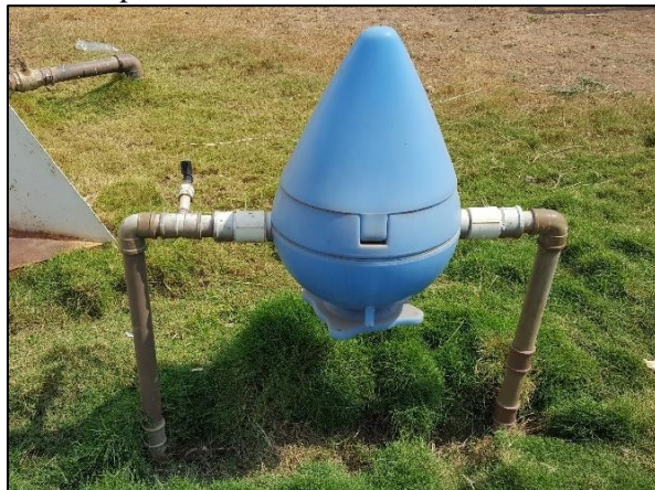
Figura 15. Dispositivo de cloração e fluoretação do tipo contato no barrilete do PT-Cohab
