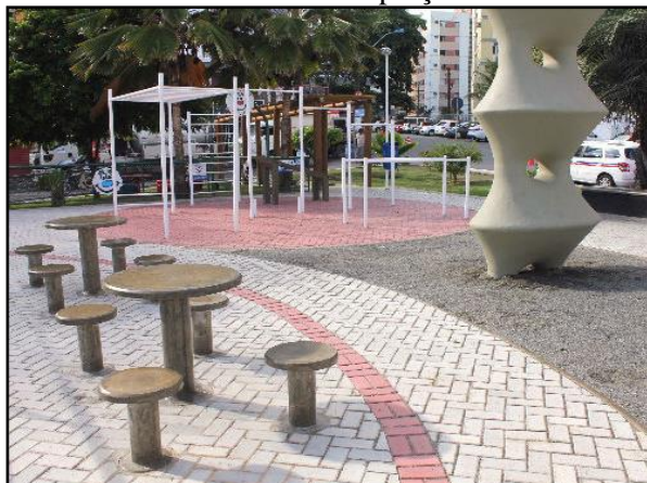
Figura 88. Pavimento poroso – piso intertravado instalado em praça
