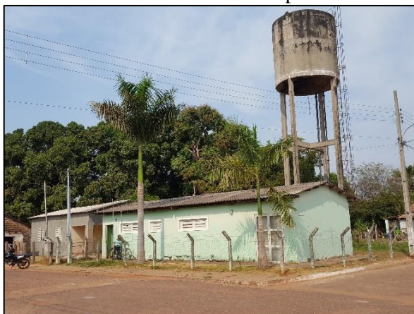
Figura 6. Fachada do escritório comercial e operacional do DAE Luciara
