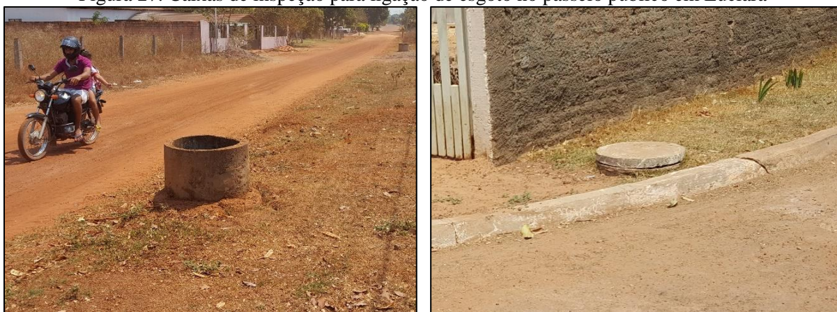
Figura 27. Caixas de inspeção para ligação de esgoto no passeio público em Luciara
