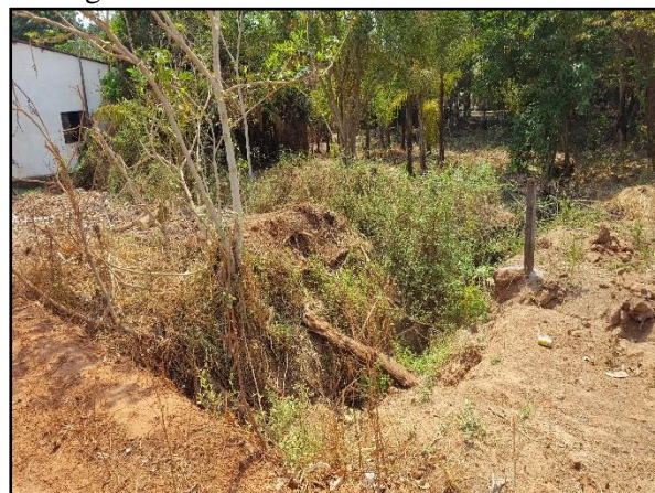
Figura 33. Erosão em um terreno na Rua C
