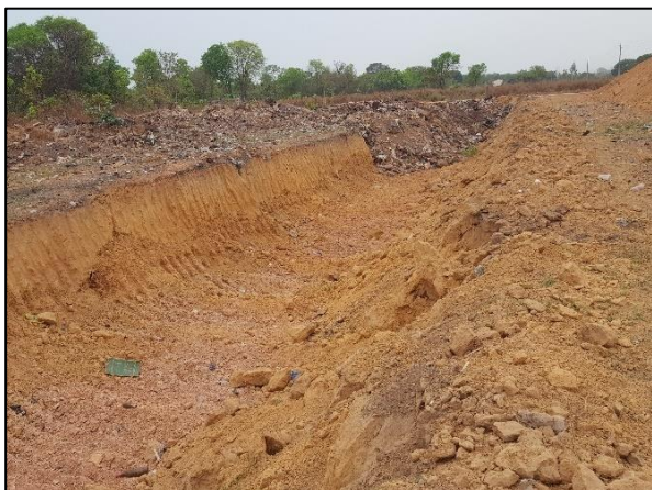
Figura 40. Vala aberta sem proteção do solo para recebimento de resíduos no lixão
