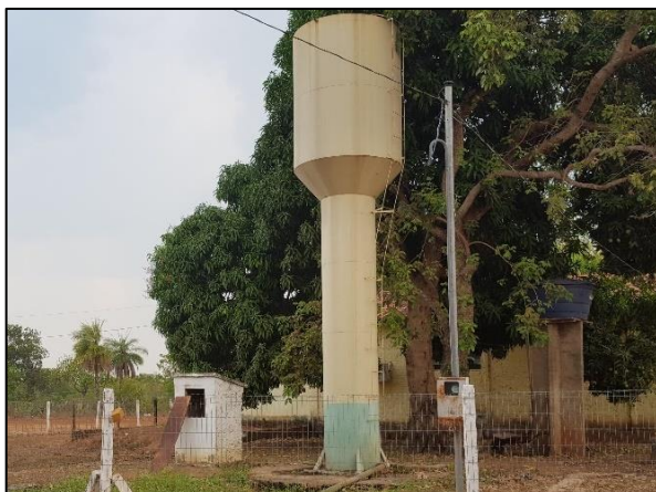
Figura 59. Reservatório de 10 m 3 da comunidade São Bento
