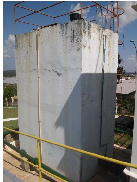
Figura 13. (A) Tanque de preparo da solução de cloro, (B) Câmara de Contato (A) (B)
