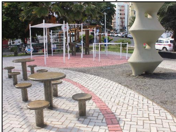
Figura 78. Pavimento poroso – piso intertravado instalado em praça
