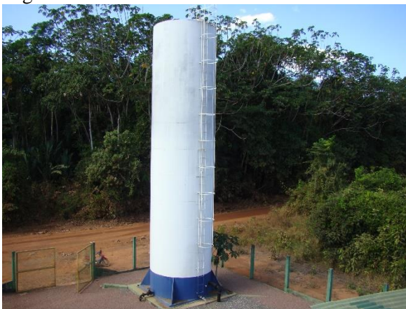
Figura 50. Reservatório instalado na comunidade
