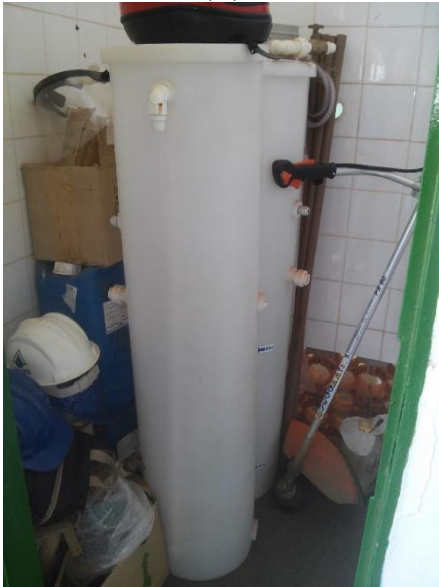
Figura 13. (A) Tanque de preparo da solução de cloro, (B) Câmara de Contato (A) (B)
