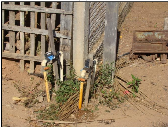
Figura 51. Hidrômetros instalados (A) e mangueiras de distribuição (B) (A) (B)
