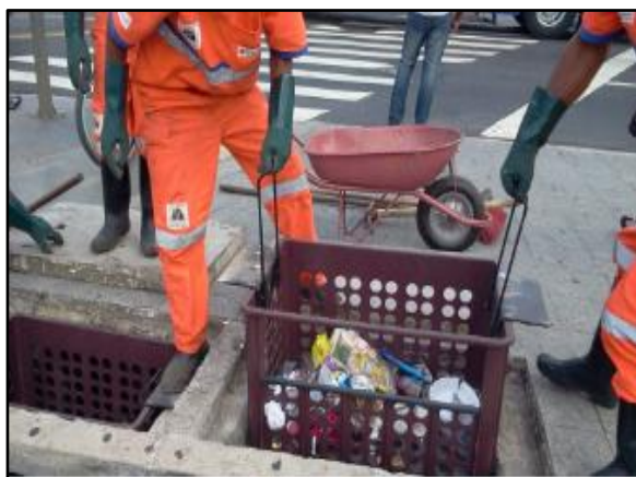
Figura 74. Cesta acoplada à boca do bueiro
