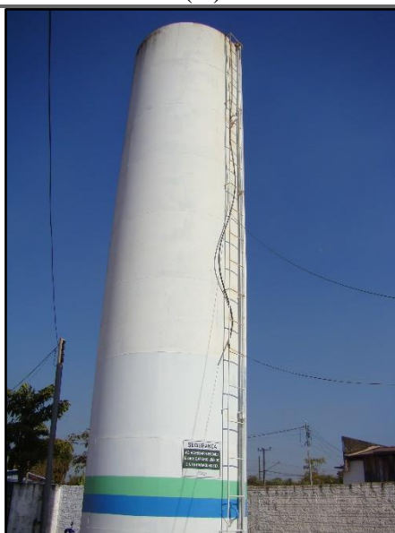
Figura 41. Reservatório metálico instalado ( (A)
