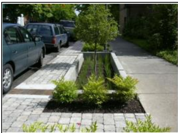
Figura 82. Trincheira de infiltração no passeio
