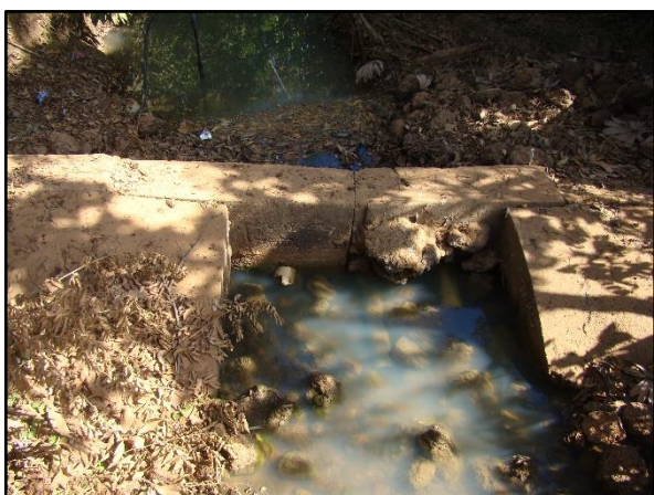
Figura 48. Barragem construída para captação superficial do Córrego Bonjaguá (A), Tubulação da captação aflorando (B), Área de proteção dos conjuntos motor-bombas (C) e conjunto motor-bomba instalado e o reserva (D)
