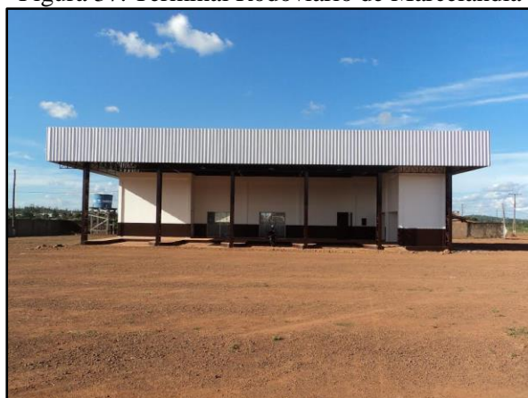
Figura 37. Terminal Rodoviário de Marcelândia
