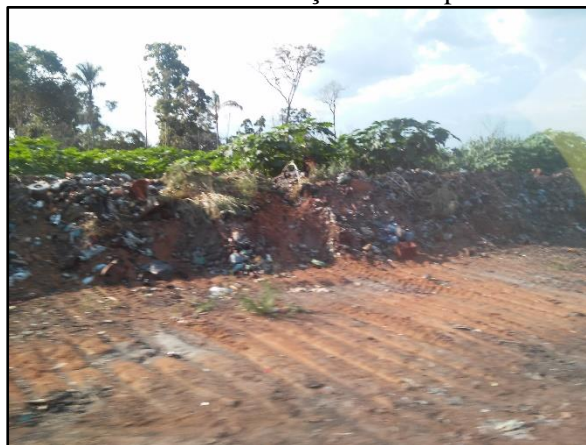
Figura 35. Resíduos de construção civil depositados no lixão
