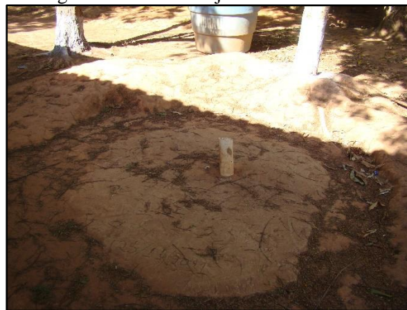
Figura 52. Vista da laje da fossa existente
