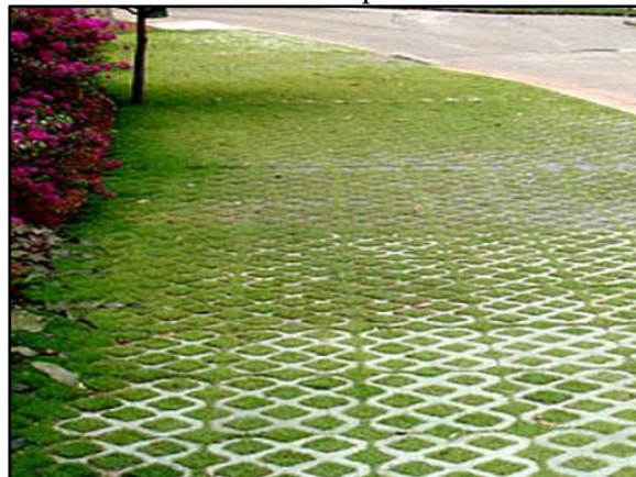
Figura 79. Pavimento poroso – concregrama instalado em passeio
