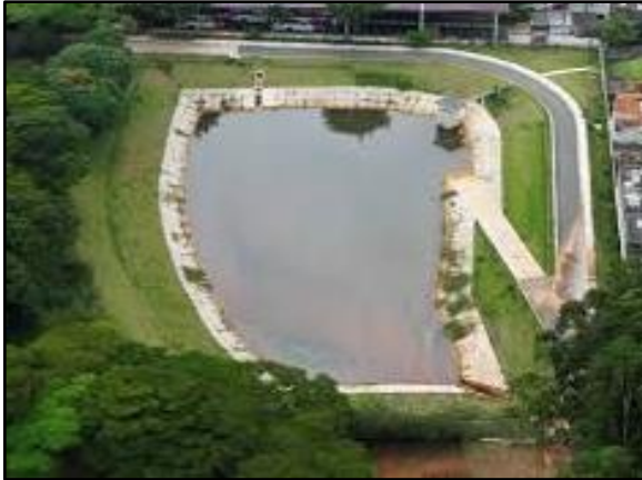
Figura 86. Bacia de detenção
