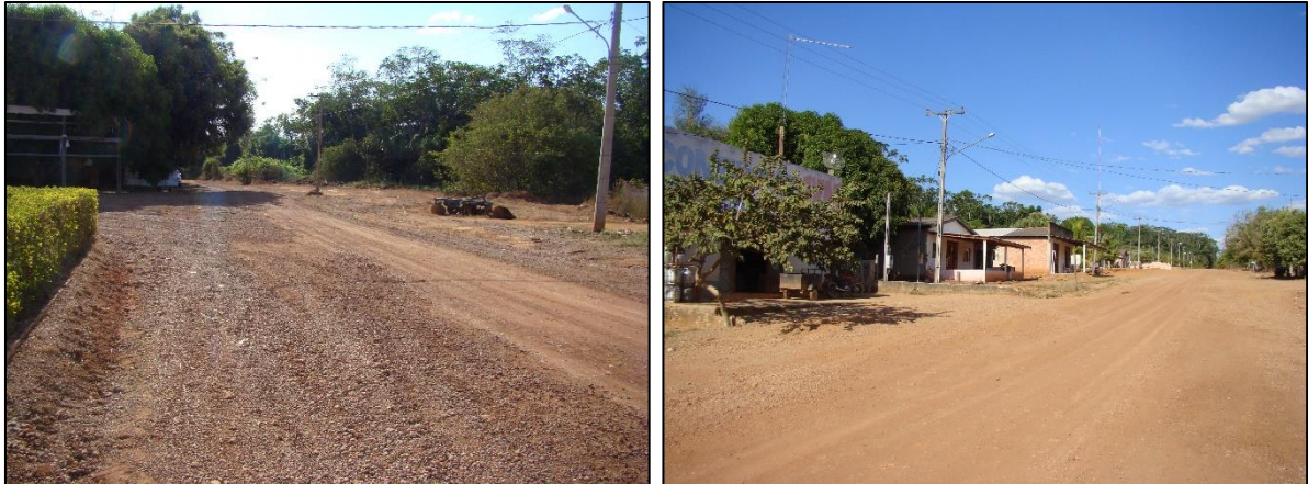
Figura 53. Vias não pavimentadas na comunidade
