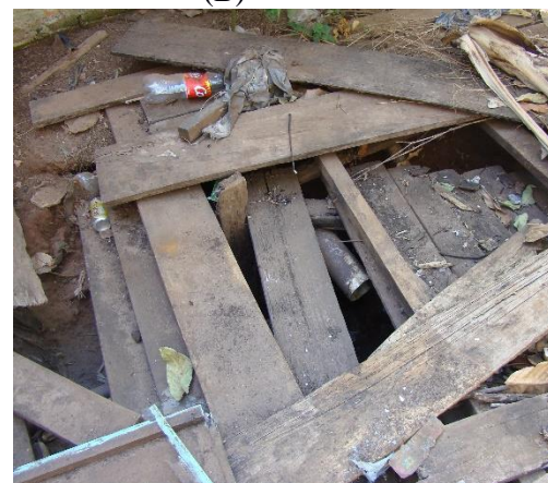
Figura 43. Cavalete com hidrômetro (A) e vista de fossa negra sem laje de proteção (B)
