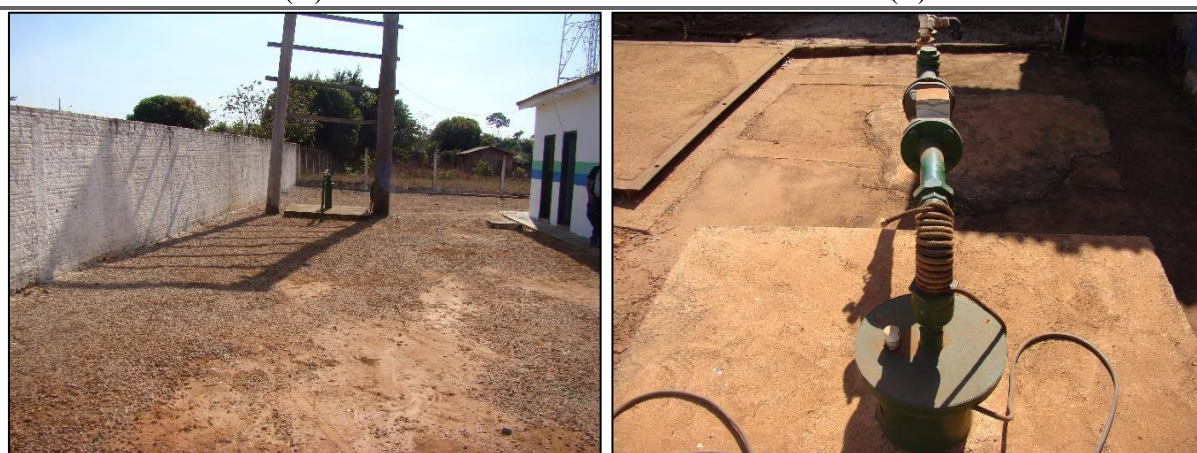
Figura 39. (A) Visão geral do PT-01 (B) Visão geral do PT-02 (A) (B)
