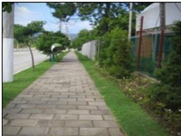
Figura 84. Vala de detenção ao longo da rua
