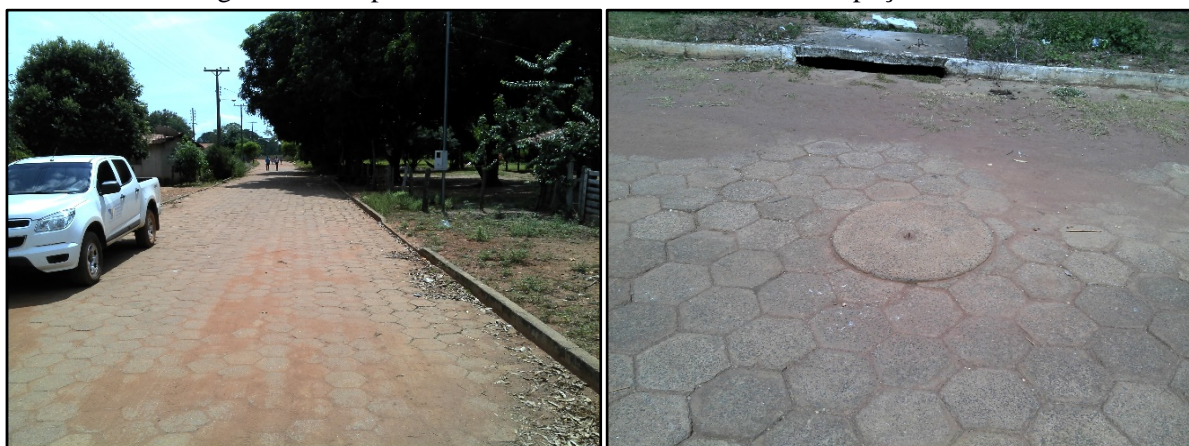
Figura 61. Via pavimentada e detalhe de boca de lobo e poço de visita
