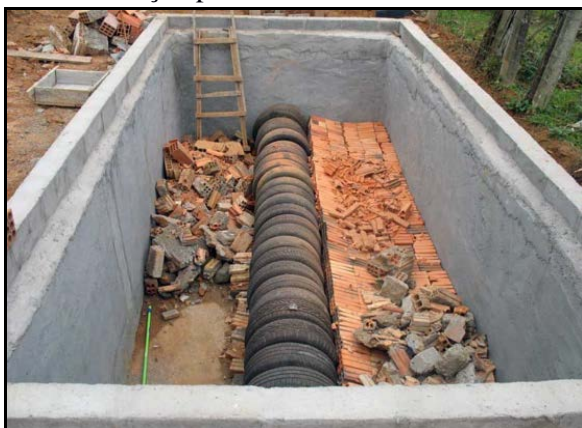
Figura 145. Método do círculo de bananeiras em execução para tratamento individual
