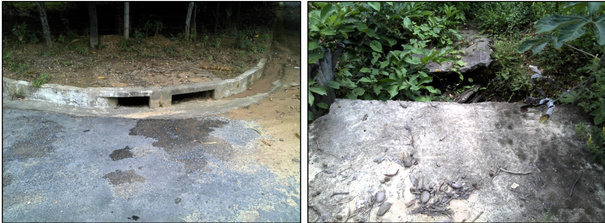
Figura 86. Detalhe de boas de lobo e dissipador de energia
