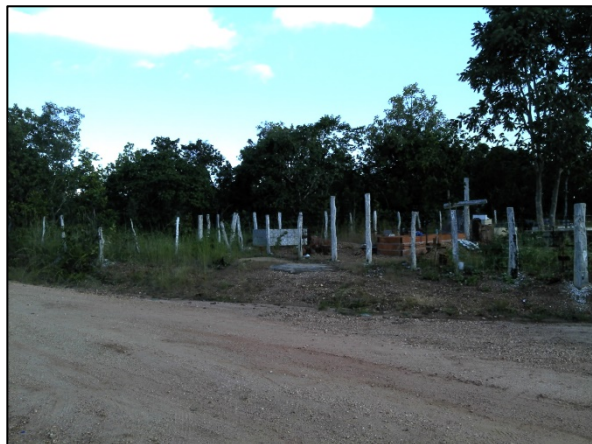
Figura 104. Via não pavimentada
