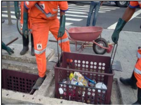
Figura 149. Cesta acoplada à boca do bueiro
