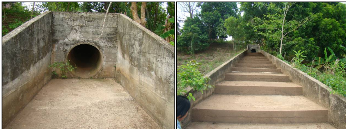
Figura 38. Saída d'água no segundo dissipador instalado no córrego Ribeirão
