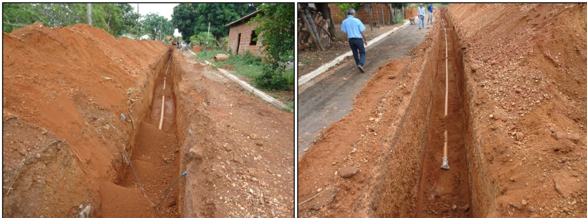
Figura 27. Execução das redes coletoras que estão desativadas
