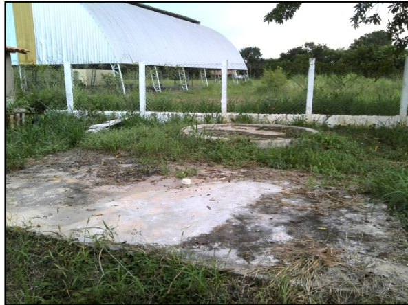
Figura 76. Sistema de tratamento de efluentes da escola
