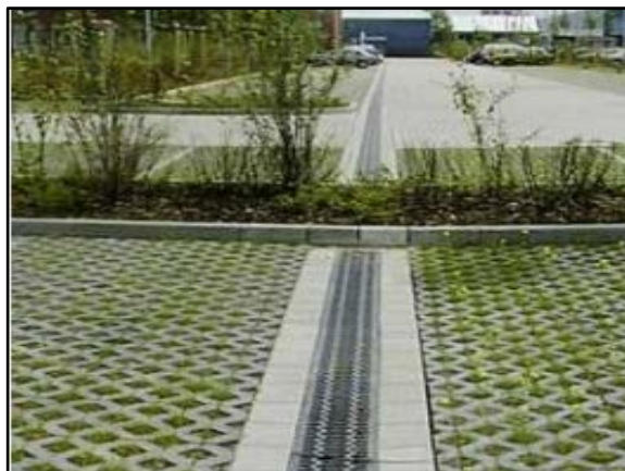
Figura 158. Trincheira de infiltração no estacionamento
