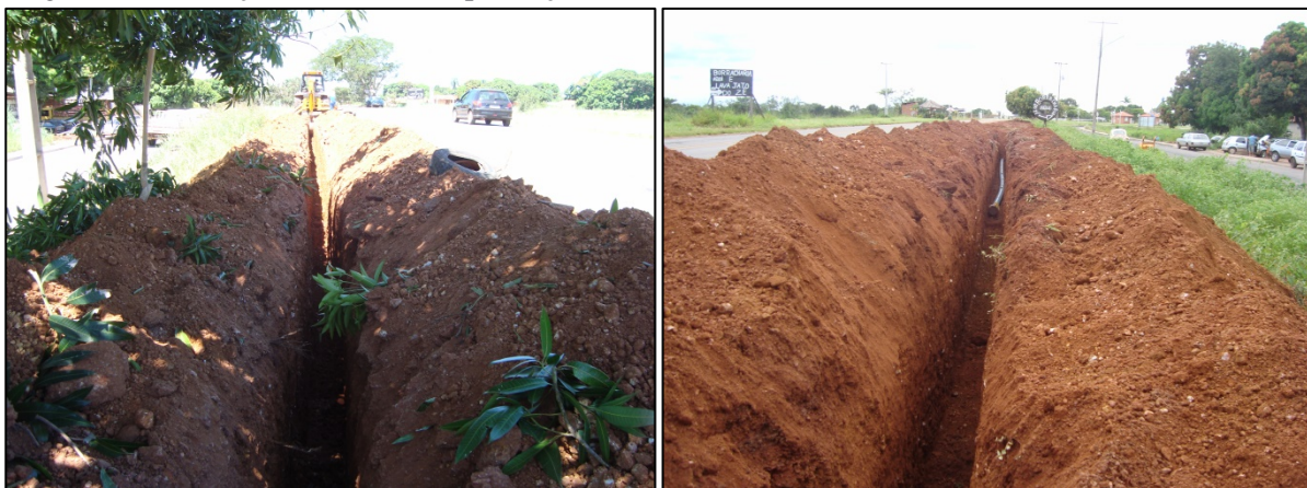
Figura 15. Execução da obra de implantação do caminhamento da adutora entre PT – 06 e RAP - 01
