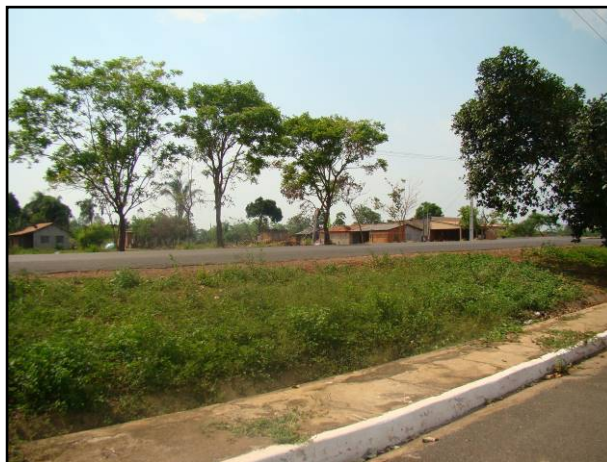
Figura 34. Canalização do Córrego Ribeirão
