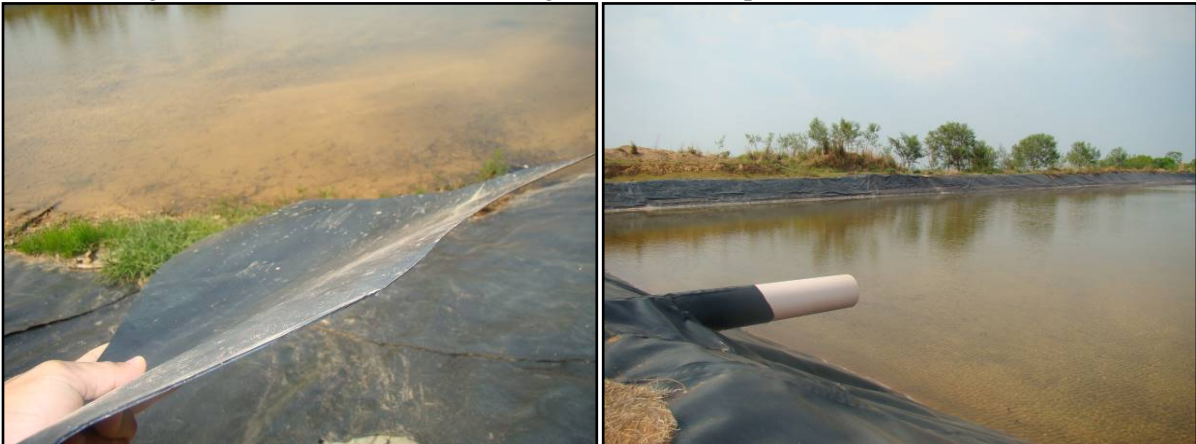
Figura 32- Manta de Geotêxtil na lagoa facultativa e ponto de entrada do efluente
