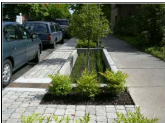
Figura 157. Trincheira de infiltração no passeio
