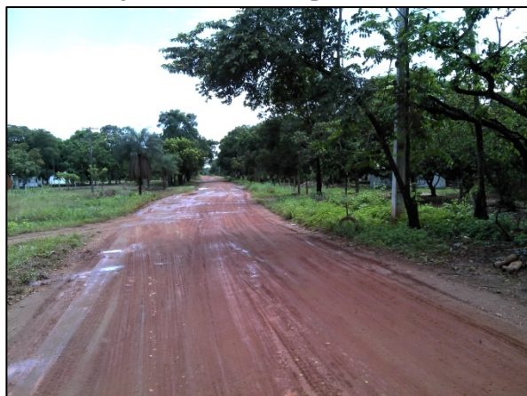
Figura 122. Via não pavimentada
