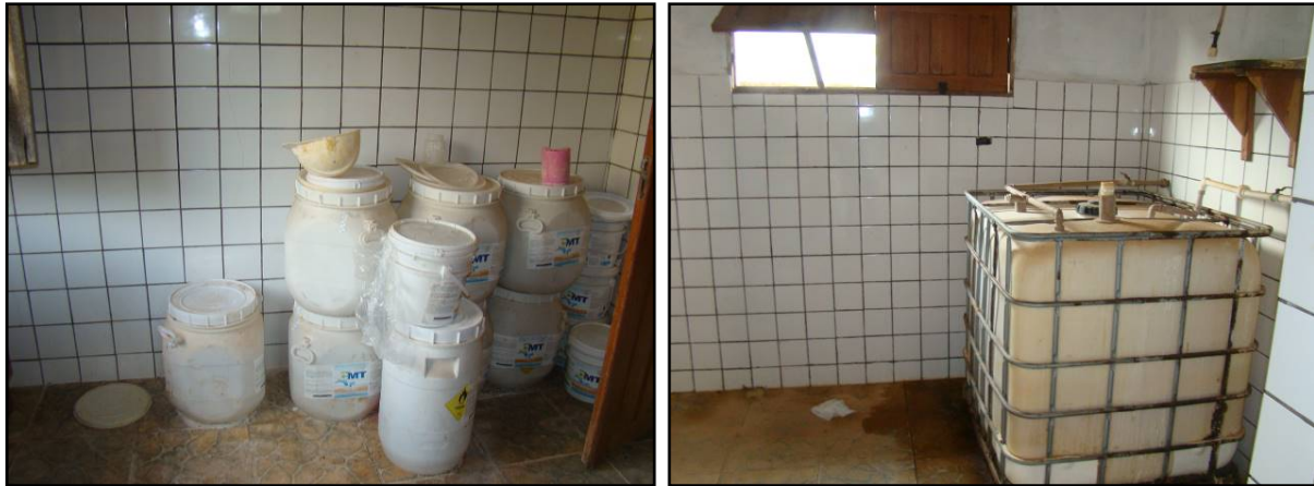
Figura 19. Armazenamento do hipoclorito de sódio e bombonas de cloro
