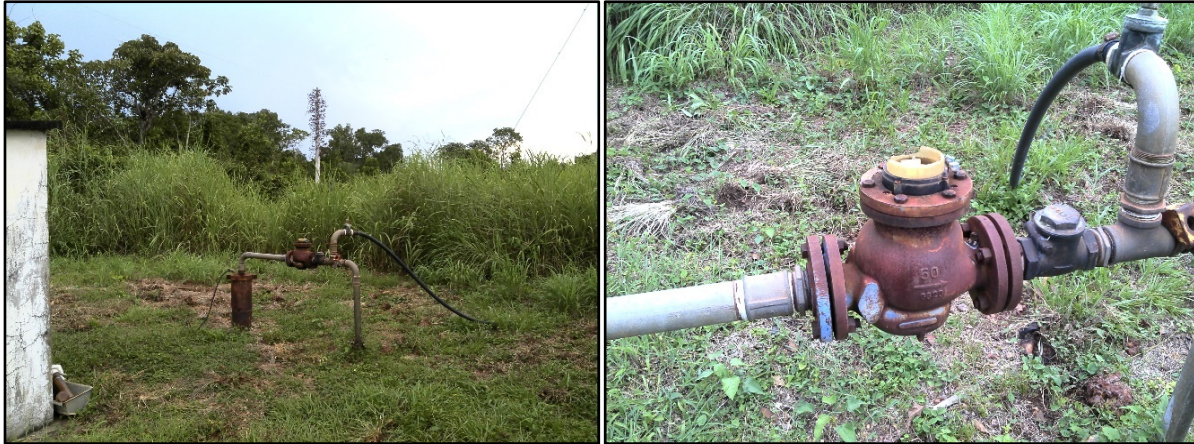
Figura 69. PT-01 e seu macro medidor
