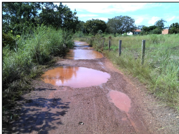
Figura 126. Via não pavimentada
