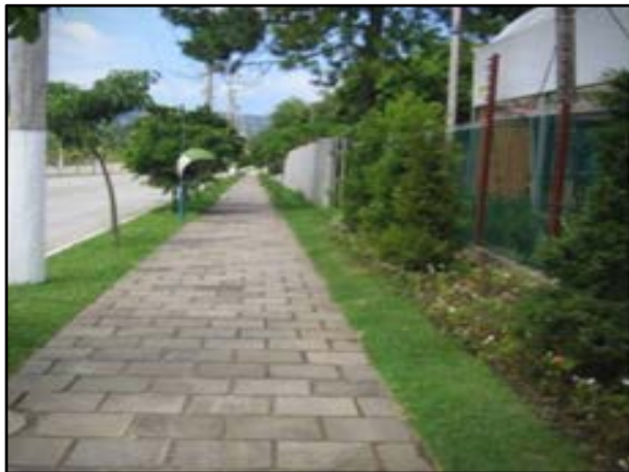
Figura 159. Vala de detenção ao longo da rua
