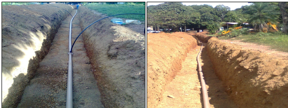
Figura 21. Execução da obra de redes de abastecimento
