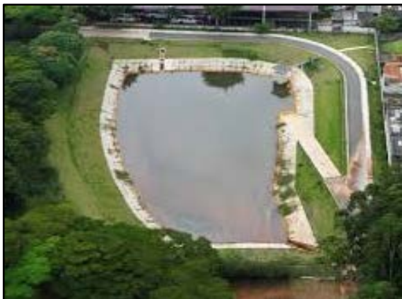
Figura 161. Bacia de detenção
