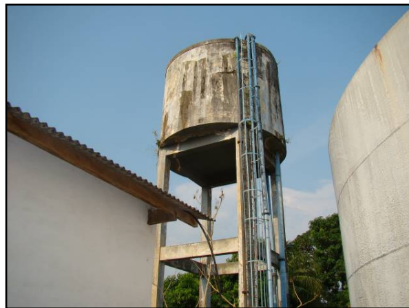
Figura 18. REL – 01, reservatório desativado
