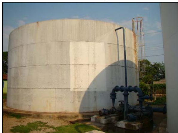
Figura 16. RAP – 01, apoiado metálico
