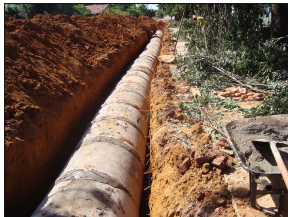
Figura 37. Obra de drenagem Livio Mendes
