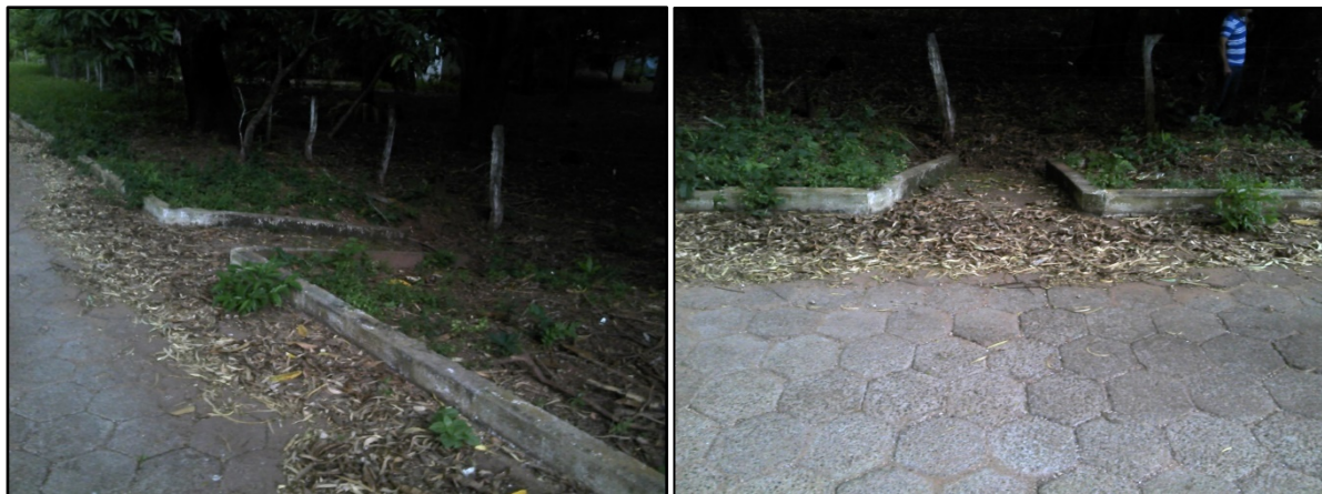
Figura 77. Drenagem do distrito
