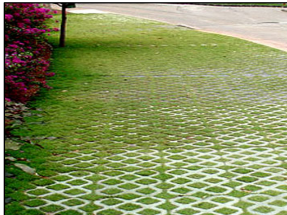
Figura 154. Pavimento poroso – concregrama instalado em passeio
