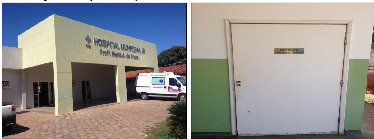
Figura 49. Hospital Municipal de Livramento e local de acondicionamento dos RSS
