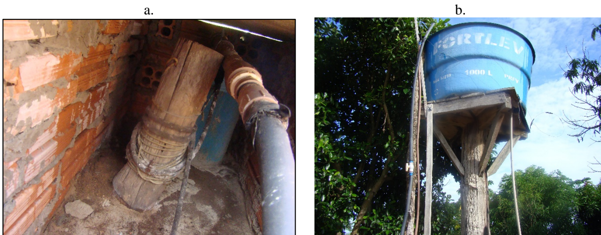
Figura 49. Poço tubular particular (a), Reservatório de polietileno de 1.000 litros (b), Fica Faca, Nova Brasilândia - MT
