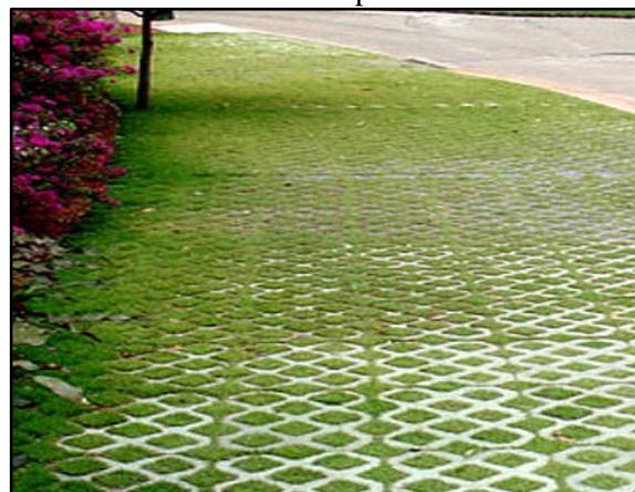
Figura 71. Pavimento poroso – concregrama instalado em passeio
