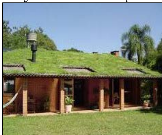
Figura 69. Telhado verde com plantas
