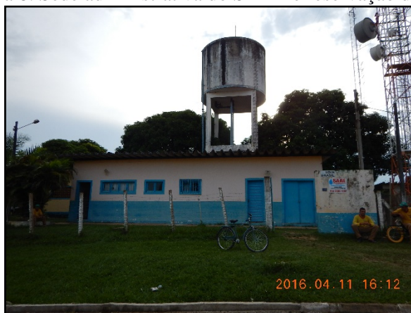
Figura 8. Sede administrativa do SAAE e reservação de água
