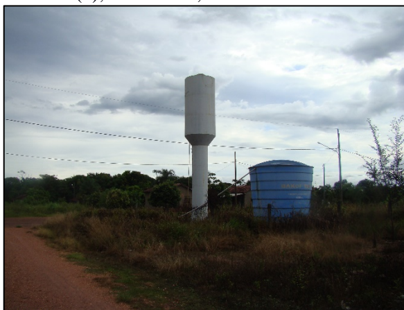
Figura 53. Reservatório metálico do tipo taça de 5.000 litros (a), Reservatório de polietileno de 20.000 litros (b), Serra Azul, Nova Brasilândia-MT
