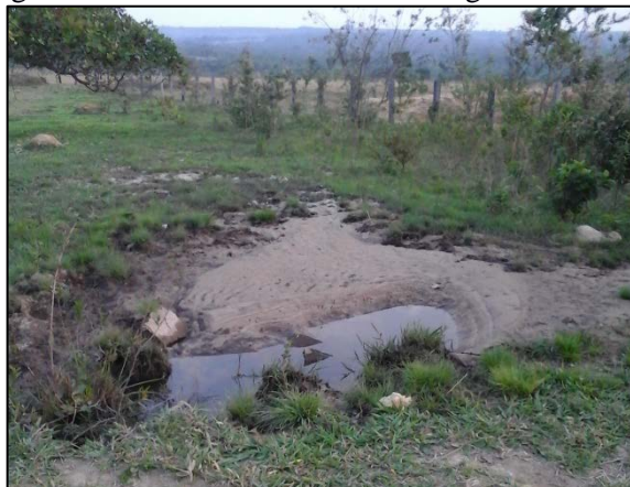
Figura 39. Local de descarte do lodo gerado na ETA
