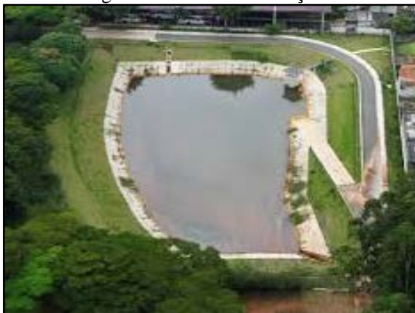
Figura 78. Bacia de detenção
