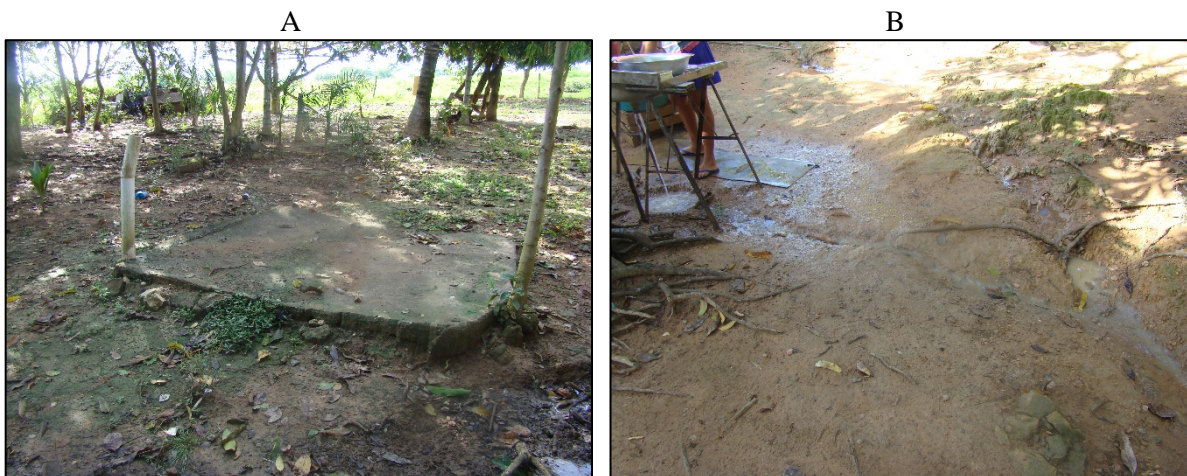
Figura 50. Fossas rudimentares (a) águas cinzas despejadas a céu aberto (b), Fica-Faca, Nova Brasilândia-MT
