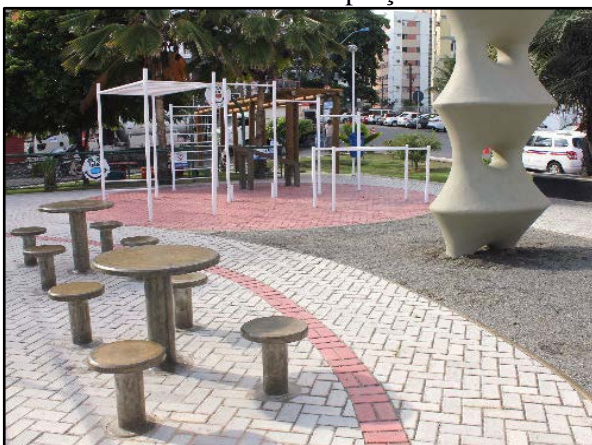
Figura 70. Pavimento poroso – piso intertravado instalado em praça
