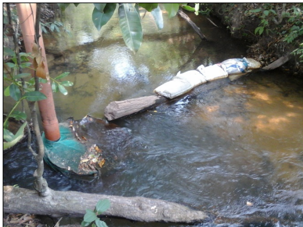
Figura 10. Barragem de nível construída no ribeirão (a), ponto de captação de água (b), conjunto motor-bomba (c) e área da captação (d) no Ribeirão Caiana em Nova Brasilândia
