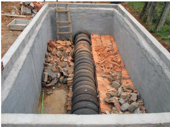
Figura 62. Método do círculo de bananeiras em execução para tratamento individual
