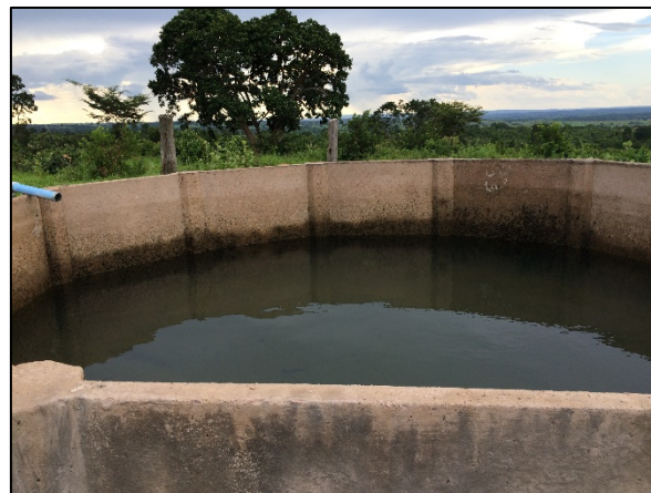
Figura 48. Reservatório de polietileno de 16.000 litros (a), Reservatório de concreto de 15.000 litros (b), Reservatório de polietileno de 16.000 litros que apresenta vazamentos (c e d), Fica-Faca
