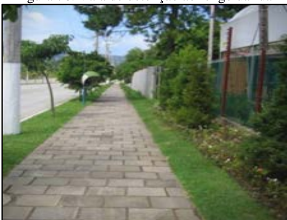
Figura 76. Vala de retenção ao longo da rua
