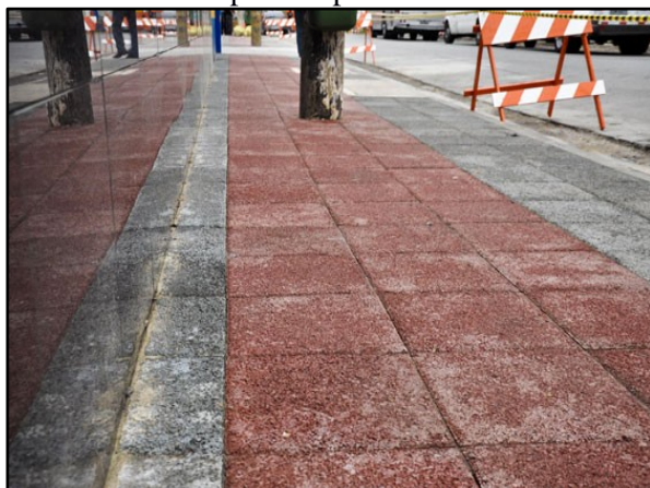
Figura 72. Pavimento poroso – instalado em passeio público
