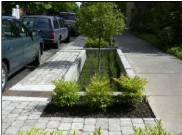
Figura 74. Trincheira de infiltração no passeio
