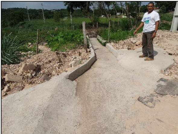
Figura 28. Dispositivos hidráulicos de contenção das águas de chuva (A) visão da entrada do dissipador de energia (B) visão da extensão do dissipador de energia
