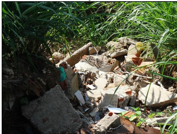
Figura 37. Resíduos de Construção Civil em erosão de drenagem
