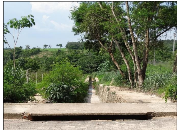
Figura 28. Dispositivos hidráulicos de contenção das águas de chuva (A) visão da entrada do dissipador de energia (B) visão da extensão do dissipador de energia
