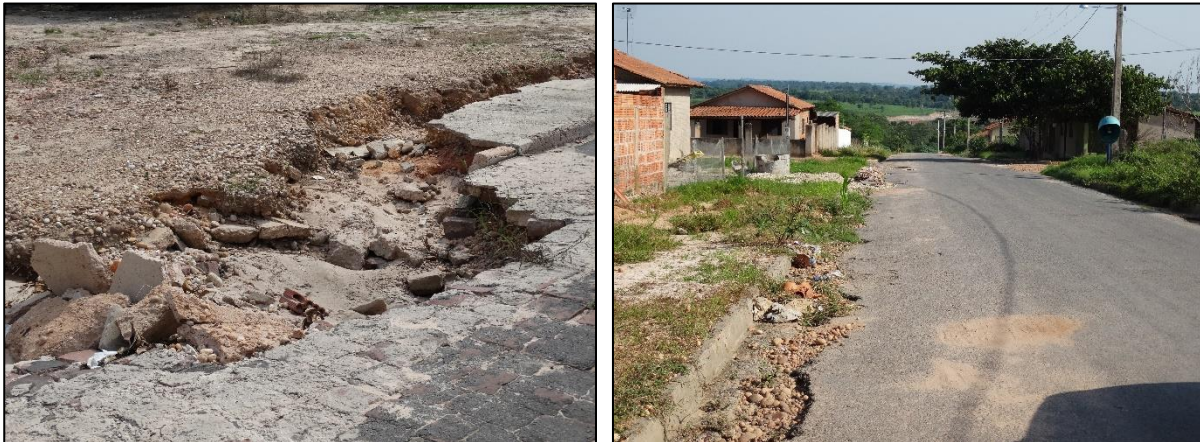
Figura 21. Erosões no pavimento das vias do bairro Renascer (A) erosões intensas que podem colocar em risco os pedestres que ali transitam (B) vista geral de uma via com erosão na parte lateral (A) (B)
