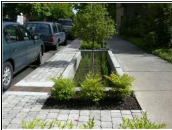
Figura 67. Trincheira de infiltração no passeio
