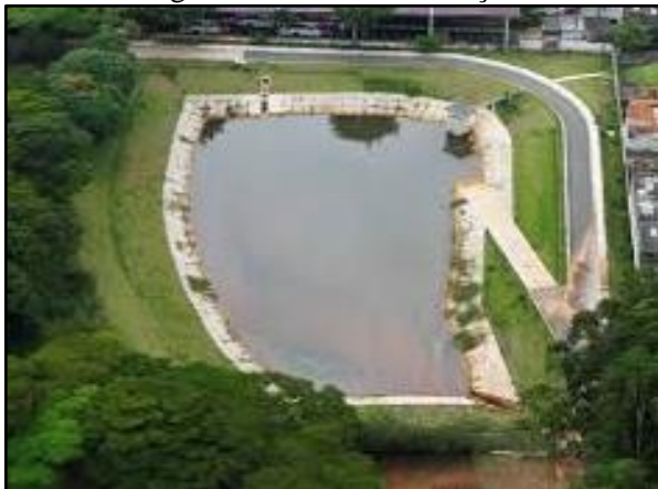
Figura 71. Bacia de detenção
