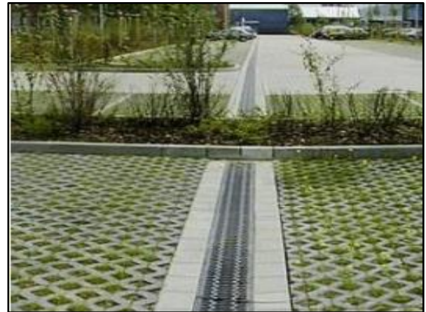
Figura 68. Trincheira de infiltração no estacionamento
