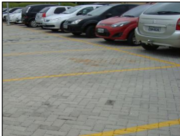
Figura 66. Pavimento poroso instalado em estacionamento
