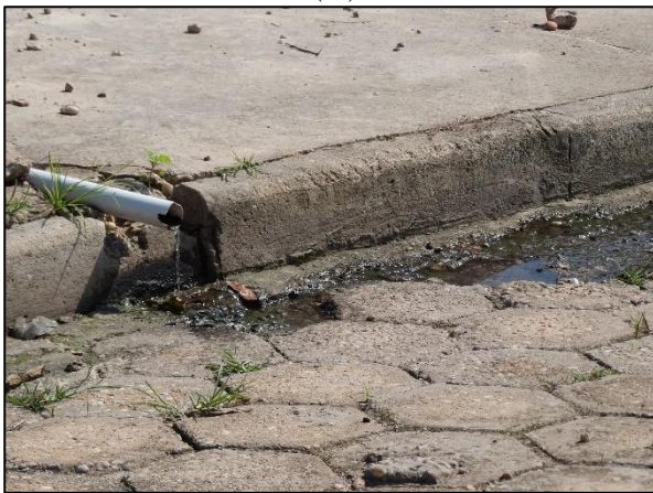
Figura 18. (A) Despejo de água servida (B) Transbordamento de fossa (A) (B)
