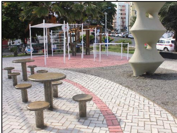
Figura 63. Pavimento poroso – piso intertravado instalado em praça
