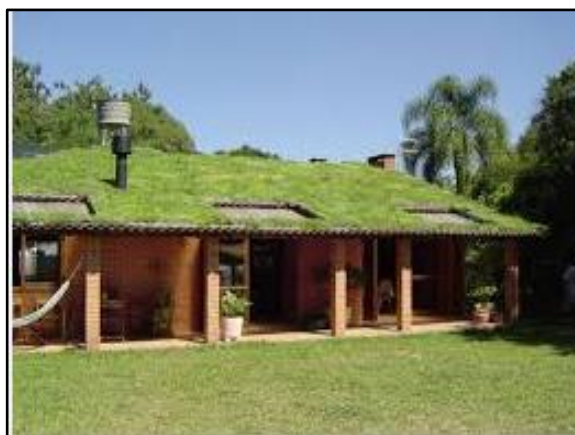
Figura 62. Telhado verde com plantas
