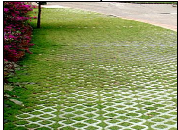
Figura 64. Pavimento poroso – concregrama instalado em passeio
