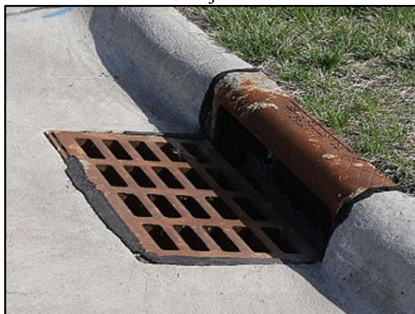
Figura 60. Boca de lobo com gradeamento na sarjeta
