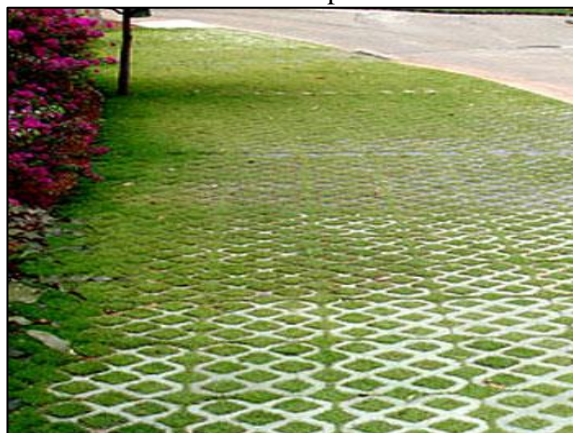
Figura 75. Pavimento poroso – concregrama instalado em passeio
