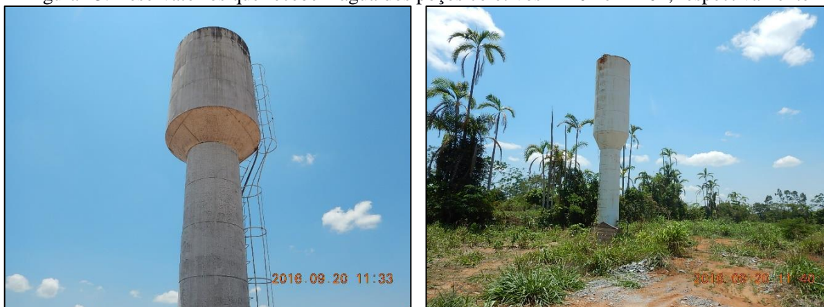
Figura 13. Reservatórios que recebem água dos poços coletivos PT-01 e PT-02, respectivamente
