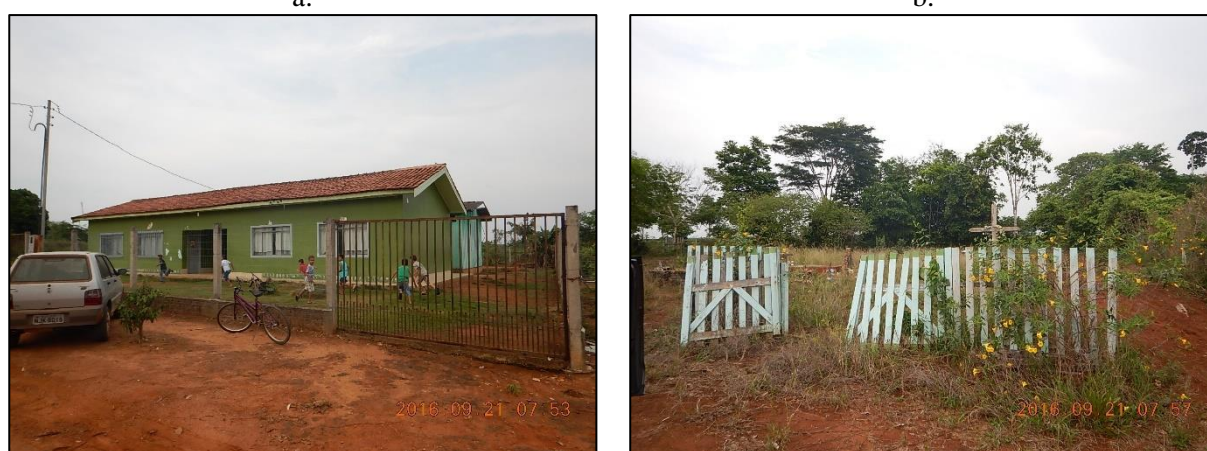
Figura 46. (a) Escola Municipal e (b) cemitério na comunidade Alto Paraíso
