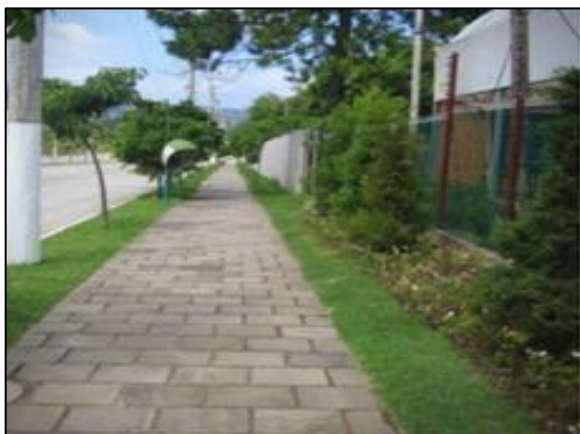
Figura 80. Vala de retenção ao longo da rua
