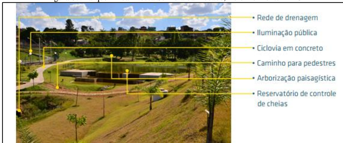
Figura 87. Parque Linear Nossa Senhora da Piedade, Belo Horizonte – MG
