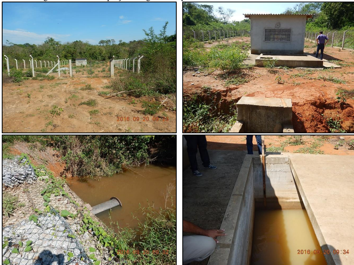
Figura 9. Área de captação de água bruta para abastecimento de Nova Monte Verde
