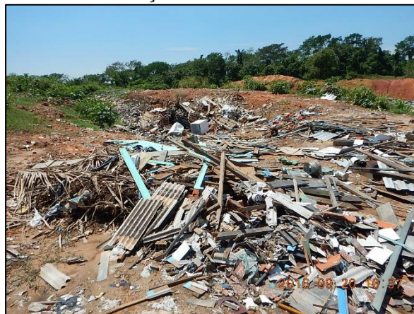
Figura 35. Resíduos de demolição destinados no lixão de Nova Monte Verde
