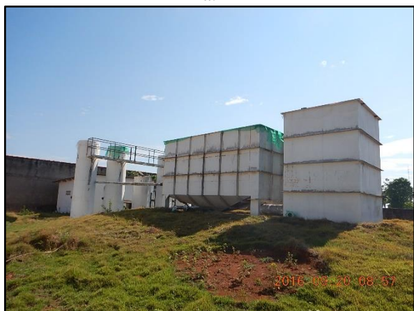
Figura 10. Estrutura (a) e tanque de contato (b) da ETA de Nova Monte Verde
