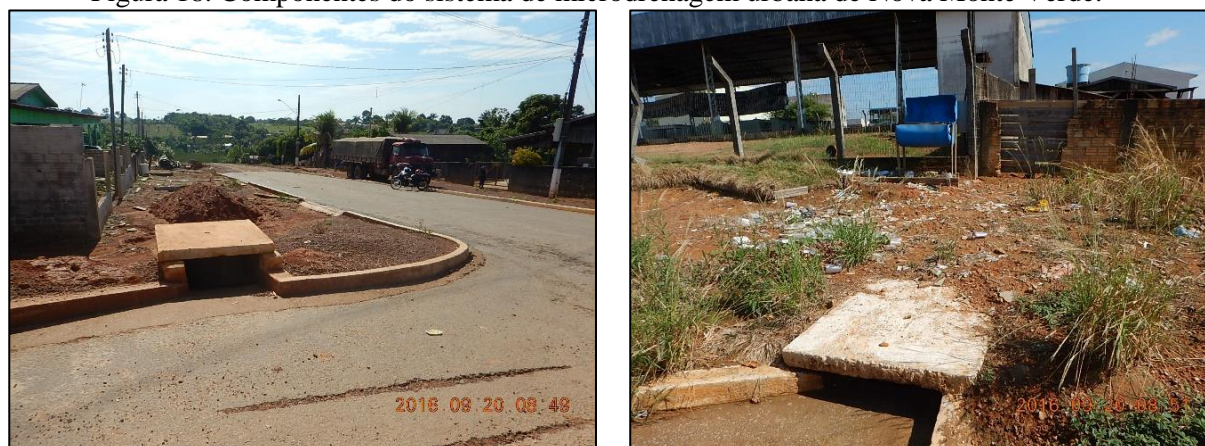
Figura 18. Componentes do sistema de microdrenagem urbana de Nova Monte Verde.
