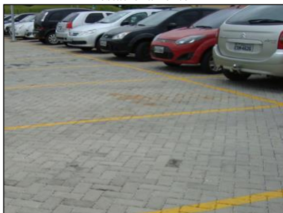
Figura 77. Pavimento poroso instalado em estacionamento
