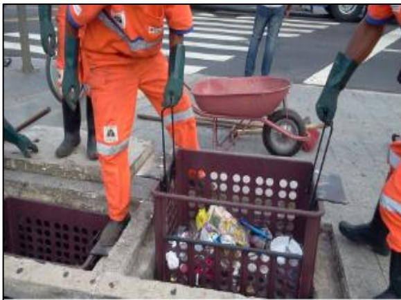
Figura 70. Cesta acoplada à boca do bueiro
