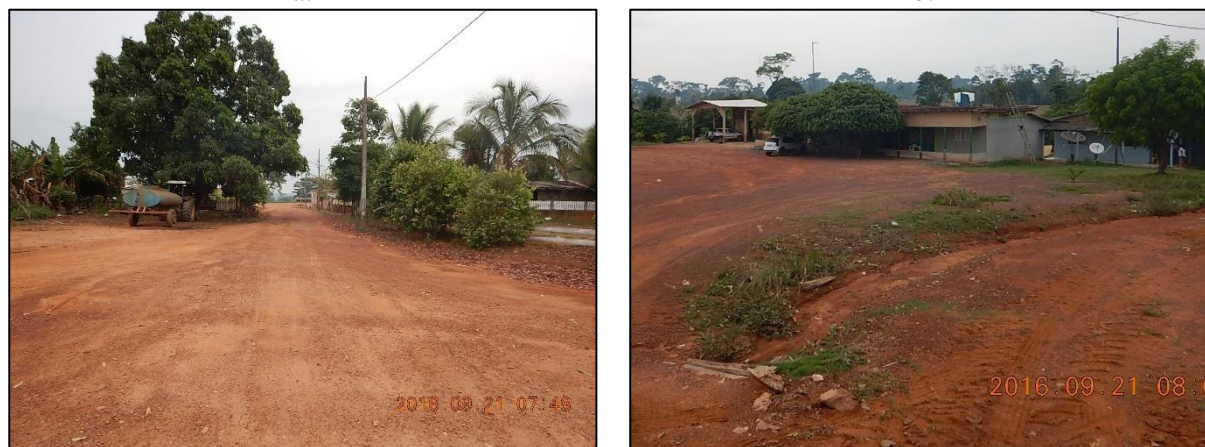
Figura 50. Via não pavimentada (a) e processos erosivos (b) na comunidade Alto Paraíso a. b.
