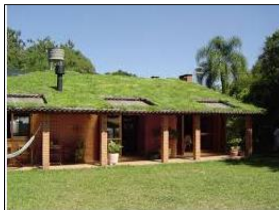
Figura 73. Telhado verde com plantas
