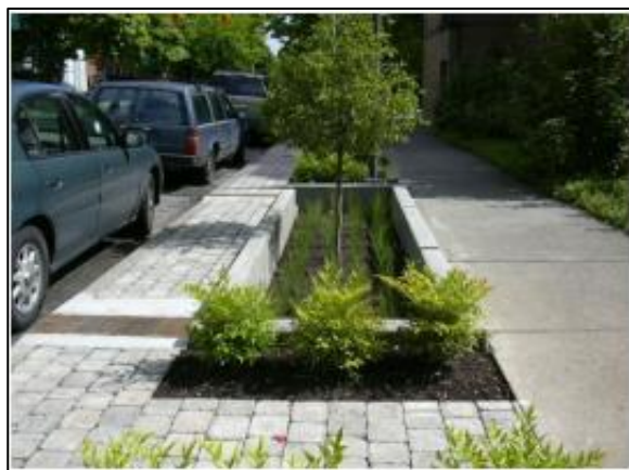
Figura 78. Trincheira de infiltração no passeio
