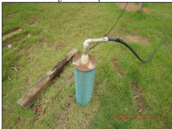
Figura 41. Poços tubulares utilizados na comunidade de São José do Apuy
