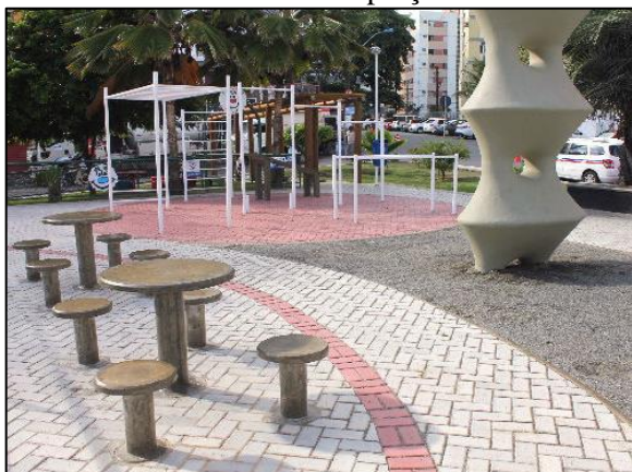
Figura 74. Pavimento poroso – piso intertravado instalado em praça
