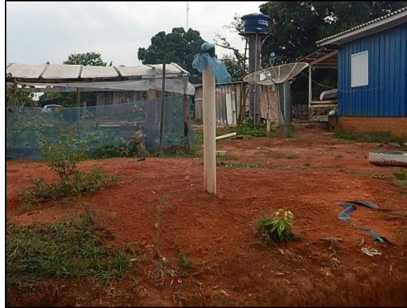
Figura 49. Vista exterior de fossa na comunidade Alto Paraíso
