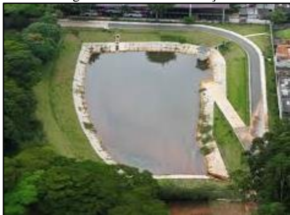
Figura 82. Bacia de detenção
