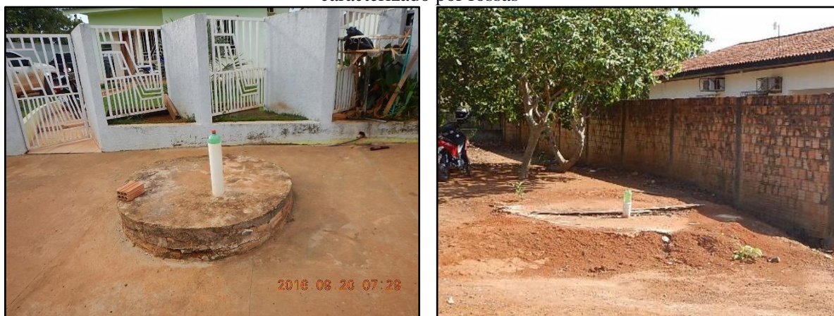
Figura 15. Soluções individuais de esgotamento sanitário adotados em Nova Monte Verde, caracterizado por fossas
