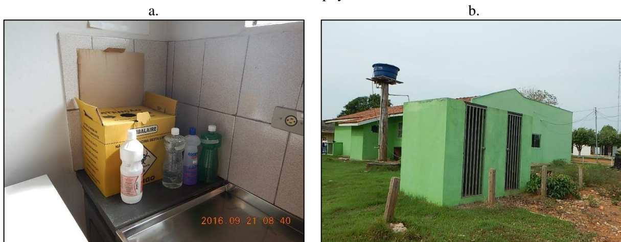
Figura 45. Acondicionamento interno (a) e externo (b) dos resíduos do PSF da comunidade de São José do Apuy
