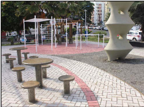
Figura 72. Pavimento poroso – piso intertravado instalado em praça
