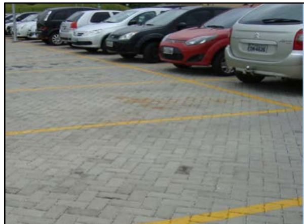
Figura 75. Pavimento poroso instalado em estacionamento
