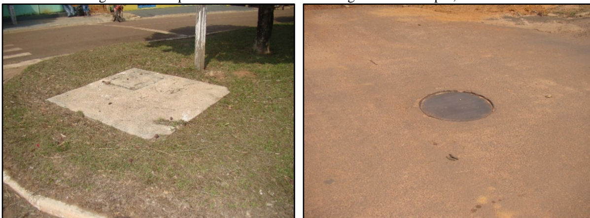
Figura 33. Componentes do sistema de drenagem do município, PV e BL
