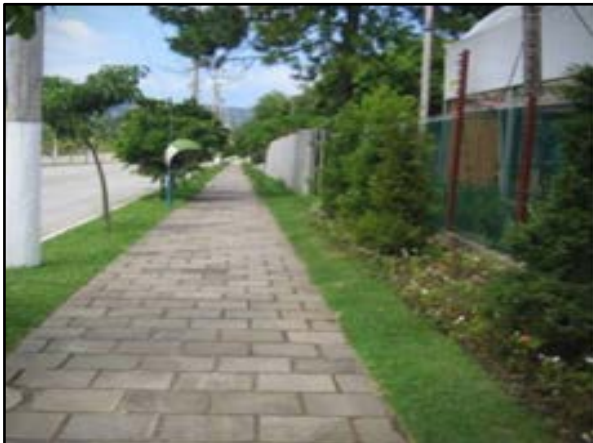
Figura 78. Vala de detenção ao longo da rua
