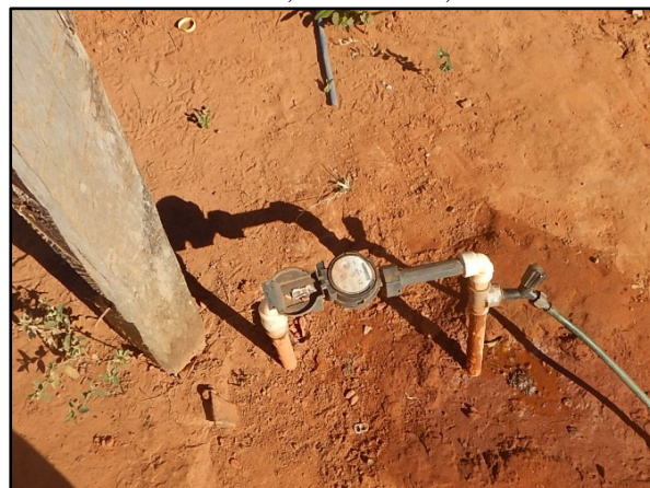
Figura 46. Cavalete com hidrômetro, Carvalho 1, Novo Horizonte do Norte-MT
