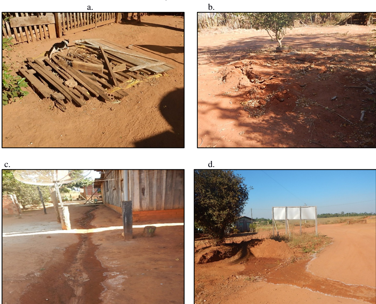
Figura 47. Vista exterior de fossa com tampa em madeira (a) e fossa coberta com madeira e terra, Carvalho 1, Novo Horizonte-MT
