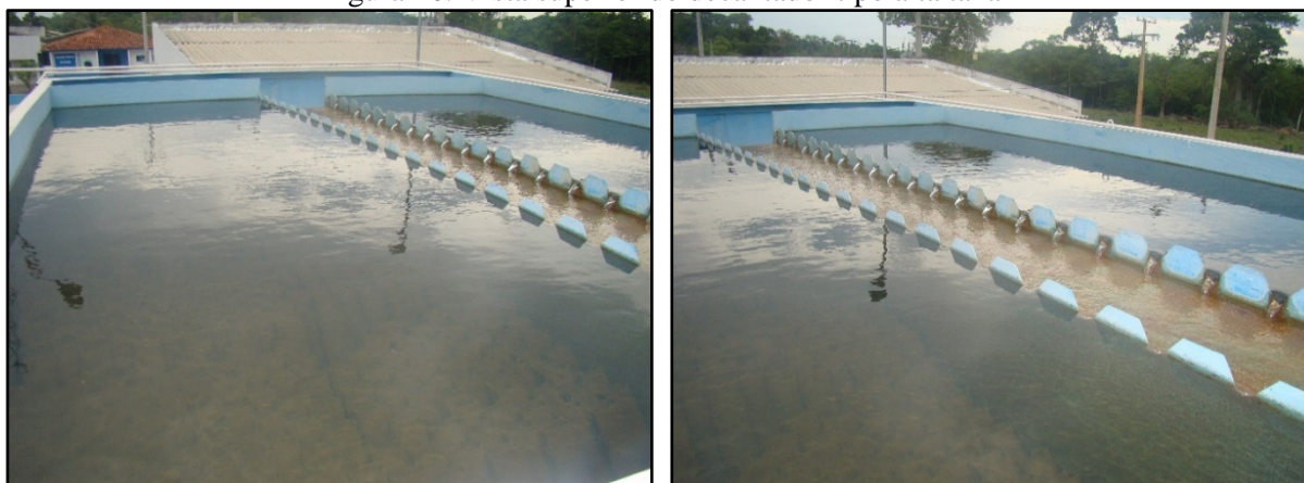
Figura 16. Vista superior do decantador tipo alta taxa
