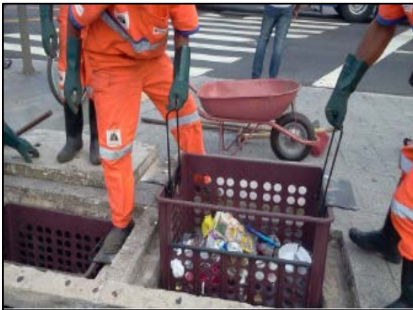
Figura 68. Cesta acoplada à boca do bueiro
