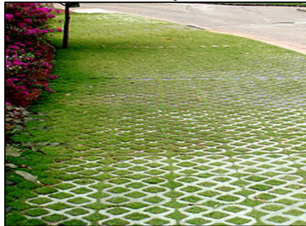
Figura 73. Pavimento poroso – concregrama instalado em passeio
