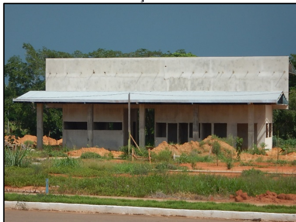
Figura 42. Rodoviária em construção de Novo Horizonte do Norte- MT
