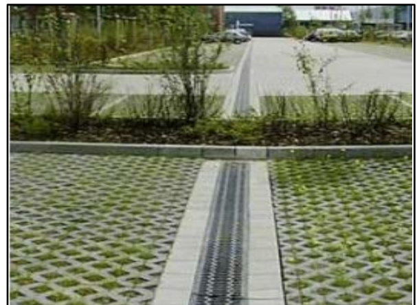
Figura 77. Trincheira de infiltração no estacionamento
