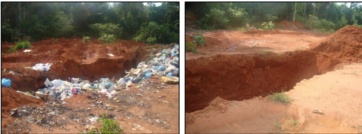
Figura 37. Disposição dos resíduos em vala aberta no lixão do município de Novo Horizonte do Norte- MT
