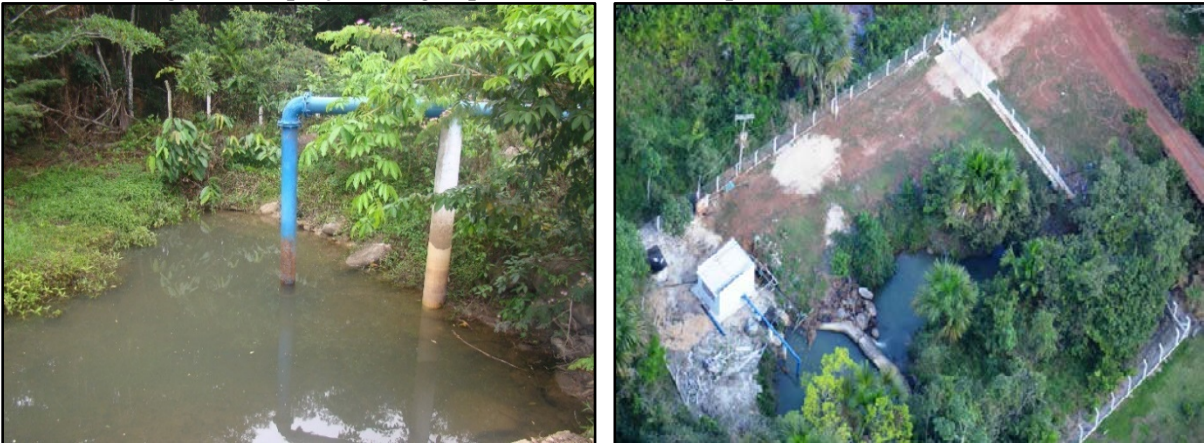
Figura 9. Captação de água por tomada direta em plataforma fixa e barramento
