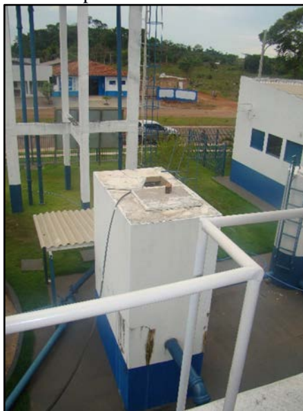
Figura 22. Vista superior da câmara de contato e nível II
