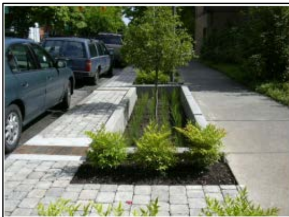
Figura 76. Trincheira de infiltração no passeio
