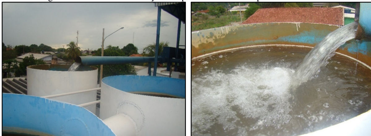
Figura 15. Câmaras de floculação do tipo circular e vista superior deles da ETA I
