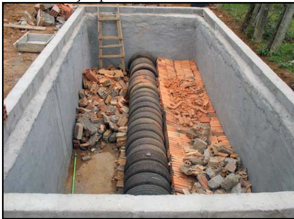
Figura 64. Método do círculo de bananeiras em execução para tratamento individual
