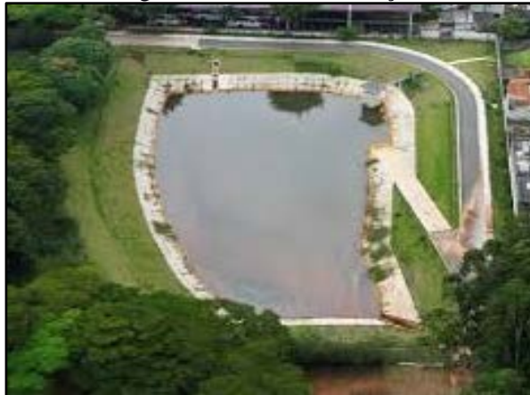
Figura 80. Bacia de detenção
