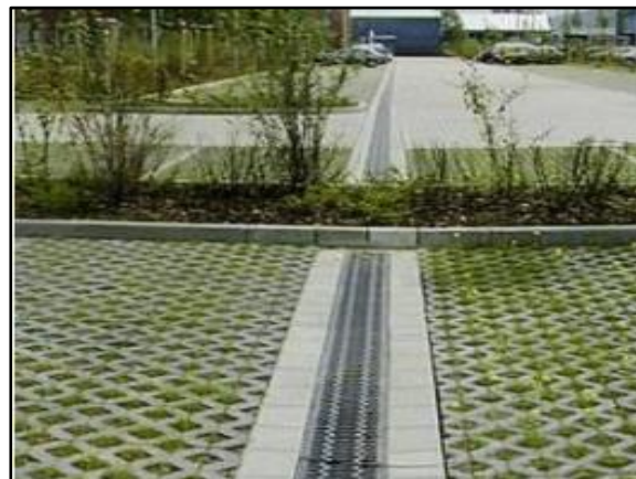
Figura 89. Trincheira de infiltração no estacionamento
