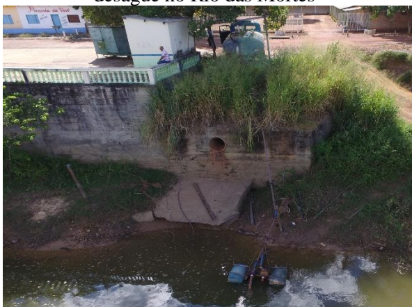
Figura 19. Vista da galeria de drenagem com desague no Rio das Mortes
