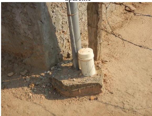
Figura 18. Fossa rudimentar, apenas com suspiro aparente
