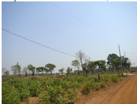
Figura 60. Via não pavimentada comunidade Murere, Novo Santo Antônio-MT
