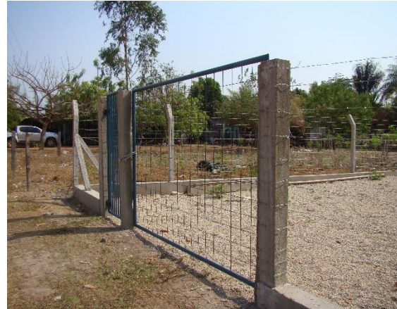
Figura 47. Área de proteção do poço do distrito Vila Trindade.
