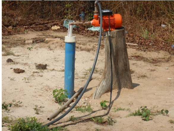
Figura 5. Poço tubular freático
