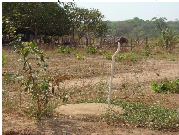
Figura 53. Vista da fossa, com suspiro, distrito Vila Trindade, Novo Santo Antônio-MT
