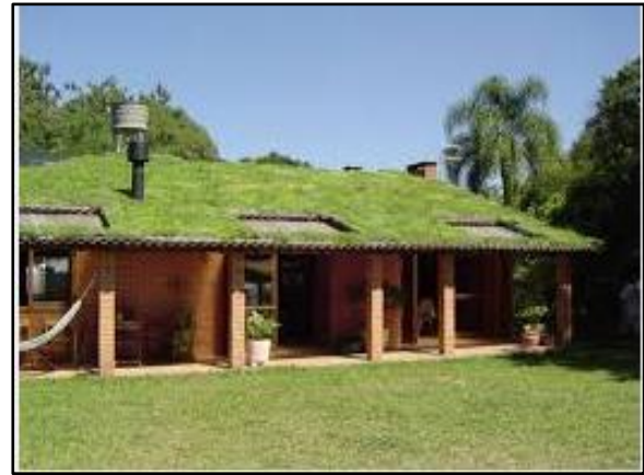
Figura 83. Telhado verde com plantas
