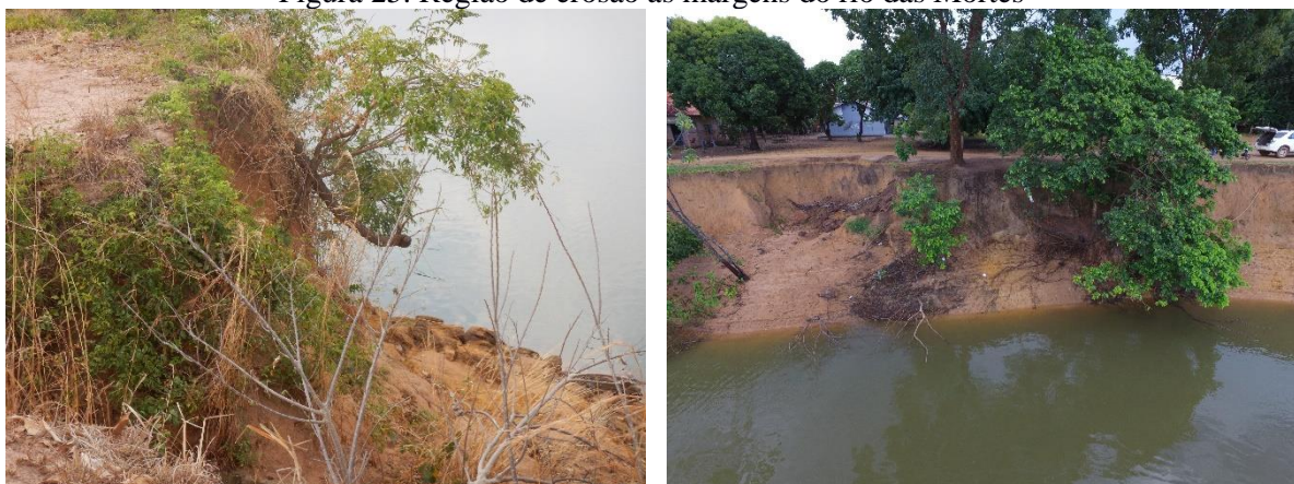
Figura 25. Região de erosão as margens do rio das Mortes
