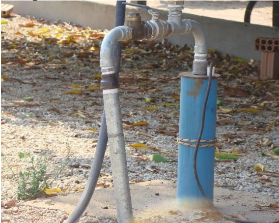
Figura 46. Poço tubular com encamisamento geomecânico distrito Vila Trindade
