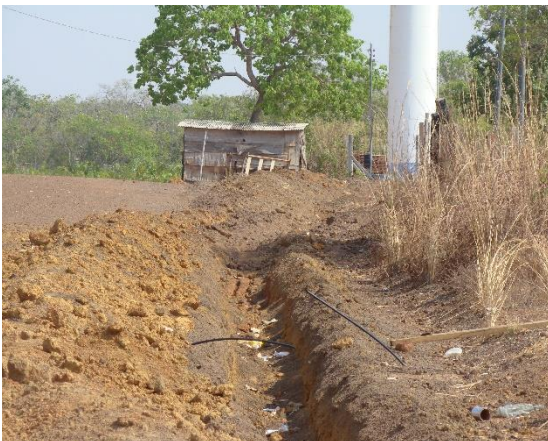
Figura 50. Obra de adução paralisada, distrito Vila Trindade
