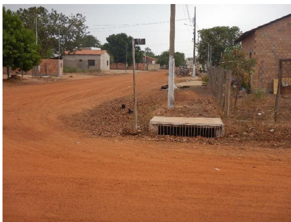
Figura 20. Baca de lobo com grelha de proteção
