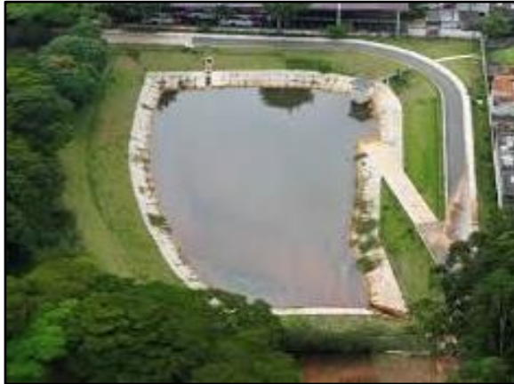
Figura 92. Bacia de detenção
