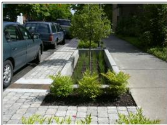
Figura 88. Trincheira de infiltração no passeio
