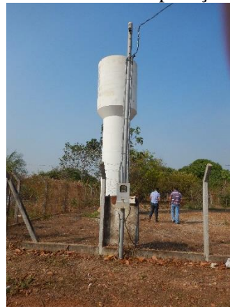
Figura 14. Reservatório tipo taça metálico
