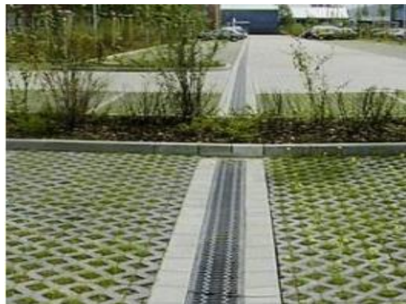
Figura 132. Trincheira de infiltração no estacionamento
