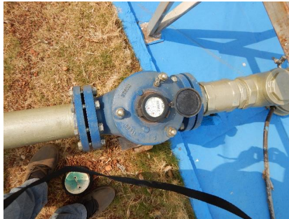
Figura 9. Macromedidor instalado na captação de água de Novo São Joaquim
