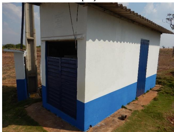
Figura 12. Abrigo do Painel de controle da bomba de captação do PT-01
