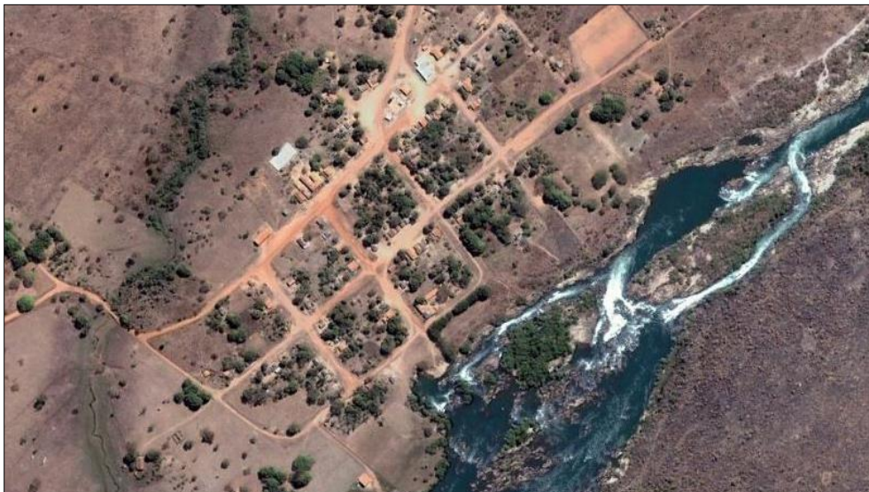
Figura 80. Vista aérea da sede do distrito Cachoeira da Fumaça às margens do rio das Mortes
