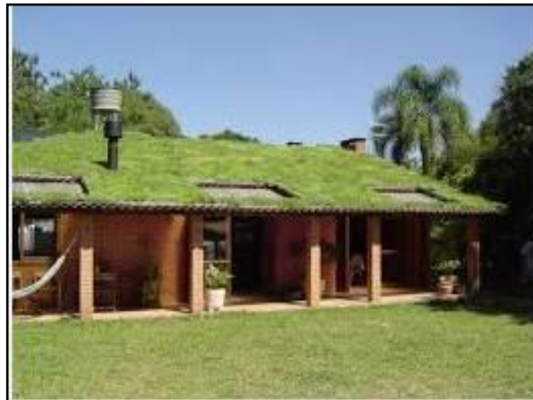
Figura 126. Telhado verde com plantas
