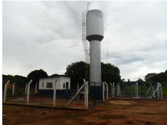
Figura 101. Vista do reservatório de água do distrito Itaquerê
