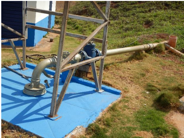
Figura 8. Vista do poço tubular utilizado para captação de água em Novo São Joaquim
