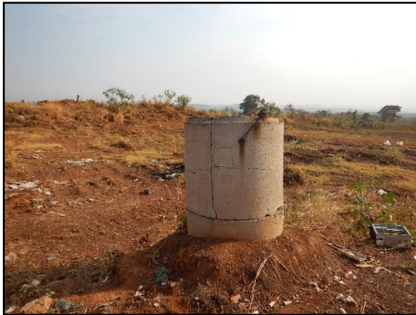
Figura 63. Vista da manilha utilizada para disposição dos RSS tipo E
