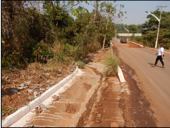
Figura 25. Vista parcial do sistema de microdrenagem na MT-110 em Novo São Joaquim, saída rápida
