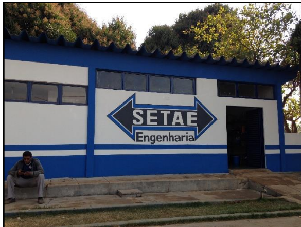
Figura 6. Vista da sede do SETAE em Novo São Joaquim
