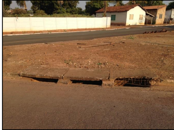
Figura 26. Boca de lobo tripla com a estrutura comprometida, situada na rua Joaquim R. de Souza
