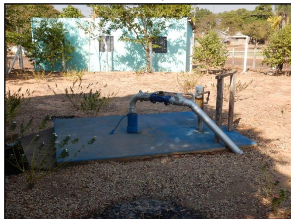
Figura 82. Poço tubular profundo do sistema de abastecimento de água do distrito
