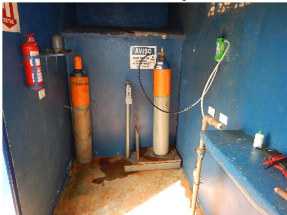
Figura 16. Vista dos cilindros de cloro utilizados em Novo São Joaquim
