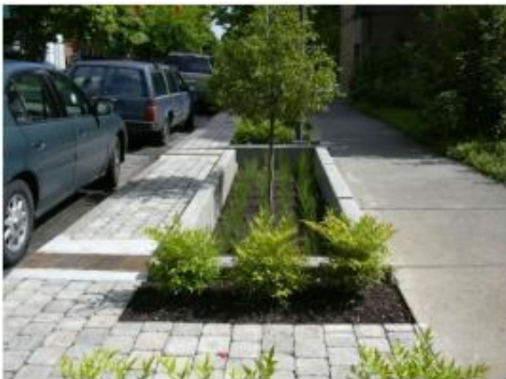
Figura 131. Trincheira de infiltração no passeio
