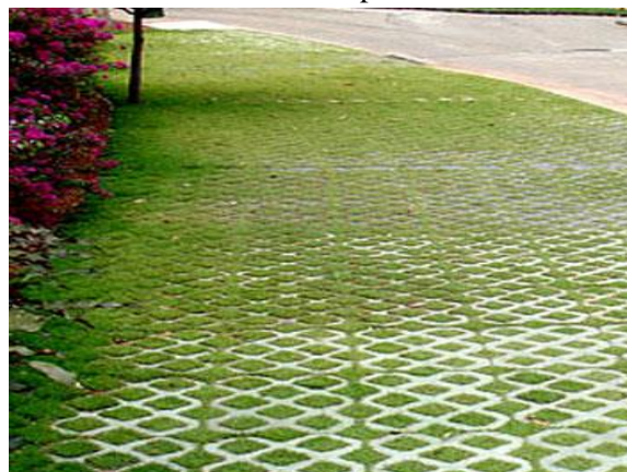
Figura 128. Pavimento poroso – concregrama instalado em passeio
