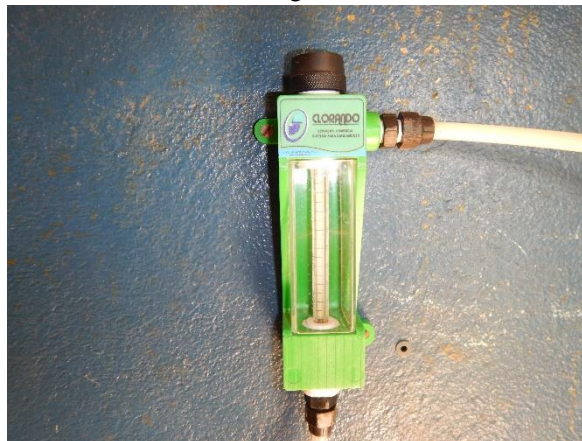
Figura 17. Dosador utilizado para a adição do cloro gasoso
