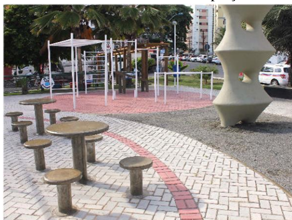
Figura 127. Pavimento poroso – piso intertravado instalado em praça
