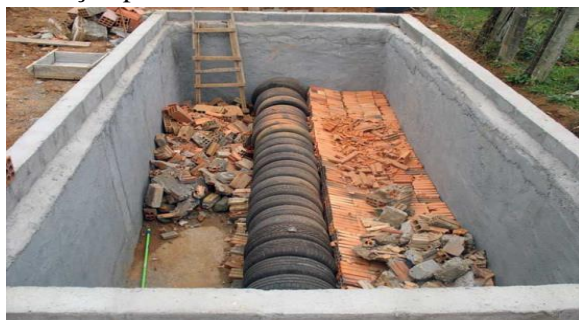
Figura 120. Método do círculo de bananeiras em execução para tratamento individual
