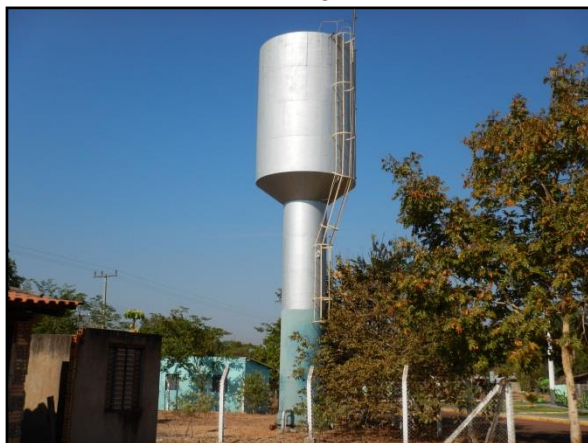
Figura 81. Reservatório do sistema de abastecimento de água do distrito
