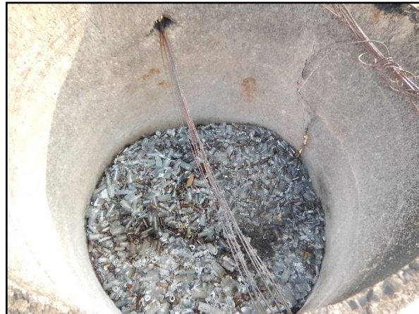
Figura 64. Vista dos RSS do tipo E acumulados e queimados dentro da tubulação
