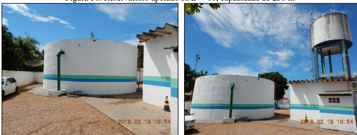
Figura 36. Reservatório apoiado RAP – 01, capacidade de 250 m 3
