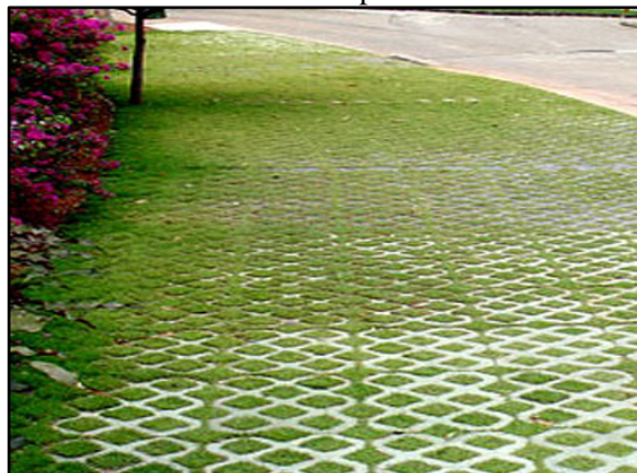
Figura 108. Pavimento poroso – concregrama instalado em passeio
