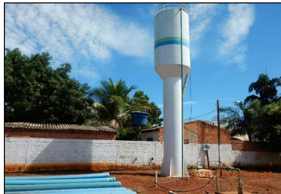
Figura 38: Reservatório metálico elevado de 50 m 3 - REL 02
