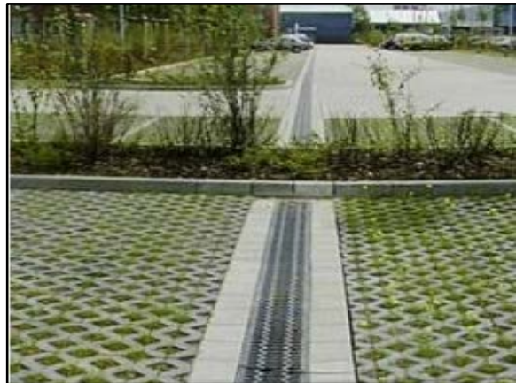
Figura 112. Trincheira de infiltração no estacionamento
