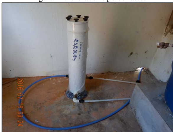
Figura 41. Clorador tipo contacto
