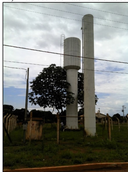
Figura 82. a) Vista do poço tubular; b) Vista dos reservatórios elevados de 35 m 3 e 25 m 3 a) Vista do poço tubular
