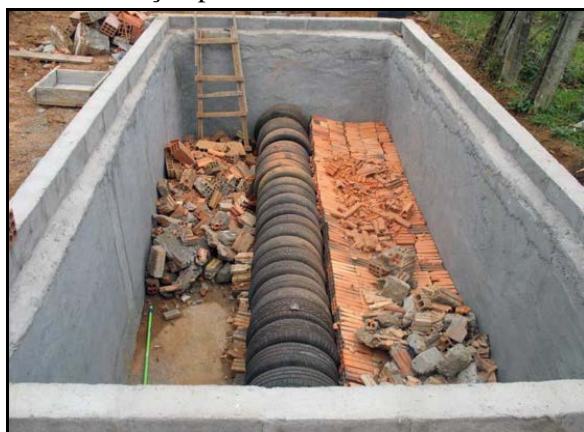
Figura 99. Método do círculo de bananeiras em execução para tratamento individual
