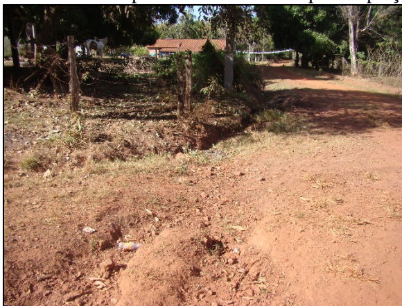
Figura 80. Processos erosivos em via não pavimentada e valeta para captação de água pluviais
