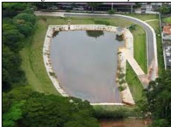
Figura 115. Bacia de detenção
