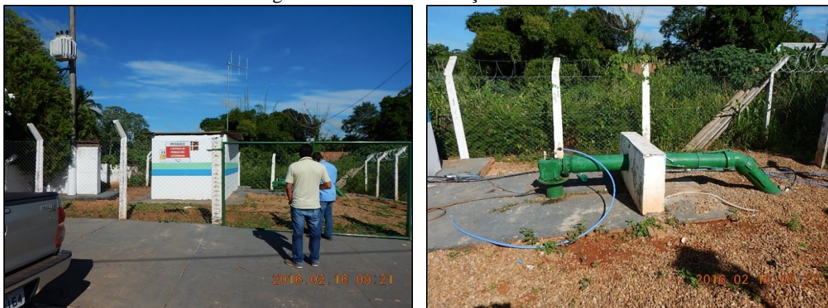
Figura 26. Estrutura do Poço Tubular 01
