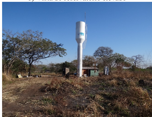
Figura 84. a) Vista do poço tubular; b) Vista dos reservatórios elevado de 10m 3
