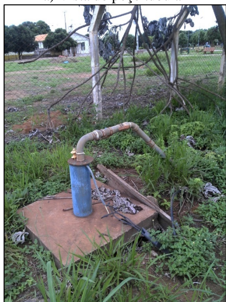
Figura 82. a) Vista do poço tubular; b) Vista dos reservatórios elevados de 35 m 3 e 25 m 3 a) Vista do poço tubular
