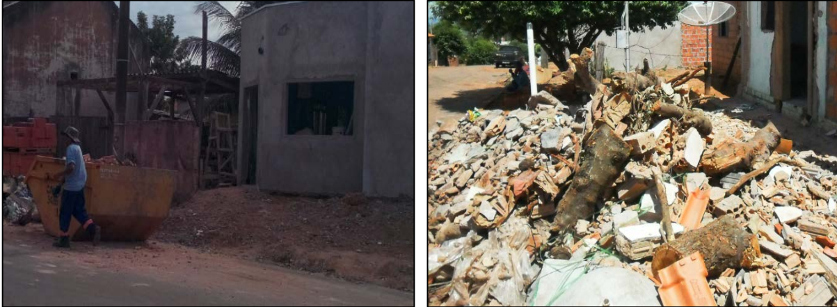
Figura 72. Acondicionamento de RDC
