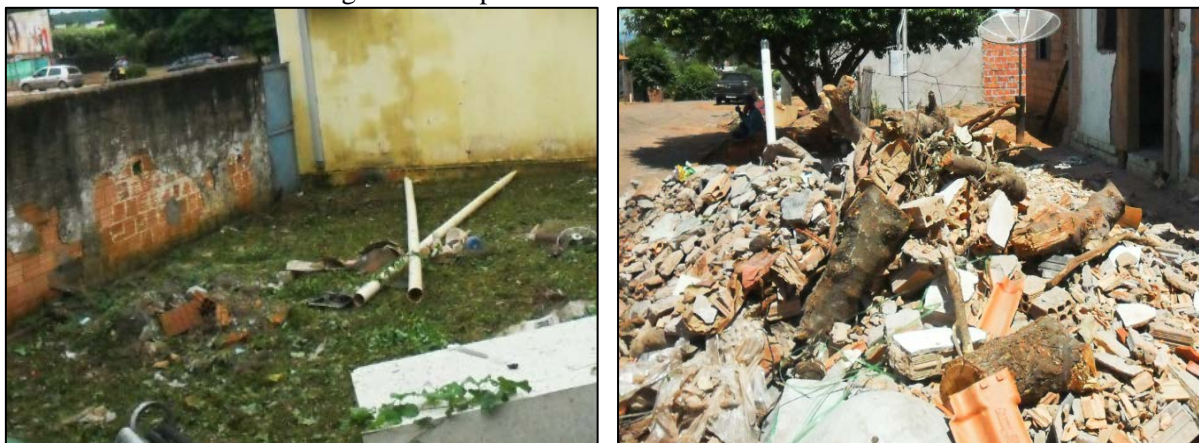
Figura 74. Depósito de RDC em terrenos baldios.
