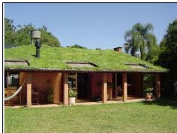
Figura 106. Telhado verde com plantas
