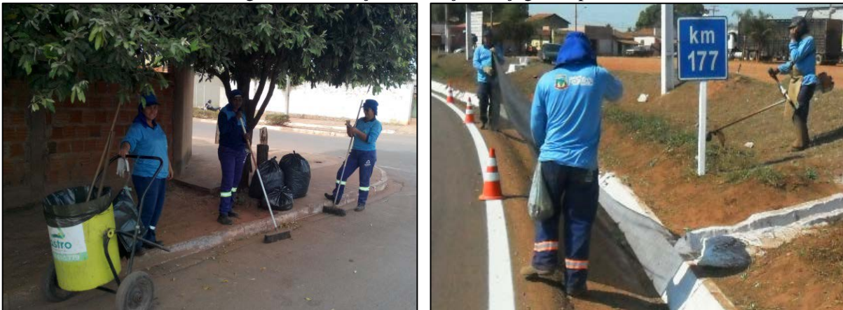
Figura 64. Serviço de varrição, roçagem e poda
