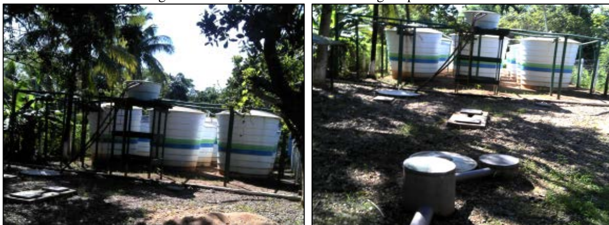
Figura 48. Estação de tratamento de esgoto provisória.
