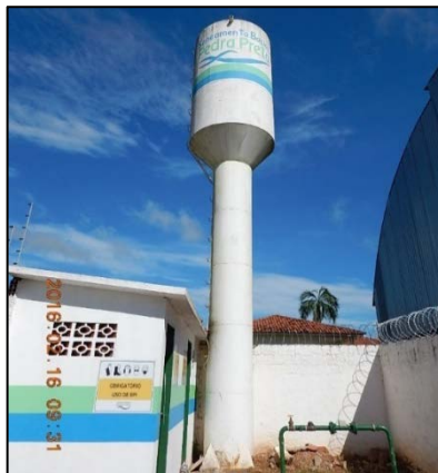
Figura 39. Reservatório metálico elevado de 50 m 3 - REL 03 (desativado)
