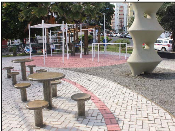
Figura 107. Pavimento poroso – piso intertravado instalado em praça
