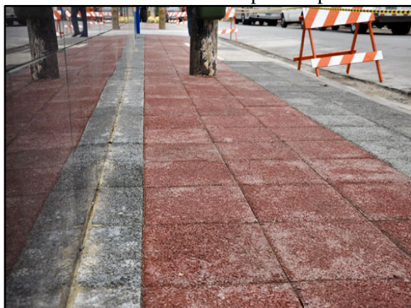
Figura 109. Pavimento poroso – piso intertravado instalado em passeio público
