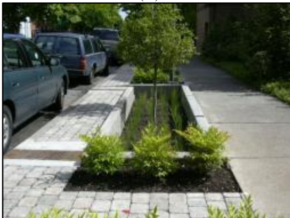
Figura 89. Trincheira de infiltração (A) no passeio (B) estacionamento
