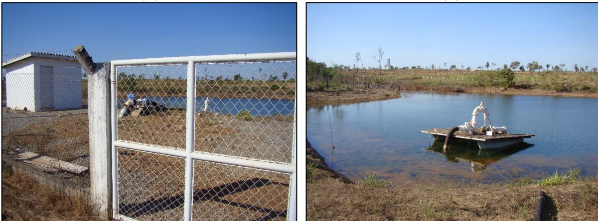
Figura 51. (A) Visão geral da área de captação (B) Balsa flutuante (A) (B)
