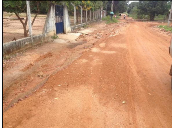
Figura 33. (A) Danos ao pavimento de vias, ocasionando pela falta de drenagem profunda (B) Água pluvial escoando em vias não-pavimentada, formando sulcos de erosão (C) Boca de lobo com capacidade de engolimento limitada pela presença de resíduos e sedimentos obstruindo-a
