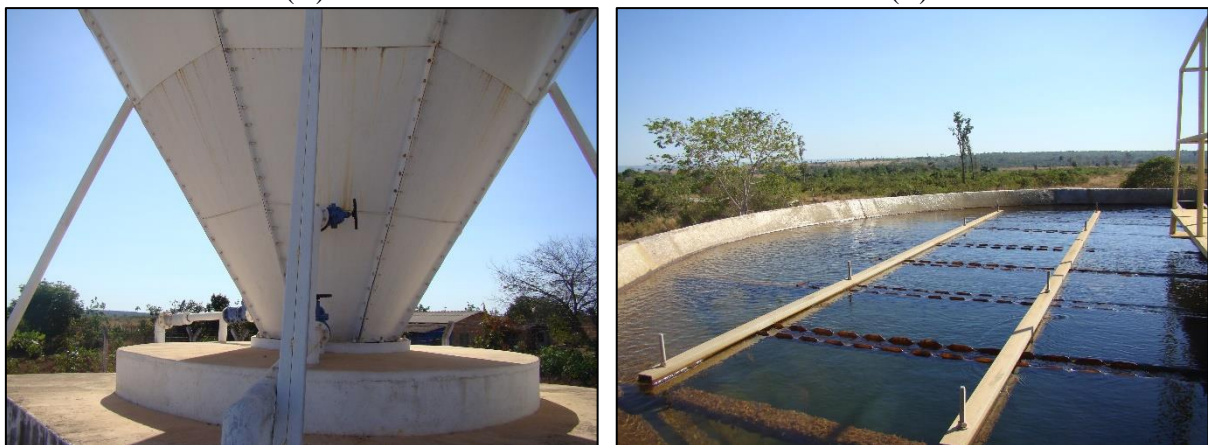
Figura 53. (A) Floco-decantador (B) Calhas onde são coletadas as águas decantadas
