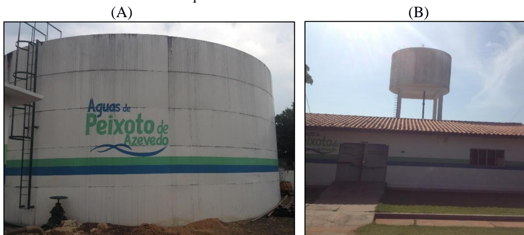
Figura 21. (A) Reservatório apoiado metálico-R1 (B) Reservatório elevado de concreto armado-R2 que se encontra desativado
