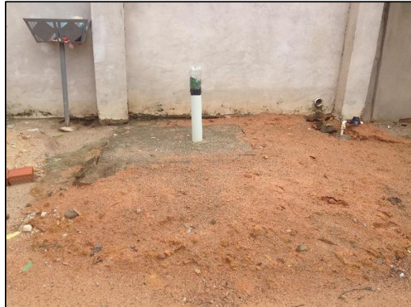
Figura 28. Vista da laje da fossa construída no passeio público
