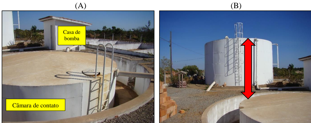
Figura 55. (A) Câmara de contato para desinfecção na área da ETA (B) Desnível entre o reservatório a câmara de contato
