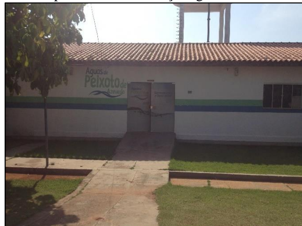
Figura 9. Sede da prestadora de serviço Águas de Peixoto de Azevedo
