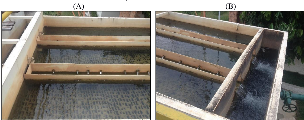
Figura 17. (A) Decantador de alta taxa com placas inclinadas tipo colmeia (B) Coleta da água decantada para encaminhá-la aos filtros
