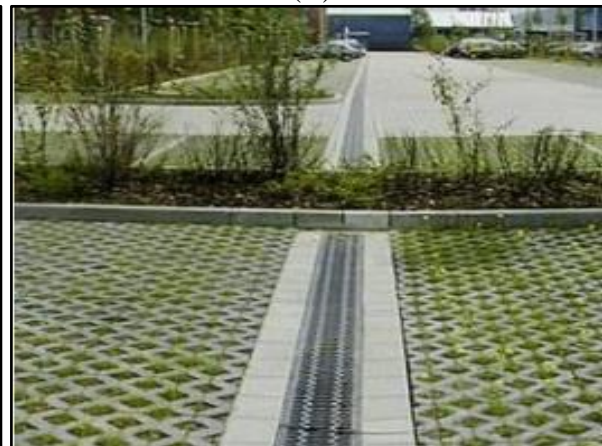
Figura 89. Trincheira de infiltração (A) no passeio (B) estacionamento
