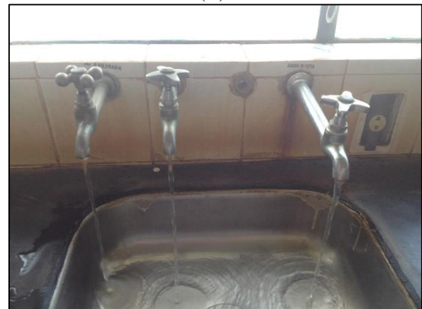
Figura 23. Laboratório ETA Peixoto de Azevedo: (A) Aparelhos de análise da água (B) Saída da água para coleta de amostras, efluente filtrado, decantado e bruto, respectivamente
