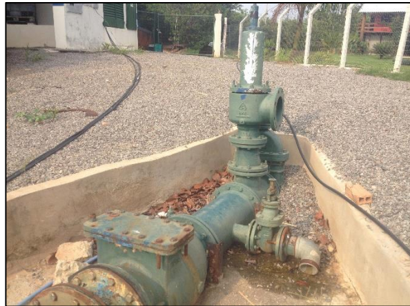
Figura 11. (A) Conexão entre tubulação de ferro fundido e mangote flexível na captação (B) Válvula de retenção, tubulação para descarga da linha de adução, ventosa e registro de manobra
