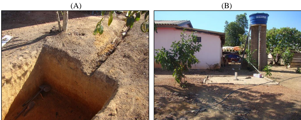
Figura 57. (A) Fossa negra em construção no assentamento (B) Vista da laje superior de fossa em União do Norte
