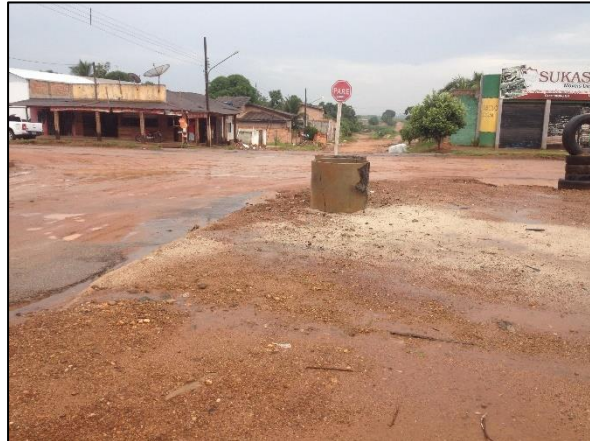
Figura 35. Via pavimentada coberta de sedimentos no bairro Alvorada
