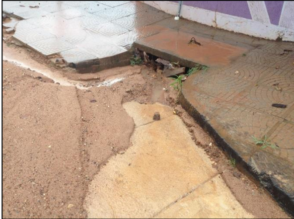
Figura 33. (A) Danos ao pavimento de vias, ocasionando pela falta de drenagem profunda (B) Água pluvial escoando em vias não-pavimentada, formando sulcos de erosão (C) Boca de lobo com capacidade de engolimento limitada pela presença de resíduos e sedimentos obstruindo-a
