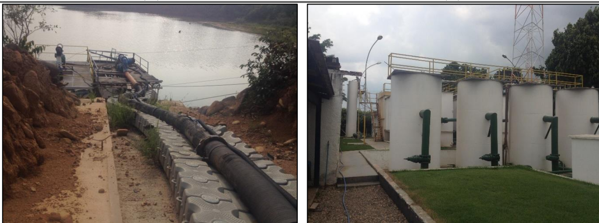
Figura 65. (A) Captação superficial no Rio Peixoto de Azevedo (B) Estação de Tratamento de Água (A) (B)
