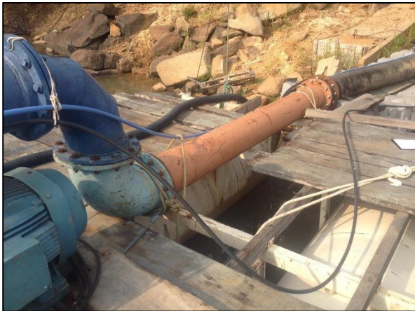
Figura 11. (A) Conexão entre tubulação de ferro fundido e mangote flexível na captação (B) Válvula de retenção, tubulação para descarga da linha de adução, ventosa e registro de manobra
