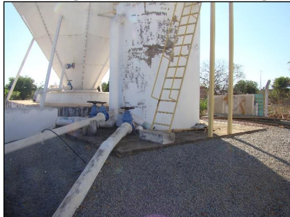
Figura 54. Filtro russo para clarificação e retirada de impurezas da água
