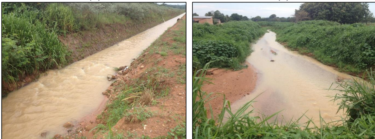
Figura 30. (A) Parte canalizada do córrego da Lavadeira (B) Parte não canalizada do córrego
