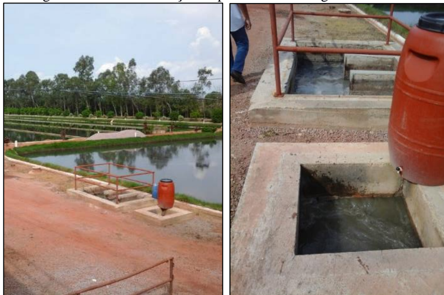
Figura 25. Local de inserção de peróxido de hidrogênio no efluente
