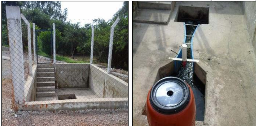
Figura 27. O efluente tratado na saída do tratamento recebe uma dosagem de antiespumante
