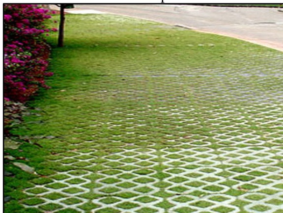
Figura 110. Pavimento poroso – concregrama instalado em passeio
