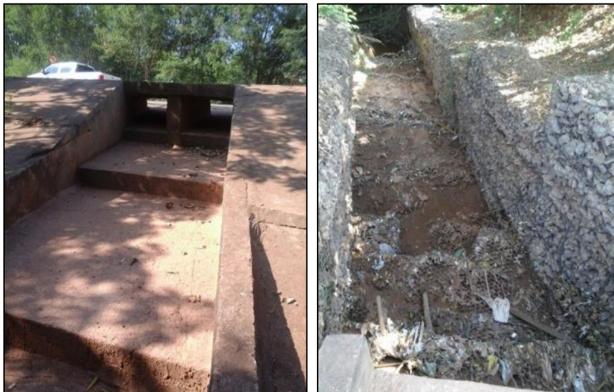
Figura 40. Escadaria hidráulica, um tipo de dissipador de energia presente no sistema de drenagem de Pontes e Lacerda
