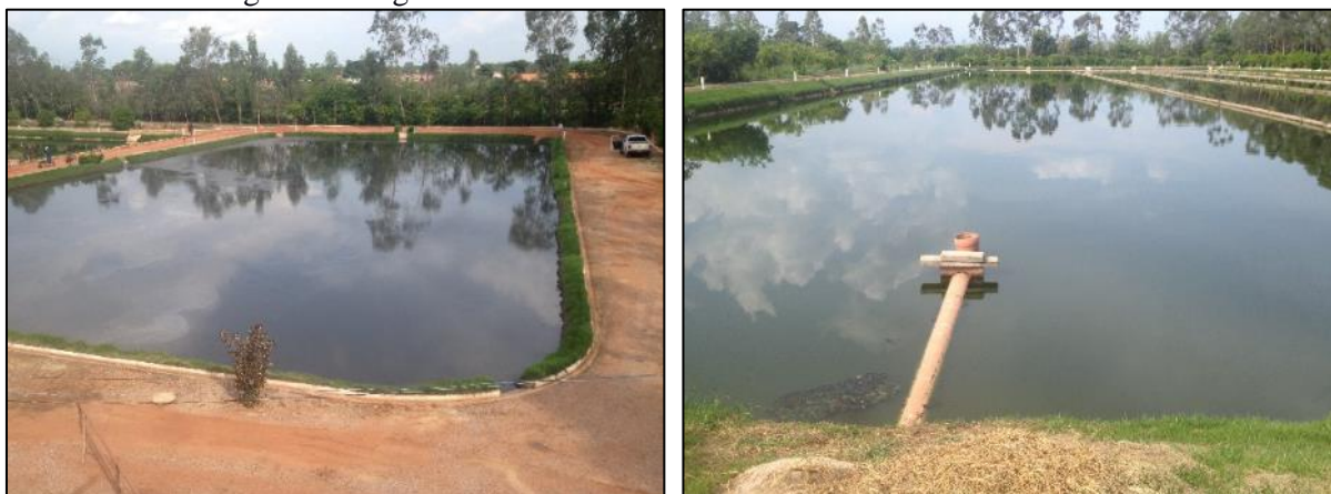
Figura 26. Lagoa anaeróbica e facultativa da ETE de Pontes e Lacerda
