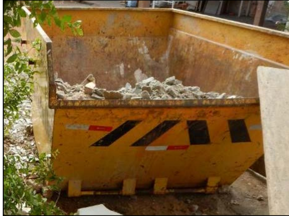
Figura 70. Acondicionamento dos resíduos de construção civil
