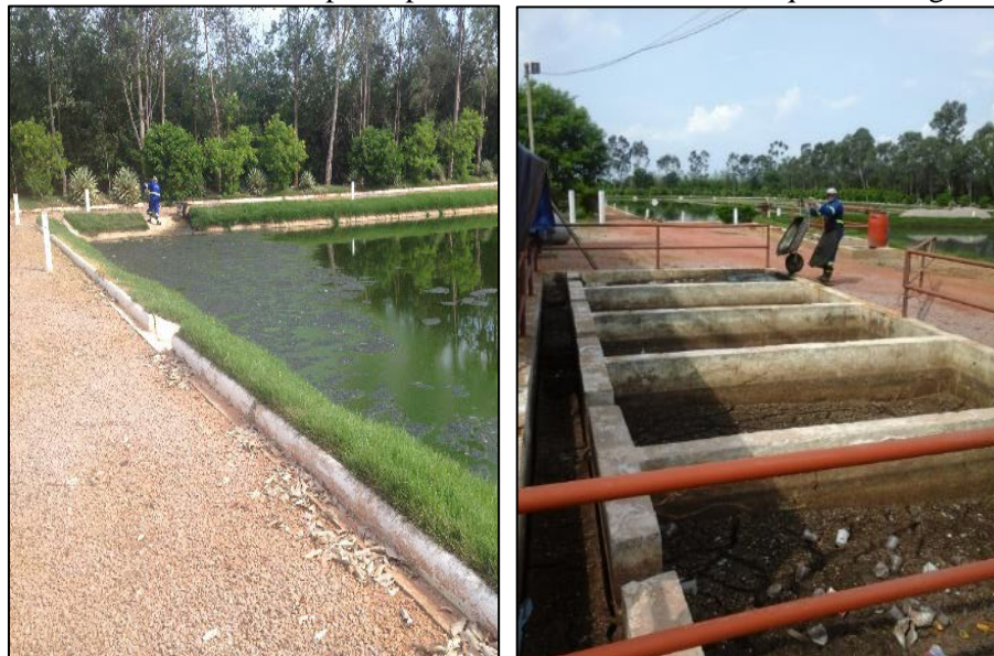
Figura 28. Lodo sendo retirado pelo operador e armazenado no tanque de secagem de lodo
