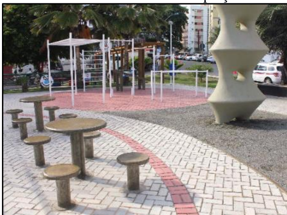
Figura 109. Pavimento poroso – piso intertravado instalado em praça
