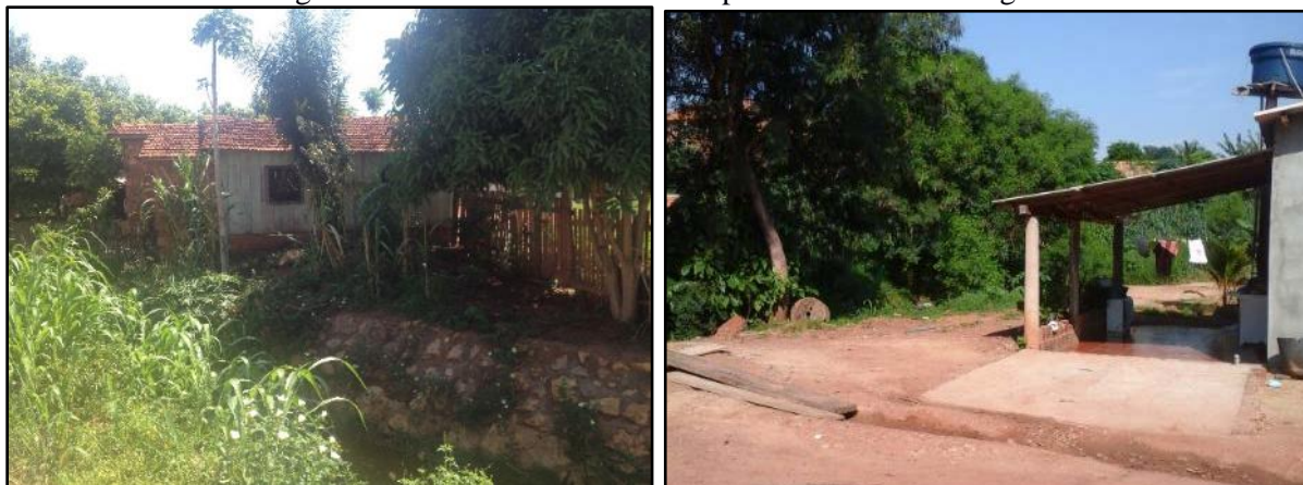
Figura 49. Residências construídas próximas ao curso d'água
