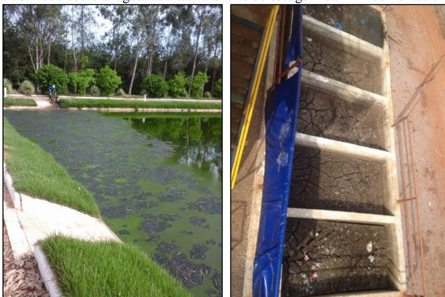
Figura 76. Lodo sobre a lagoa facultativa e leito de secagem da ETE de Pontes e Lacerda
