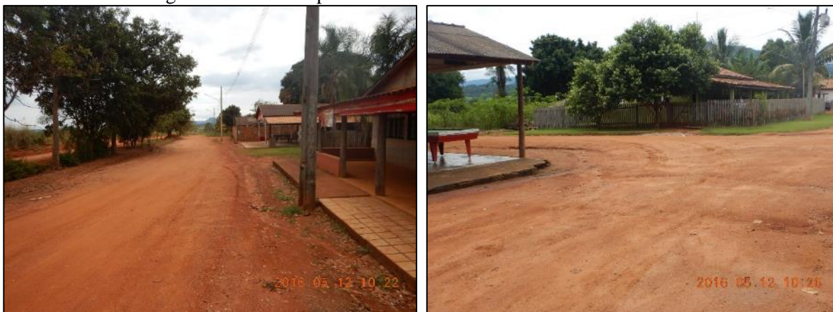
Figura 84. Vias não pavimentadas no distrito de São José da Serra
