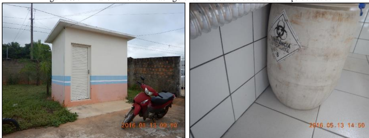
Figura 69. Armazenamento em abrigo externo dos resíduos de serviço de saúde
