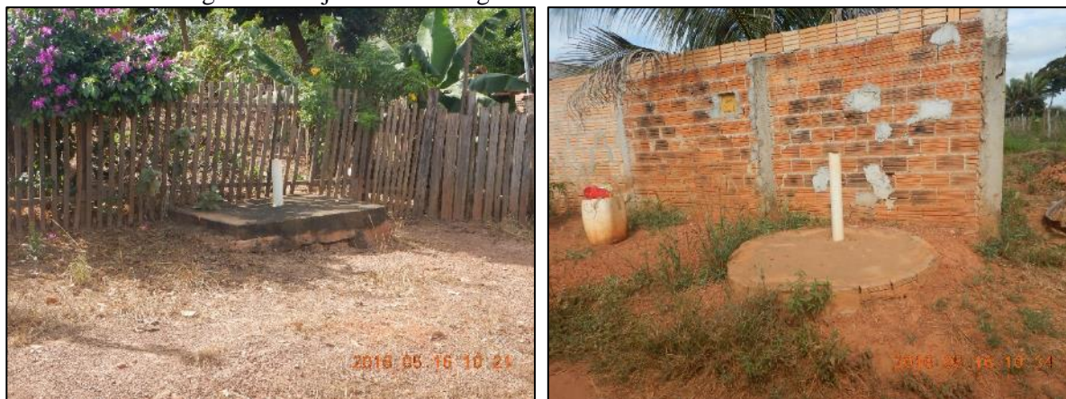
Figura 36. Laje de fossas negras de residências em Pontes e Lacerda
