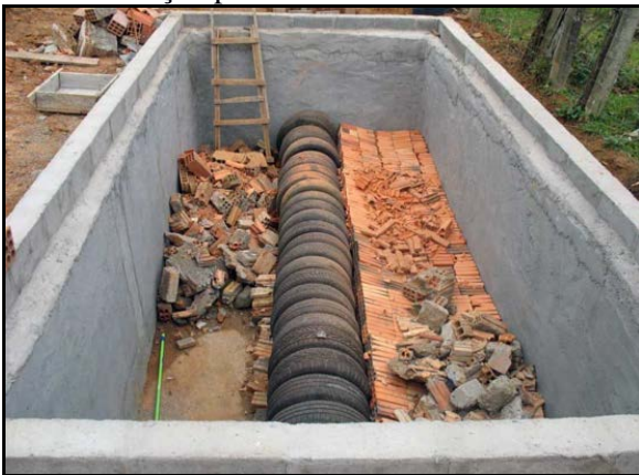
Figura 101. Método do círculo de bananeiras em execução para tratamento individual
