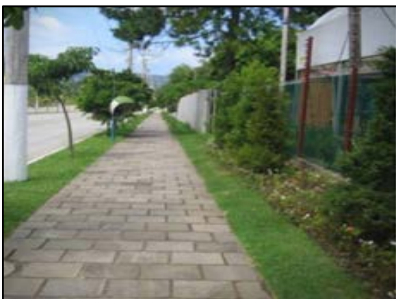
Figura 115. Vala de detenção ao longo da rua
