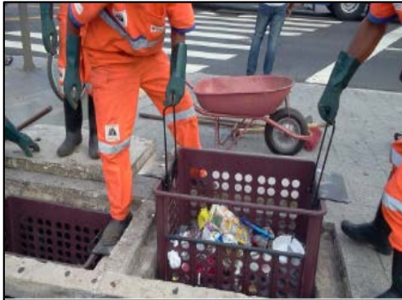
Figura 105. Cesta acoplada a boca do bueiro
