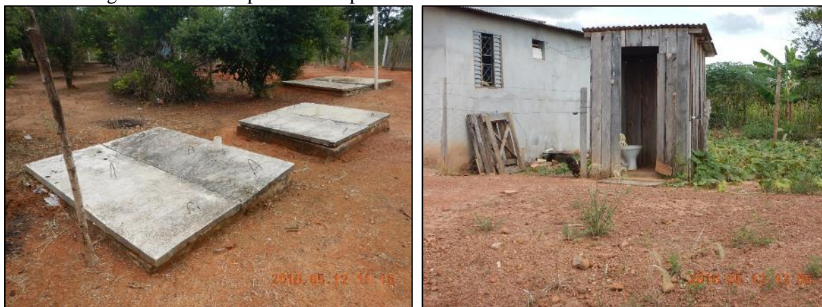
Figura 91. Fossa séptica e exemplo de banheiro utilizados em Vila Monte Cristo
