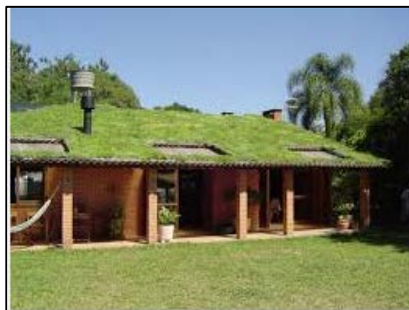
Figura 108. Telhado verde com plantas
