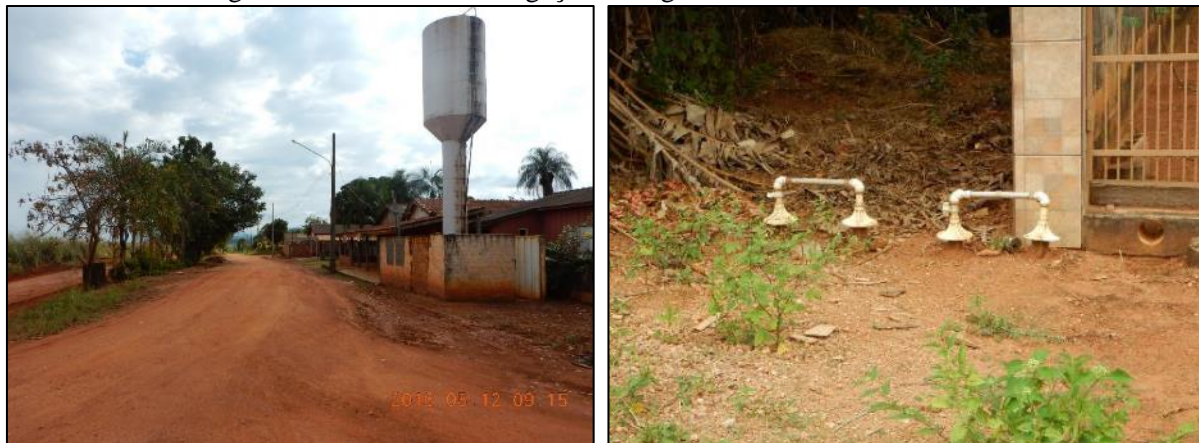
Figura 81. Reservatório e ligações de água do distrito de Vila Matão
