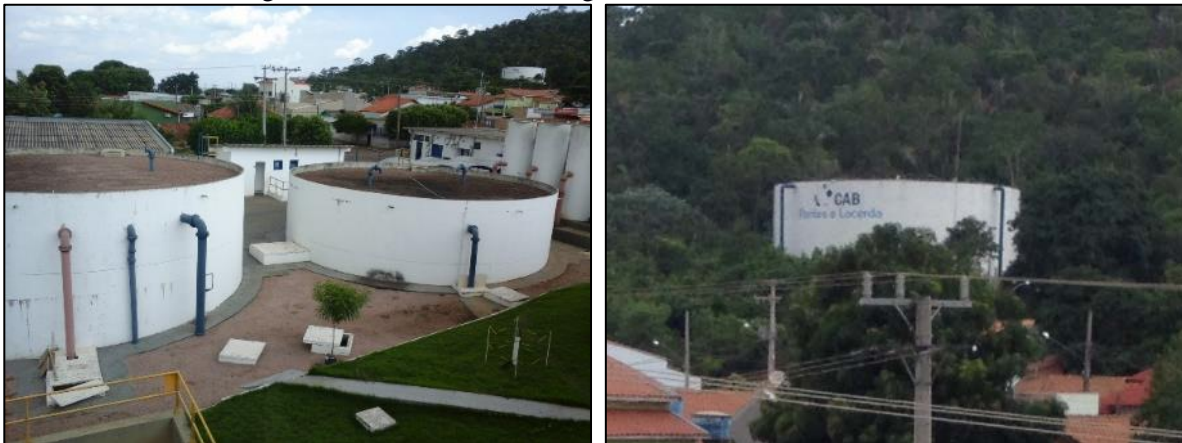
Figura 12. Reservatórios de água tratada de Pontes e Lacerda
