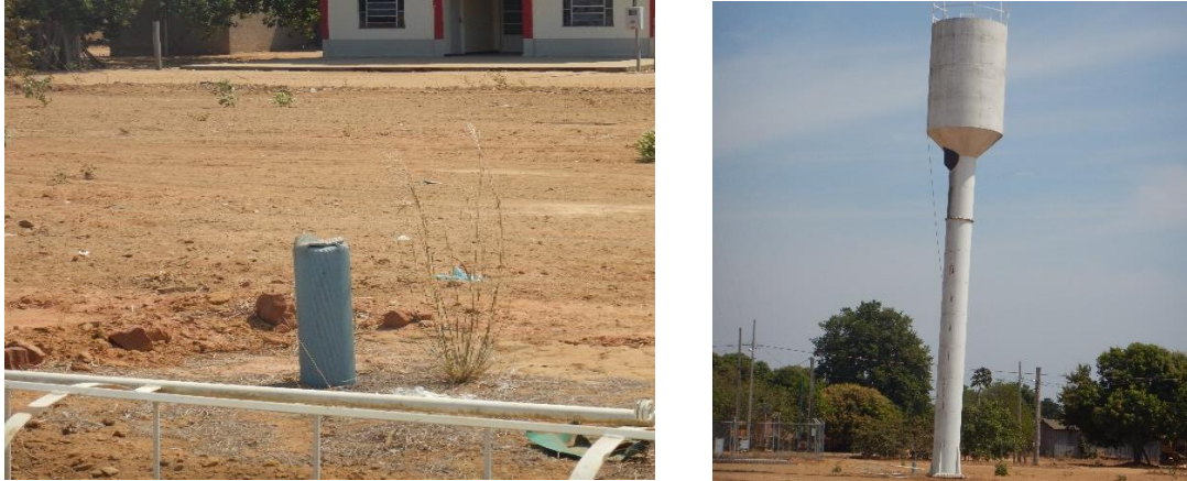
Figura 80. Vista exterior de poço profundo (a) e reservatório (b) a. b.
