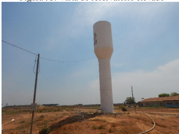
Figura 95. Vista do reservatório elevado
