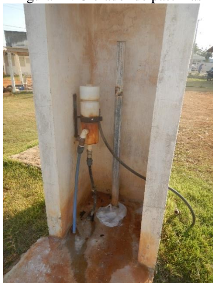
Figura 24. Clorador de pastilhas
