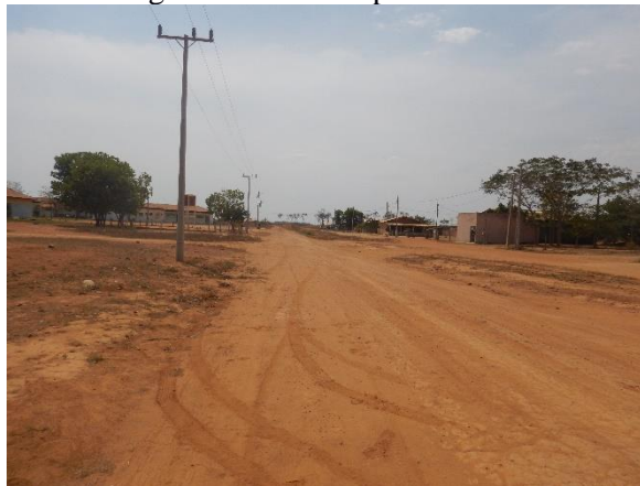
Figura 97. Via não pavimentada
