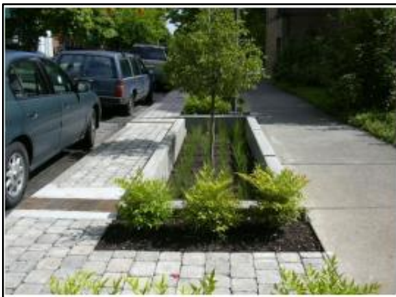
Figura 125. Trincheira de infiltração no passeio
