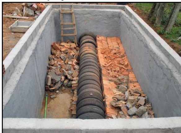
Figura 113. Método do círculo de bananeiras em execução para tratamento individual
