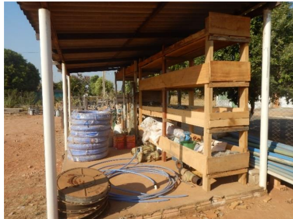
Figura 30. Materiais para manutenção do sistema estocados no almoxarifado do DAE
