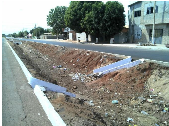
Figura 40. Drenagem pluvial na Avenida Norberto Schwantes
