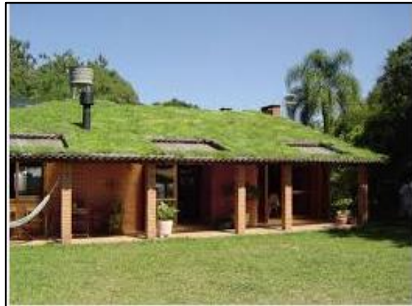
Figura 120. Telhado verde com plantas
