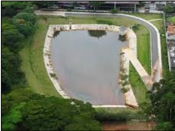
Figura 129. Bacia de detenção
