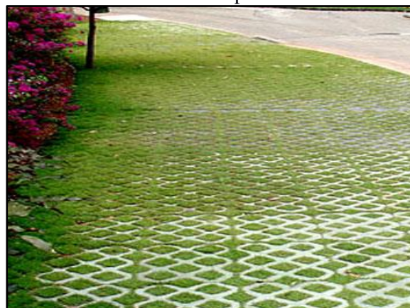
Figura 122. Pavimento poroso – concregrama instalado em passeio
