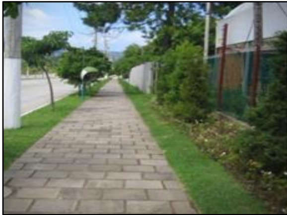
Figura 127. Vala de retenção ao longo da rua
