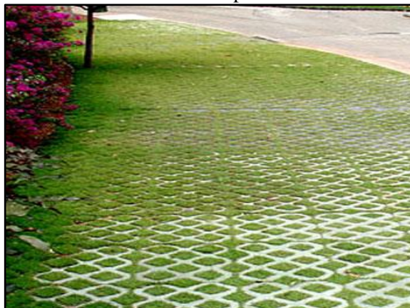
Figura 102. Pavimento poroso – concregrama instalado em passeio
