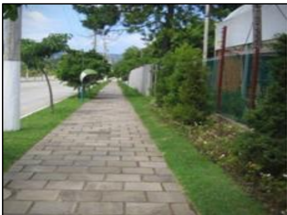
Figura 107. Vala de detenção ao longo da rua
