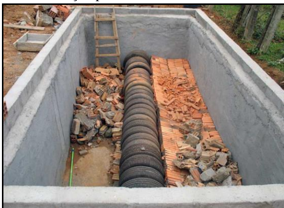
Figura 93. Método do círculo de bananeiras em execução para tratamento individual
