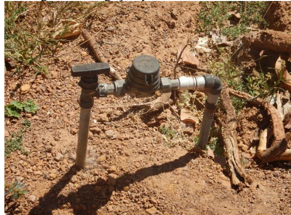
Figura 24. Ligação predial hidrometrada
