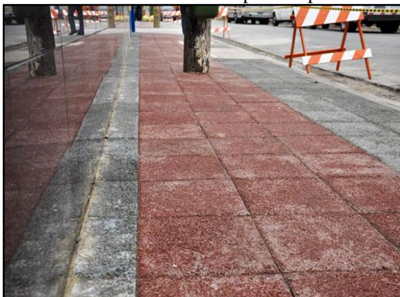
Figura 103. Pavimento poroso – piso intertravado instalado em passeio público
