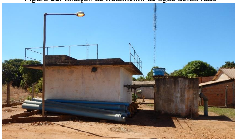
Figura 22. Estação de tratamento de água desativada
