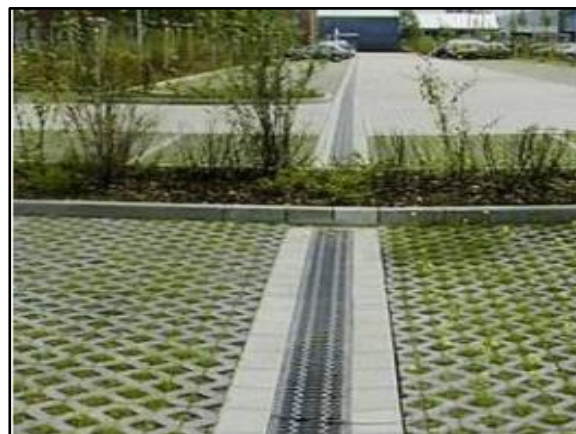
Figura 106. Trincheira de infiltração no estacionamento
