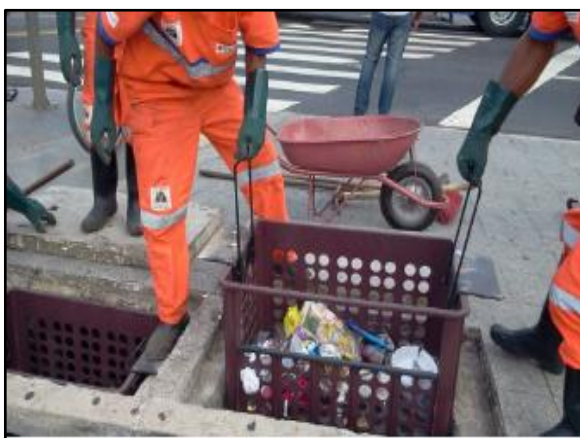
Figura 97. Cesta acoplada à boca do bueiro
