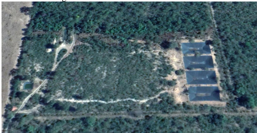
Figura 50. Vista da área do aterro sanitário
