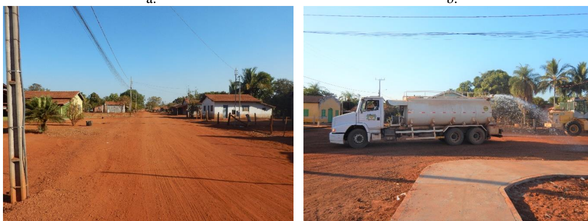
Figura 68. Via não pavimentada (a) e umectação das vias (b).
