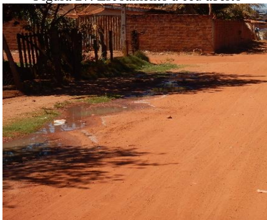
Figura 27. Escoamento à céu aberto
