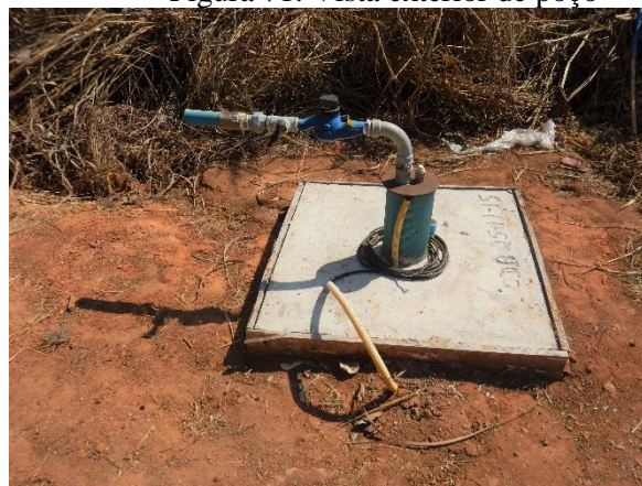
Figura 71. Vista exterior de poço
