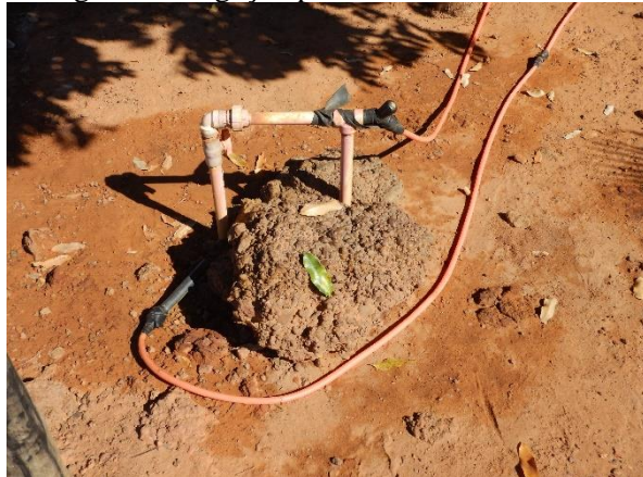
Figura 23. Ligação predial sem hidrômetro
