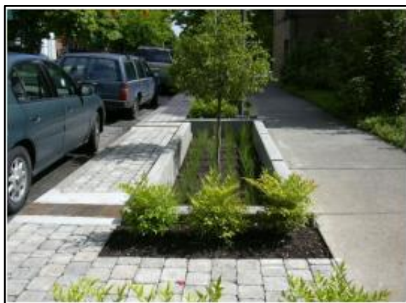
Figura 105. Trincheira de infiltração no passeio
