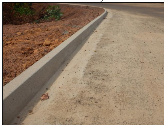
Figura 19. Componentes da microdrenagem: meio-fio e sarjeta
