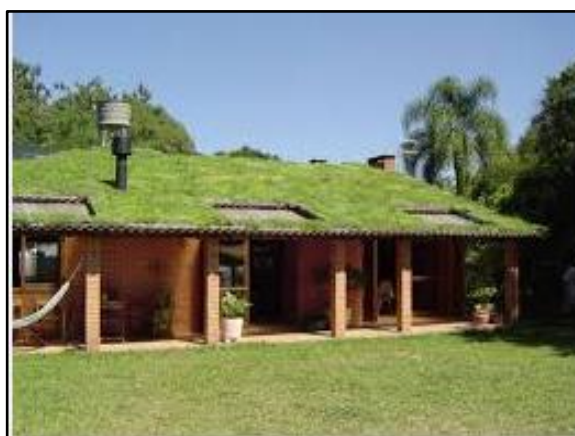
Figura 56. Telhado verde com plantas
