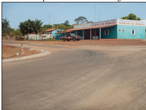
Figura 18. Rua pavimentada no centro do município de Santa Cruz do Xingu
