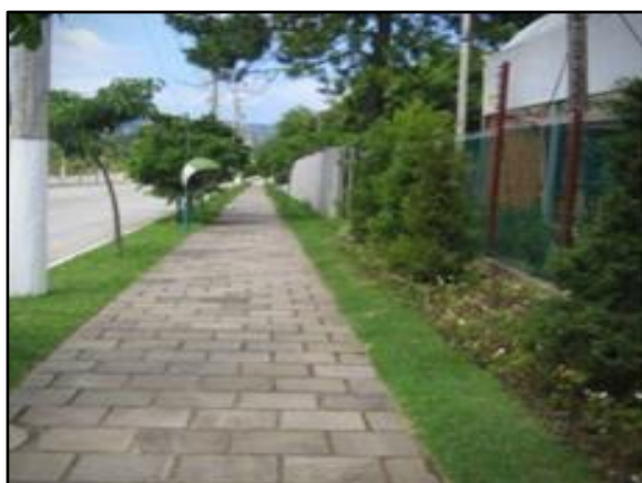
Figura 63. Vala de detenção ao longo da rua
