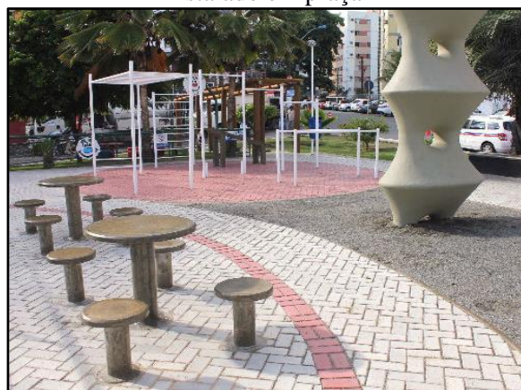
Figura 57. Pavimento poroso – piso intertravado instalado em praça
