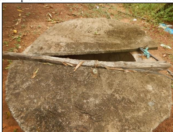
Figura 33. Fossa rudimentar implantada no Assentamento de Santa Clara, Santa Cruz do Xingu-MT
