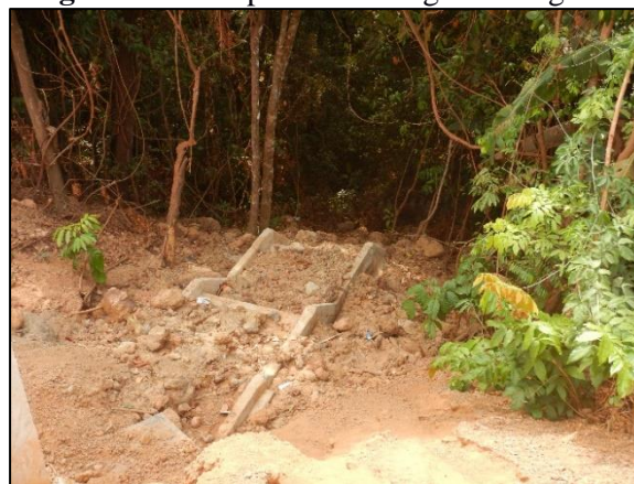
Figura 21. Dissipador de energia em degraus
