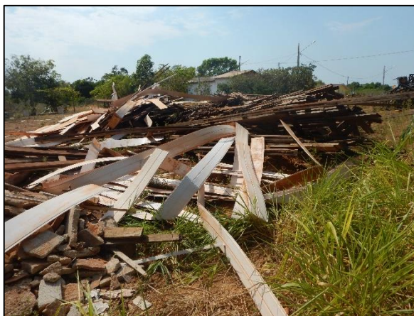
Figura 28. Acondicionamento de RDC em terreno baldio – Santa Cruz do Xingu-MT
