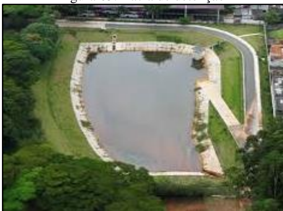
Figura 65. Bacia de detenção
