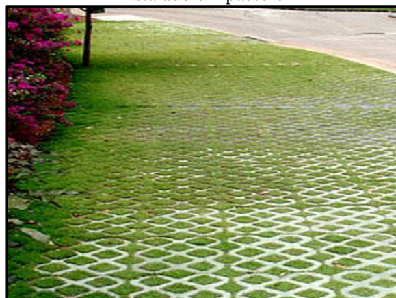
Figura 58. Pavimento poroso – concregrama instalado em passeio
