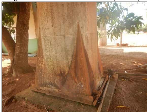
Figura 11. Base do reservatório 02 (RES 02)
