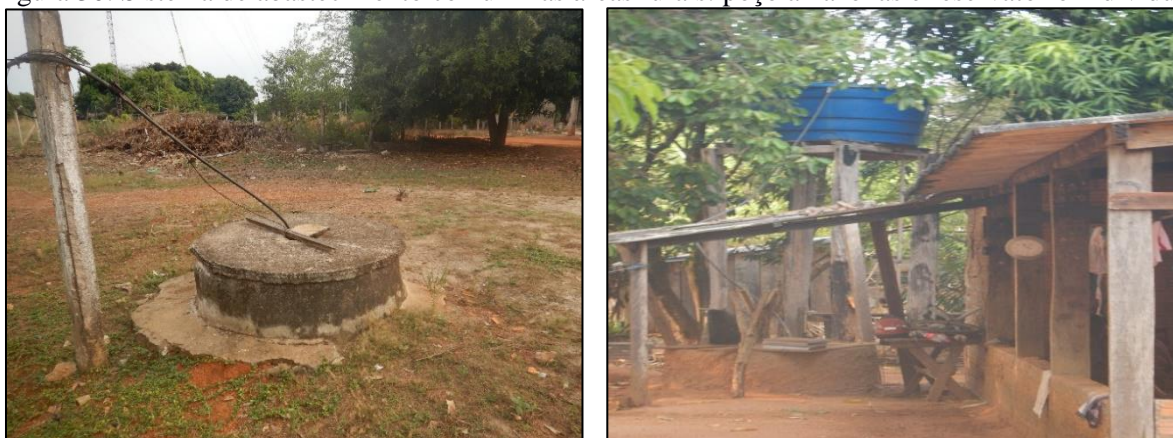
Figura 30. Sistema de abastecimento comum nas áreas rurais: poço amazonas e reservatório individual
