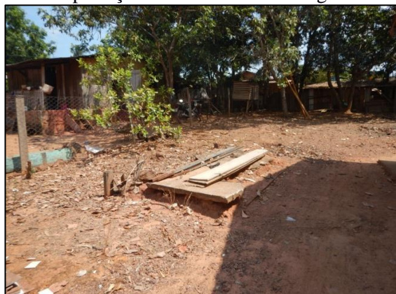
Figura 16. Fossa rudimentar sem a devida proteção – Santa Cruz do Xingu
