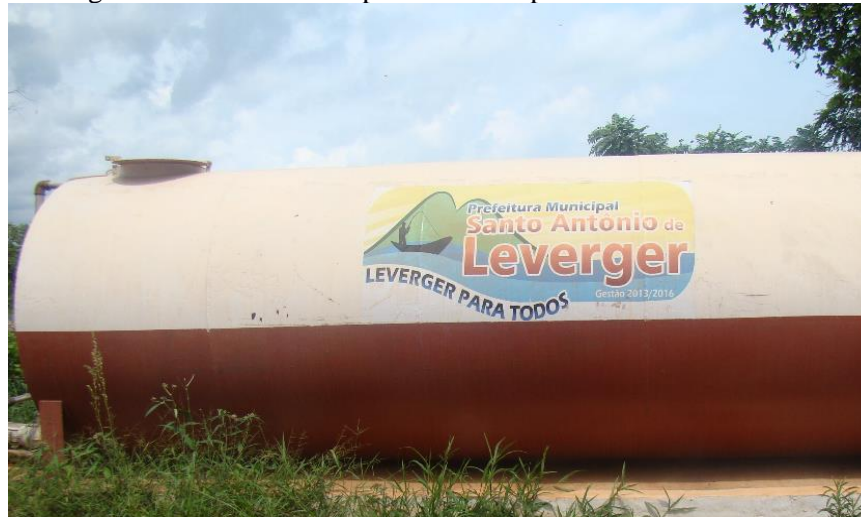
Figura 37. Reservatório apoiado N.S. Aparecida - 25 m 3
