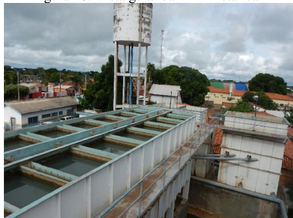
Figura 18. Vista geral da ETA metálica
