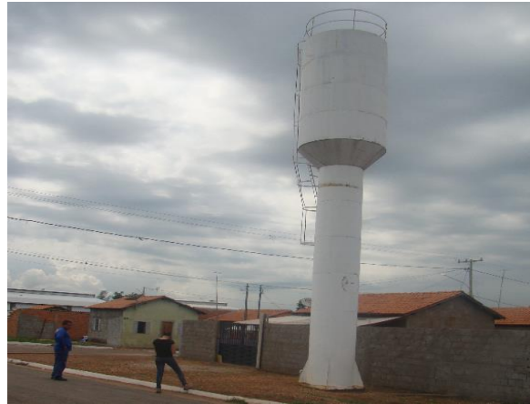
Figura 36. Reservatório Altos de Leverger - 25 m 3
