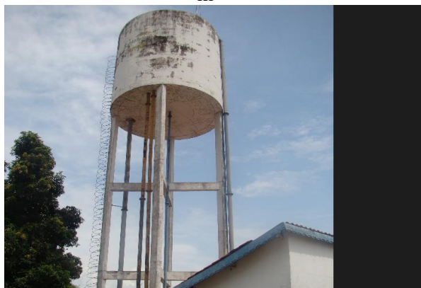
Figura 33. Reservatório concreto elevado - 250 m 3
