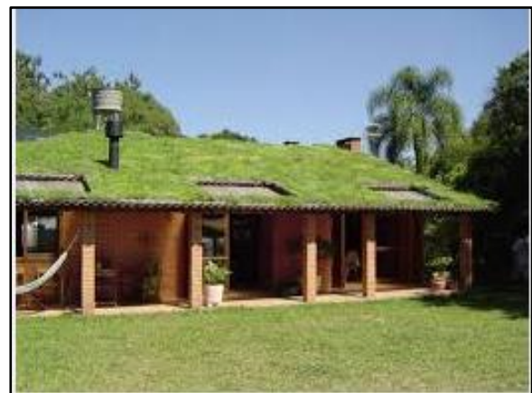
Figura 161. Telhado verde com plantas
