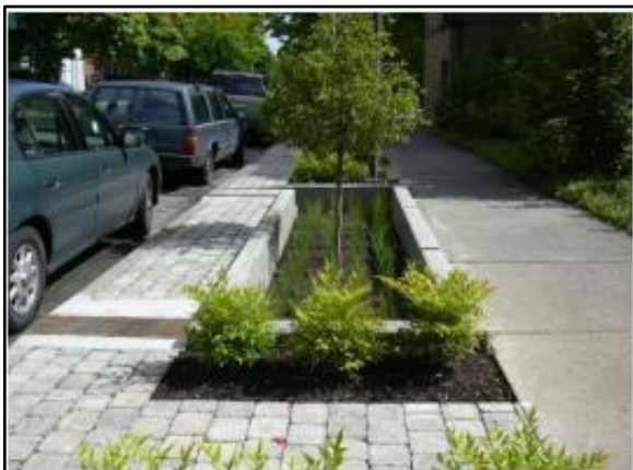
Figura 166. Trincheira de infiltração no passeio
