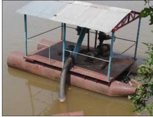
Figura 8. Captação superficial no rio Cuiabá
