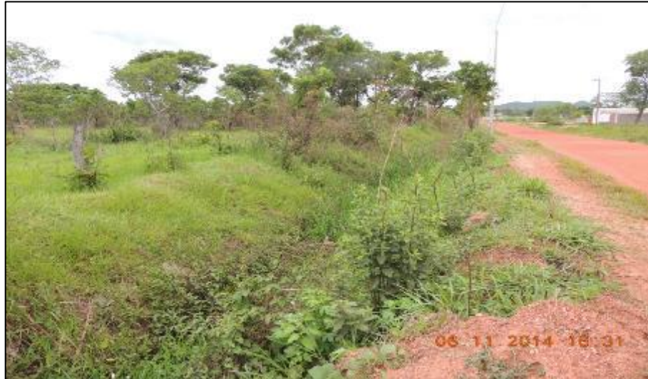
Figura 64. Canal a céu aberto utilizado para escoamento de águas pluviais de ruas não pavimentadas
