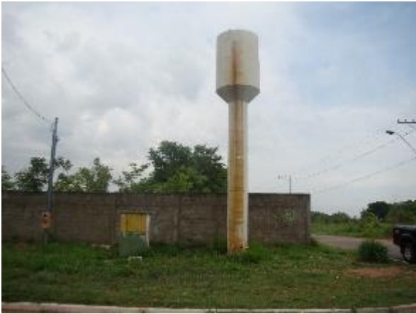
Figura 35. Reservatório Altos de Leverger - 15 m 3
