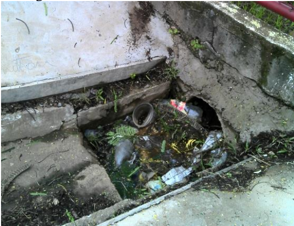
Figura 65. Boca de lobo obstruída Rua C
