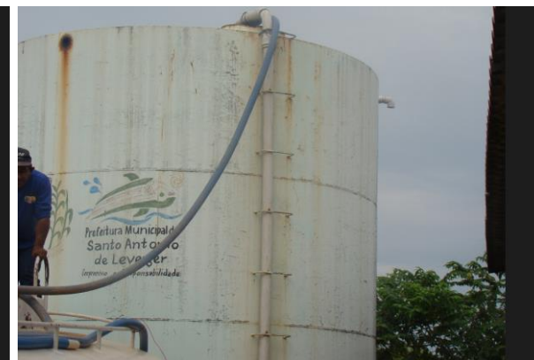
Figura 34. Reservatório bairro da Laje - 50 m 3
