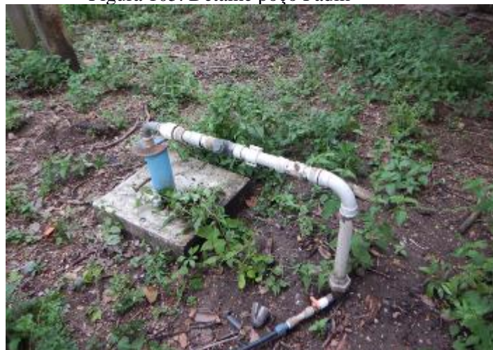
Figura 105. Detalhe poço Padik
