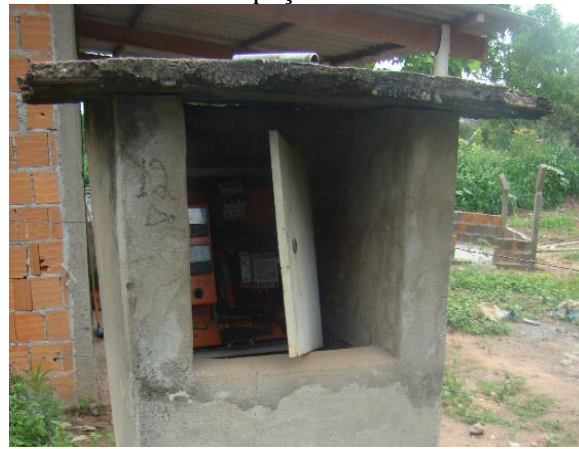
Figura 11. Abrigo e quadro de comando do poço 1
