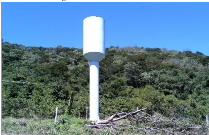
Figura 112. Reservatório metálico
