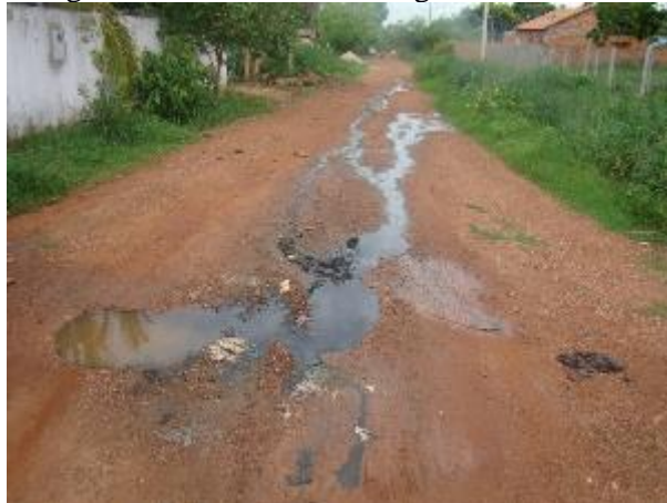
Figura 60. Escoamento de esgoto à céu aberto.
