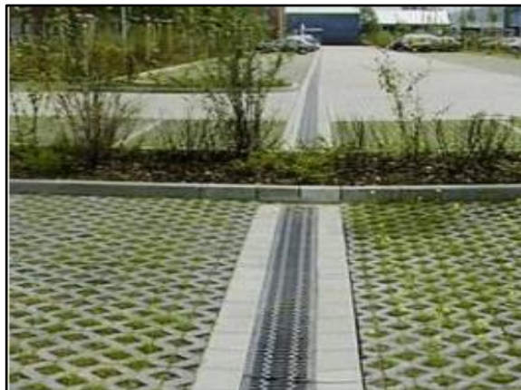
Figura 167. Trincheira de infiltração no estacionamento
