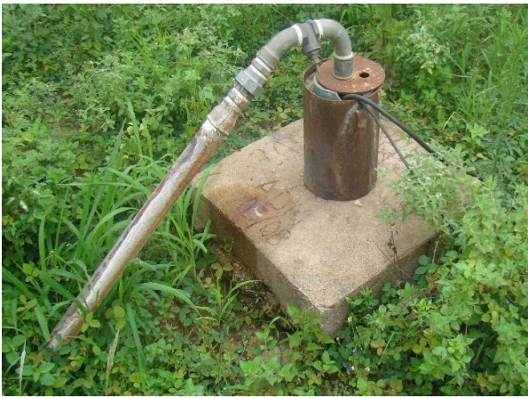
Figura 10. Laje de proteção e cavalete do poço 1
