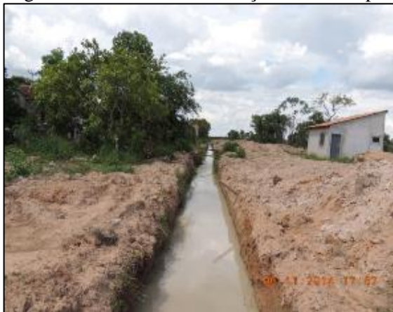
Figura 62. Galerias em execução no município
