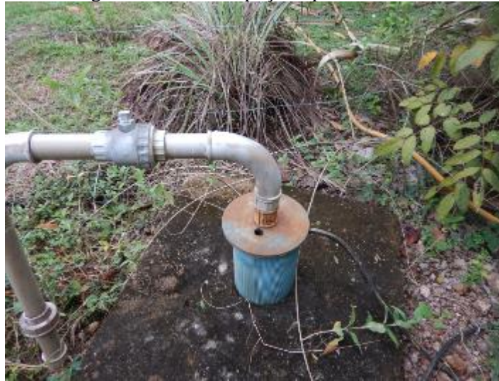
Figura 104. Detalhe poço Itapeva II
