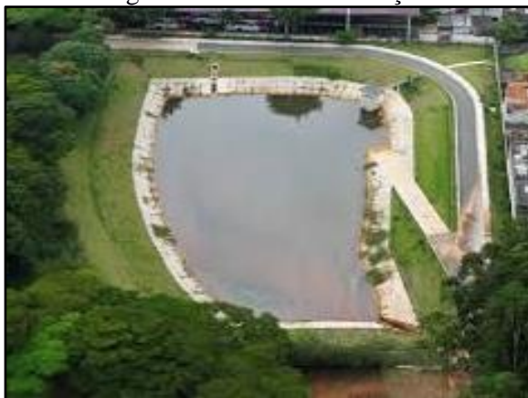
Figura 170. Bacia de detenção
