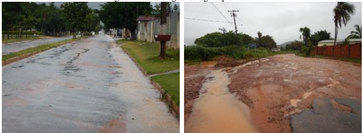
Figura 126. Drenagem de águas pluviais.
