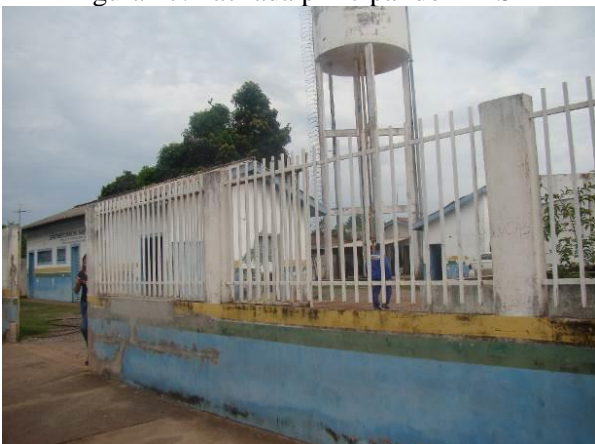
Figura 17. Fachada principal do DMS
