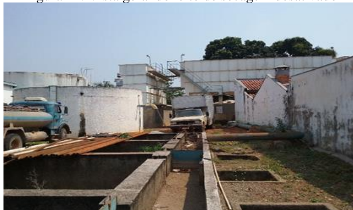
Figura 24. Vista geral do leito de secagem desativado
