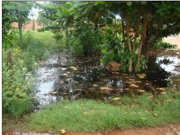
Figura 68. Acúmulo de águas de chuvas
