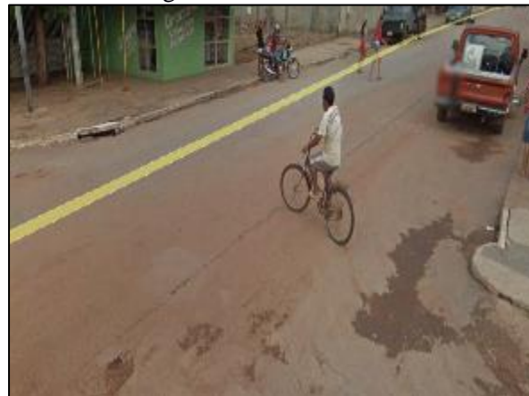
Figura 67. Bocas de lobo
