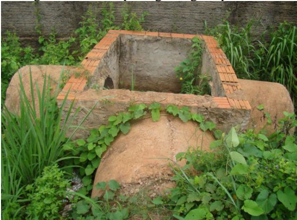
Figura 71. Ponto descarga águas pluviais
