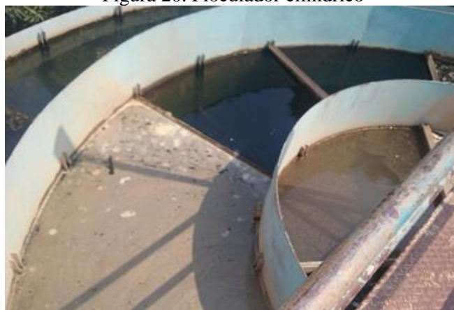
Figura 20. Floculador cilíndrico
