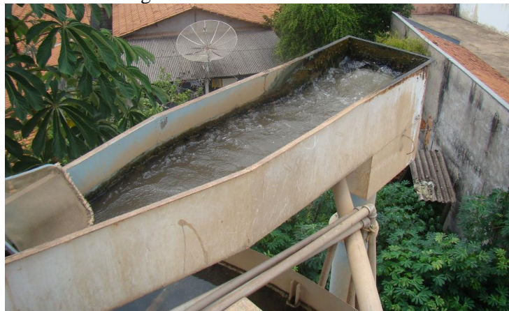
Figura 19. Calha Parshall
