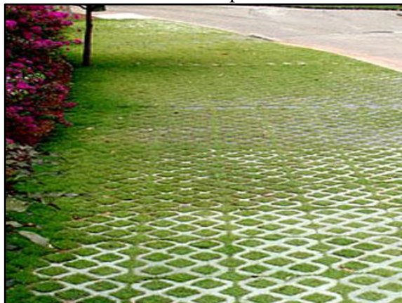
Figura 163. Pavimento poroso – concregrama instalado em passeio
