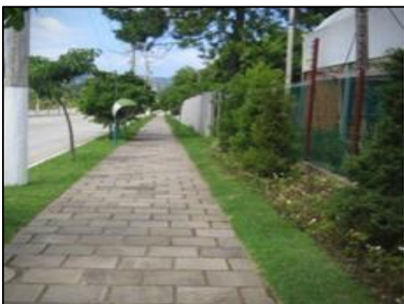
Figura 168. Vala de retenção ao longo da rua
