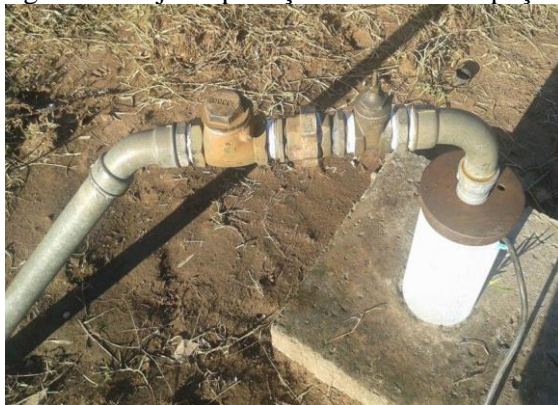
Figura 13. Laje de proteção e cavalete do poço 3
