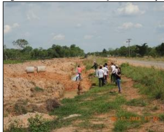
Figura 63. Galerias em execução no município
