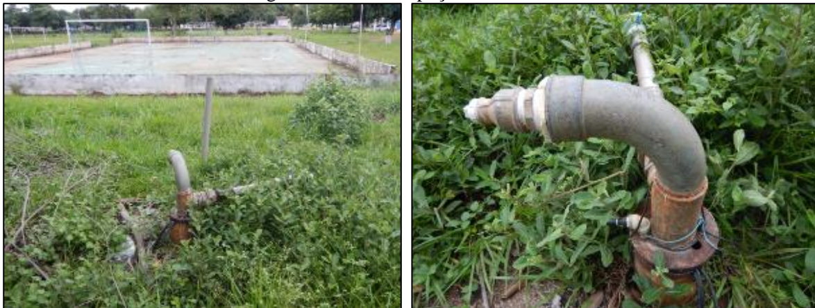
Figura 107. Detalhe poço do João da Cruz
