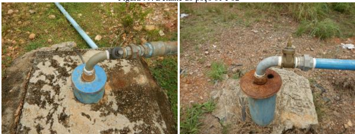
Figura 99. Detalhe do poço 01 e 02
