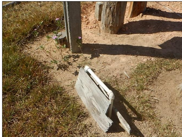
Figura 45. Cavalete sem hidrômetro, 5ª Agrovila, Terra Nova do Norte-MT
