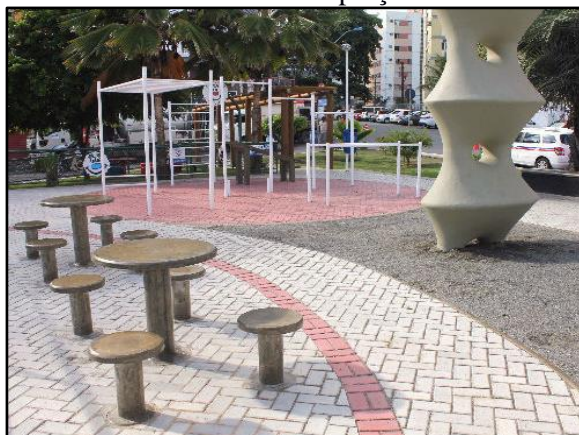
Figura 94. Pavimento poroso – piso intertravado instalado em praça
