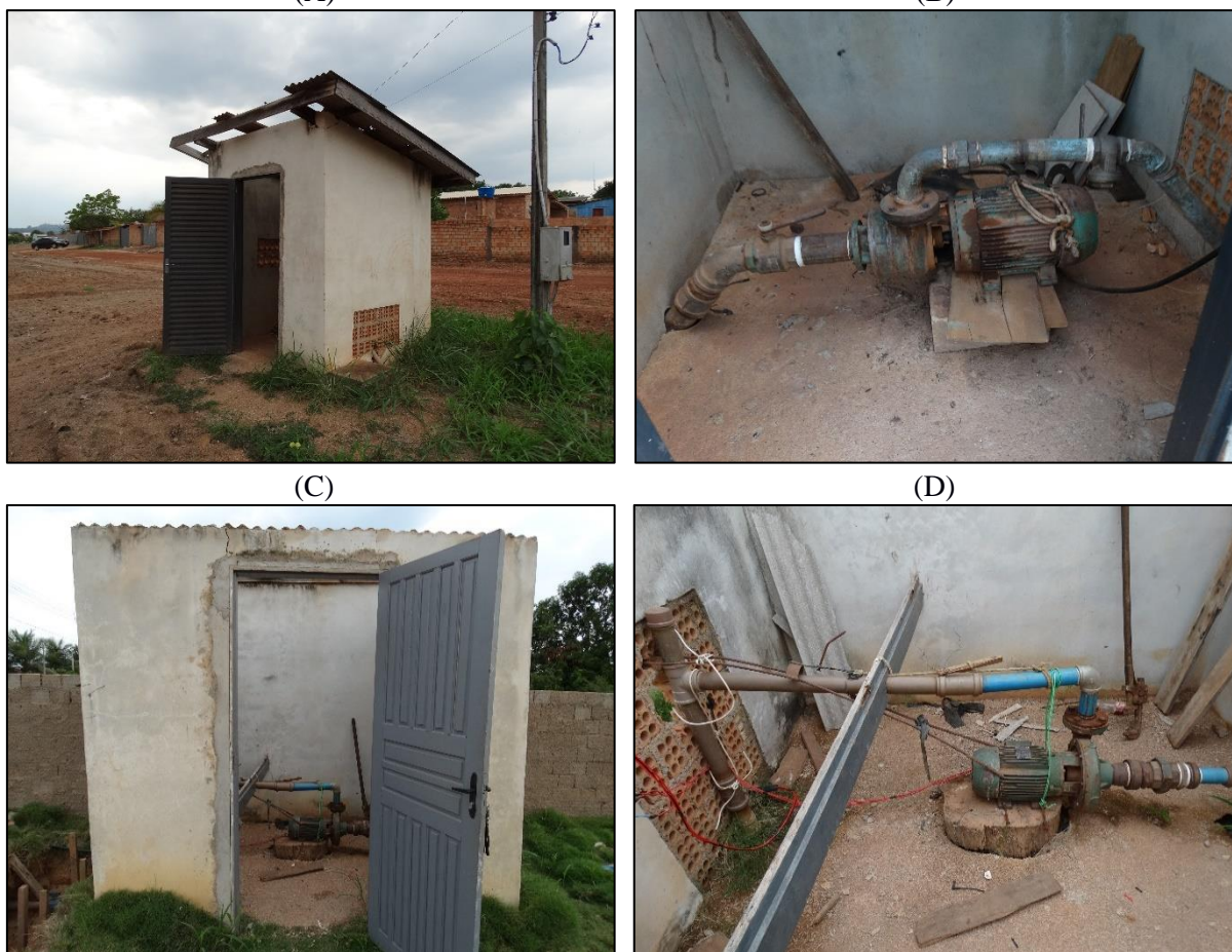
Figura 16. (A) Estrutura de alvenaria do BS-1 com telhado danificado (B) Bomba do BS-1, (C) Abrigo da bomba do BS-2, ausente de telhado (D) Bomba do BS-2 com adaptações não-convencionais
