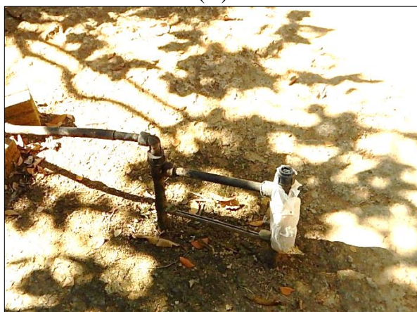
Figura 41. (A) Cavalete sem hidrômetro (B) Mangueira para distribuição de água (A) (B)
