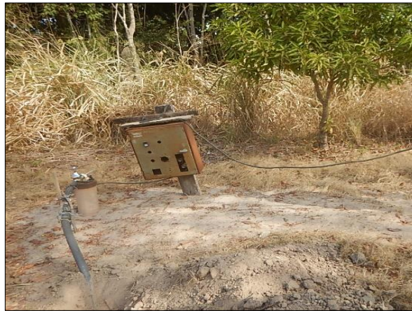
Figura 47. Vista da boca do poço tubular e as precariedades do quadro de comando, 6ª Agrovila, Terra Nova do Norte-MT
