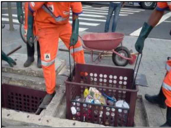
Figura 91. Cesta acoplada à boca do bueiro
