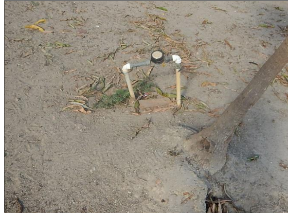
Figura 49. Cavalete com hidrômetro, 6ª Agrovila, Terra Nova do Norte-MT
