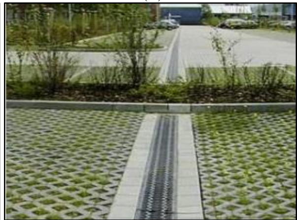
Figura 98. Trincheira de infiltração (A) no passeio (B) estacionamento (A) (B)
