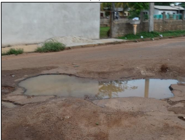
Figura 26. (A) Danos ao pavimento de vias, ocasionando pela falta de drenagem profunda (B) Água pluvial escoando em vias não-pavimentada formando sulcos de erosão (C) Boca de lobo com capacidade de engolimento limitada pela obstrução de resíduos
