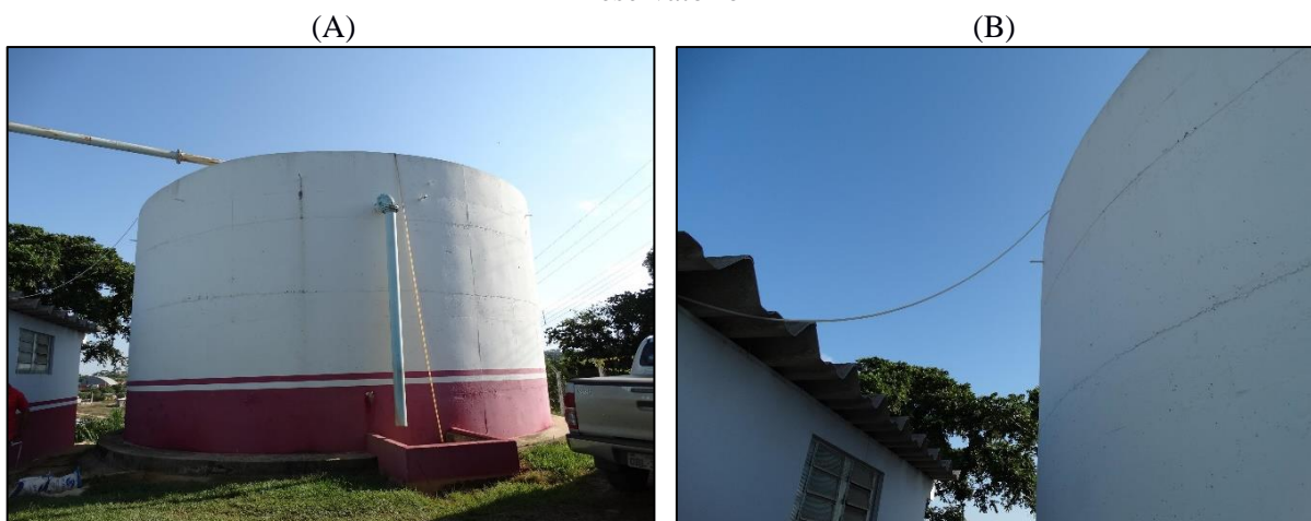
Figura 14. (A) Reservatório – ETA (B) Mangueira flexível para aplicação da cal hidratada no reservatório
