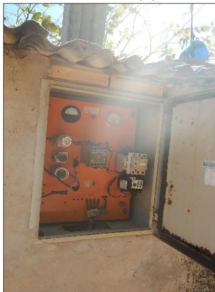
Figura 43. (A) Vista da boca do poço tubular e cavalete de saída d'água (B) Quadro de comando do poço
