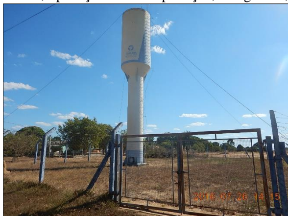
Figura 44. Reservatório elevado, tipo taça e cerca de proteção, 5 a Agrovila, Terra Nova do Norte-MT
