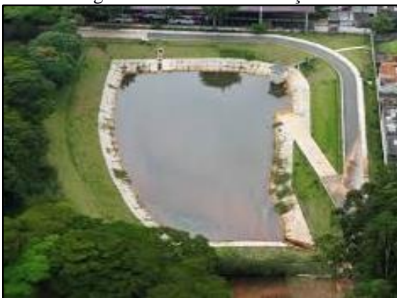
Figura 100. Bacia de detenção
