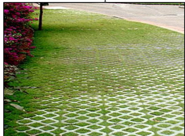
Figura 95. Pavimento poroso – concregrama instalado em passeio
