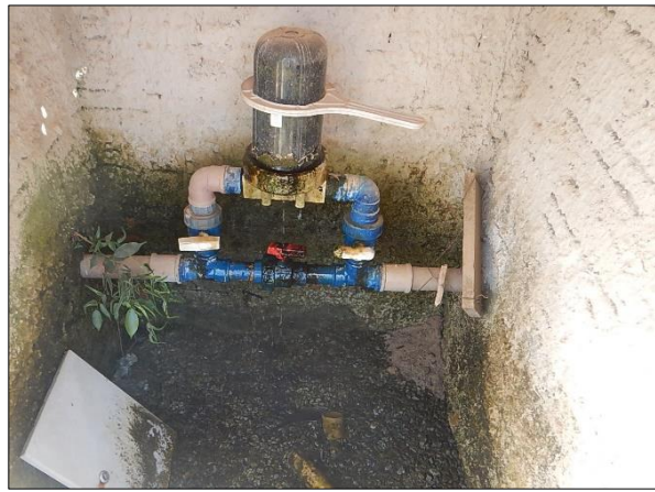
Figura 52. (A) Vista da boca do poço tubular e cavalete com tubo guia (B) Clorador de pastilha (C), Quadro de comando (D) Cerca de proteção na 7ª Agrovila, Terra Nova do Norte-MT
