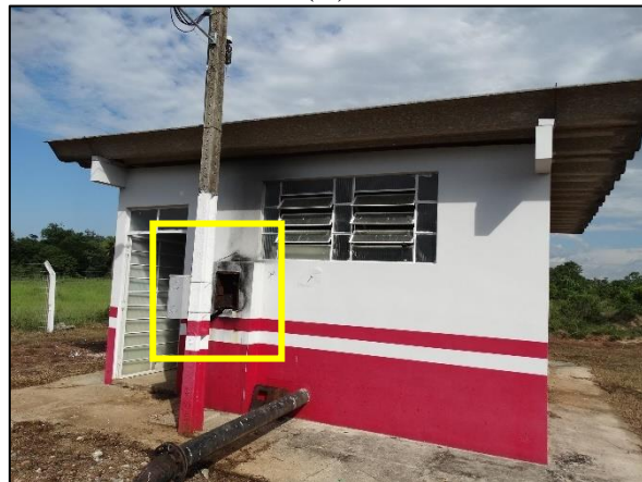
Figura 15. (A) Quadro de comando da captação superficial (B) Estrutura de alvenaria de abrigo do quadro de comando e das bombas de captação superficial com detalhe para o quadro danificado
