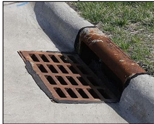
Figura 92. Boca de lobo com gradeamento na sarjeta
