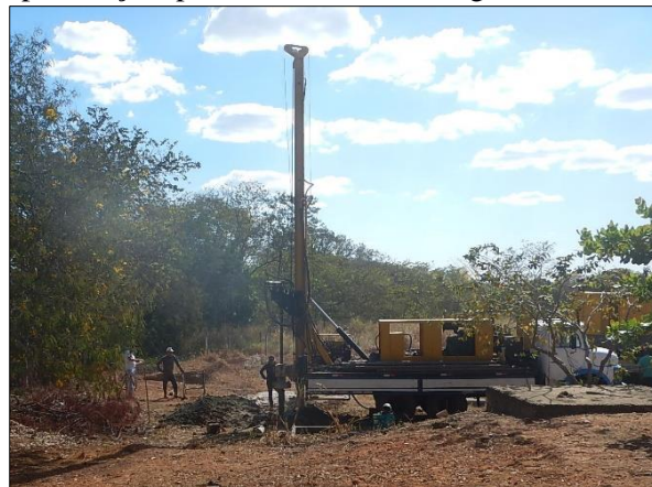
Figura 50. Poço em perfuração, próximo à escola, 6ª Agrovila, Terra Nova do Norte-MT
