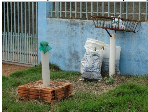
Figura 19. Vista da laje da fossa construída no passeio público
