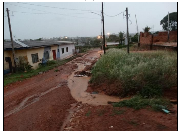
Figura 26. (A) Danos ao pavimento de vias, ocasionando pela falta de drenagem profunda (B) Água pluvial escoando em vias não-pavimentada formando sulcos de erosão (C) Boca de lobo com capacidade de engolimento limitada pela obstrução de resíduos
