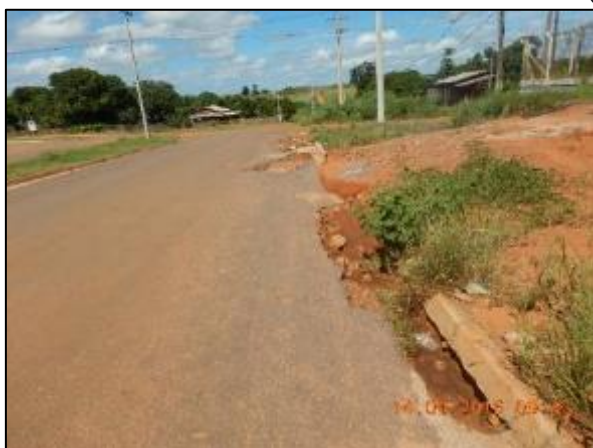
Figura 42. Enxurrada verificada na Av. Santa Catarina (A) bocas de lobos danificadas e com acúmulo de resíduos (B)
