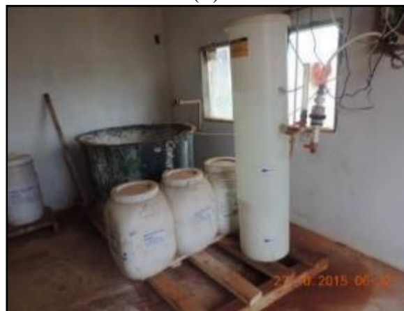
Figura 12. Casa de química (A), tanque de cloração e fluoretação (B), bombas dosadoras (C) (A) (B)
