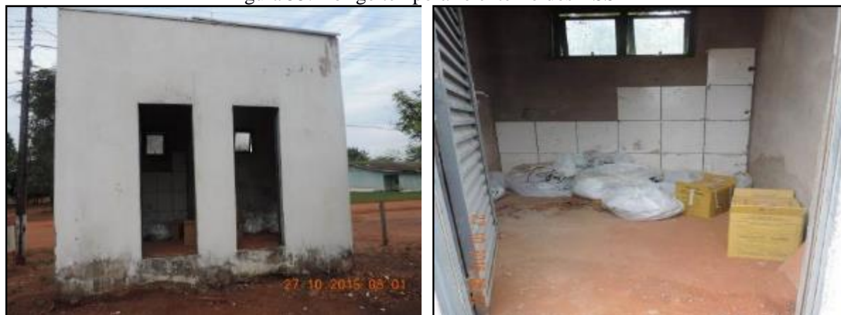
Figura 55. Abrigo temporário externo dos RSS
