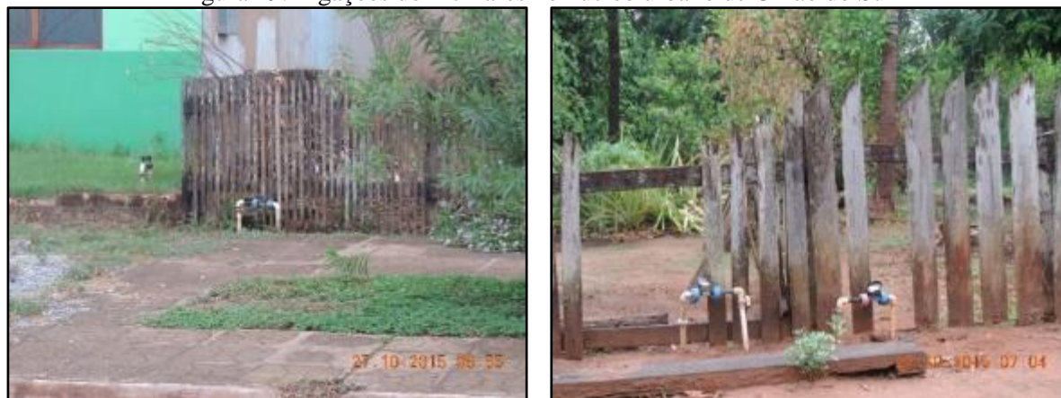
Figura 19. Ligações domiciliares no núcleo urbano de União do Sul
