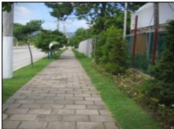
Figura 121. Vala de detenção ao longo da rua
