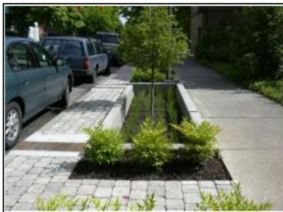
Figura 119. Trincheira de infiltração no passeio
