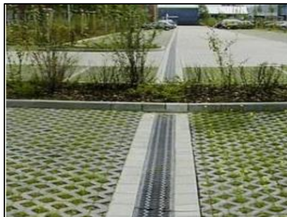
Figura 120. Trincheira de infiltração no estacionamento
