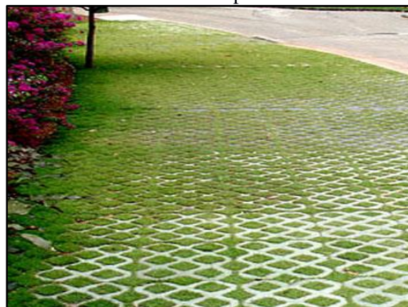
Figura 116. Pavimento poroso – concregrama instalado em passeio
