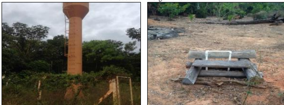
Figura 76. Reservatório tipo taça (esq.) e ligação domiciliar (dir.) – executados pelo convênio Funasa - Subsistema Olga Benário 2
