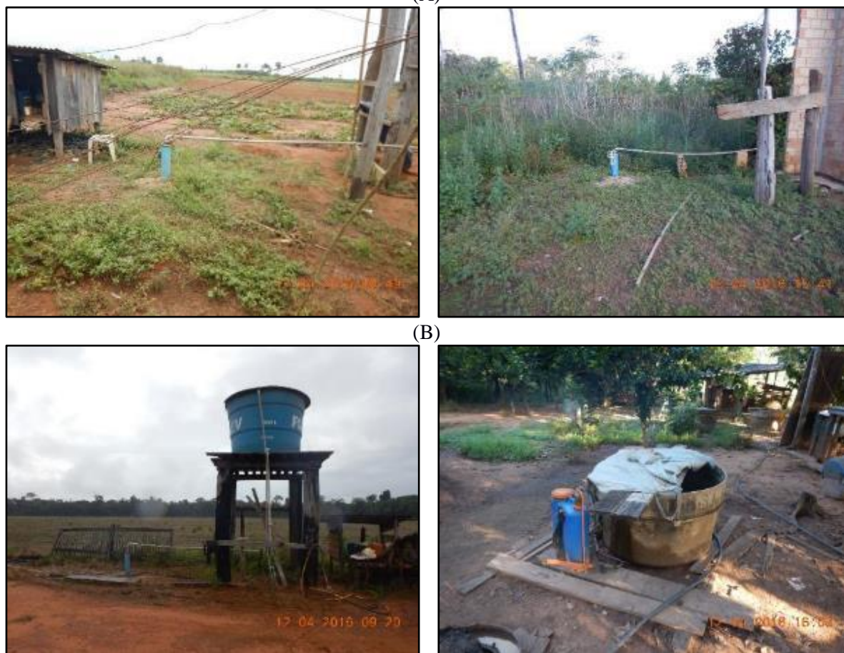
Figura 74. Poços tubulares (A) e reservatórios (B) observados em Olga Benário
