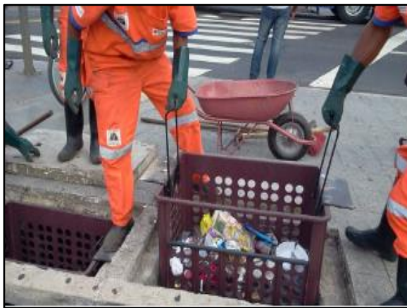
Figura 111. Cesta acoplada à boca do bueiro
