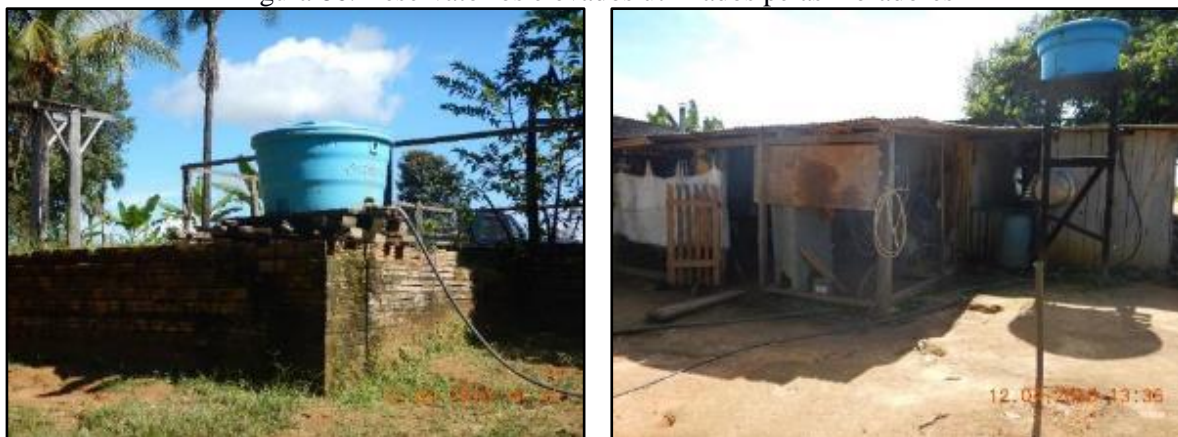
Figura 86. Reservatórios elevados utilizados pelas moradores
