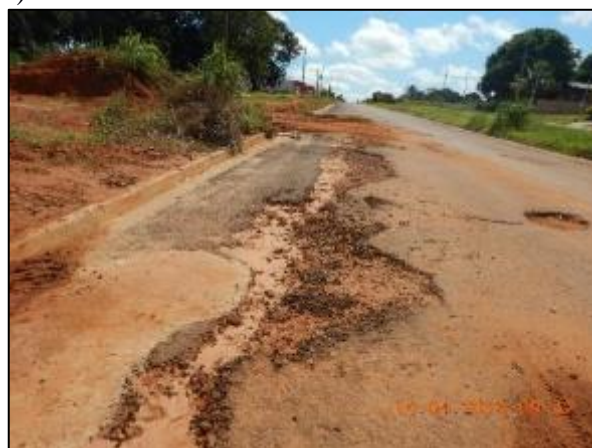
Figura 42. Enxurrada verificada na Av. Santa Catarina (A) bocas de lobos danificadas e com acúmulo de resíduos (B)
