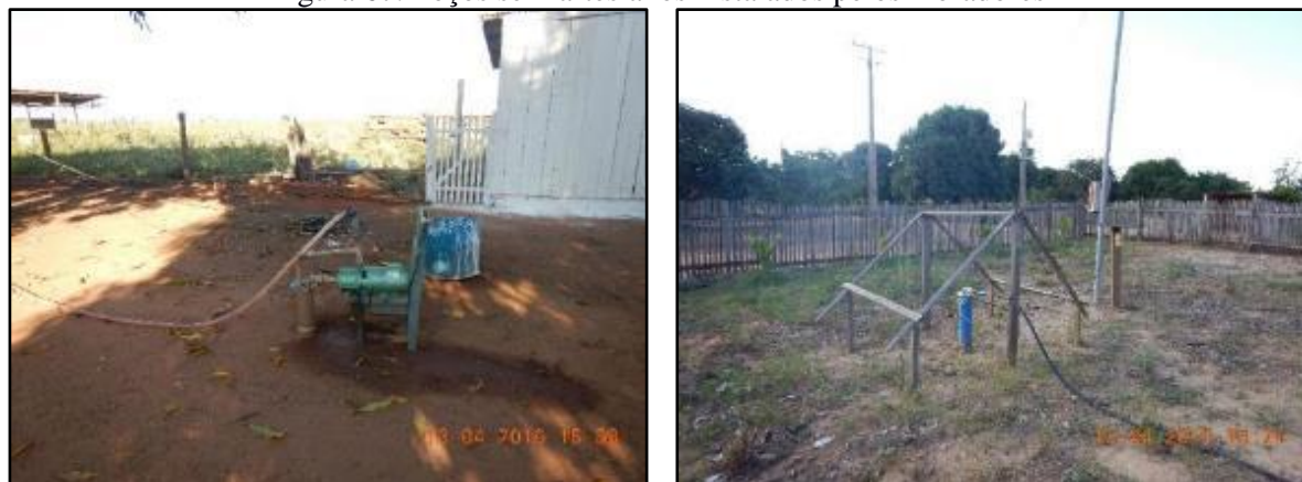
Figura 67. Poços semiartesianos instalados pelos moradores
