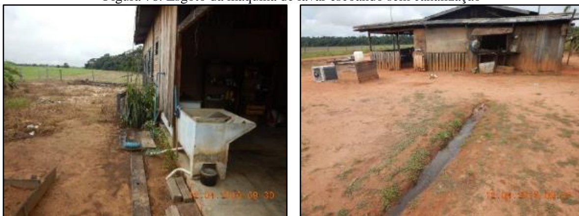
Figura 78. Esgoto da máquina de lavar escoando sem canalização
