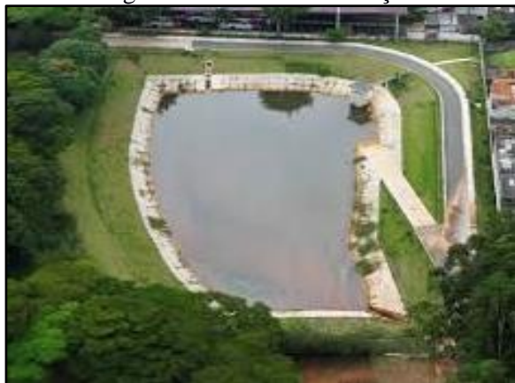
Figura 123. Bacia de detenção
