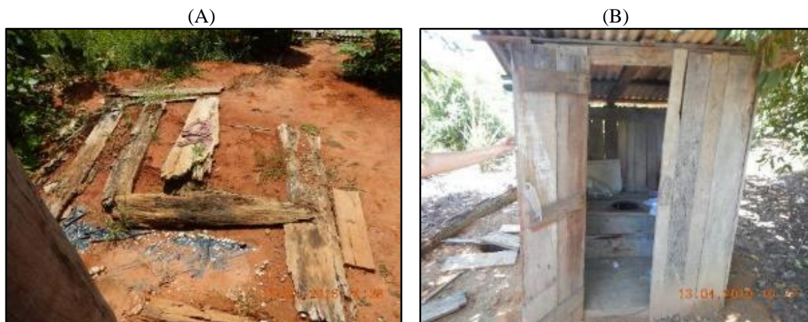
Figura 92. Vista da tampa de uma fossas rudimentar (A) e de um banheiro tipo latrina (B) utilizados no Assentamento Sonho de Anderson
