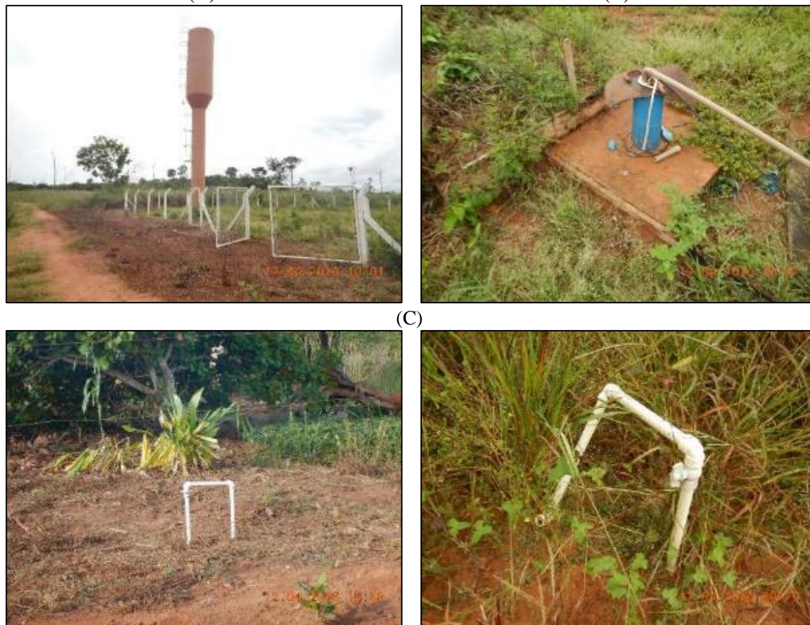
Figura 75. Reservatório tipo taça (A), poço tubular (B) e ligações domiciliares (C) – executados pelo convênio Funasa no Subsistema Olga Benário 1
