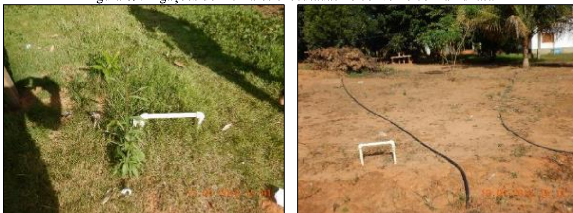
Figura 69. Ligações domiciliares executadas no convênio com a Funasa
