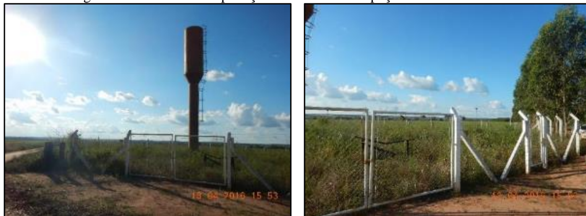
Figura 83. Reservatório tipo taça e área cercada do poço tubular - CV Funasa
