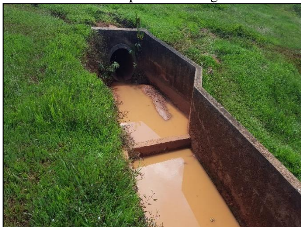
Figura 30. Desague da galeria de águas pluviais no dissipador de energia
