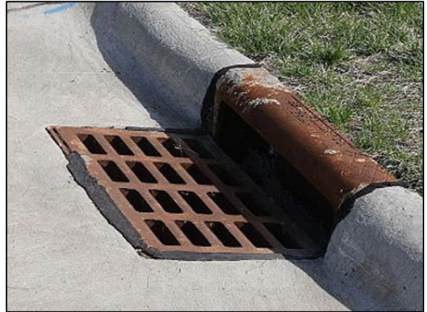
Figura 94. Boca de lobo com gradeamento
