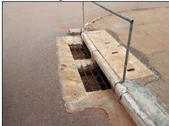
Figura 29. Boca de lobo com grela no cruzamento da Rua Domingos Azzolini com a Av. Curitiba
