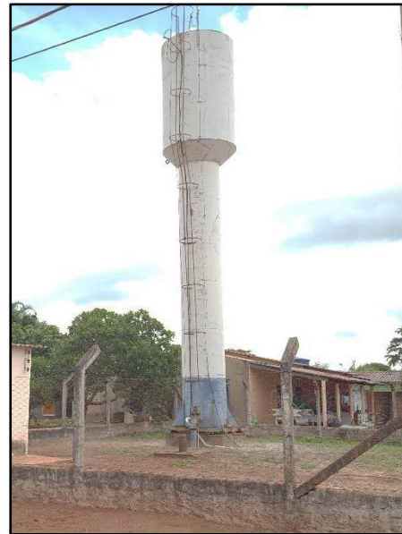
Figura 21. Reservatório RAP-02 de 30 m 3 na área do PT-02
