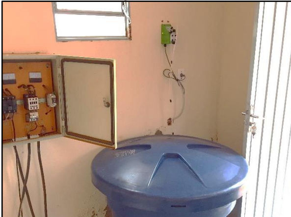
Figura 18. Bomba dosadora interligada à caixa d'água com solução de hipoclorito de sódio no abrigo do PT-02
