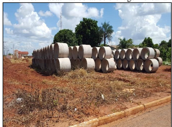
Figura 37. Manilhas de concreto estocadas para serem utilizadas nas obras de drenagem urbana
