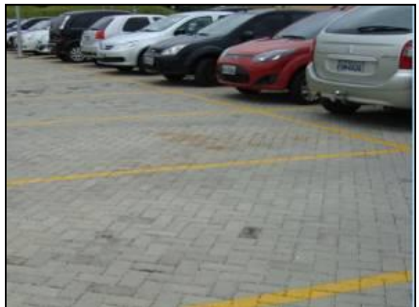
Figura 100. Pavimento poroso instalado em estacionamento
