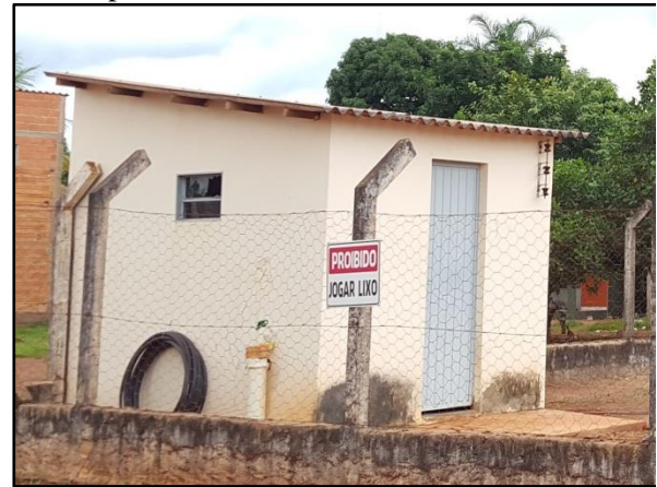
Figura 17. Abrigo do quadro de comando, bomba dosadora de cloro e da solução de hipoclorito de sódio na área do PT-01
