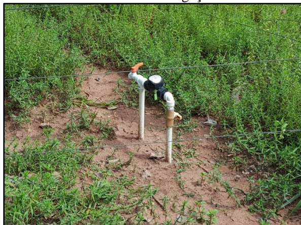
Figura 72. Hidrômetro no cavale em uma ligação no assentamento Matrinchã
