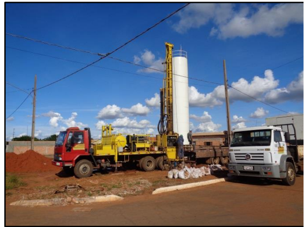
Figura 13. Equipamentos perfurando o PT-04 no Jd. Bem Viver em Santo Antônio do Leste-MT
