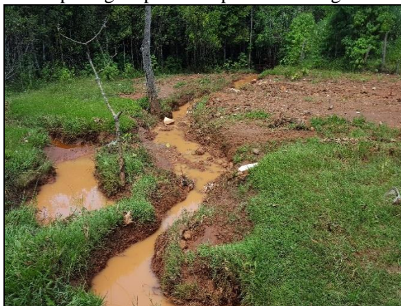
Figura 31. Erosão provocada pela água após sua passagem pelo dissipador de energia
