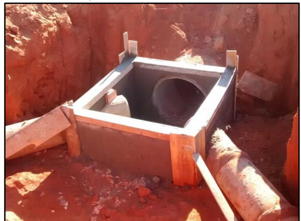
Figura 35. Execução de poço de visita no bairro Centro, em Santo Antônio do Leste
