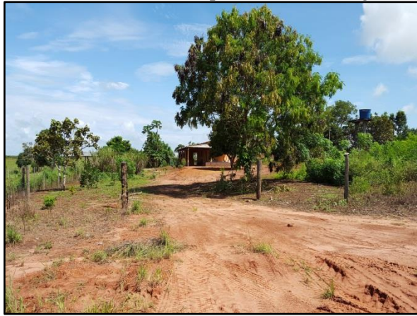
Figura 74. Estrada não pavimentada de acesso ao assentamento sem dispositivos de drenagem
