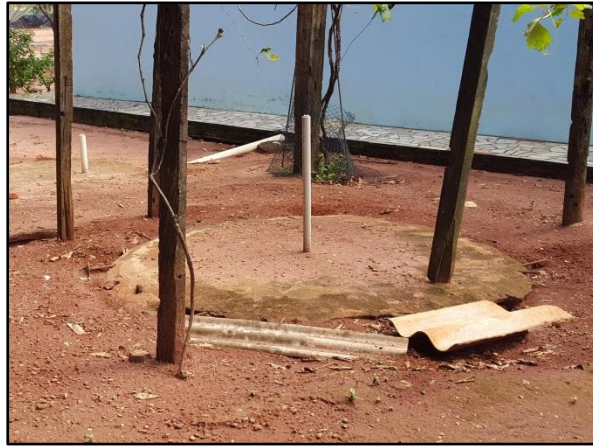
Figura 73. Fossa absorvente de uma propriedade no assentamento Matrinchã, em Santo Antônio do Leste-MT
