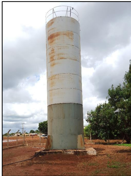
Figura 20. Reservatório RAP-01 de 120 m 3 na área do PT-01
