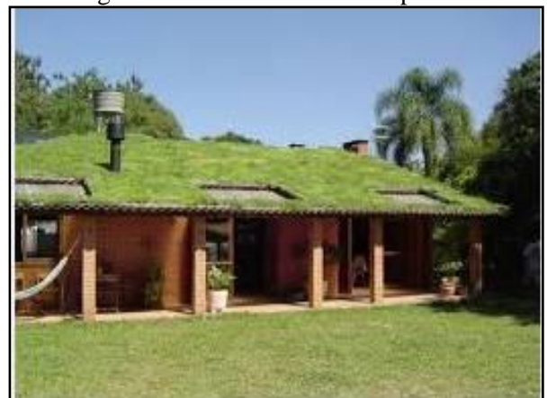
Figura 96. Telhado verde com plantas
