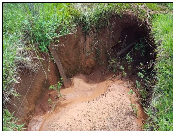
Figura 46. Profundidade da erosão formada na via não pavimentada
