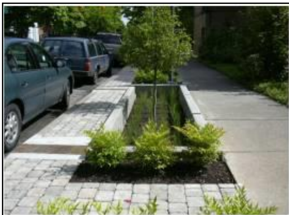
Figura 101. Trincheira de infiltração no passeio
