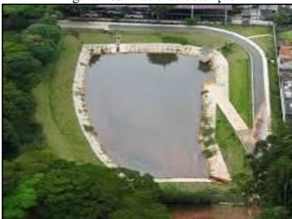
Figura 105. Bacia de detenção
