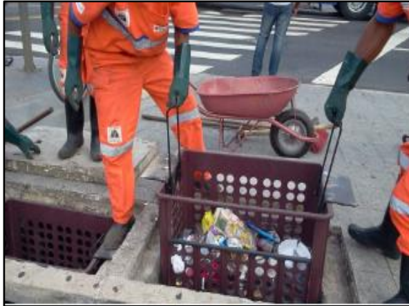
Figura 93. Cesta acoplada a boca do bueiro
