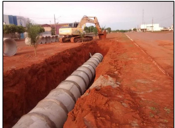
Figura 33. Execução da galeria de águas pluviais na Rua Goiás no bairro Centro, em Santo Antônio do Leste
