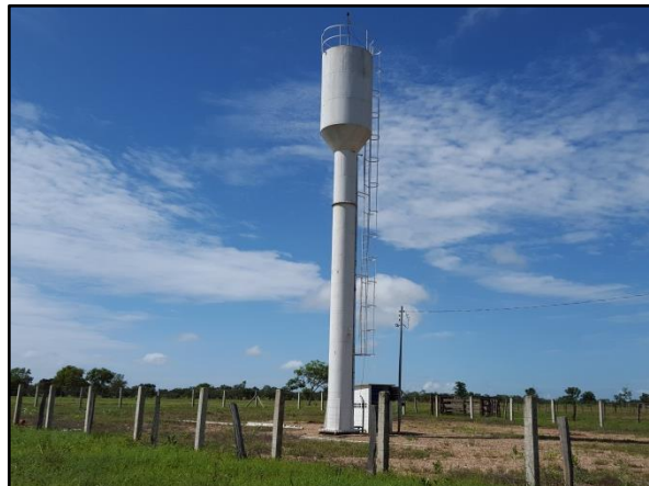
Figura 71. Reservatório de 15 m 3 do assentamento Matrinchã
