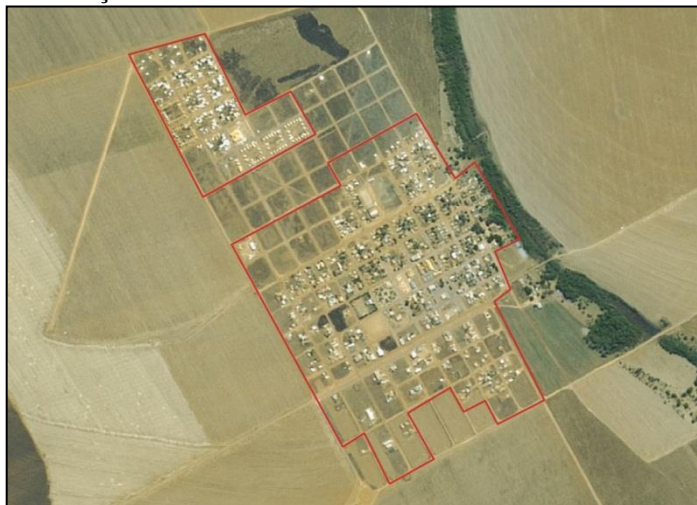
Figura 48. Delimitação da área urbanizada de Santo Antônio do Leste-MT em 2013
