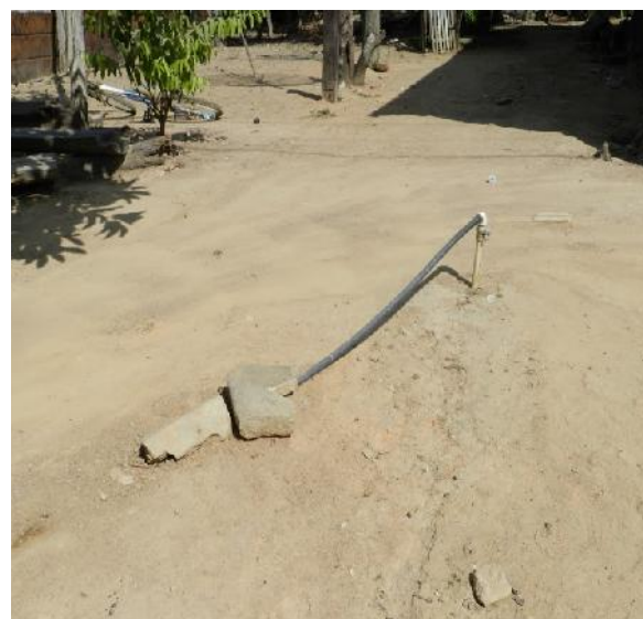
Figura 58 – Ligação do cavalete
