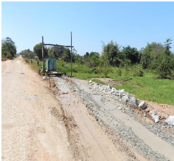
Figura 30– captação para abastecer carro pipa vista geral
