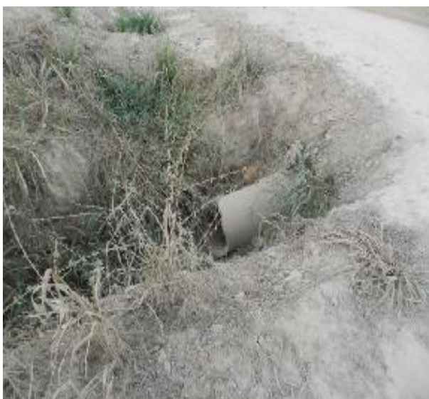
Figura 77 - vala aberta em área alagadiça para facilitar escoamento da água de chuva
