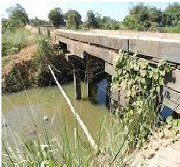
Figura 73– Ponte de madeira sobre o córrego Angelim
