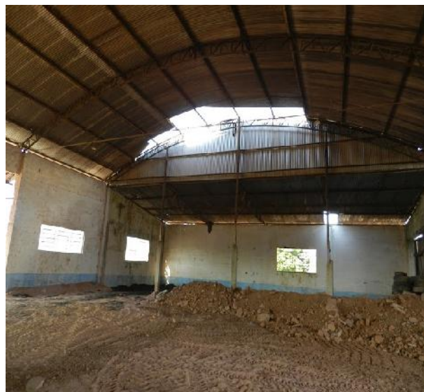
Figura 95 – Deposito de pneus vista frontal
