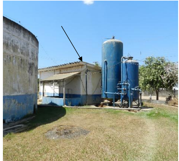
Figura 34– casa da pressurização
