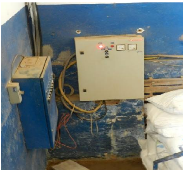
Figura 45– Sistema de pressurização da rede de água tratada
