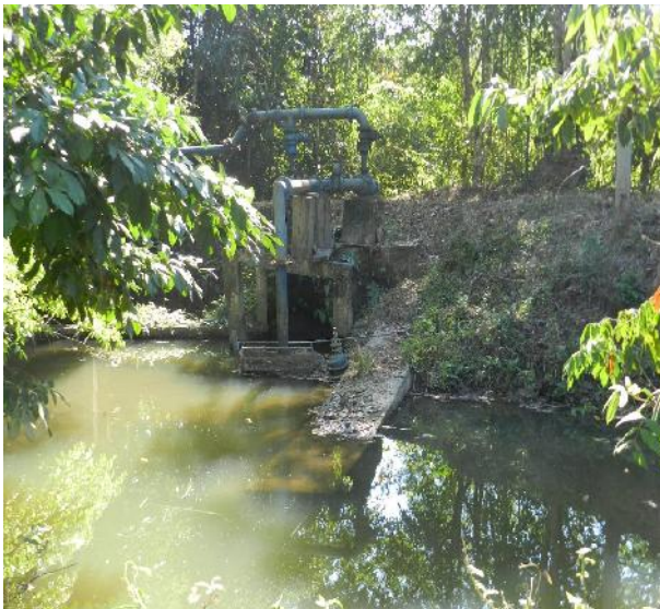
Figura 28- Captação superficial – Córrego Angelim
