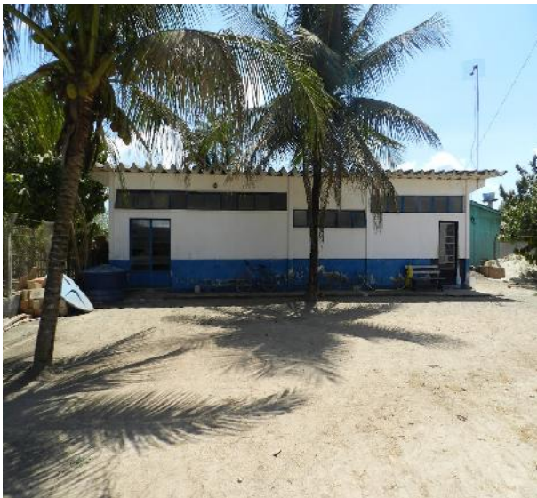
Figura 37- Laboratório e casa de química
