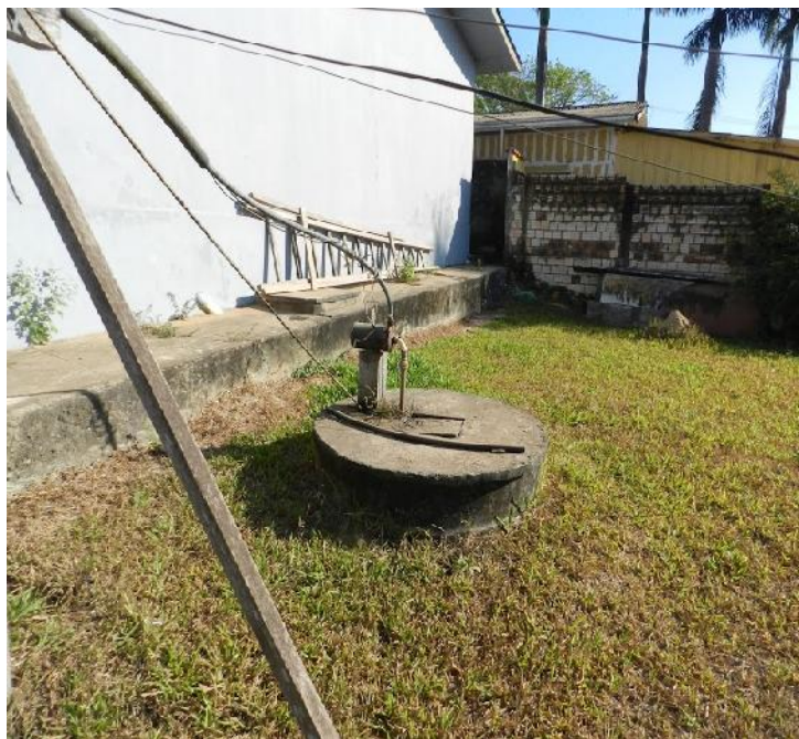
Figura 24–Poço raso particular
