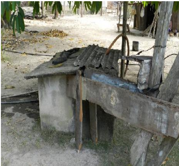
Figura 53 - Poço que abastece a Vila Mutum
