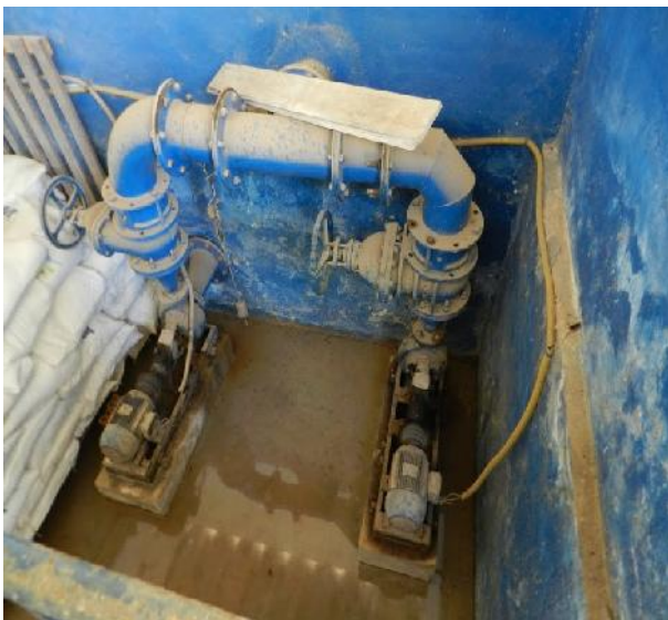
Figura 45– Sistema de pressurização da rede de água tratada
