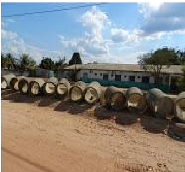
Figura 65 - Manilhas dispostas na margem da obra
