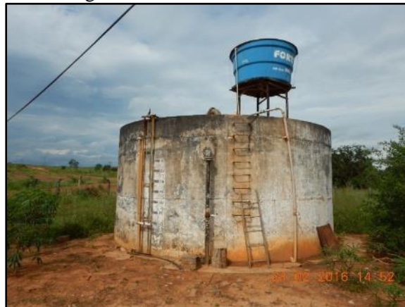
Figura 11. Reservatório de 100 m 3
