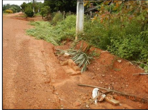
Figura 32. Vias não pavimentadas com erosões decorrentes de enxurradas (A), meio fio e sarjeta danificados (A) e boca de lobo danificada e obstruída (C)
