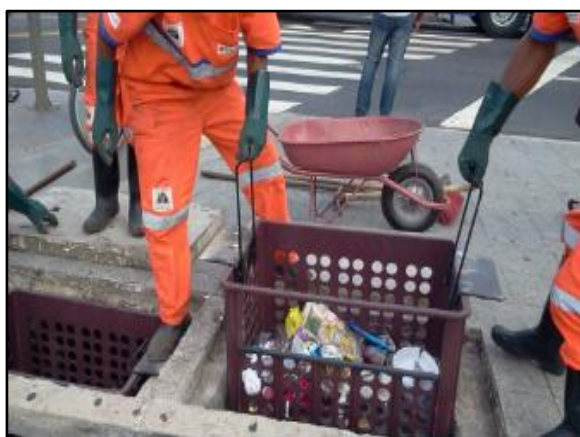
Figura 72. Cesta acoplada a boca do bueiro
