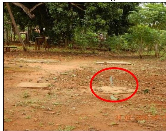
Figura 22. Vista da laje e suspiros de fossa existentes no núcleo urbano de Araguainha
