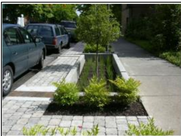
Figura 80. Trincheira de infiltração no passeio
