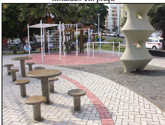
Figura 76. Pavimento poroso – piso intertravado instalado em praça
