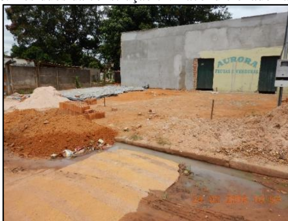
Figura 46. Resíduos da construção civil acondicionado nas calçadas
