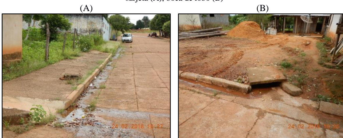
Figura 28. Dispositivos de microdrenagem existente no núcleo urbano de Araguainha, meio fio e sarjeta (A), boca de lobo (B)
