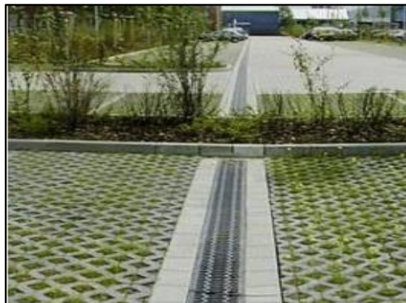
Figura 81. Trincheira de infiltração no estacionamento
