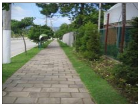
Figura 82. Vala de detenção ao longo da rua
