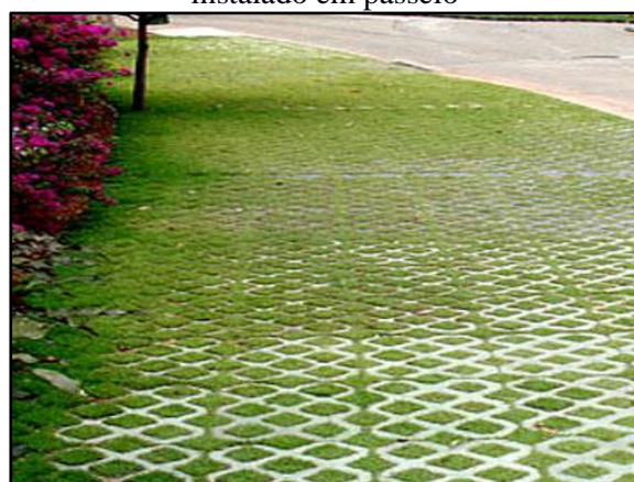
Figura 77. Pavimento poroso – concregrama instalado em passeio
