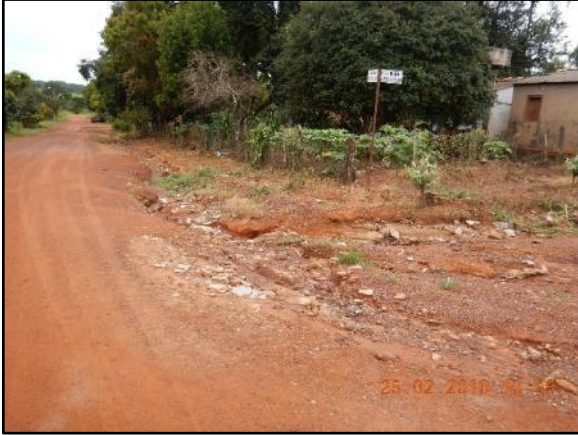
Figura 32. Vias não pavimentadas com erosões decorrentes de enxurradas (A), meio fio e sarjeta danificados (A) e boca de lobo danificada e obstruída (C)
