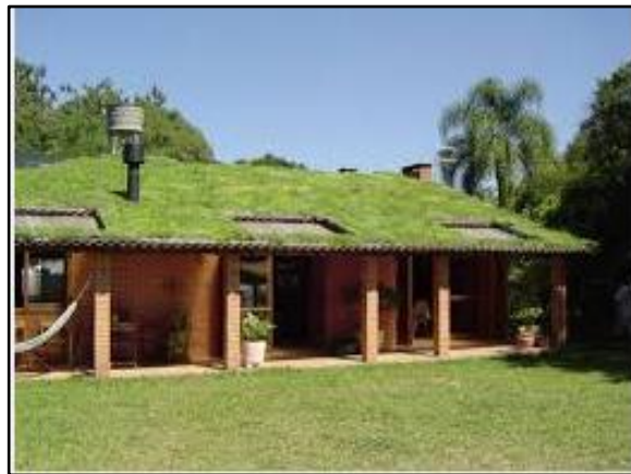
Figura 75. Telhado verde com plantas
