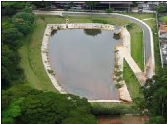
Figura 84. Bacia de detenção
