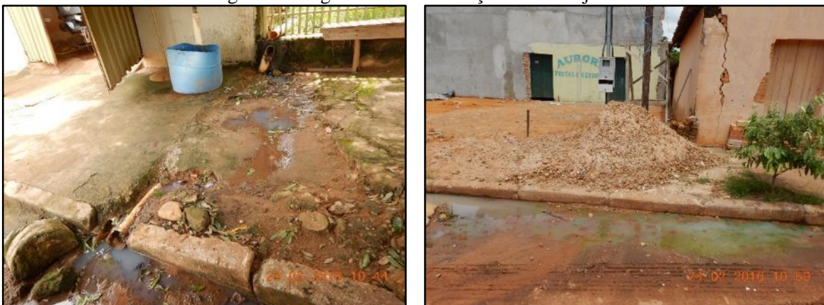
Figura 24. Esgotos in natura lançados nas sarjetas
