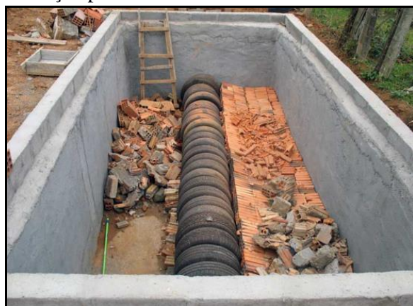
Figura 67. Método do círculo de bananeiras em execução para tratamento individual
