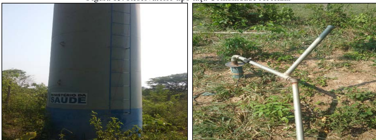
Figura 15. Reservatório tipo taça Comunidade Acorizal
