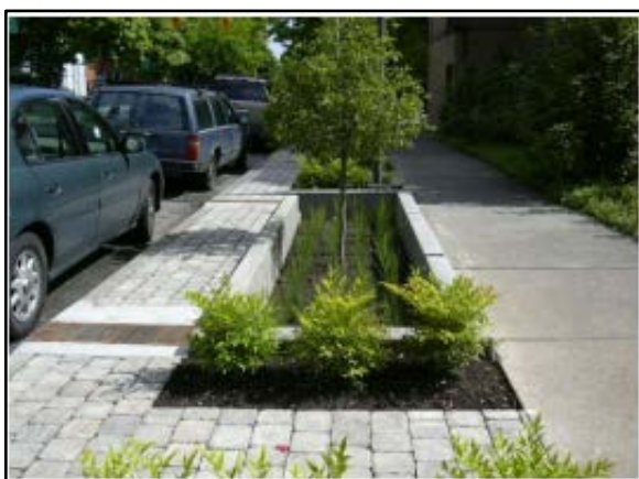
Figura 142. Trincheira de infiltração no passeio
