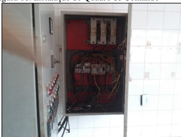
Figura 18. Instalação do Quadro de Comando
