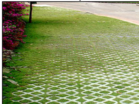
Figura 139. Pavimento poroso – concregrama instalado em passeio
