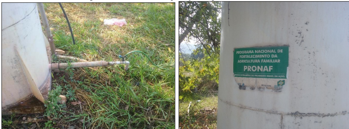
Figura 12. Reservatório tipo taça Cooperativa de Leite
