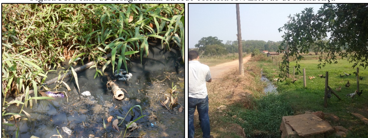
Figura 36. Ponto de deságue final da rede coletora Av. Estevão de Mendonça
