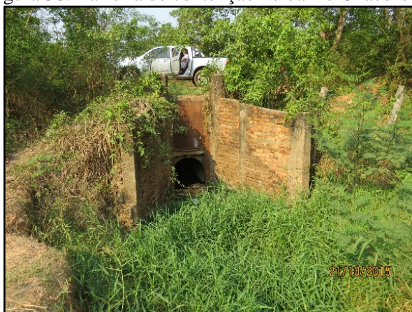
Figura 38. Barreira de contenção no bairro Chacororé
