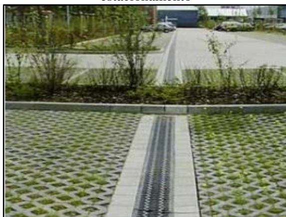
Figura 143. Trincheira de infiltração no estacionamento
