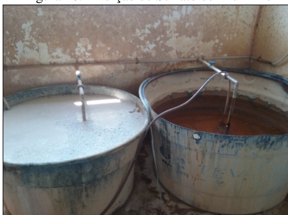
Figura 20. Diluição de Sulfato de Alumínio
