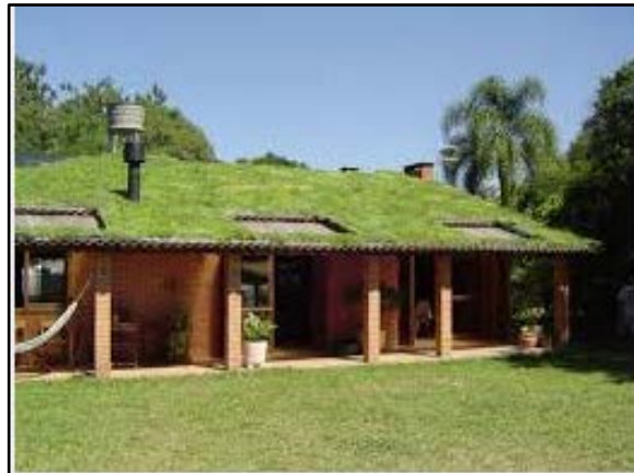
Figura 137. Telhado verde com plantas
