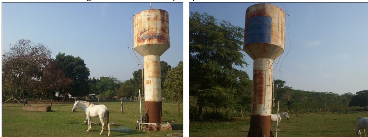
Figura 14. Reservatório tipo taça Comunidade Buritizal
