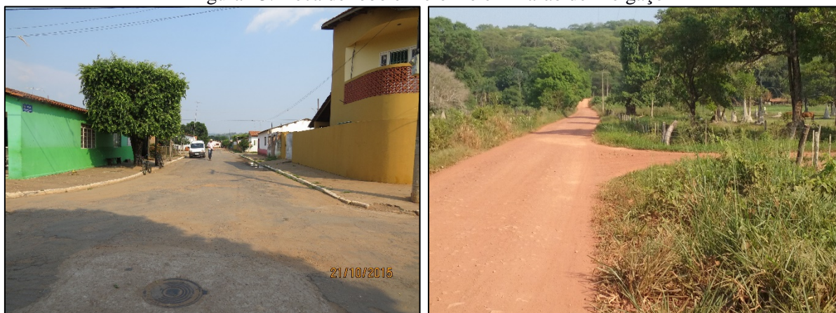
Figura 43. Boca de lobo e meio-fio em Barão de Melgaço
