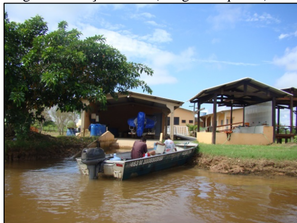
Figura 82. Poço tubular (margem esquerda)
