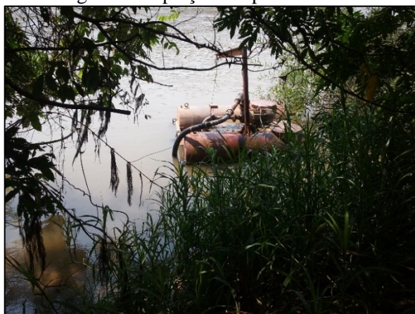
Figura 6. Captação - Tipo Flutuador
