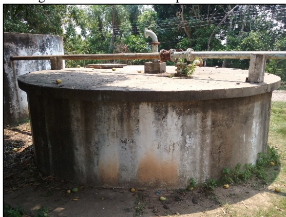
Figura 24. Reservatório Apoiado 50m 3
