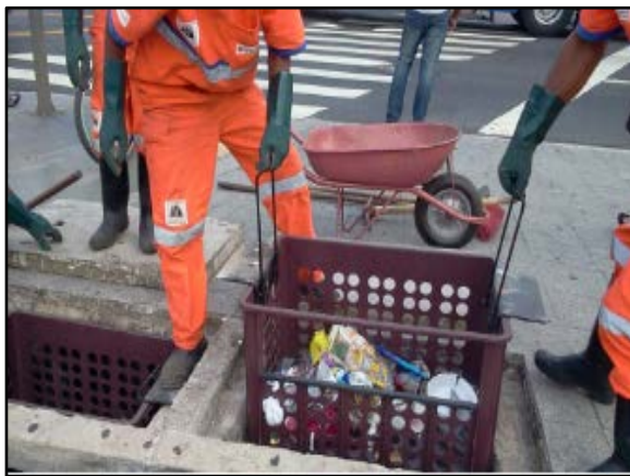
Figura 134. Cesta acoplada à boca do bueiro
