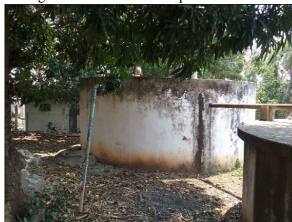
Figura 25. Reservatório Apoiado 100m 3
