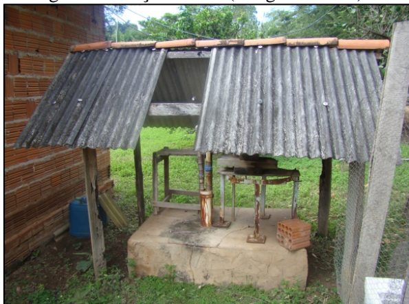
Figura 81. Poço tubular (margem direita)
