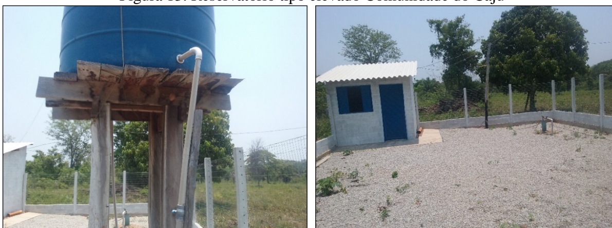
Figura 13. Reservatório tipo elevado Comunidade do Caju
