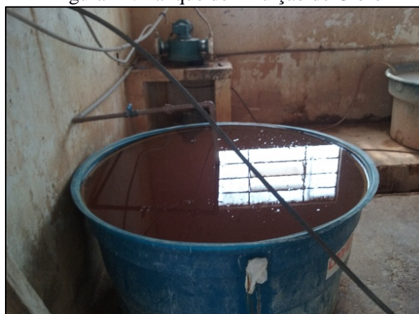
Figura 21. Tanque de Diluição de Cloro
