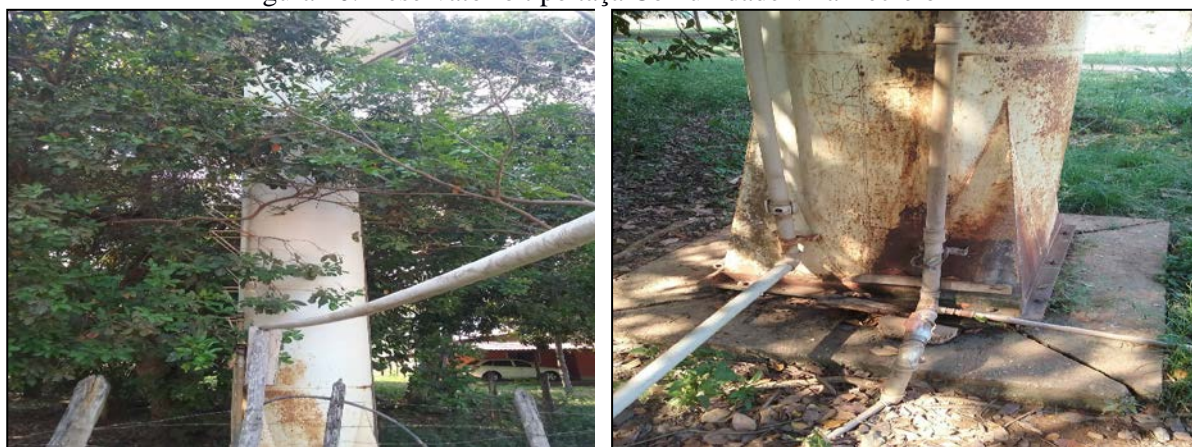
Figura 10. Reservatório tipo taça Comunidade Vila Recreio
