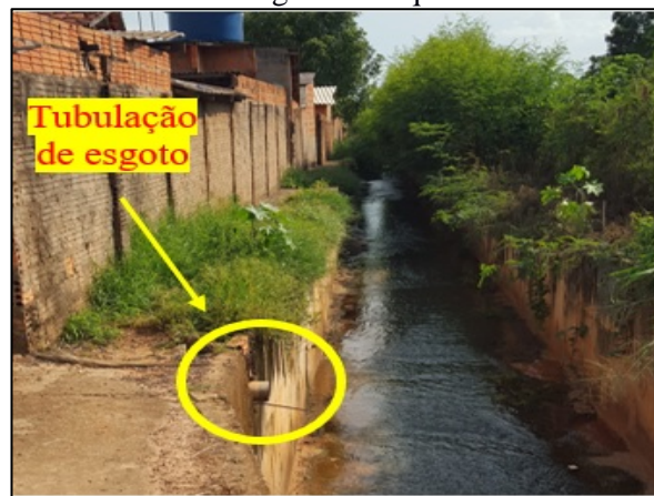
Figura 54. Lançamento de esgoto bruto no córrego do Tanque
