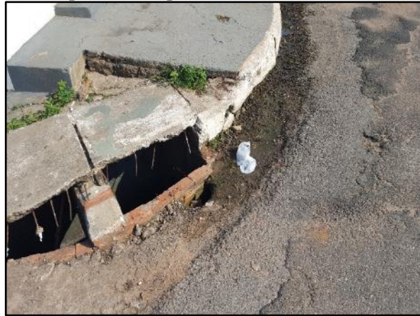
Figura 65. Boca de lobo localizada de forma inadequada na esquina da rua 01 com a rua A
