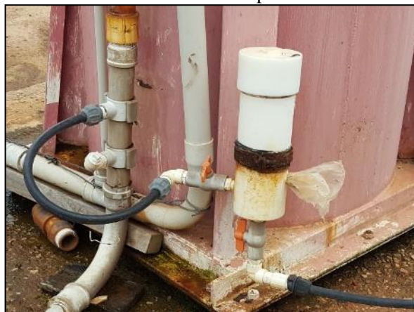
Figura 125. Clorador de contato inoperante em Nova Fernandópolis
