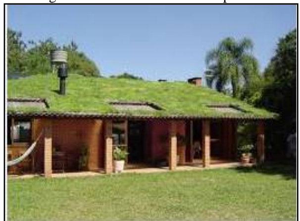
Figura 171. Telhado verde com plantas
