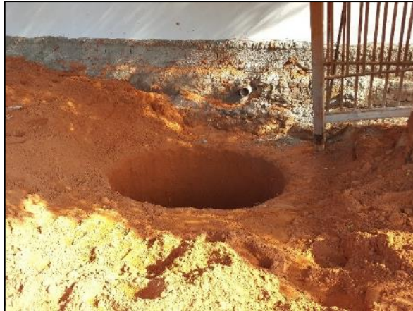
Figura 51. Fossa absorvente de uma residência em construção na calçada
