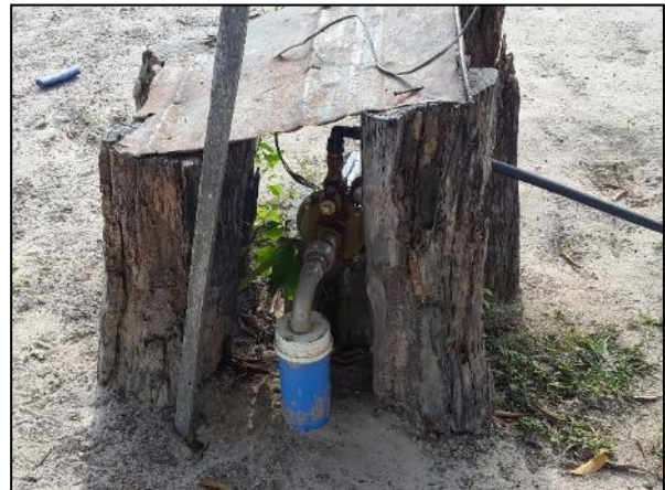
Figura 134. Poço cacimba de uma propriedade rural no assentamento Antônio Conselheiro
