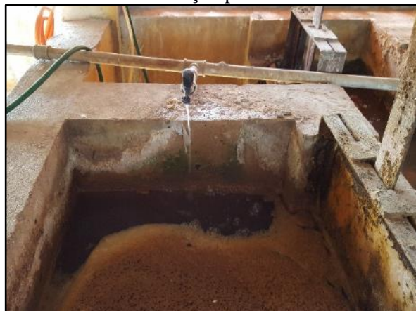
Figura 21. Aplicação do sulfato de alumínio na câmara de distribuição para ETA metálica
