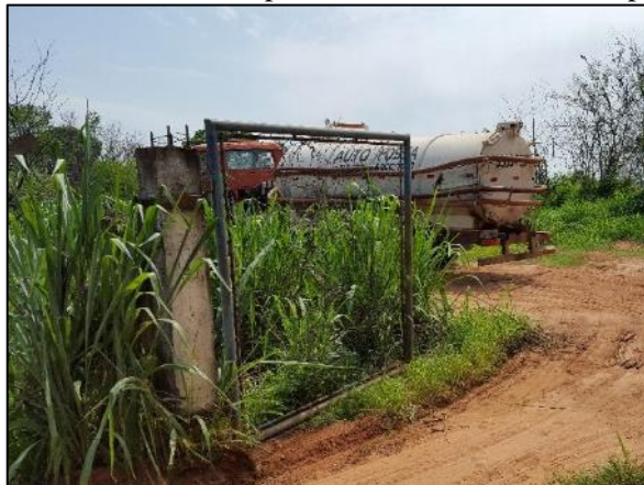
Figura 52. Caminhão limpa-fossa na área da ETE inoperante
