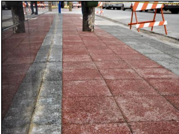
Figura 174. Pavimento poroso instalado em passeio público
