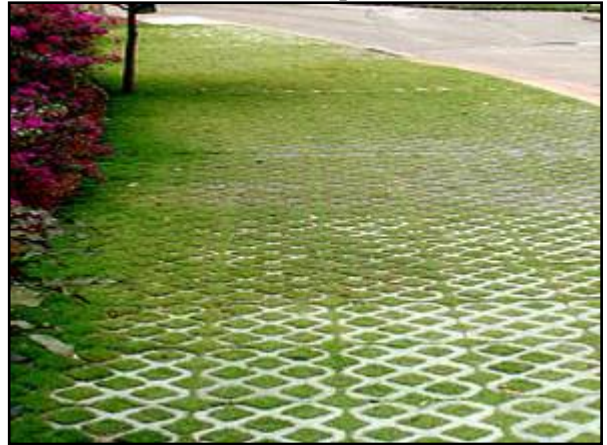
Figura 173. Pavimento poroso – concregrama instalado em passeio
