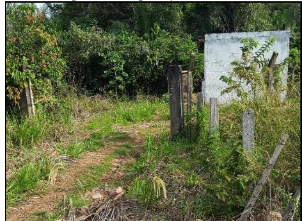
Figura 111. Área da captação do distrito Assari desprovido de proteção de acesso
