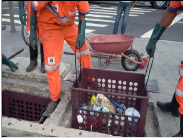
Figura 168. Cesta acoplada a boca do bueiro
