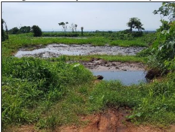
Figura 49. Lagoa anaeróbia da ETE de Barra do Bugres em estado precário de conservação
