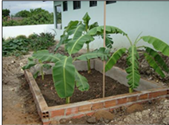
Figura 165. Fossa bananeira em funcionamento
