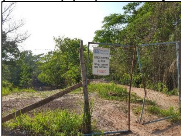
Figura 11. Portão e cerca em estado precário para acesso à captação superficial no rio Bugres
