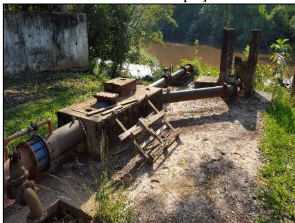
Figura 15. Barrilete com válvula de retenção, ponto de descarga da linha e redução de 200 x 300 mm na área da captação
