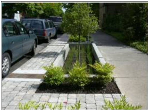
Figura 176. Trincheira de infiltração no passeio
