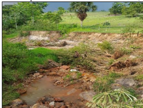
Figura 68. Processo erosivo em um córrego sob a MT-247 à direita da pista sentido Barra-Lambari D'Oeste (2)
