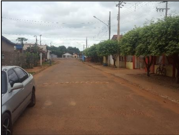
Figura 139. Rua pavimenta com sarjeta e meio fio no distrito de Assari
