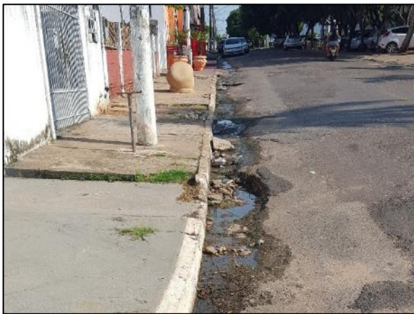
Figura 53. Despejo de águas servidas na sarjeta da Rua 01 ao lado da UNEMAT
