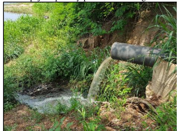
Figura 48. Esgoto sem tratamento na EEE despejado pelo by-pass no Rio Paraguai
