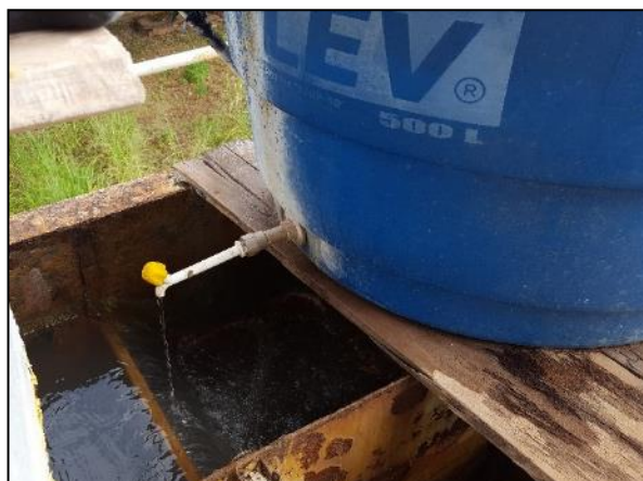
Figura 114. Aplicação do polímetro no floculador na ETA de Assari
