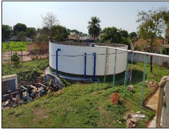
Figura 37. Reservatório RAP-1 de 1000,0 m 3 na área da ETA
