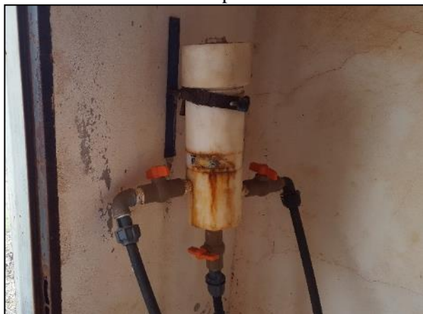
Figura 124. Clorador de contato inoperante em Currupira
