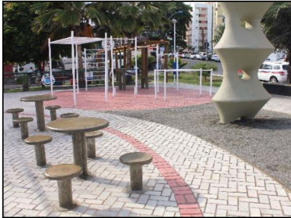
Figura 172. Pavimento poroso – piso intertravado instalado em praça
