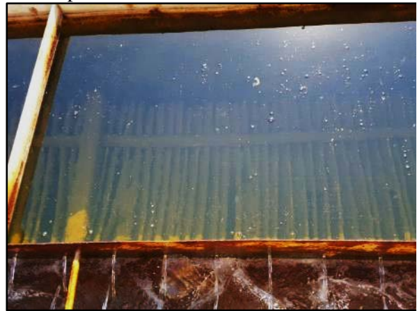
Figura 28. Decantador de alta taxa com placas planas de PVC da ETA metálica
