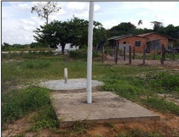
Figura 135. Fossas rudimentares utilizadas de residências no assentamento Cabaças
