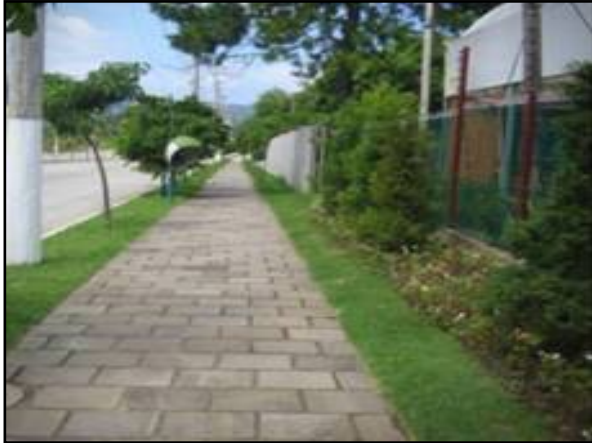
Figura 178. Vala de detenção ao longo da rua
