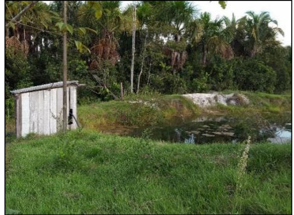
Figura 131. Manancial e abrigo dos equipamentos da captação do assentamento Campo Verde
