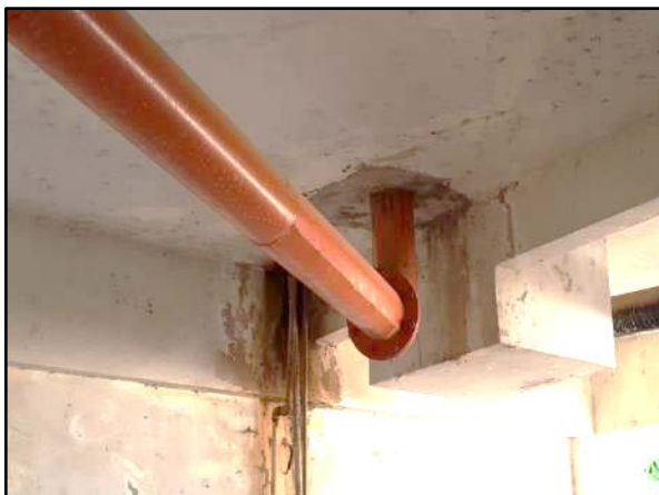
Figura 23. Tubulação interligando uma das câmaras de distribuição da calha Parshall ao floculador da ETA metálica
