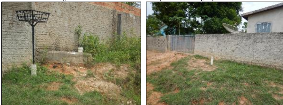
Figura 19. Fossas instaladas em vias públicas, Cotriguaçu-MT
