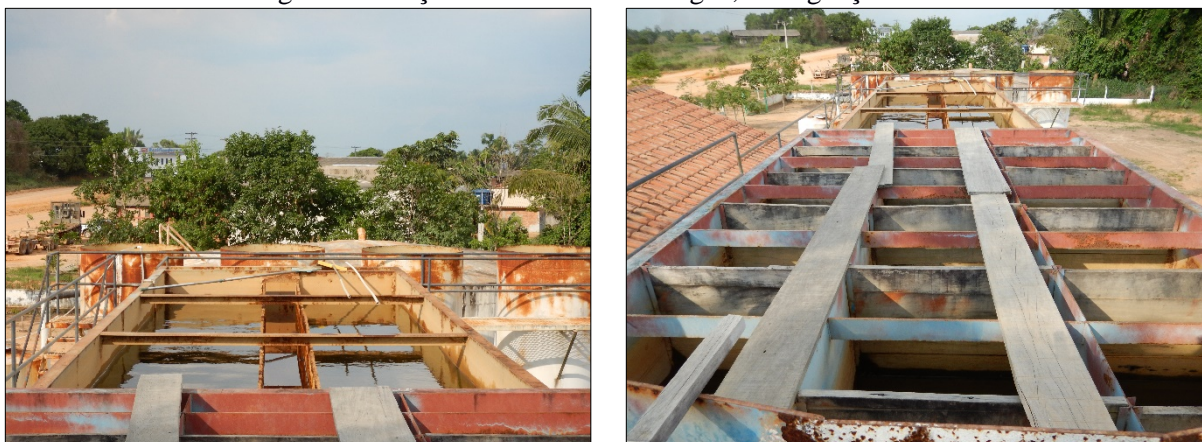
Figura 8. Estação de tratamento de Água, Cotriguaçu-MT
