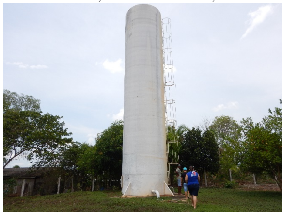
Figura 39. Reservatório cilíndrico, metálico e elevado, Nova União, Cotriguaçu-MT
