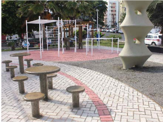
Figura 67. Pavimento poroso – piso intertravado instalado em praça
