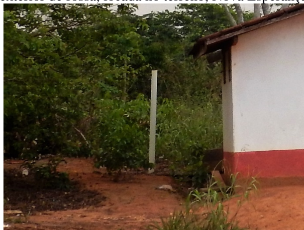
Figura 51. Vista exterior de fossa, locada no terreno, Nova Esperança, Cotriguaçu -MT
