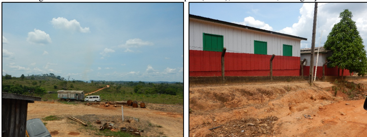
Figura 42. Vista exterior de fossa com suspiro (A e B), Nova União, Cotriguaçu-MT
