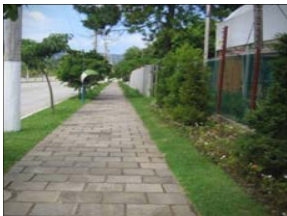
Figura 73. Vala de detenção ao longo da rua
