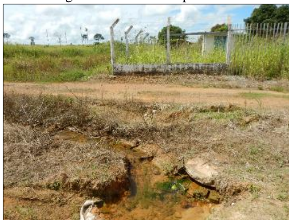
Figura 21. Vista do trecho em que o poço de visita da rede de esgoto existente recebe contribuição de águas de mananciais próximos
