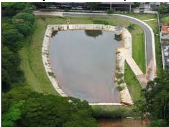
Figura 75. Bacia de detenção
