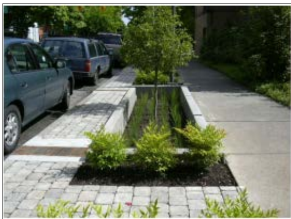
Figura 71. Trincheira de infiltração no passeio
