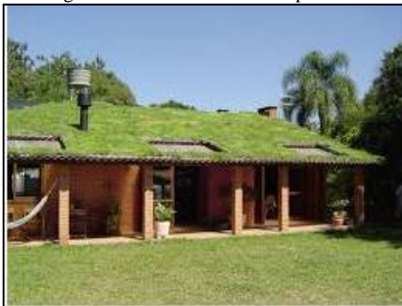
Figura 66. Telhado verde com plantas
