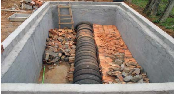
Figura 60. Método do círculo de bananeiras em execução para tratamento individual
