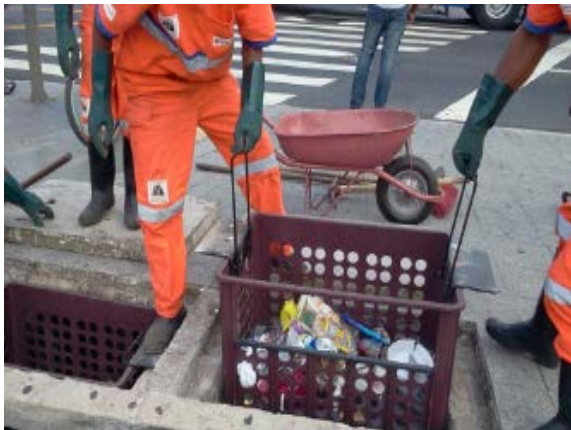
Figura 63. Cesta acoplada à boca do bueiro
