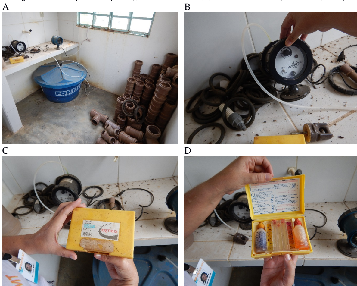
Figura 40. Caixa para diluição (A), bomba dosadora (B) e kit de análise de pH e cloro (C e D)
