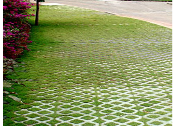
Figura 68. Pavimento poroso – concregrama instalado em passeio
