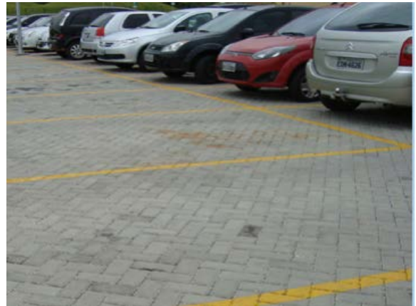
Figura 70. Pavimento poroso instalado em estacionamento
