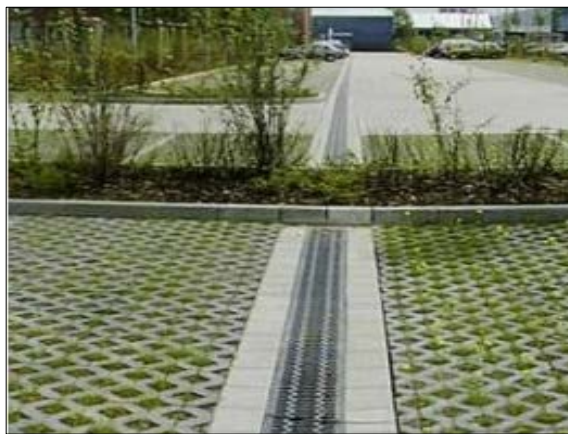
Figura 72. Trincheira de infiltração no estacionamento
