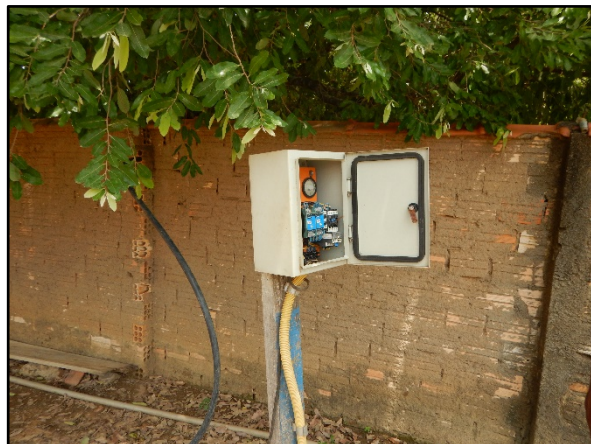
Figura 37. Vista da boca do poço tubular (P2) (A) e quadro de comando (B), Nova União
