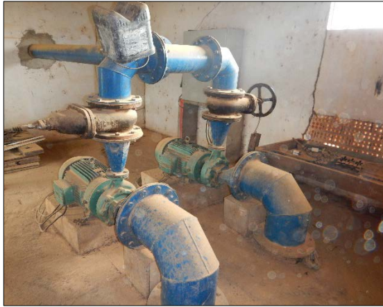
Figura 6. Bombas de recalque (A), adutora (B) e abrigo das bombas (C).
