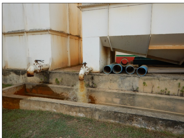
Figura 12. Vista do descarte de lodo (A) e vista do lodo seguindo para o córrego (B)
