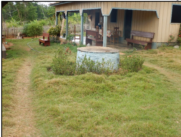
Figura 50. Vista exterior do poço freático em uma residência, Nova Esperança, Cotriguaçu-MT
