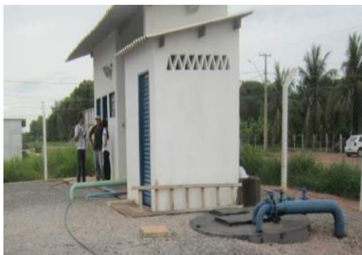
Figura 83 -Alojamento para operador Foto: Aldecy de Almeida Santos (2014)
