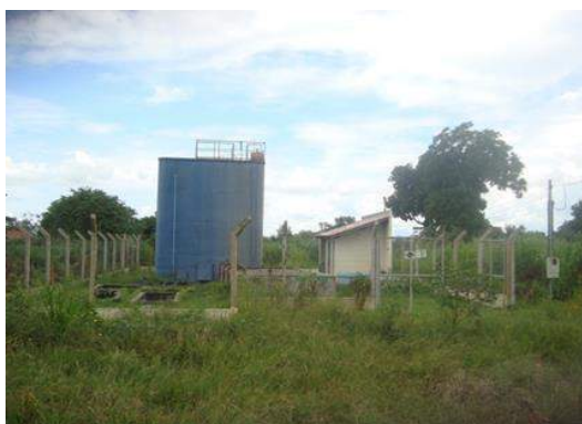
Figura 58 -Estação de Tratamento Guanabara
