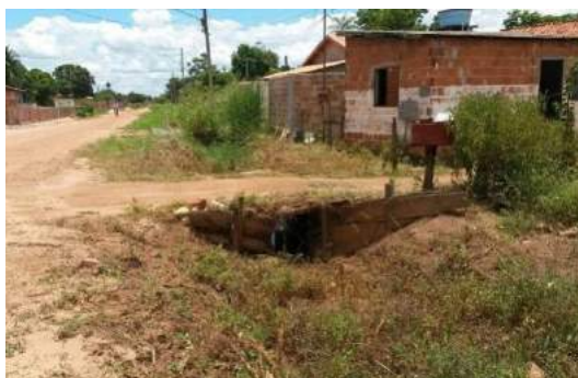
Figura 168 -Galeria de drenagem com bueiro provisório Foto:Rafael Pedrollo de Paes (2014)
