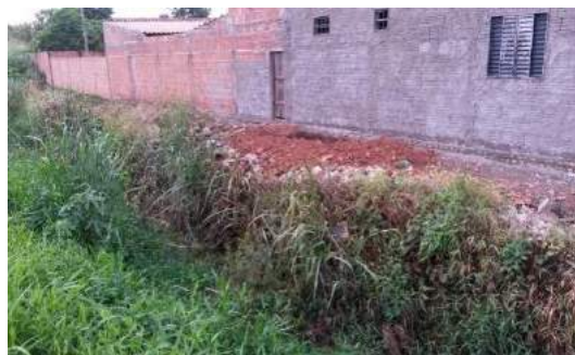
Figura 148 -Córrego do Renato com ocupações recém-construídas nas suas margens Foto: Rafael Pedrollo de Paes (2014)
