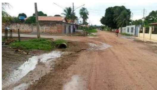
Figura 167 -Via local com sistema de drenagem lateral Foto:Rafael Pedrollo de Paes (2014)
