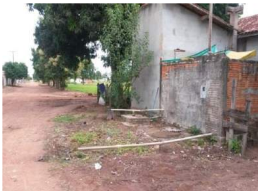
Figura 38 -Lançamento do esgoto no solo e na fossa rudimentar na área urbana. Bairro do Junco Foto: Aldecy de Almeida Santos (2014)
