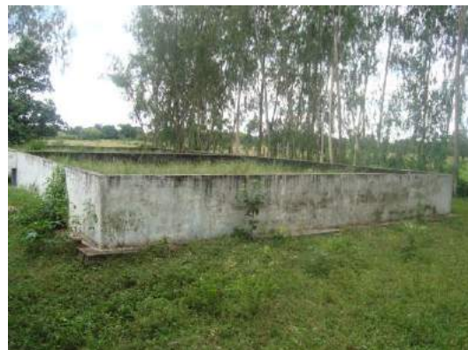
Figura 51 -Leito de secagem da ETE Cohab Nova Foto: Aldecy de Almeida Santos (2014)
