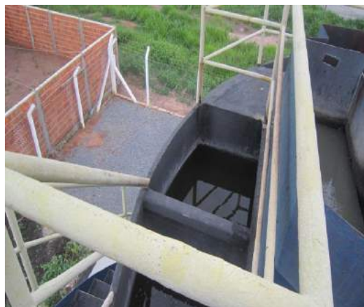
Figura 81 -ETE próximo a residência Foto: Aldecy de Almeida Santos (2014)
