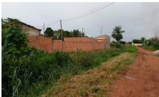
Figura 147 -Margem do córrego do Renato ocupado por residências Foto: Rafael Pedrollo de Paes (2014)
