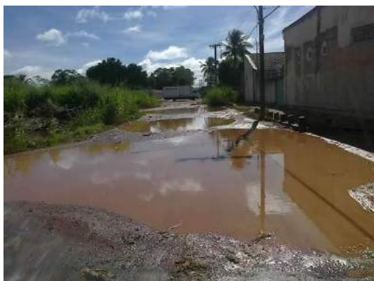
Figura 155 -Via de tráfego com acúmulo de água após precipitação, bairro Cidade Nova Foto: Moto Táxi Vapt Vupt, 2014
