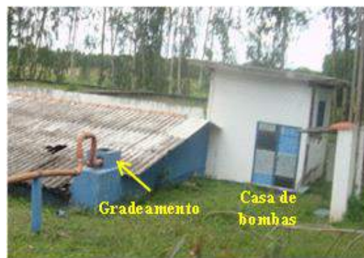
Figura 53 -Gradeamento e casa de bombas da ETE Cohab Nova Foto: Aldecy de Almeida Santos (2014)
