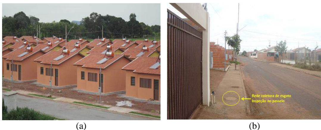
Figura 35 - Bairros com rede coletora de esgoto: (a) Residencial Jardim Aeroporto; (b) Residencial Aroldo Fanaia
