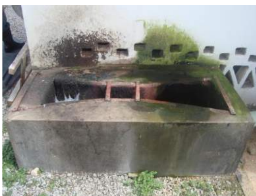
Figura 69 -Determinação da vazão do efluente tratado por Calha Parshall Foto: Aldecy de Almeida Santos (2014)
