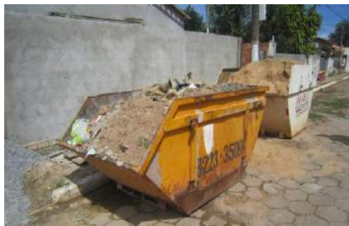
Figura 103 -Acondicionamento de resíduos da construção civil Foto: Tadeu Latorraca (2014)
