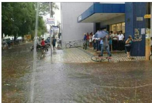
Figura 157 -Via de tráfego pavimentada com alagamento durante precipitação
