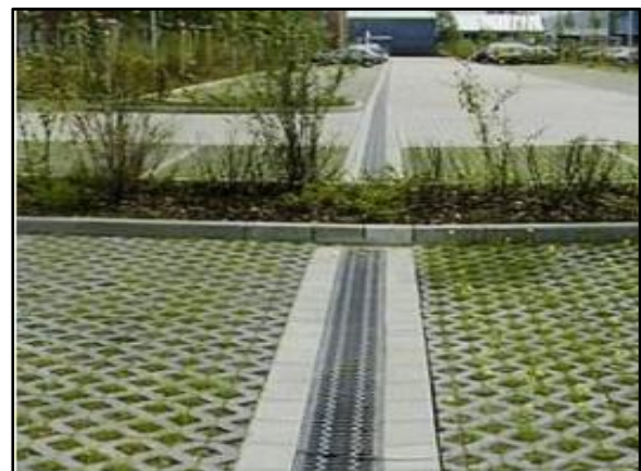
Figura 165. Trincheira de infiltração no estacionamento
