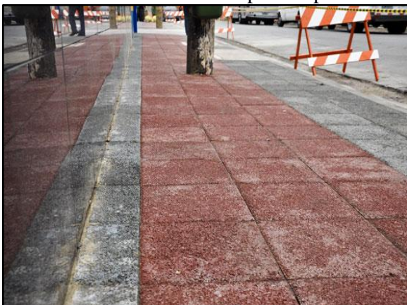
Figura 162. Pavimento poroso – piso intertravado instalado em passeio público
