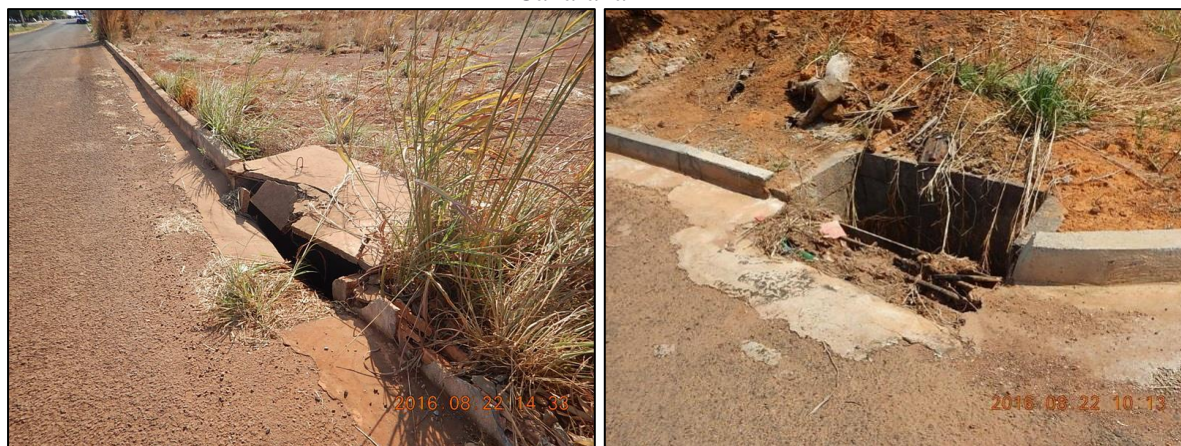
Figura 68. Dispositivos de microdrenagem com estrutura física comprometida, localizados em Canarana-MT
