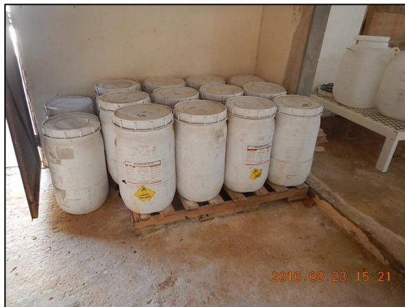
Figura 22. Armazenamento de hipoclorito de cálcio no almoxarifado da ETA de Canarana-MT
