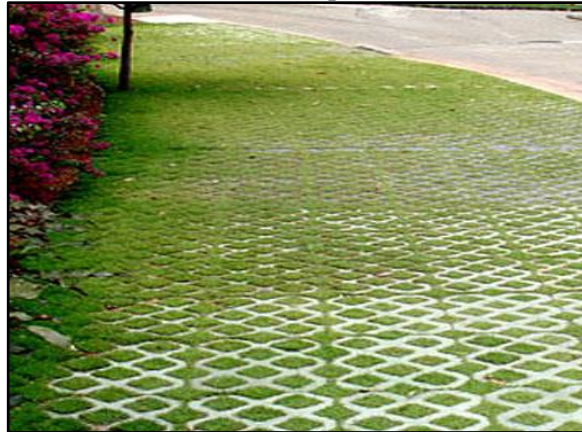
Figura 161. Pavimento poroso – concregrama instalado em passeio
