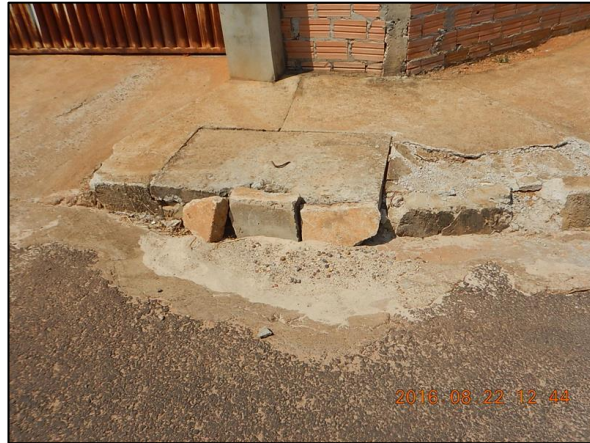
Figura 67. Boca de lobo fechada por problemas de mau cheiro por ligações clandestinas de esgoto, no bairro Jardim União, em Canarana
