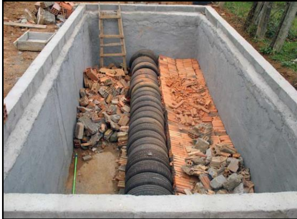
Figura 152. Método do círculo de bananeiras em execução para tratamento individual
