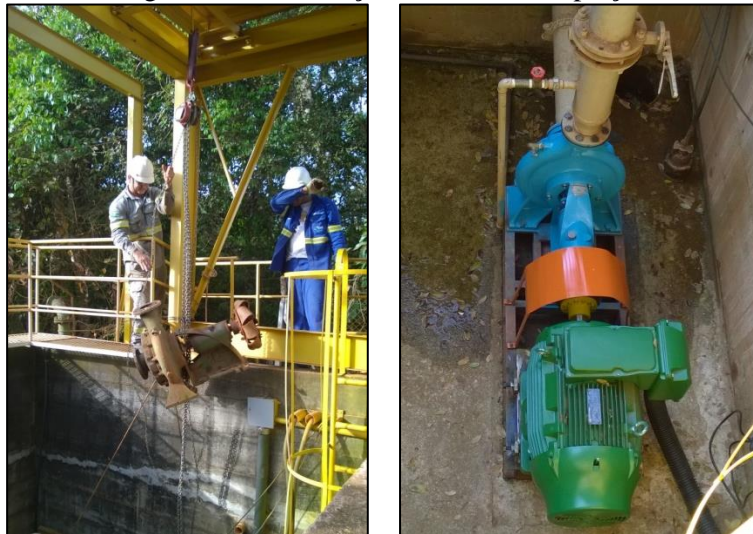
Figura 49. Substituição de motor na captação
