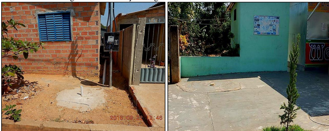
Figura 54. Construção irregular de fossas em Canarana-MT
