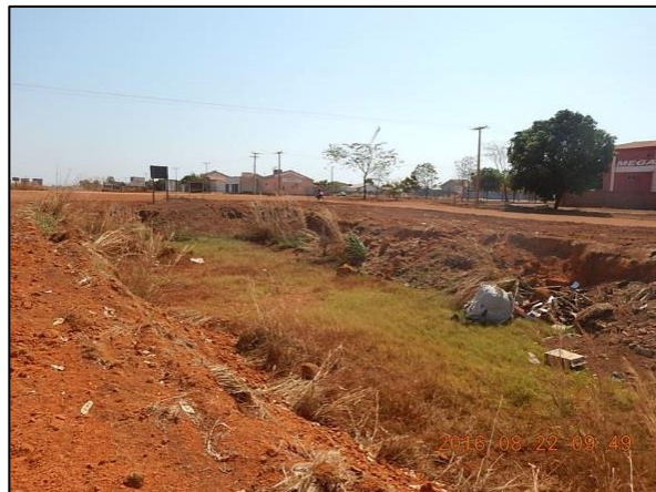
Figura 59. Bacia de detenção localizada na Avenida Mato Grosso, bairro Morada do Sol, em Canarana-MT
