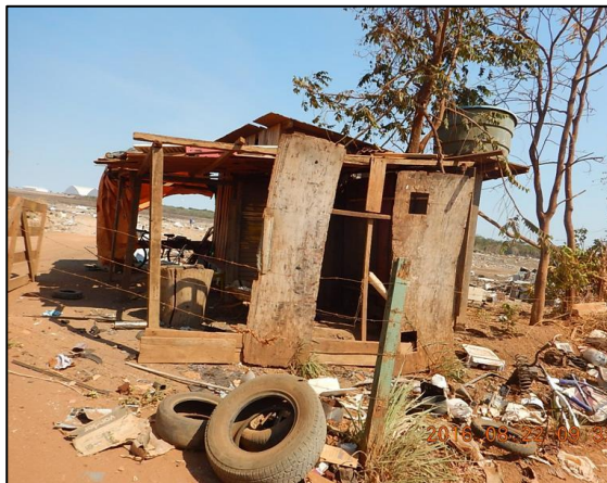
Figura 82. Estrutura de madeira na entrada da área do lixão de Canarana-MT
