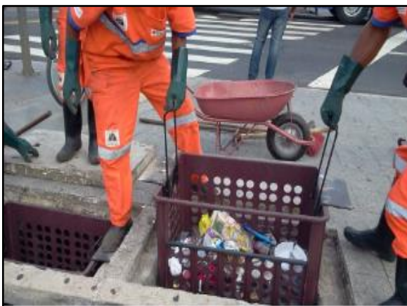
Figura 156. Cesta acoplada a boca do bueiro
