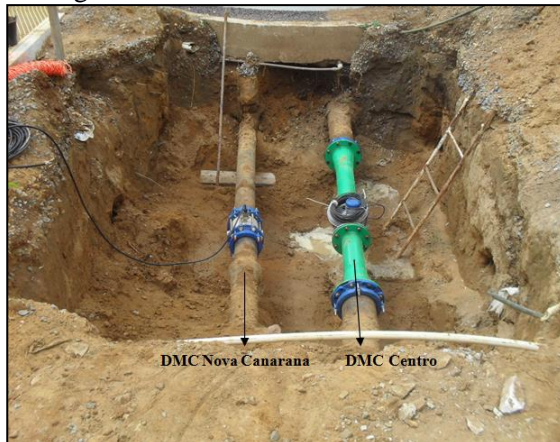
Figura 37. Instalação dos macromedidores de água tratada da ETA de Canarana-MT
