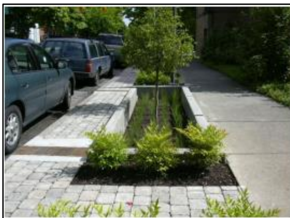
Figura 164. Trincheira de infiltração no passeio
