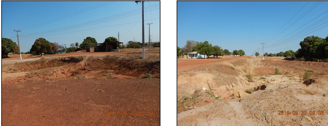
Figura 114. Processos erosivos em vias não pavimentadas da comunidade de Culueue, em Canarana
