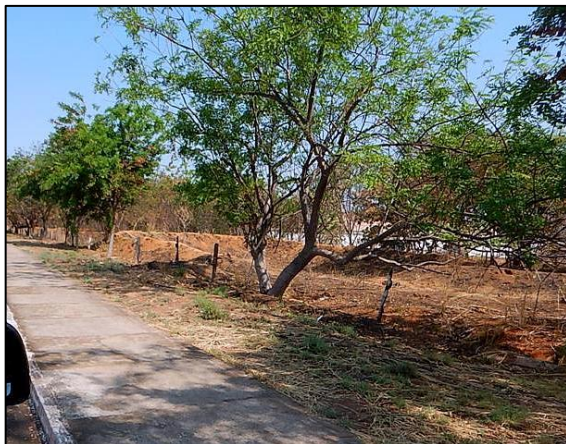
Figura 58. Bacia de detenção localizada na Avenida Mato Grosso, bairro Centro, em Canarana-MT
