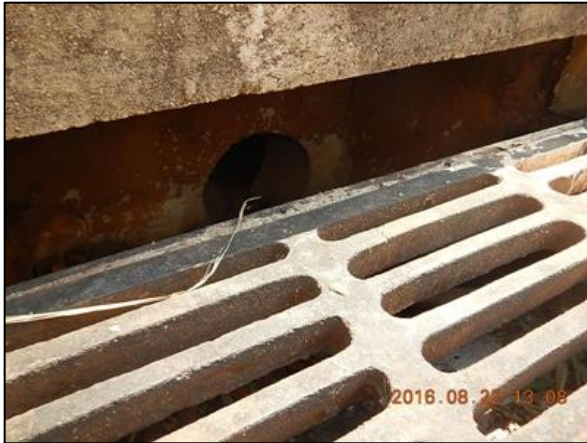
Figura 66. Ligação clandestina de esgoto observada em dispositivo de microdrenagem localizado no bairro Centro, em Canarana-MT
