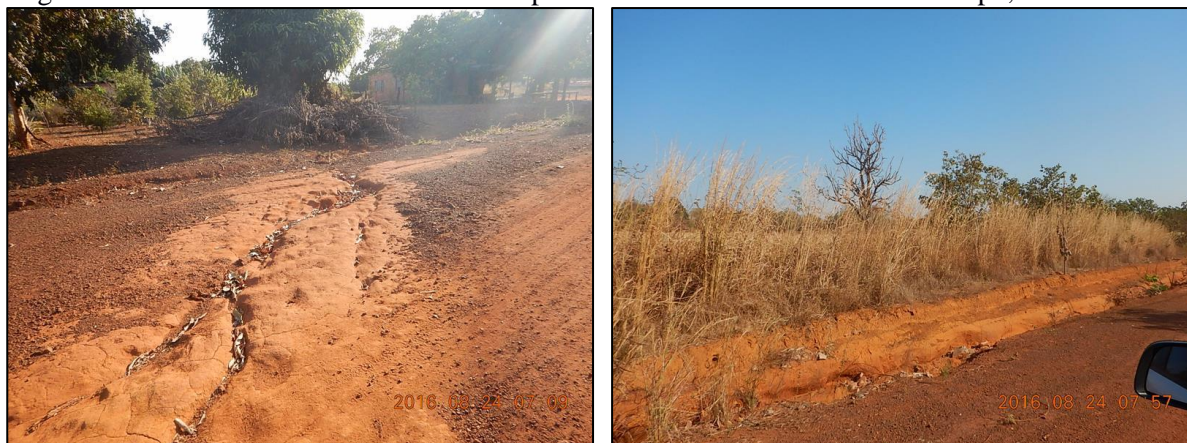
Figura 125. Processos erosivos em vias não pavimentadas da comunidade de Garapu, em Canarana
