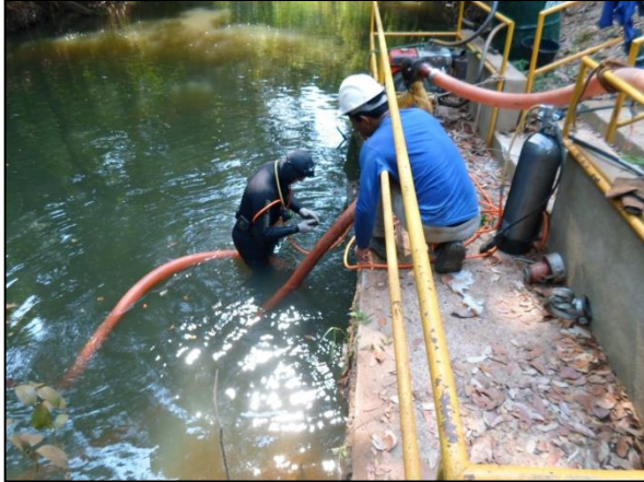
Figura 41. Equipe da CAB realizando limpeza do poço de sucção da captação de água bruta
