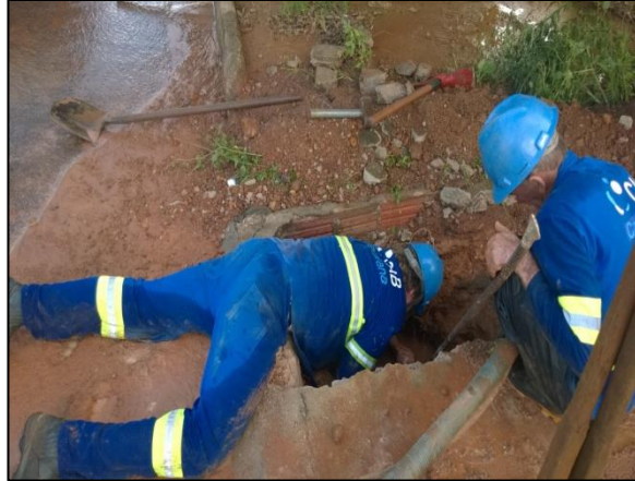
Figura 42. Funcionários da CAB realizando o reparo de vazamentos na rede de distribuição
