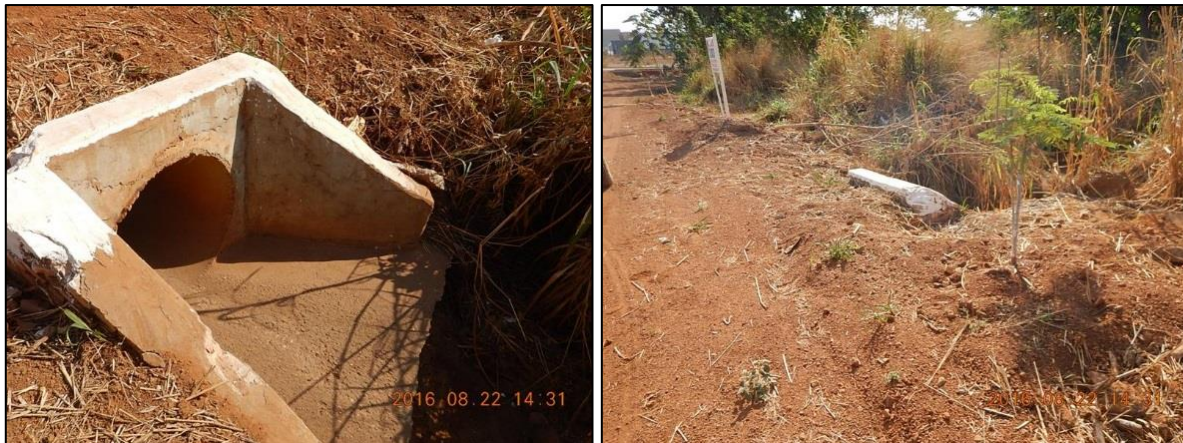
Figura 65. Ponto de deságue da rede de drenagem localizado na Avenida Rio Grande do Sul, em Canarana-MT
