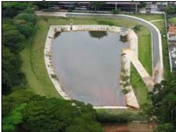
Figura 168. Bacia de detenção
