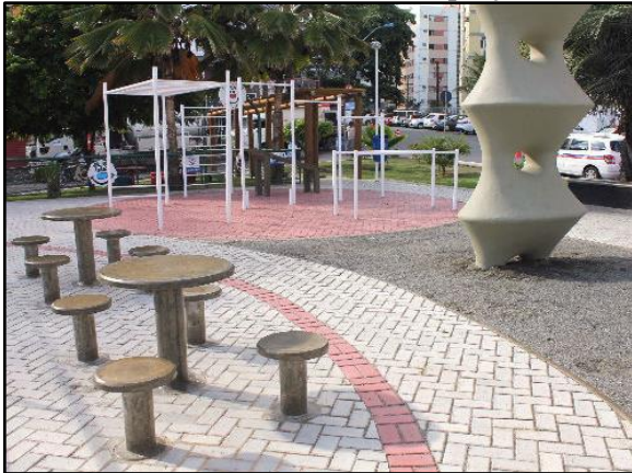
Figura 160. Pavimento poroso – piso intertravado instalado em praça
