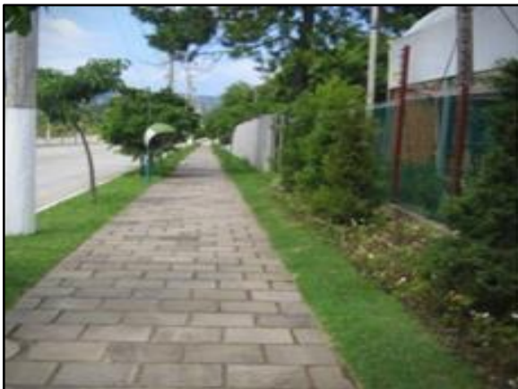
Figura 166. Vala de detenção ao longo da rua
