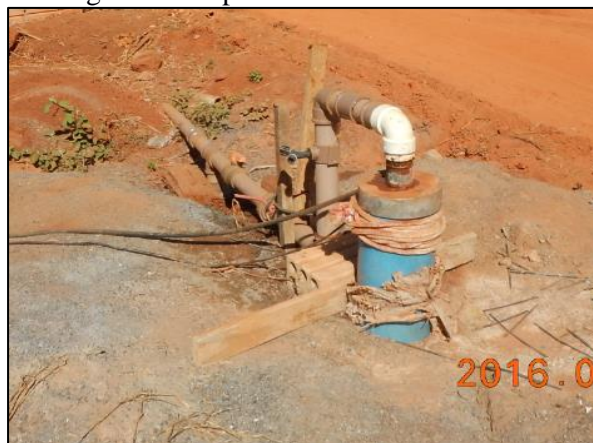
Figura 15. Aspectos estruturais do PT-11
