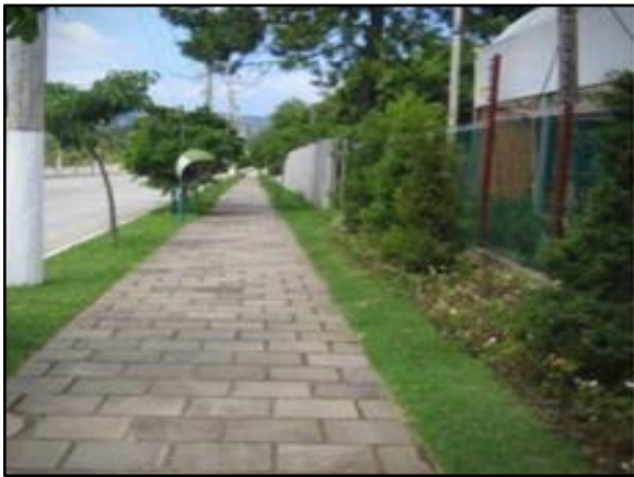
Figura 87. Vala de detenção ao longo da rua
