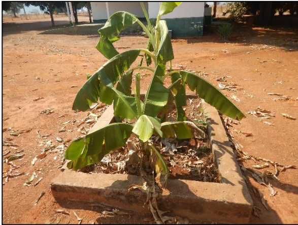
Figura 55. a. Fossas bananeira para tratamento do esgoto; b. Fossa rudimentar
