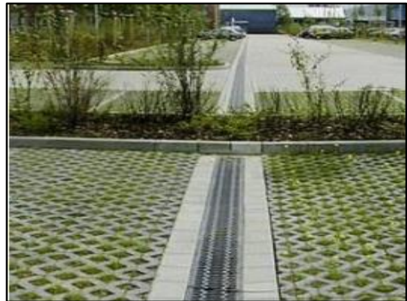
Figura 86. Trincheira de infiltração no estacionamento
