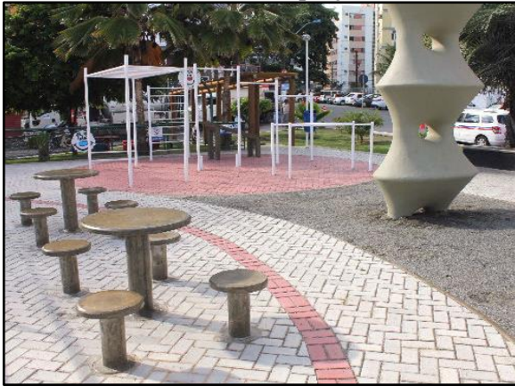
Figura 81. Pavimento poroso – piso intertravado instalado em praça
