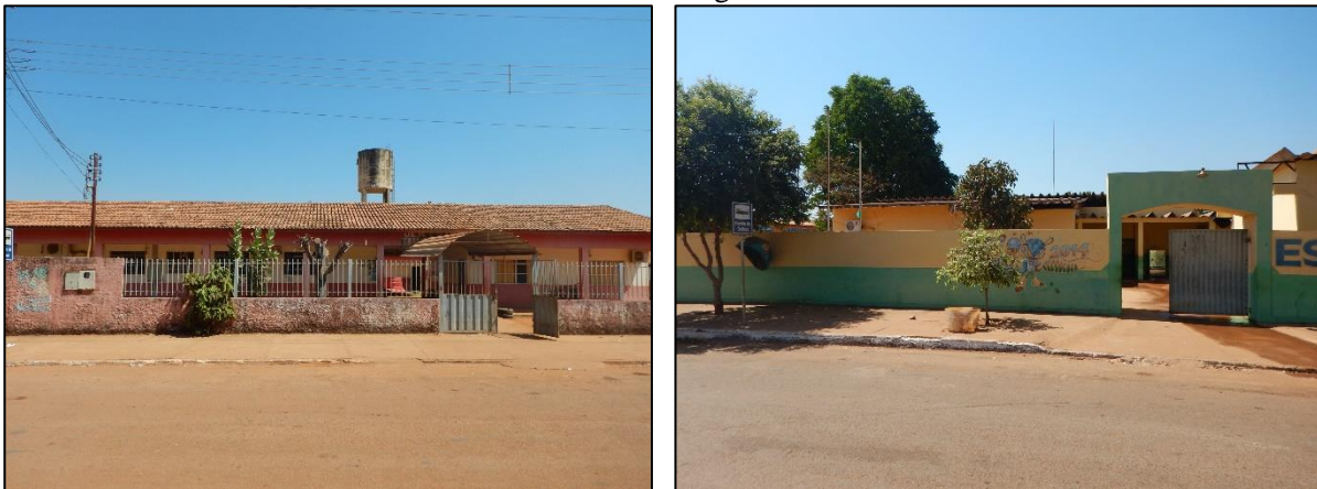
Figura 28. Vias municipais em Cocalinho com meio-fio e sarjeta e sem nenhum tipo de dispositivo de microdrenagem
