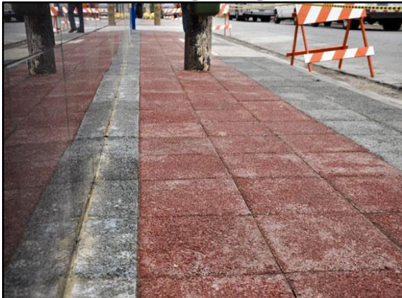
Figura 83. Pavimento poroso – piso intertravado instalado em passeio público
