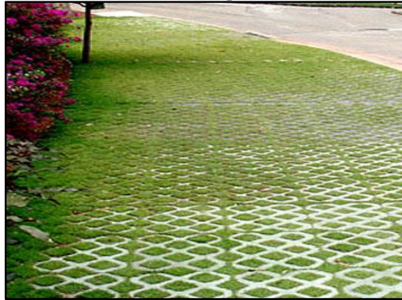
Figura 82. Pavimento poroso – concregrama instalado em passeio
