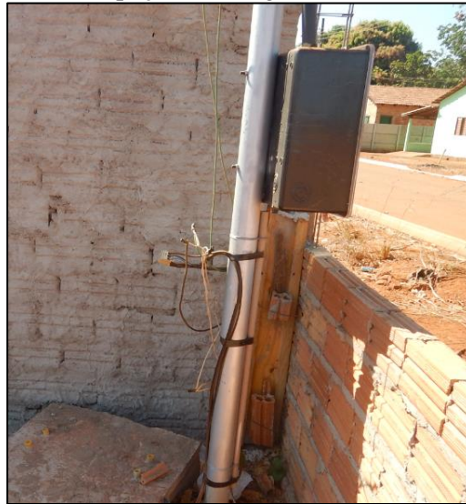
Figura 17. Fiação elétrica do poço PT-11 ligada diretamente ao padrão de energia
