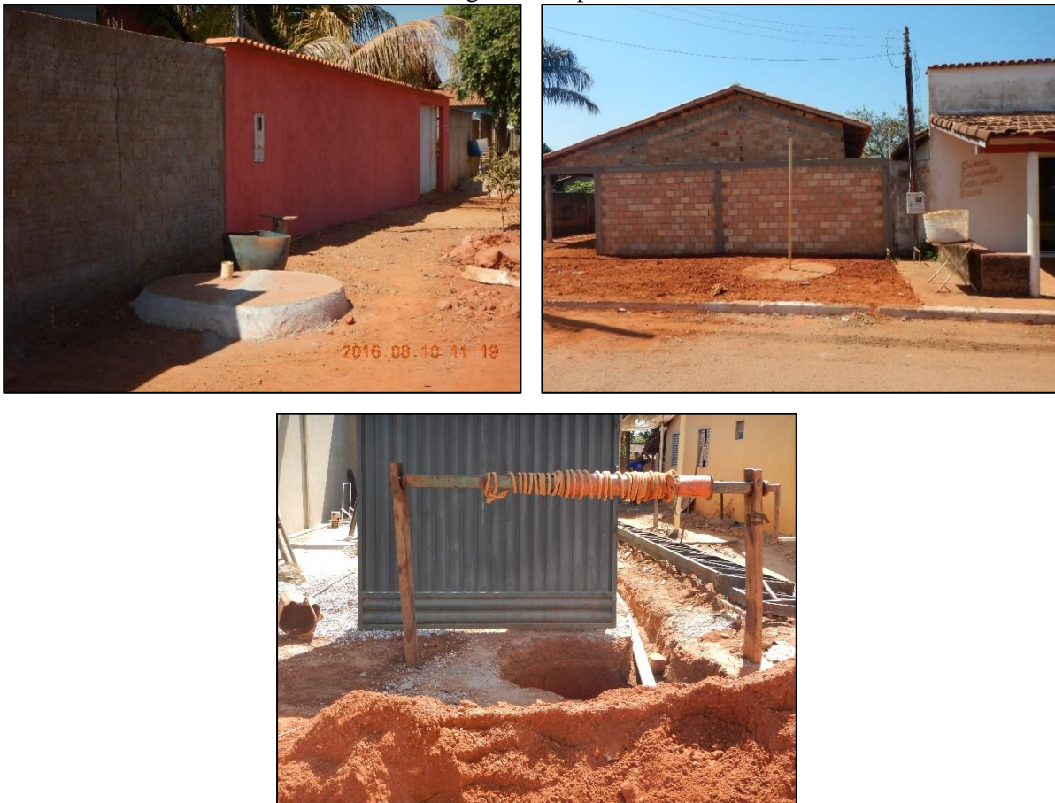
Figura 25. Soluções individuais adotadas nas residências de Cocalinho e construção de novas fossas em logradouros públicos
