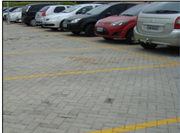
Figura 84. Pavimento poroso instalado em estacionamento
