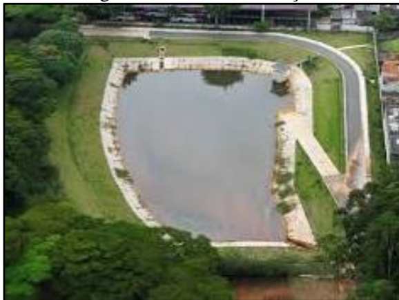
Figura 89. Bacia de detenção
