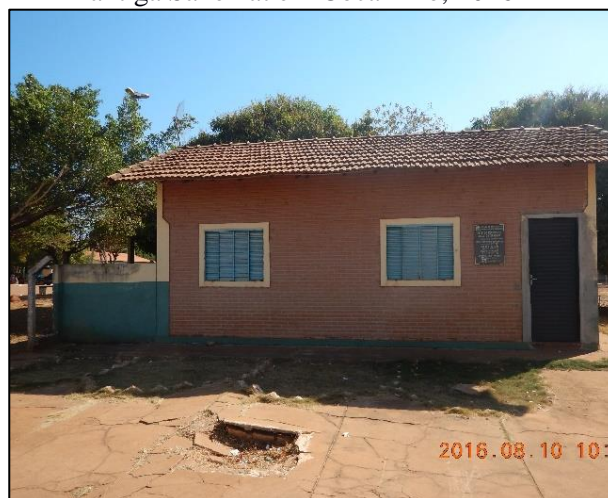
Figura 6. Aspectos da sede do escritório local da antiga Sanemat em Cocalinho, 2016
