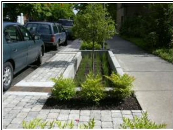
Figura 85. Trincheira de infiltração no passeio
