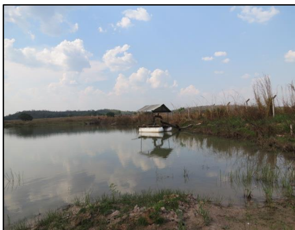
Figura 42: Captação de água bruta no Córrego Paciguara
