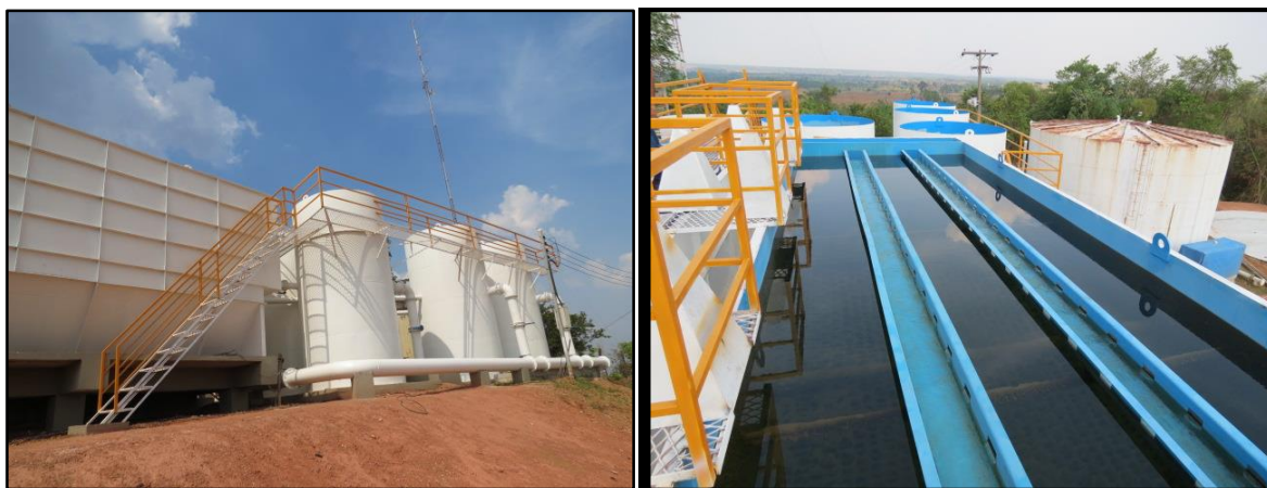
Figura 45. Estação de Tratamento de Água – Rio Cacao
