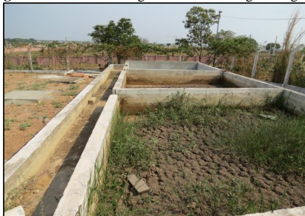
Figura 20: Leito de secagem – ETA Córrego Paciguara
