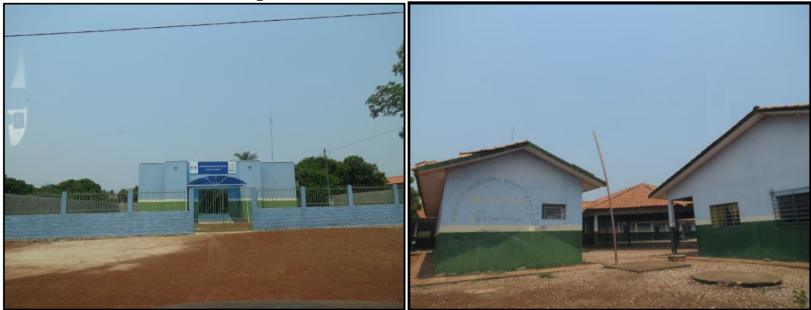
Figura 54: Obras e estrutura da área rural
