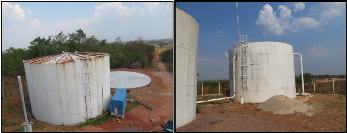
Figura 23: Reservatórios de água
