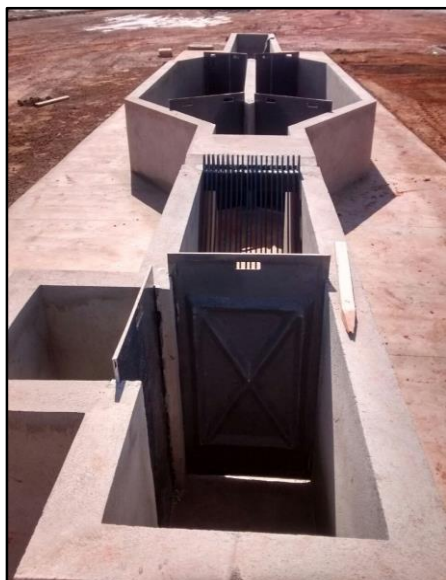
Figura 73. Sistema de Tratamento de Esgoto de Confresa em execução
