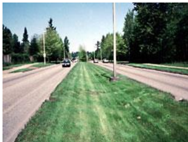
Figura 82 - Exemplo de vala de infiltração.
