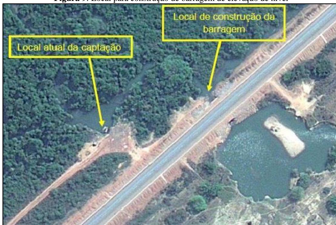
Figura 9: Local para construção de barragem de elevação de nível
