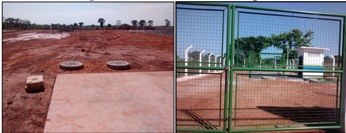
Figura 35: Obras do sistema de tratamento de esgoto
