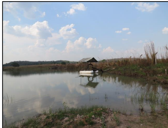
Figura 11: Captação de água bruta no Córrego Paciguara
