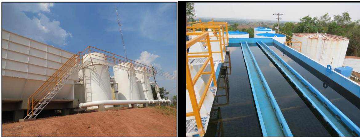
Figura 14. Estação de Tratamento de Água – Rio Cacaú
