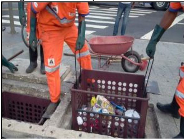
Figura 120. Cesta acoplada a boca do bueiro
