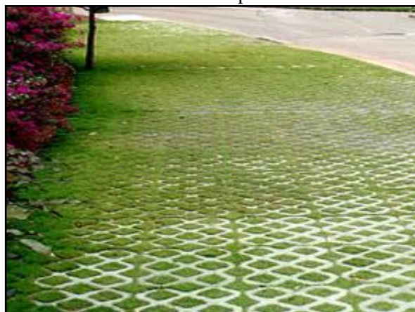
Figura 125. Pavimento poroso – concregrama instalado em passeio
