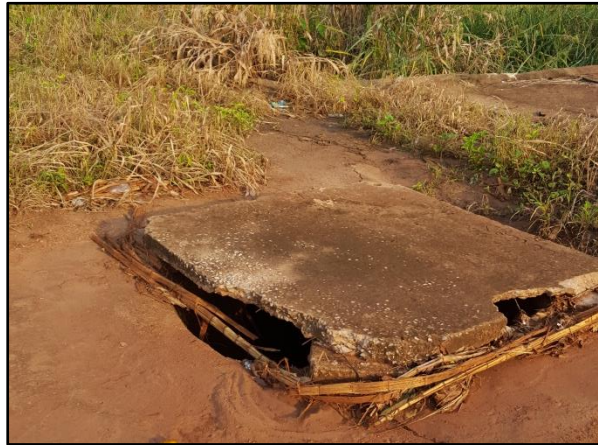
Figura 46. Boca de lobo com tampa danificada na Rua Juscelino Kubistchek
