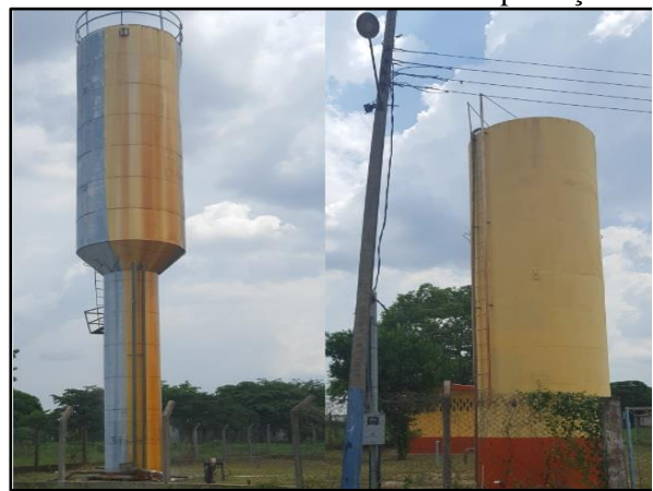
Figura 23. Reservatórios RAP-01 de 40 m 3 e RAP-02 de 100 m 3 do Setor Boa Esperança
