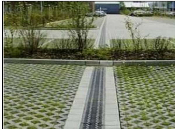
Figura 129. Trincheira de infiltração no estacionamento
