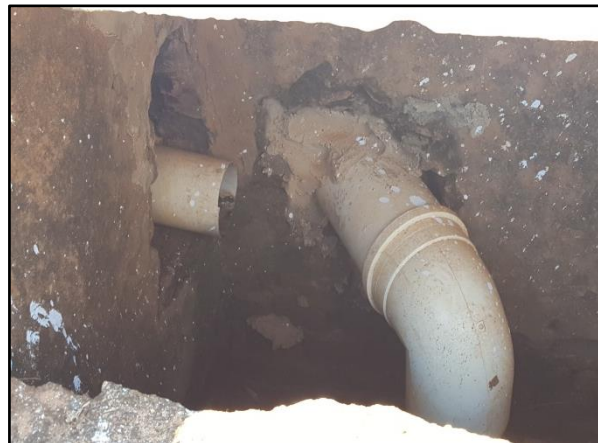
Figura 35. Ligação de esgoto na boca de lobo localizada na esquina da Rua Antônio Alves Teixeira com a Rua Juscelino Kubitschek
