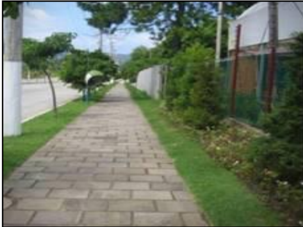
Figura 130. Vala de detenção ao longo da rua
