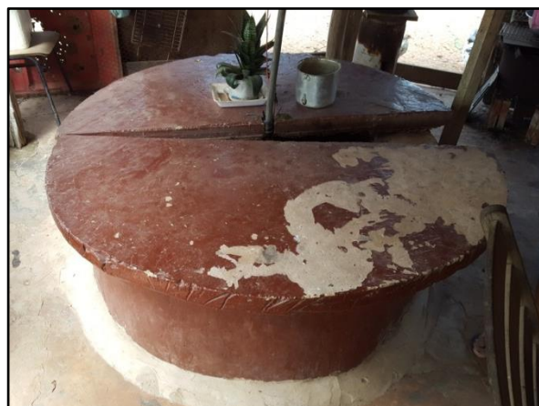
Figura 96. Poço cacimba particular de uma propriedade na comunidade de Brito, em Denise-MT
