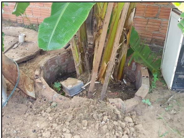
Figura 28. Fossa de bananeira em uma residência localizada na Rua das Corujas, no bairro Recanto dos Pássaros (Setor Centro)
