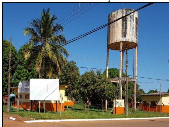
Figura 6. Fachada do escritório comercial e operacional do DMAE em Denise
