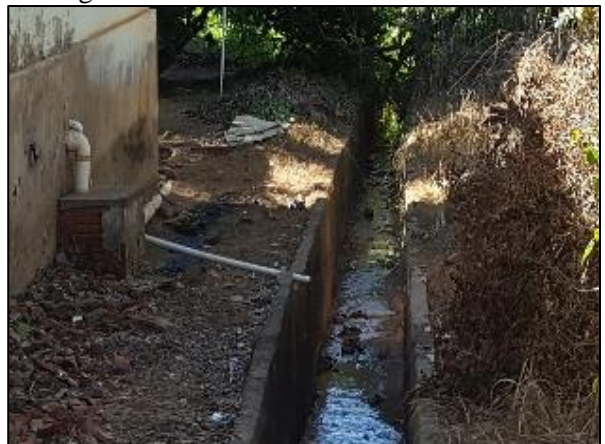
Figura 41. Lançamento de esgoto no canal de drenagem de uma residência na Av. Mato Grosso
