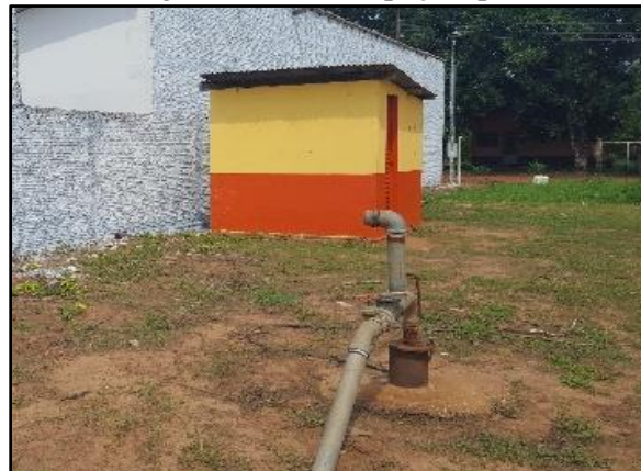
Figura 13. Área do poço Apae
