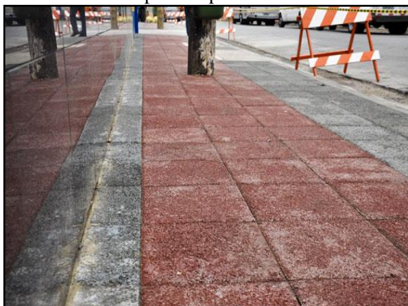
Figura 126. Pavimento poroso instalado em passeio público
