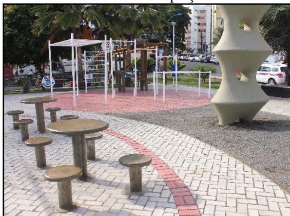
Figura 124. Pavimento poroso – piso intertravado instalado em praça
