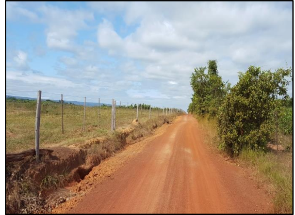
Figura 100. Estrada não pavimentada sem dispositivos de drenagem na comunidade Brito, em Denise-MT
