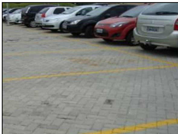
Figura 127. Pavimento poroso instalado em estacionamento
