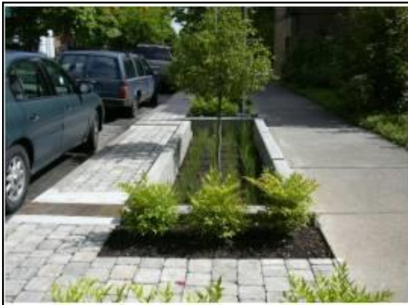
Figura 128. Trincheira de infiltração no passeio
