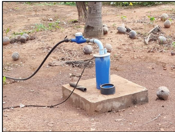
Figura 93. Poço tubular profundo construído na comunidade de Fátima, em Denise-MT
