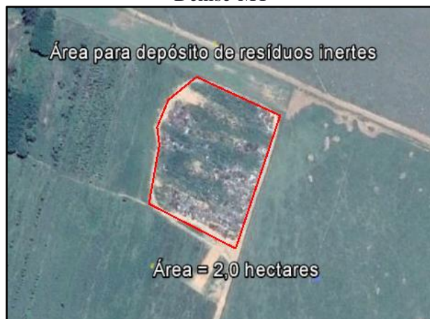
Figura 91. Área para depósito de resíduos inertes em Denise-MT
