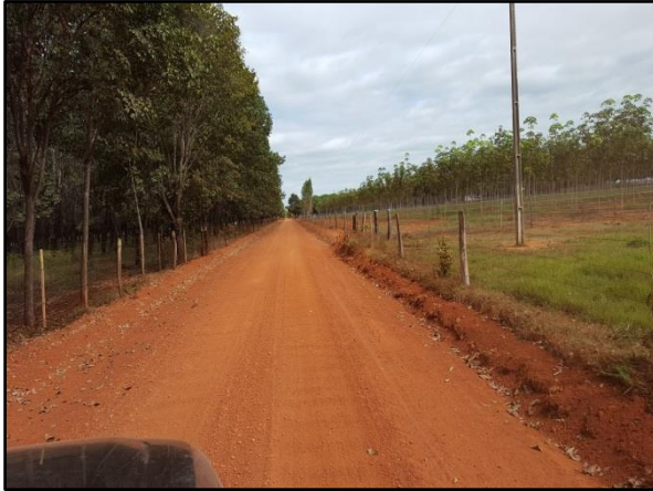
Figura 99. Estrada não pavimentada sem dispositivos de drenagem na comunidade Banco da Terra, em Denise-MT
