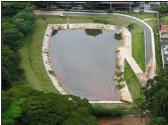
Figura 125. Bacia de detenção
