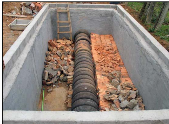
Figura 109. Método do círculo de bananeiras em execução para tratamento individual
