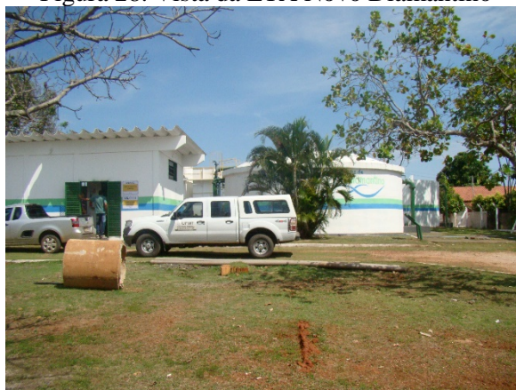
Figura 28. Vista da ETA Novo Diamantino
