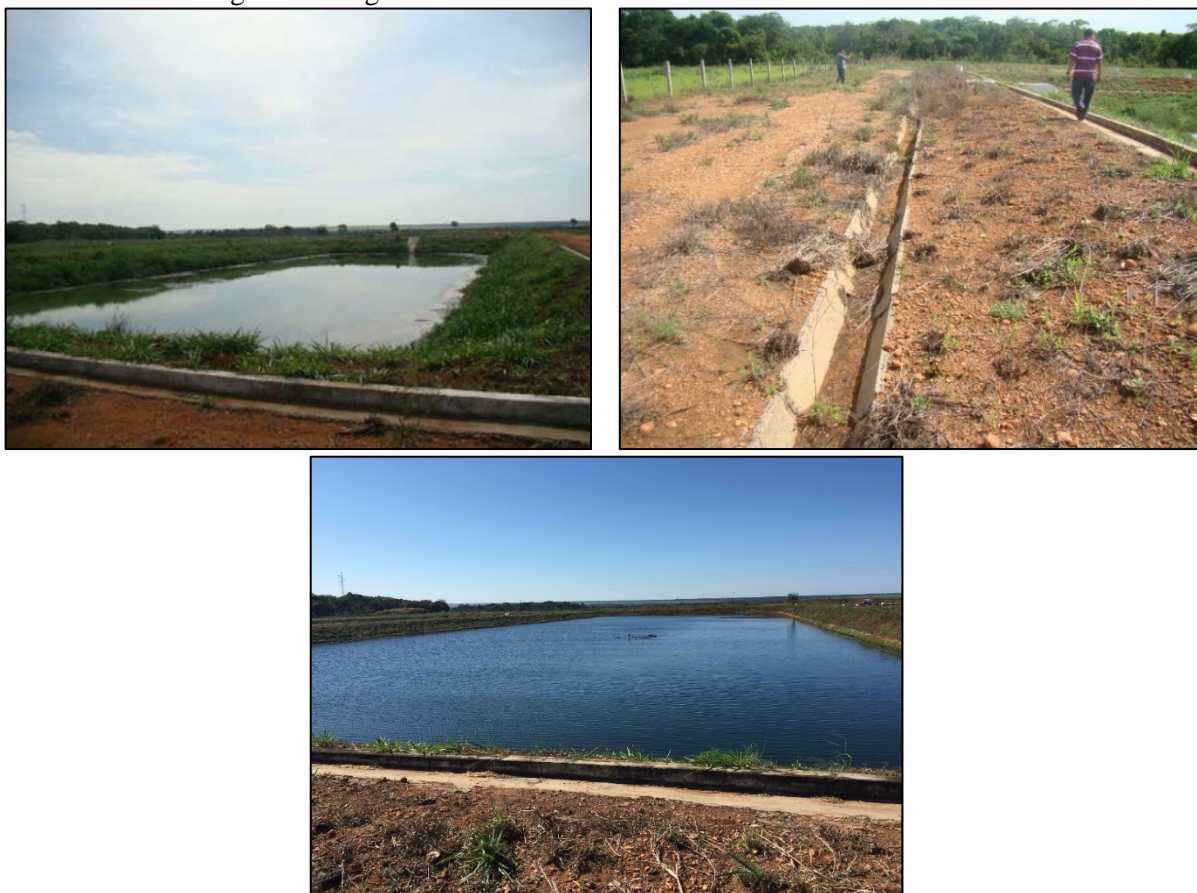
Figura 52. Lagoas anaeróbia e facultativa da ETE Novo Diamantino
