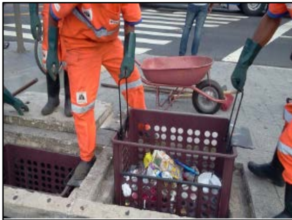
Figura 113. Cesta acoplada à boca do bueiro
