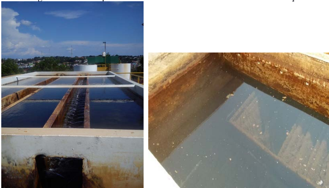
Figura 22. Visão superior do decantador de alta taxa e lonas de decantação
