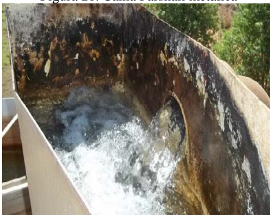
Figura 20. Calha Parshall metálica
