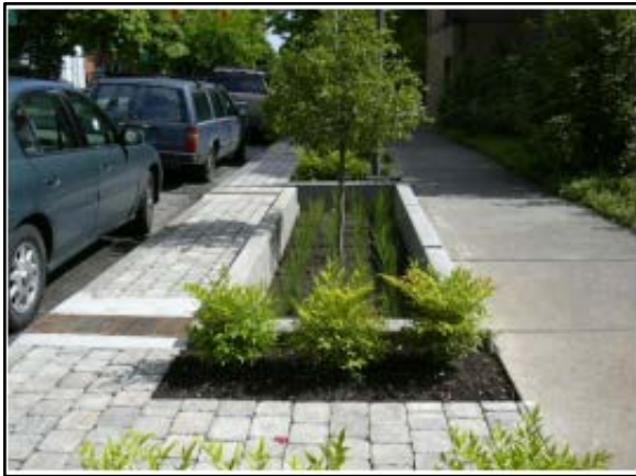
Figura 121. Trincheira de infiltração no passeio
