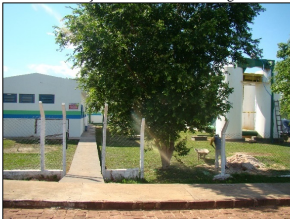
Figura 19. Fachada da Estação de Tratamento de Água do Centro Histórico
