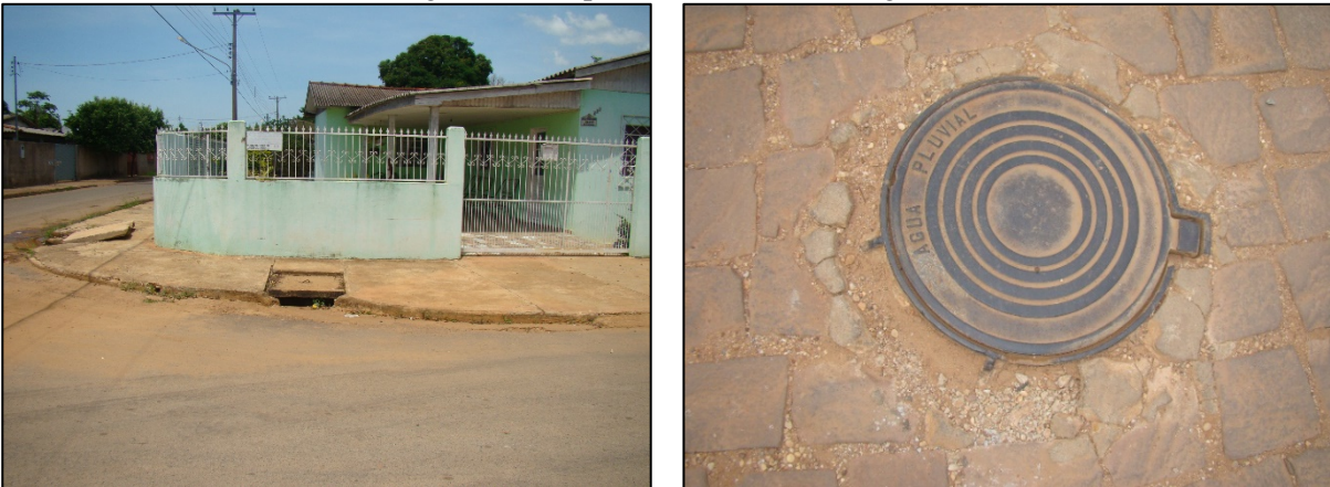
Figura 64. Dispositivo de microdrenagem
