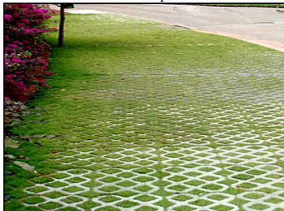
Figura 118. Pavimento poroso – concregrama instalado em passeio
