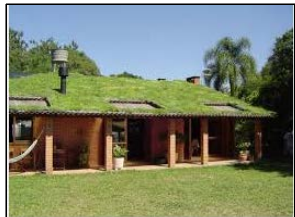
Figura 116. Telhado verde com plantas
