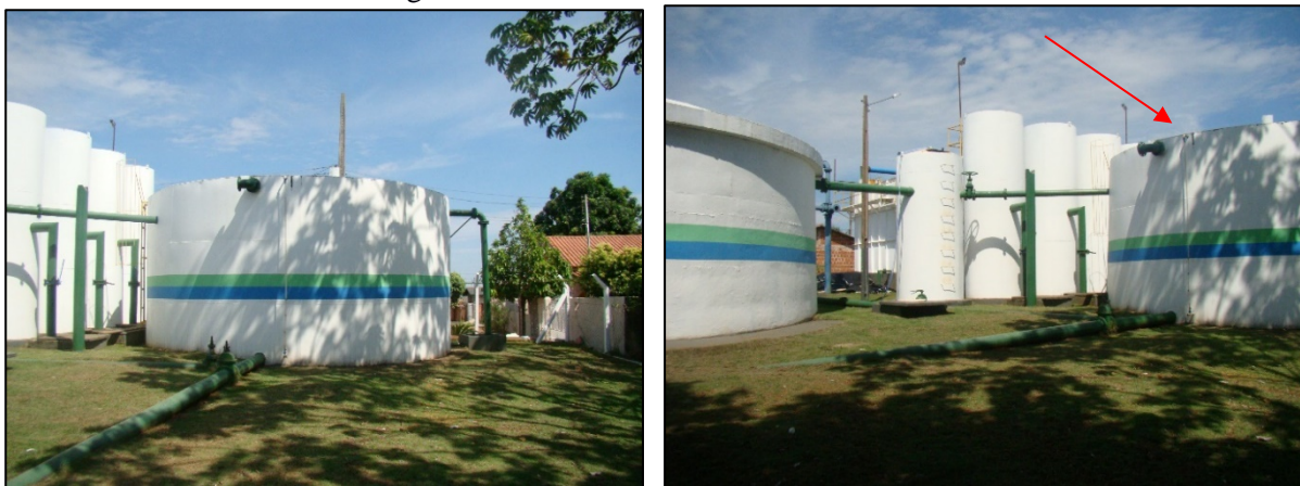
Figura 41. Reservatório metálico de 200 m 3
