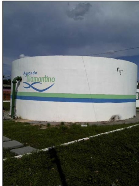
Figura 39. Reservatório apoiado em concreto armado de 350m 3
