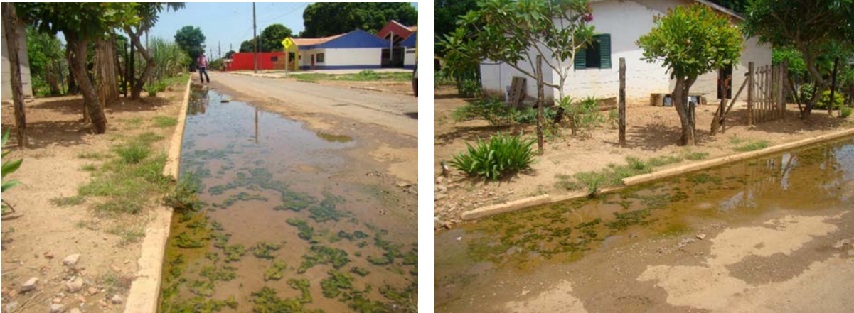
Figura 60. Rua com esgoto extravasado correndo a céu aberto,
