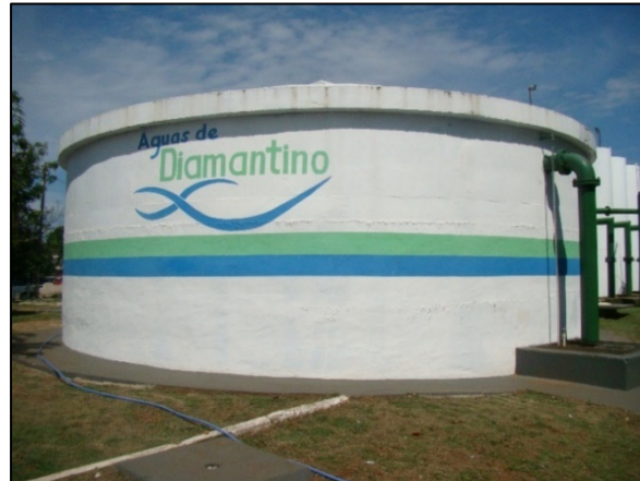
Figura 42. Reservatório semi-enterrado em concreto armado de 200m 3
