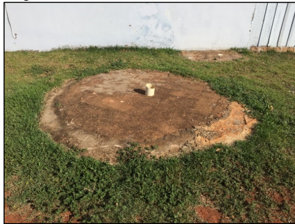
Figura 90. Fossas rudimentares em Deciolândia
