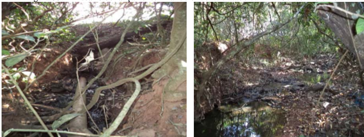
Figura 55. Emissário de lançamento final do efluente tratado da ETE Cohab Morumbi.
