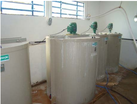
Figura 26 a. Tanques de preparo com agitador mecanizado das soluções químicas b. Sala de armazenamento dos produtos químicos
