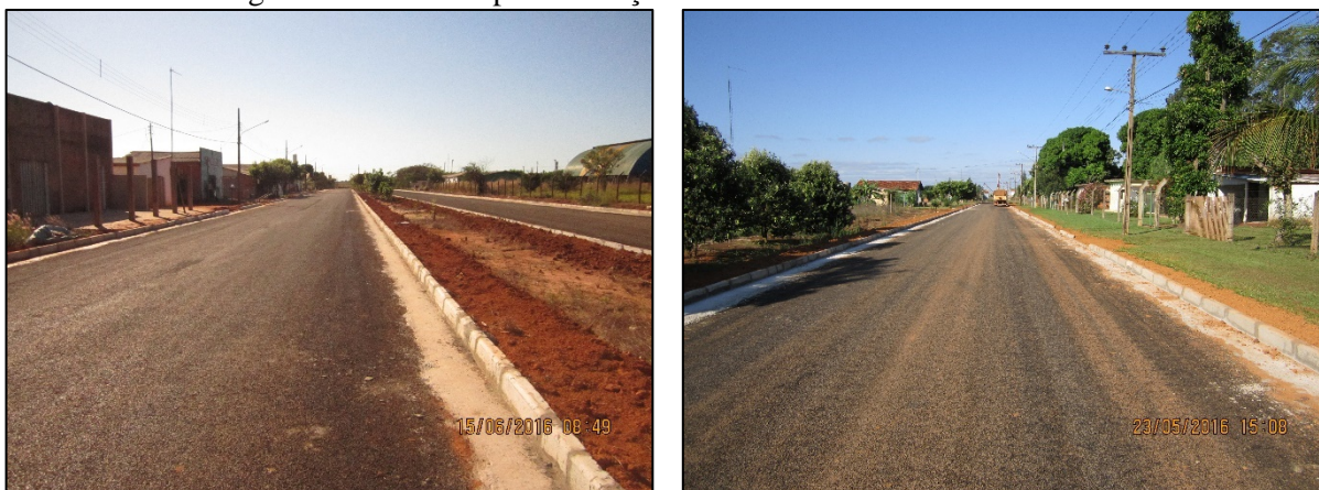
Figura 91. Vias com pavimentação em Deciolândia- Diamantino/MT
