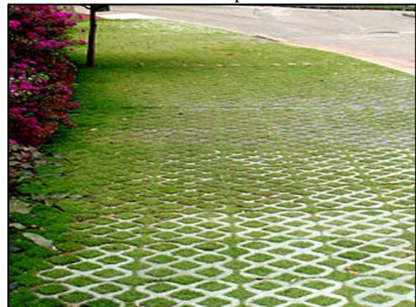
Figura 92. Pavimento poroso – concregrama instalado em passeio
