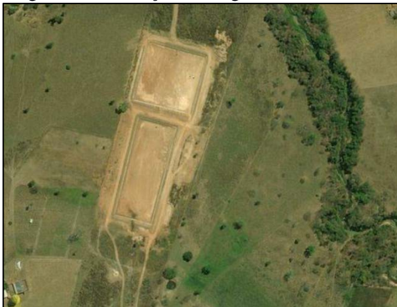
Figura 25. Execução das lagoas de tratamento
