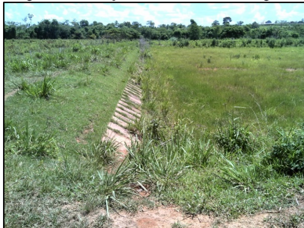
Figura 26. Situação atual das obras das lagoas
