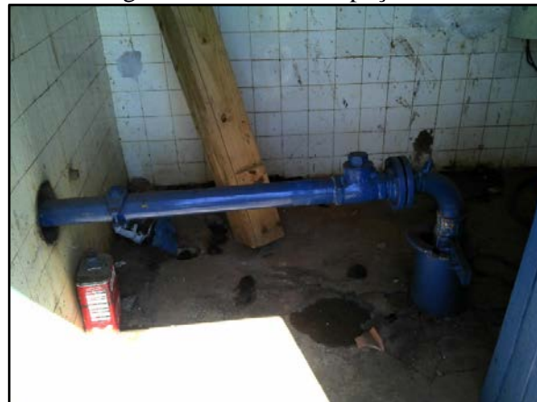
Figura 10. Cavalete do poço 01
