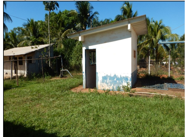
Figura 55. Abrigo de quadro de comando
