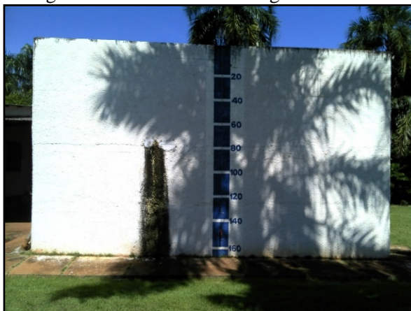
Figura 16. Reservatório retangular- RAP 1
