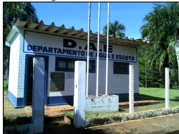
Figura 7. Fachada do DAE
