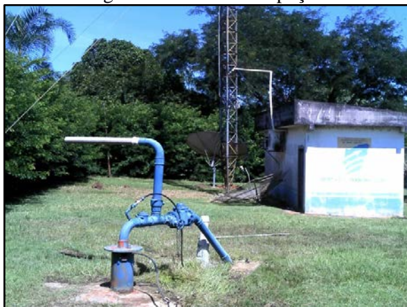
Figura 11. Cavalete do poço 2
