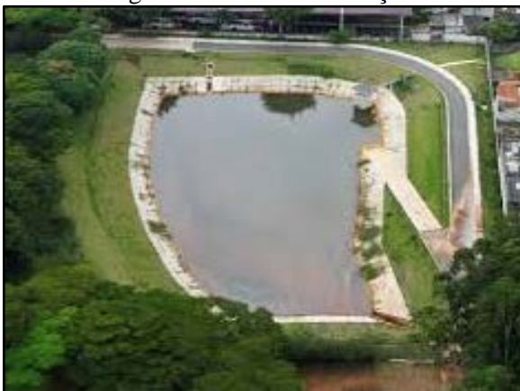
Figura 99. Bacia de detenção
